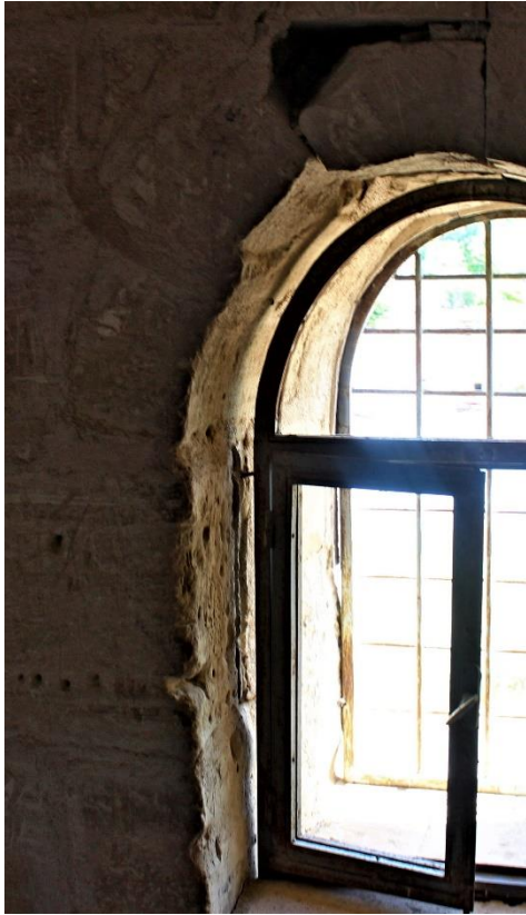
Fot. 257: Güney Cephe Pencere Açıklığı Doğu Yüzü
