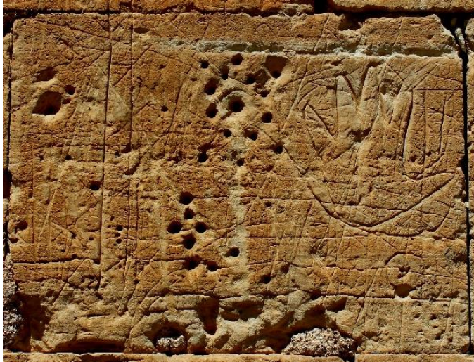
Fot. 96: Dođu Cephe Alttan 4. Sıra 16. Taş Blok
