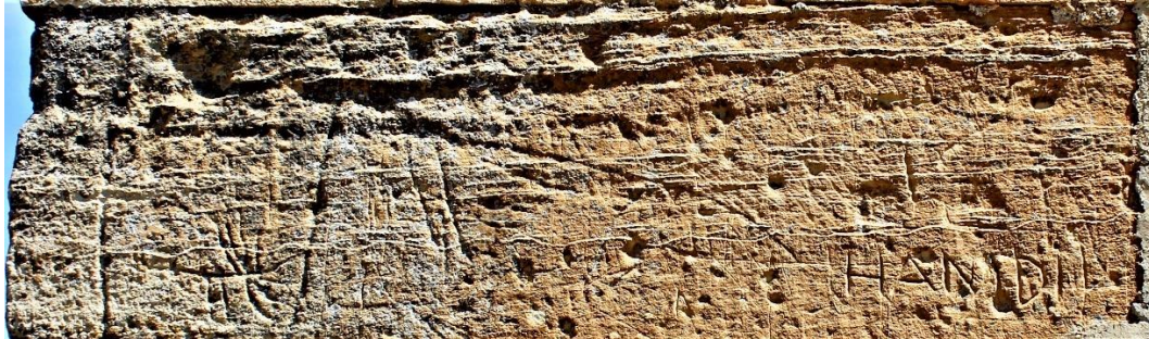
Fot. 189: Güney Cephe Alttan 4. Sıra 9. Taş Blok
