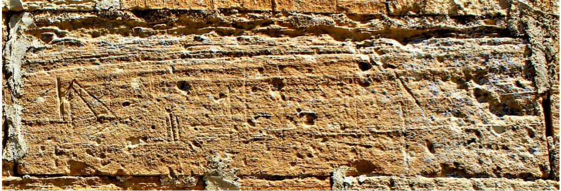
Fot. 195: Güney Cephe Alttan 5. Sıra 11. Taş Blok
