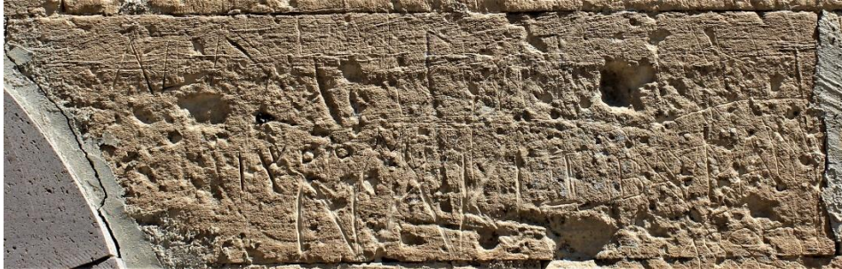
Fot. 187: Güney Cephe Alttan 4. Sıra 6. Taş Blok
