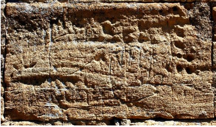
Fot. 172: Güney Cephe Alttan 3. Sıra 2. Taş Blok
