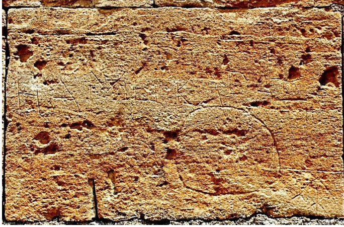
Fot. 203: Batı Cephe Alttan 2. Sıra 10. Taş Blok
