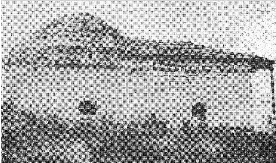
Fot. 2: Doğan Arslan Mescidi Restorasyon Öncesi Hali (N. Çağatay, 1981)
