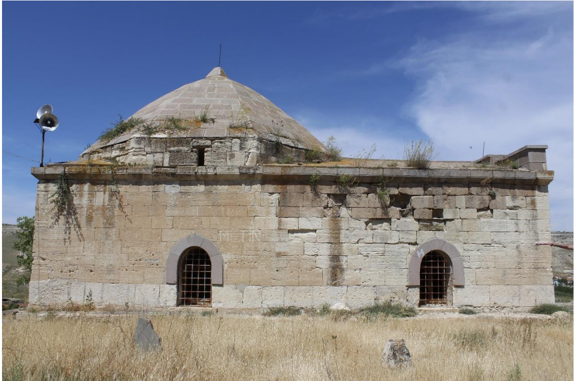
Fot. 6: Doğan Arslan Mescidi Doğu Cephesi
