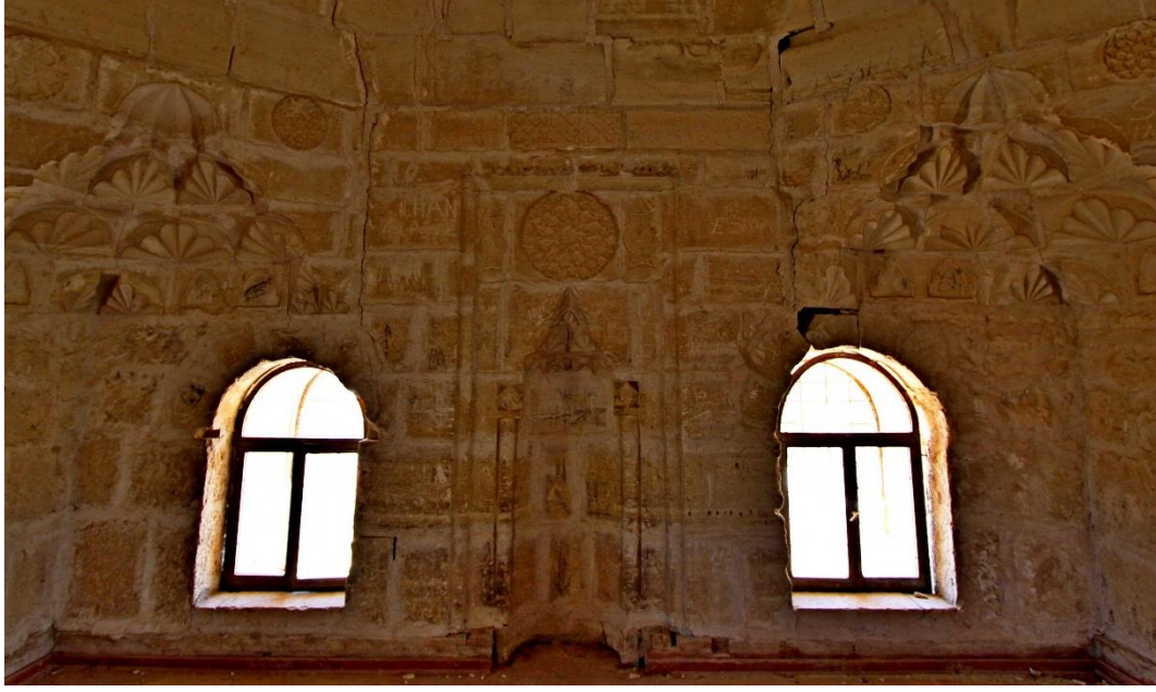
Fot. 248: Harim Mekanı Güney Cephesi Genel Görünümü
