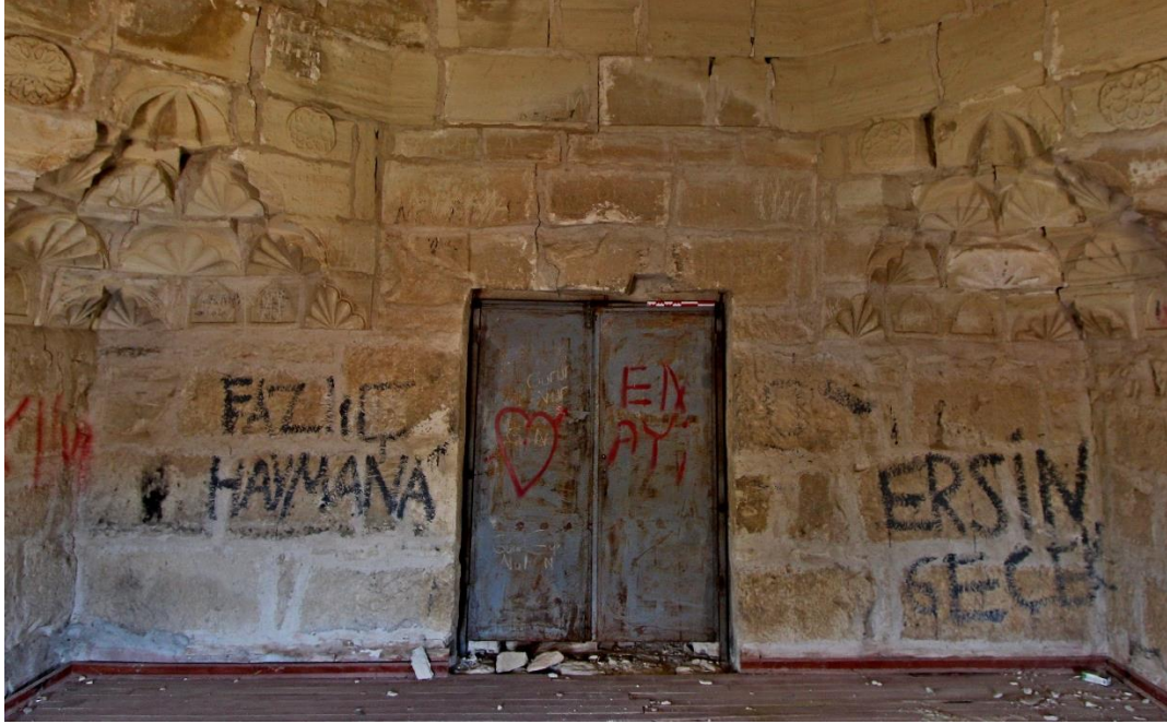
Fot. 284: Harim Kuzey Cephe Genel Görünümü
