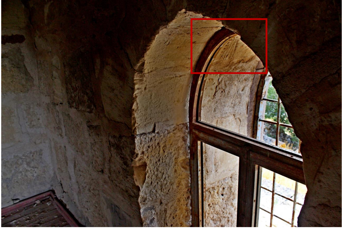
Fot. 244: Ön Harim Mekanı Batı Cephedeki Pencere Açıklığının Güney Duvarı
