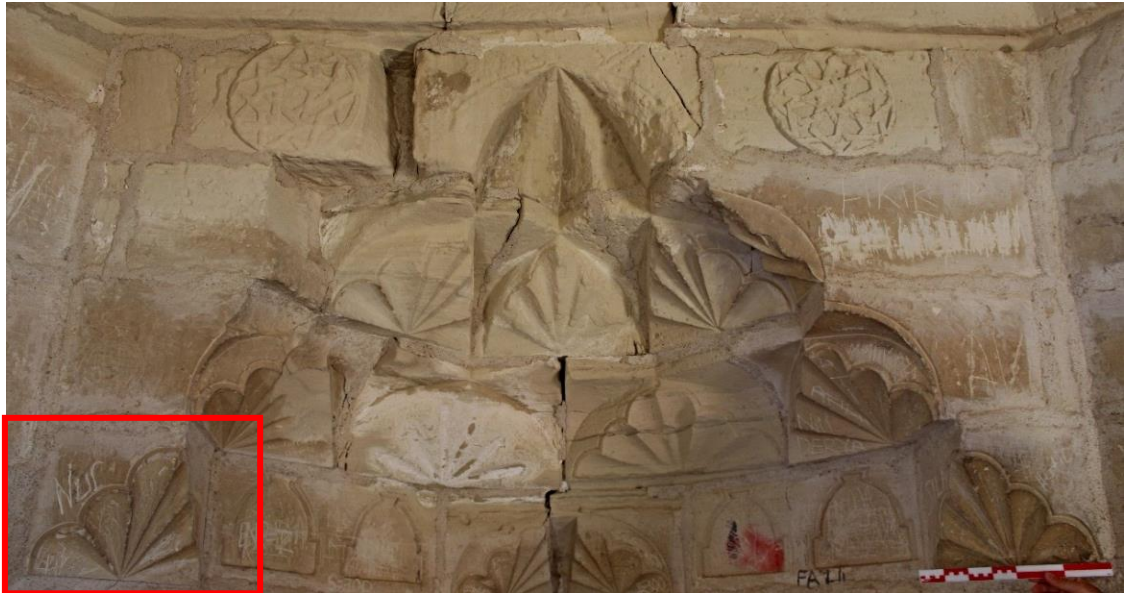
Fot. 289: Kuzeydoğudaki Tromp
