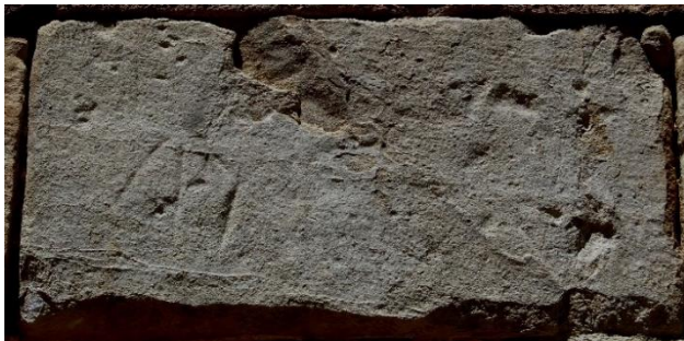
Fot. 137: Doğu Cephe 6. Sıra 11. Taş Blok
