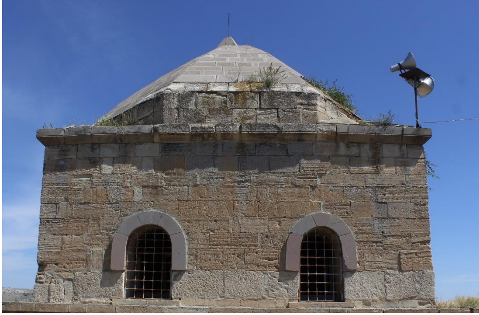
Fot. 163: Güney Cephe Genel Görünümü
