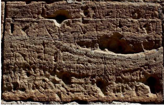
Fot. 164: Güney Cephe Alttan 2. Sıra 3. Taş Blok
