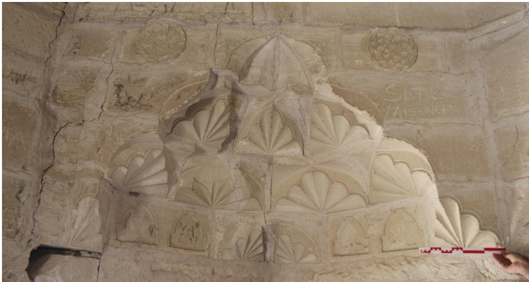
Fot. 14: Kuzeydoğu Köşede Kubbeye Geçişi Sağlayan İstiridye Kabuğu Şeklindeki Mukarnas Dolgulu Tromp
