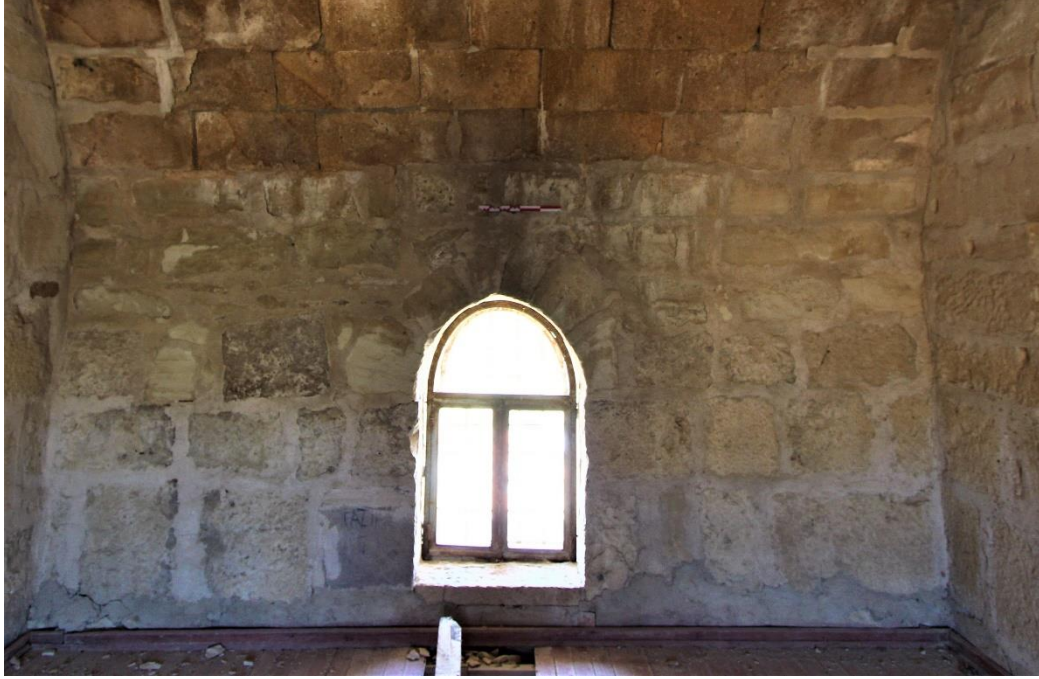
Fot. 243: Ön Mekanın Batı Cephesi Genel Görünümü
