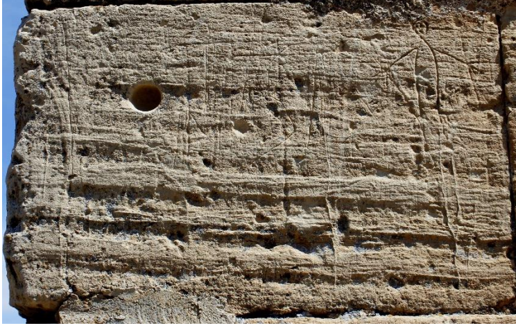
Fot. 177: Güney Cephe Alttan 3. Sıra 9. Taş Blok
