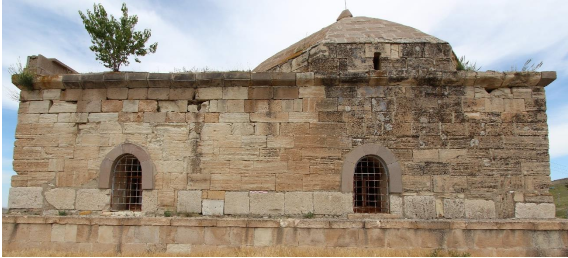
Fot. 200: Batı Cephe Genel Görünümü
