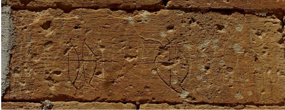
Fot. 154: Dođu Cephe Alttan 7. Sıra 18. Taş Blok
