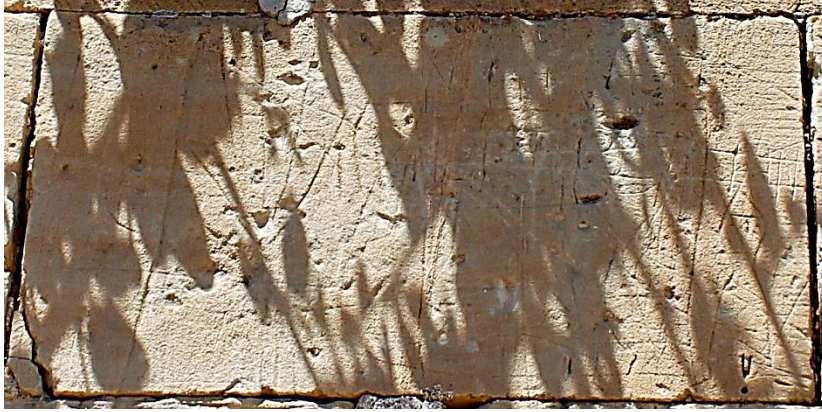
Fot. 149: Dođu Cephe Alttan 6. Sıra 22. Taş Blok
