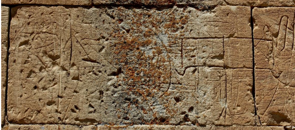
Fot. 129: Dođu Cephe Alttan 5. Sıra 17. Taş Blok
