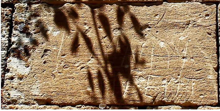
Fot. 159: Dođu Cephe Alttan 7. Sıra 22. Taş Blok
