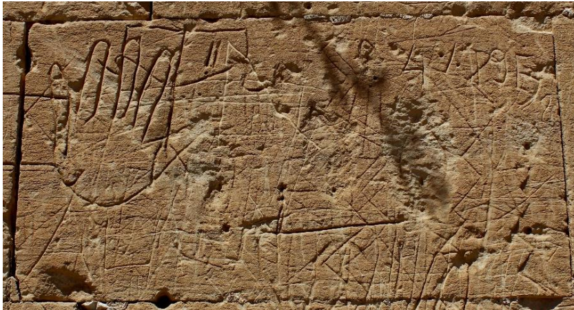
Fot. 125: Dođu Cephe Alttan 5. Sıra 16. Taş Blok
