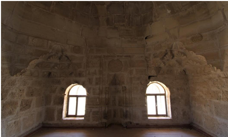
Fot. 16: Dođan Arslan Mescidi Harim Mekanı Güney Cephesi
