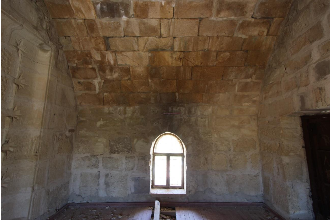
Fot. 10: Doğan Arslan Mescidi Ön Mekanın Batı Cephesi
