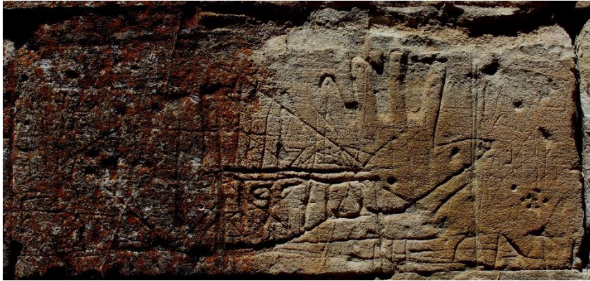
Fot. 80: Dođu Cephe Alttan 4. Sıra 8. Taş Blok
