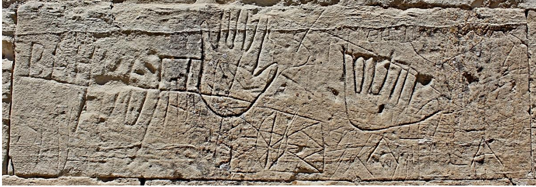
Fot. 76: Dođu Cephe Alttan 4. Sıra 2. Taş Blok
