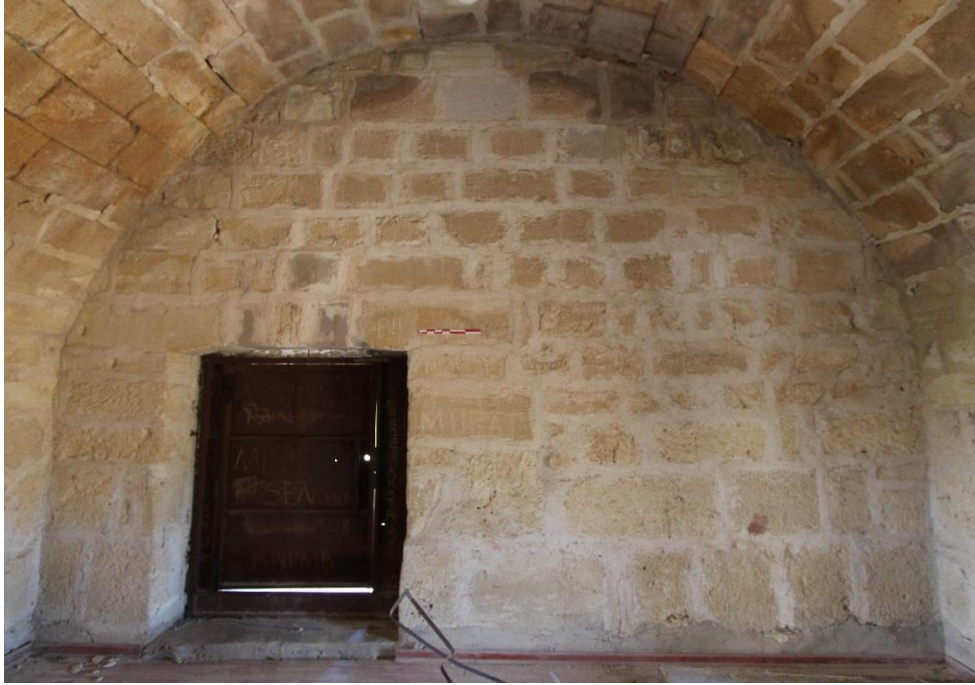
Fot. 246: Ön Mekanın Kuzey Cephesi Genel Görünümü
