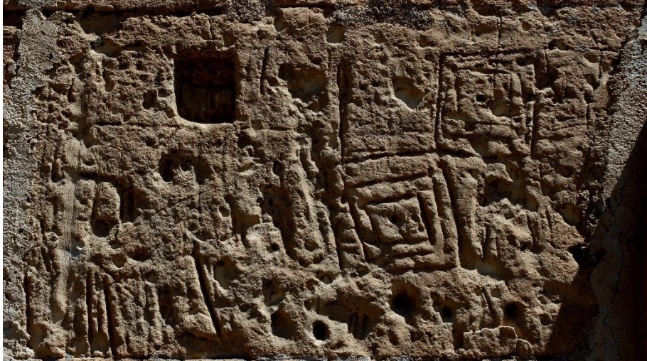
Fot. 175: Güney Cephe Alttan 3. Sıra 4. Taş Blok
