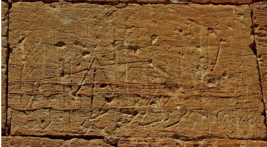
Fot. 139: Dođu Cephe Alttan 6. Sıra 15. Taş Blok
