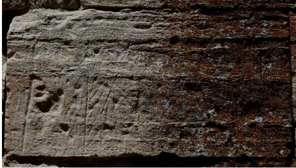
Fot. 116: Dođu Cephe Alttan 5. Sıra 9. Taş Blok
