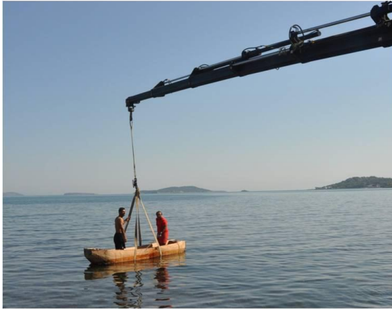
Levha 20: Kanonun Vinç Yardımı ile Tartılması ve Denize İndirilmesi
