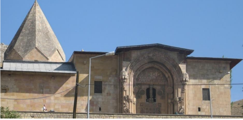
Fotoğraf 4: Divriği Darüşşifası'nın batı cephesi (batıdan)
