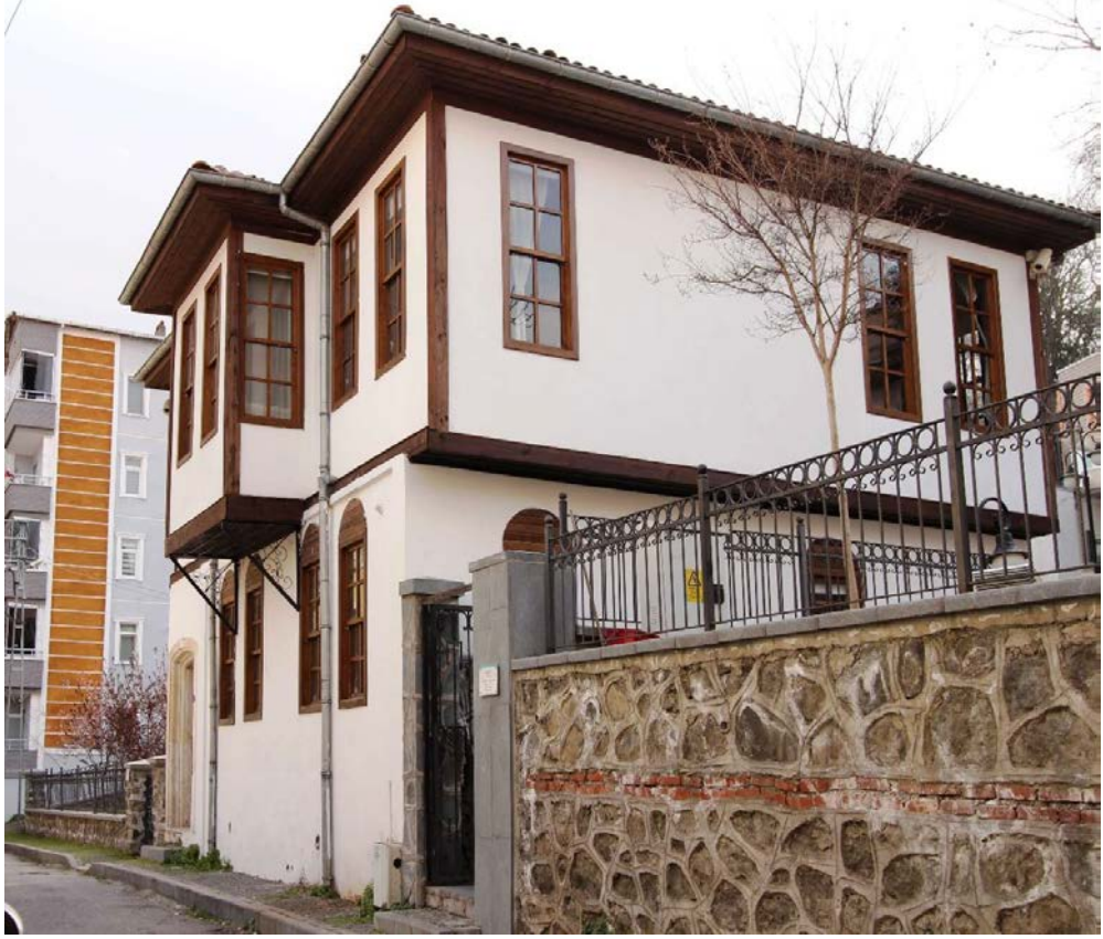
Foto. 123: Şehit-Gazi ve Anı Evi'nin Doğu ve Kuzey Cephesi
