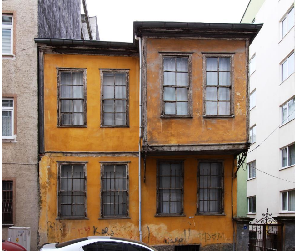
Foto. 229: Gündoğdu Evi'nin Doğu Cephesi
