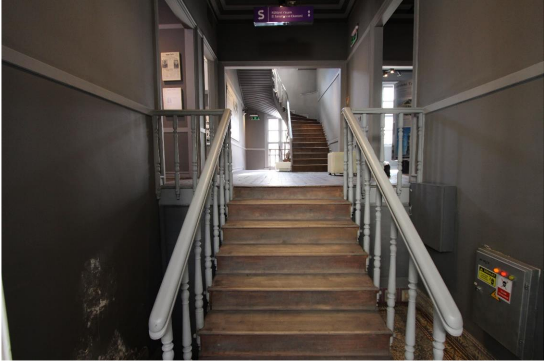
Foto. 585: Kent Müzesi A Blok Zemin Kat Merdiven Düzenlemesi
