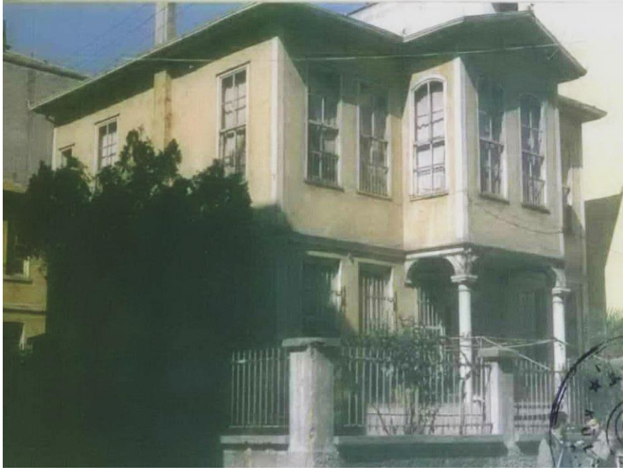
Foto. 506: OMÜ İlim Sanat ve Kültür Evi'nin Onarım Öncesi Hali (SKVKBK 1990)
