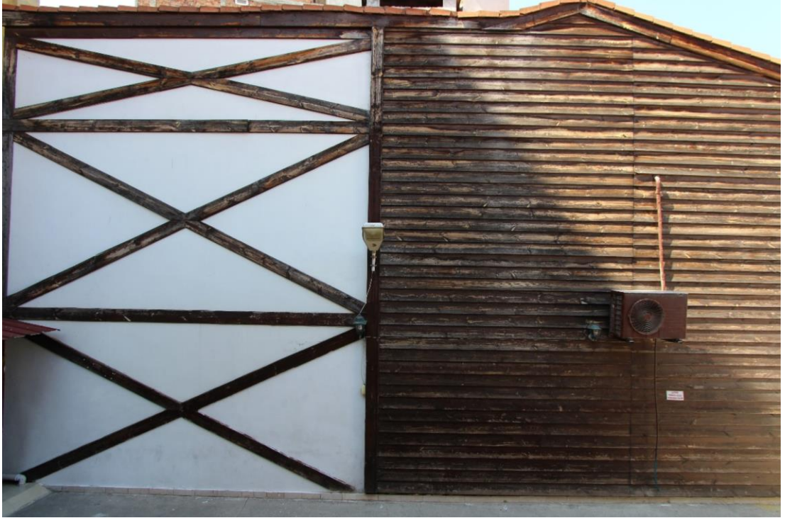
Foto. 545: Fatma Akyüz Evi'nin Güneydoğu Cephesi
