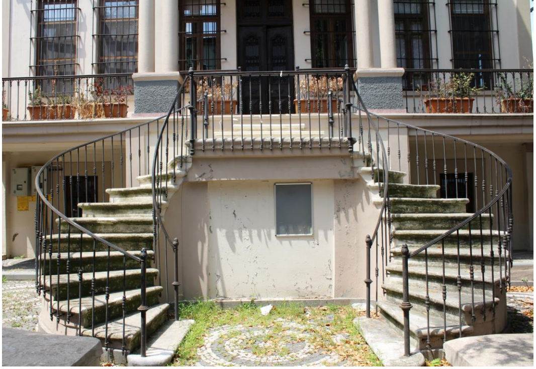
Foto. 244: Paşa Konağı Sahanlığa Çıkan Merdiven Detayı
