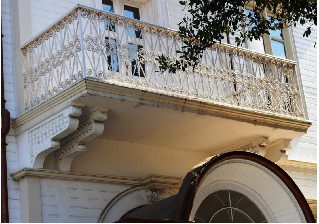
Foto. 577: Kent Müzesi Kuzeybatı Cephedeki Balkon
