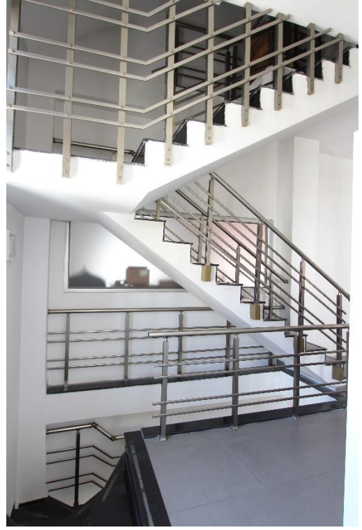
Foto. 308: Lazzade Kaşif Bey Evi Merdivenlerin Günümüzdeki Durumu
