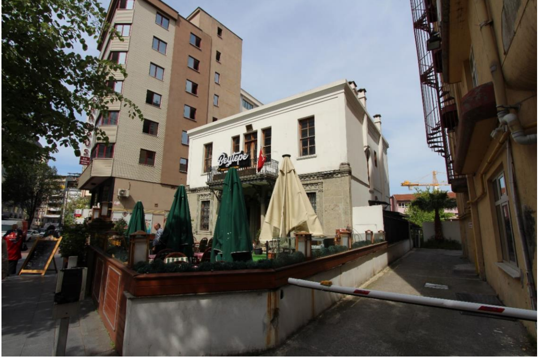
Foto. 329: Fahriye Hanım Konağı'nın Çevresiyle Birlikte Görünümü
