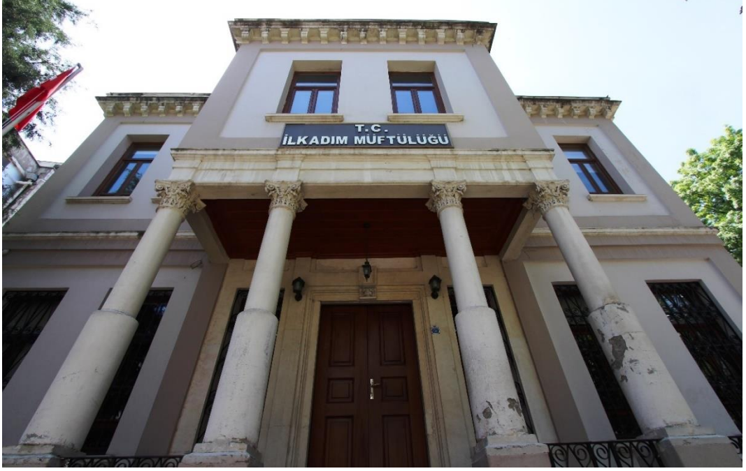
Foto. 481: İlkadım Müftülüğü'nün Kuzey Cephesi
