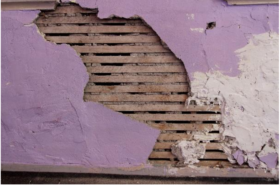
Foto. 299: Abdül Demirci Evi'nin İç Duvarlardaki Bağdadi Tekniği Detayı
