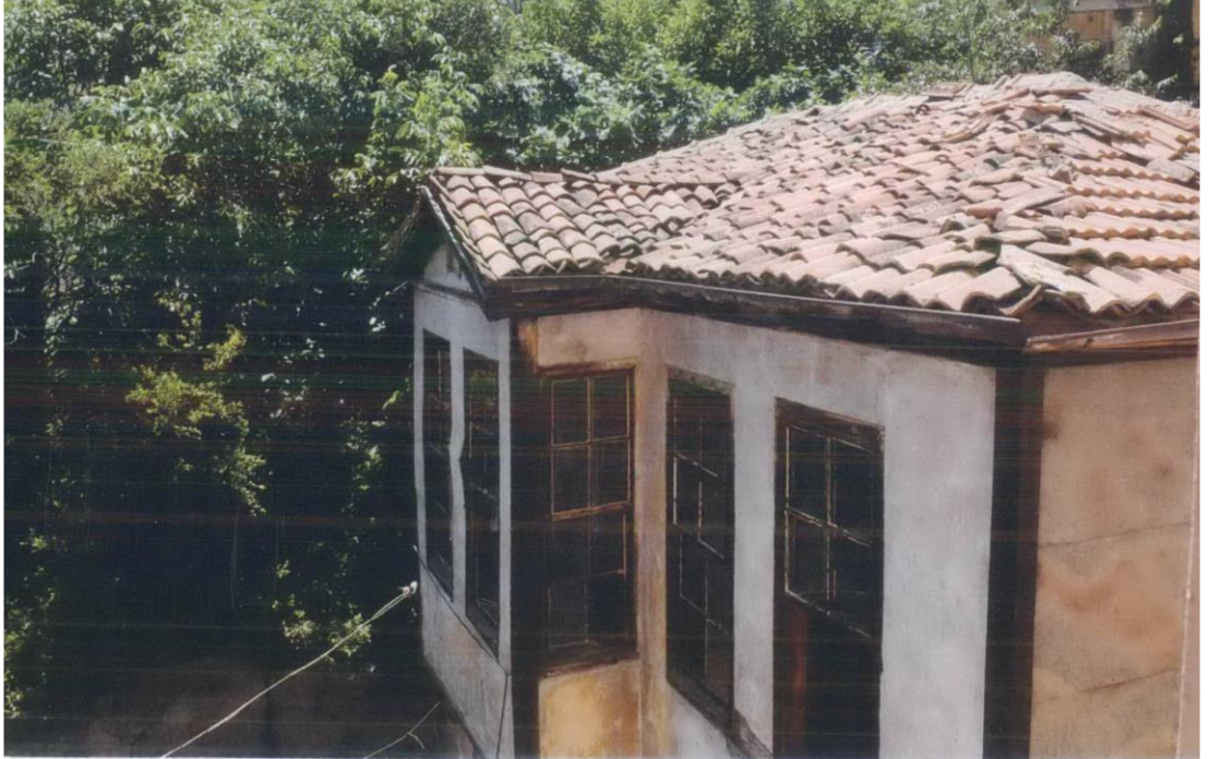
Foto. 178: Ahmet Şevki Özturan Evi'nin Çatı ve Sofa Ayrıntısı (SKVKBK 2014)
