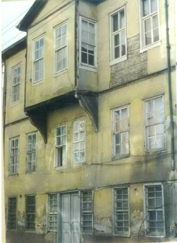
Foto. 685: Hakkıbey Sokak 44 Numaralı Ev Ön cephe Ayrıntı (SKVKBK 1991)
