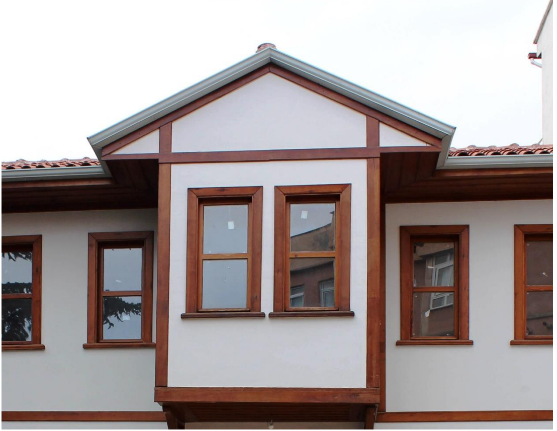
Foto. 177: Ahmet Şevki Özturan Evi'nin Çıkma Ayrıntısı ve Üçgen Alınlık
