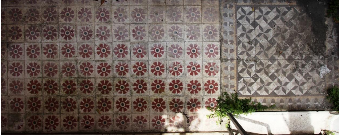
Foto. 265: İkiz Ev Merdiven Sahanlığı Karo Döşeme
