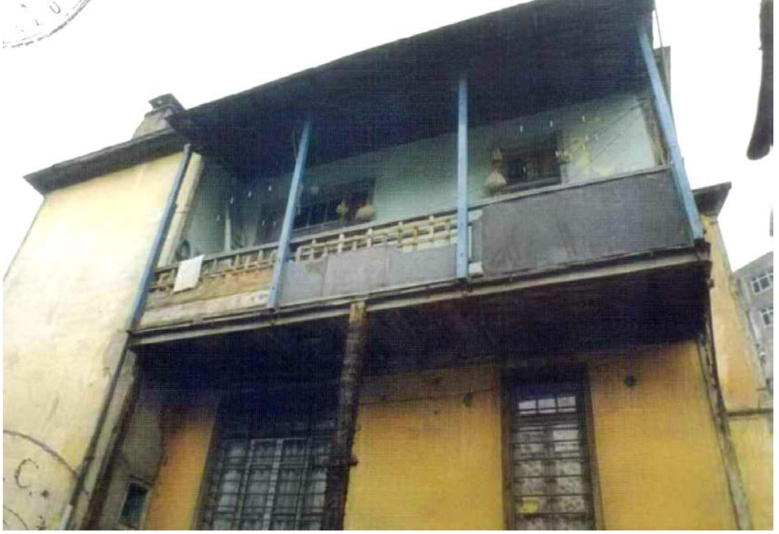
Foto. 673: Çıraklar Evi Güney Cephesi (SKVKBK 1987)
