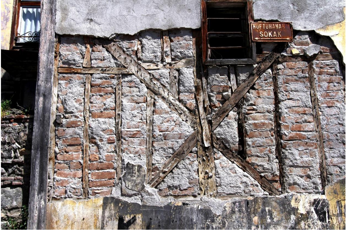
Foto. 97: Müftü Hamam Sokak 28 Numaralı Ev'deki Ahşap Karkas Arası Tuğla Dolgu Tekniği Ayrıntısı
