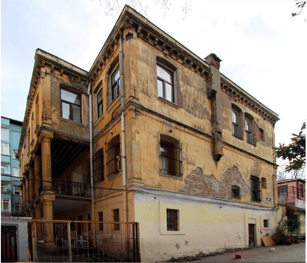
Foto. 395: Ahmet Tos Evi'nin Kuzeyden Görünümü
