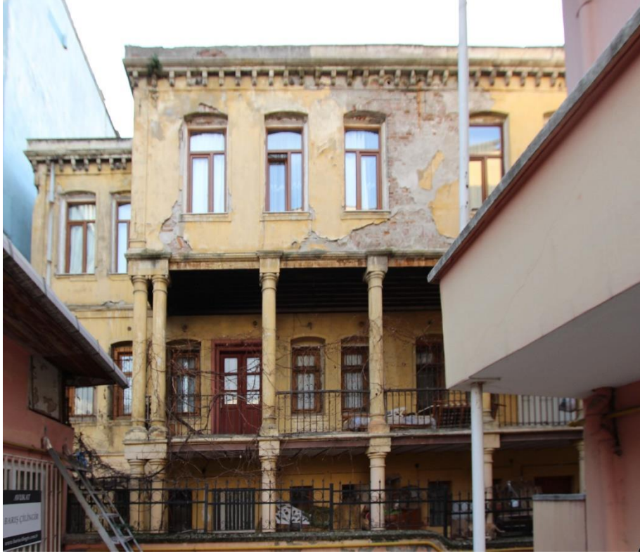
Foto. 396: Ahmet Tos Evi'nin Kuzeydoğu Cephesi
