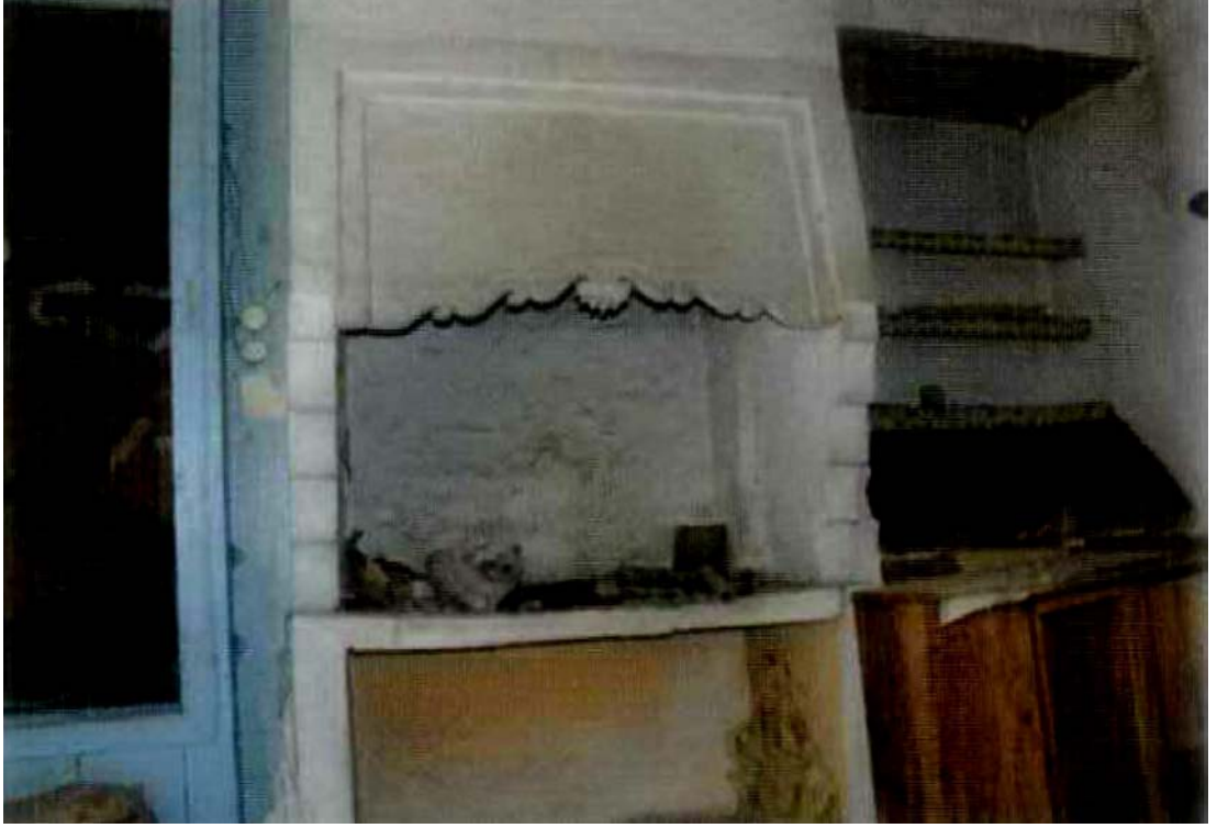
Foto. 536: Fethi Akyüz Evi Zemin Kat Kuzeydoğu Köşedeki Oda
