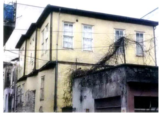
Foto. 689: Hakkıbey Sokak 44 Numaralı Evin Arka ve Yan Cephesi (SKVKBK 1994)
