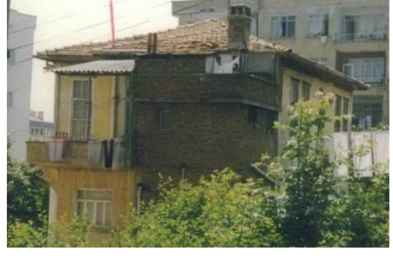
Foto. 652: Demireller Evi'nin Batı Cehesinden Görünüm (SKVKBK 1991)
