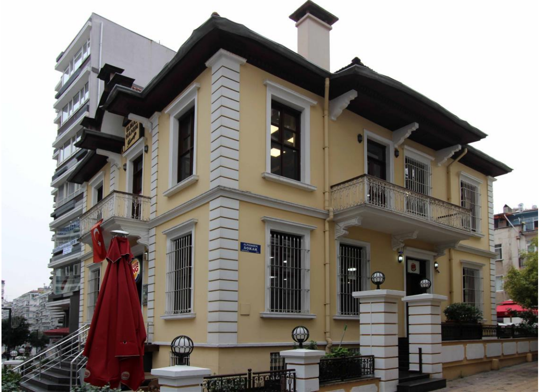
Foto. 610: Elmas Hanım Konağı'nın Kuzeyden Görünümü
