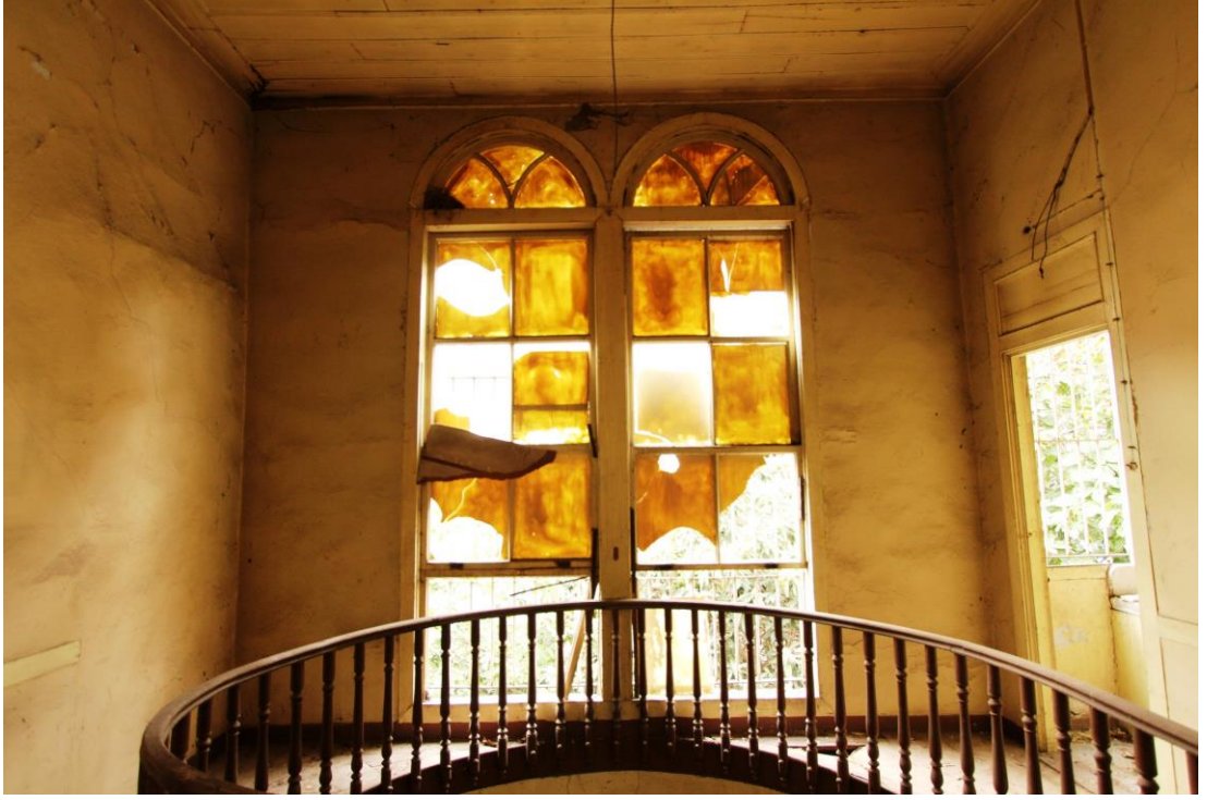
Foto. 12: Alemdarzadeler Evi'nin Merdiven Sofası ve Pencereleeri
