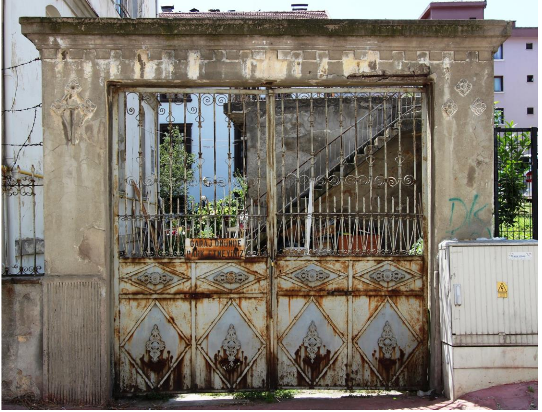
Foto. 205: Necip Özüdođru Evi'nin Kuzey Yöndeki Avluya Geçiş Kapısı
