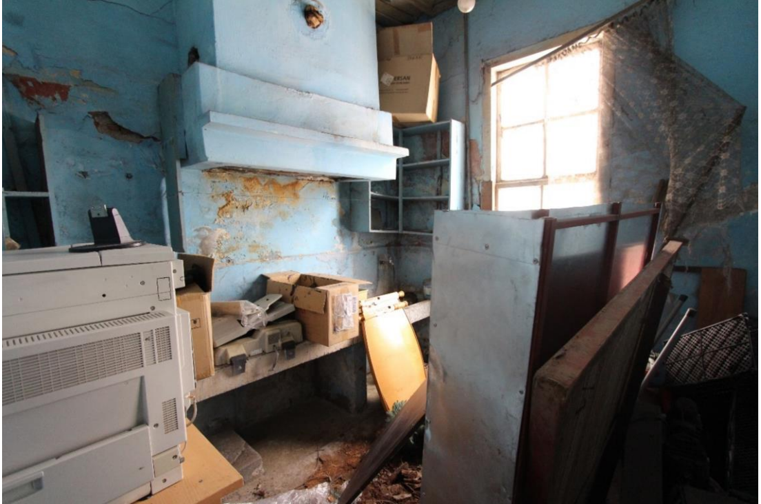
Foto. 445: İrfan Tamtürk Evi Zemin Kat Mutfağı
