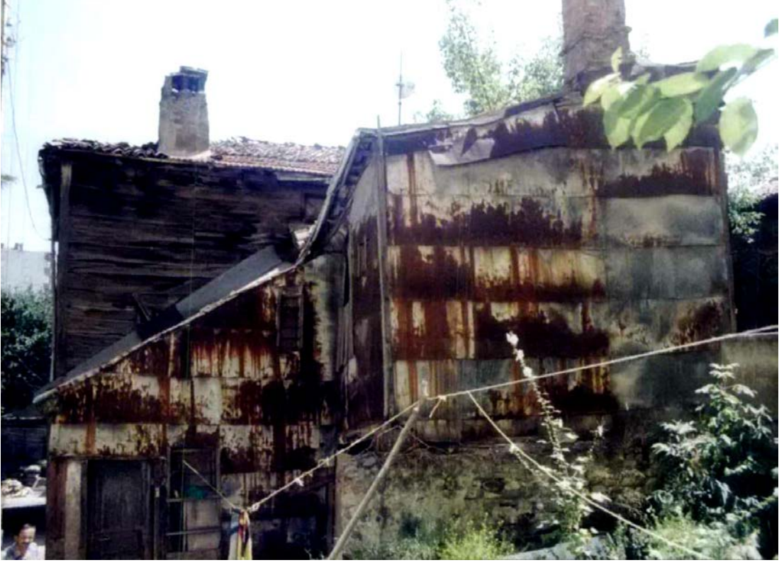
Foto. 546: Fatma Akyüz Evi'nin Batı Cephesi (SKVKBK 1997)
