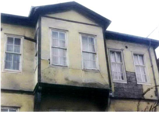
Foto. 688: Hakkıbey Sokak 44 Numaralı Evin Çıkma Ayrıntısı (SKVKBK 1991)
