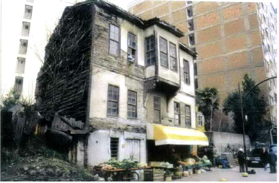
Foto. 544: Fatma Akyüz Evi'nin Kuzeydoğu Cephe Görünümü (SKVKBK 2006)
