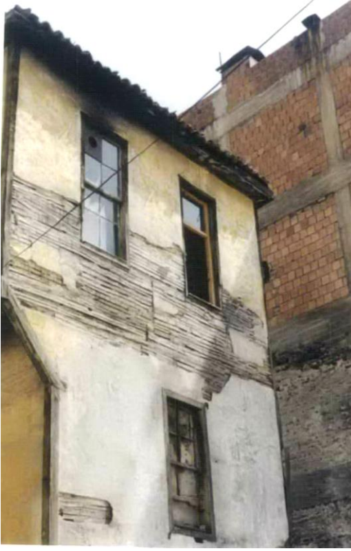
Foto. 746: Medrese Sokak ile Şeyh Hamza Sokağı'nın Kesiştiği Köşedeki Evin Sağ Cephesi (SKVKBK 2000)
