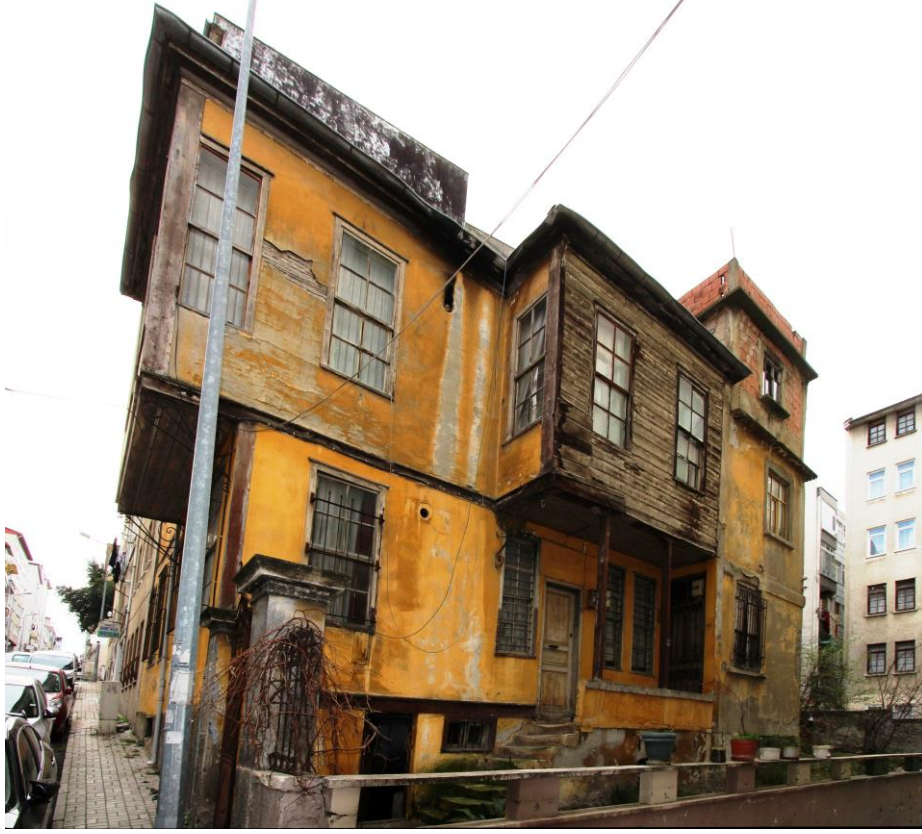
Foto. 230: Gündoğdu Evi'nin Kuzey Cephesi
