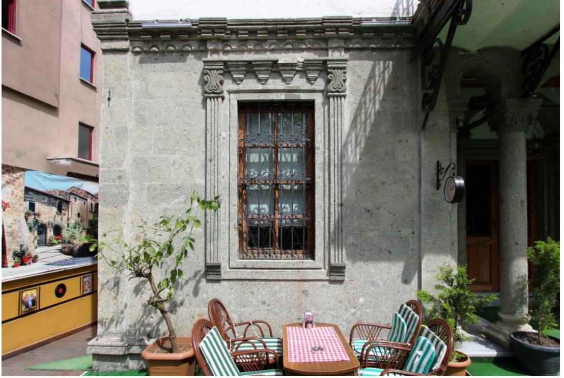
Foto. 337: Fahriye Hanım Konağı Batı Cephe Pencere Düzenlemesi
