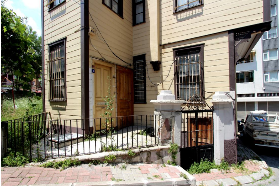
Foto. 290: Abdül Demirci Evi Avlu, Zemin ve Birinci Kata Geçiş Kapıları
