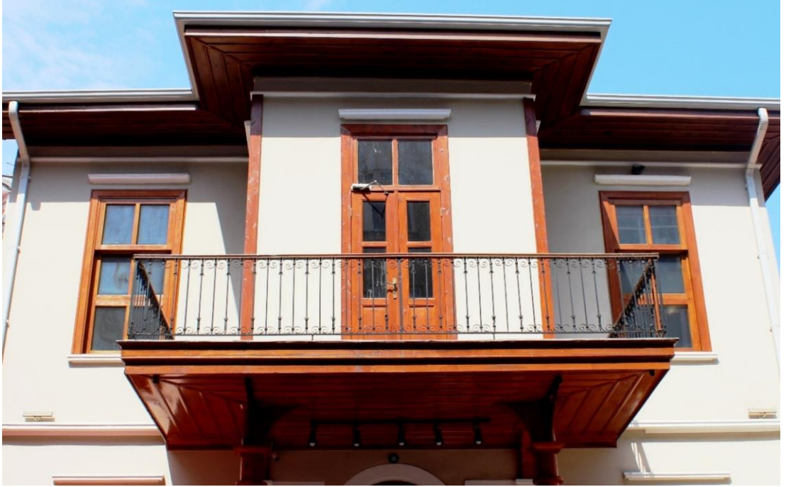
Foto. 521: Musa Arslan Evi'nin Doğu Cephe Birinci Kat Çıkma ve Balkon
