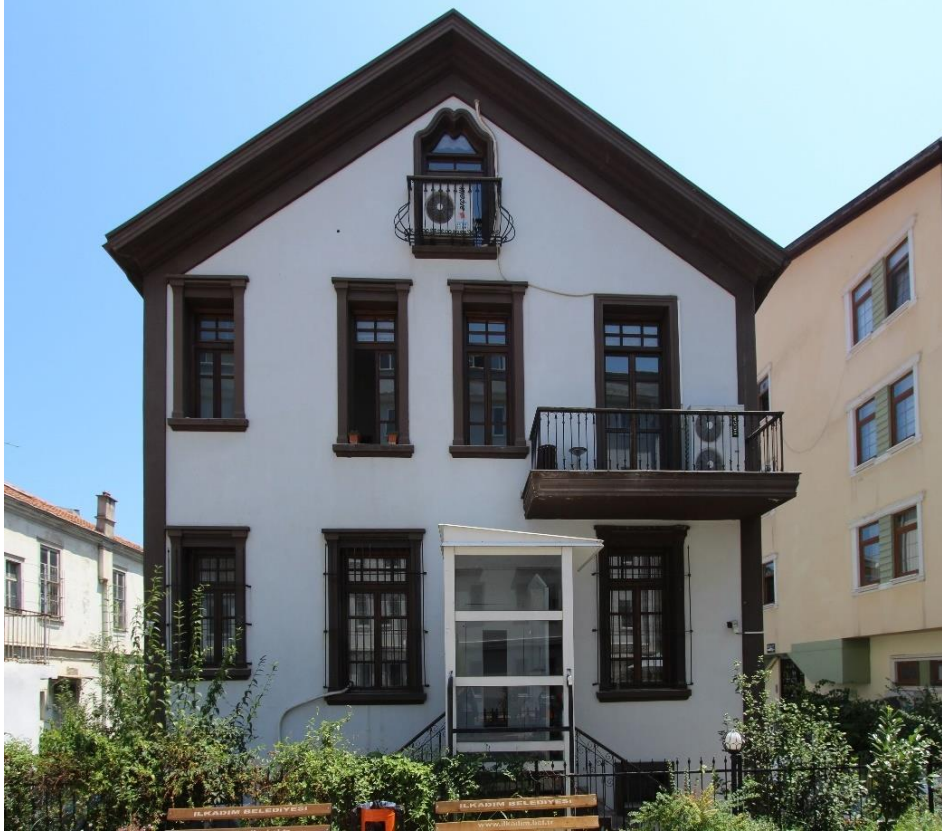
Foto. 303: Lazzade Kaşif Bey Evi'nin Batı Cephe Görünümü
