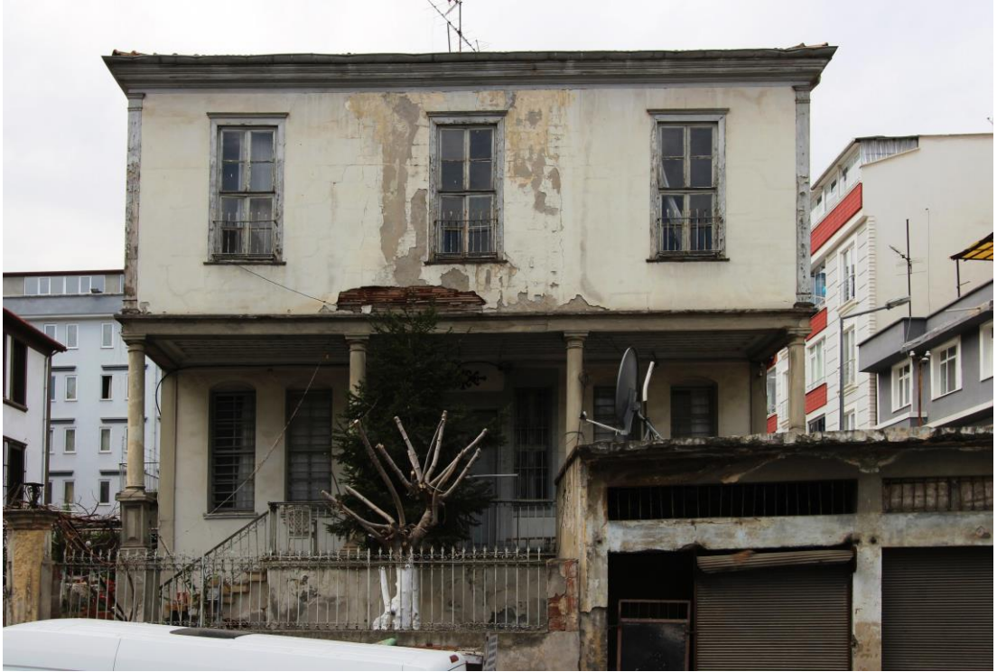
Foto. 199: Necip Özüdođru Evi'nin Dođu Cephesi
