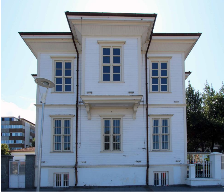
Foto. 572: Kent Müzesi A Blok Kuzeydoğu Cephesi
