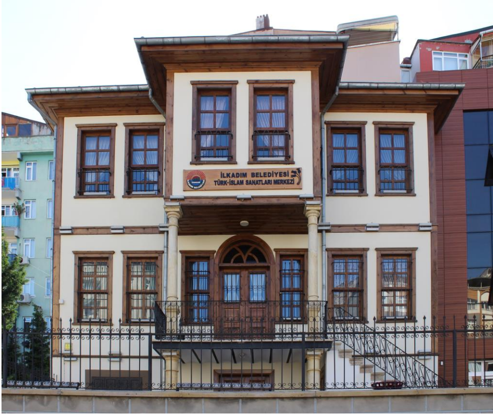
Foto. 43: Türk İslam Sanatları Merkezi'nin Kuzey Cephe Görünümü
