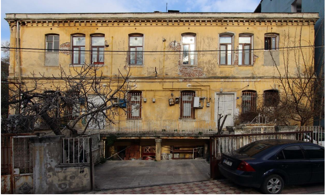
Foto. 398: Ahmet Tos Evi'nin Güneybatı Cephesi
