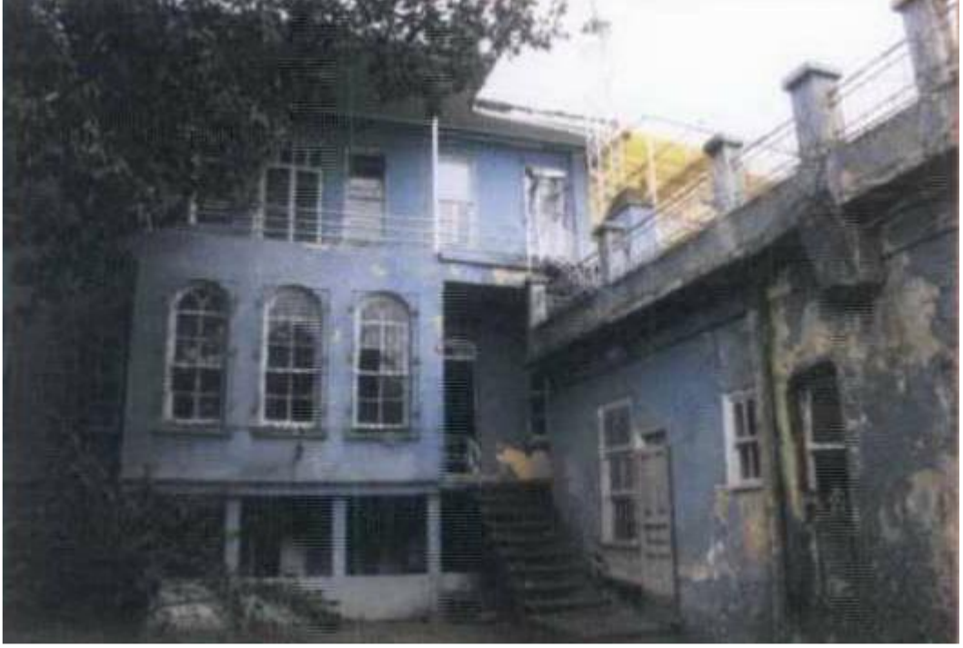
Foto. 592: Yapının Onarım Öncesi Görünümü (SKVKBK 2008)
