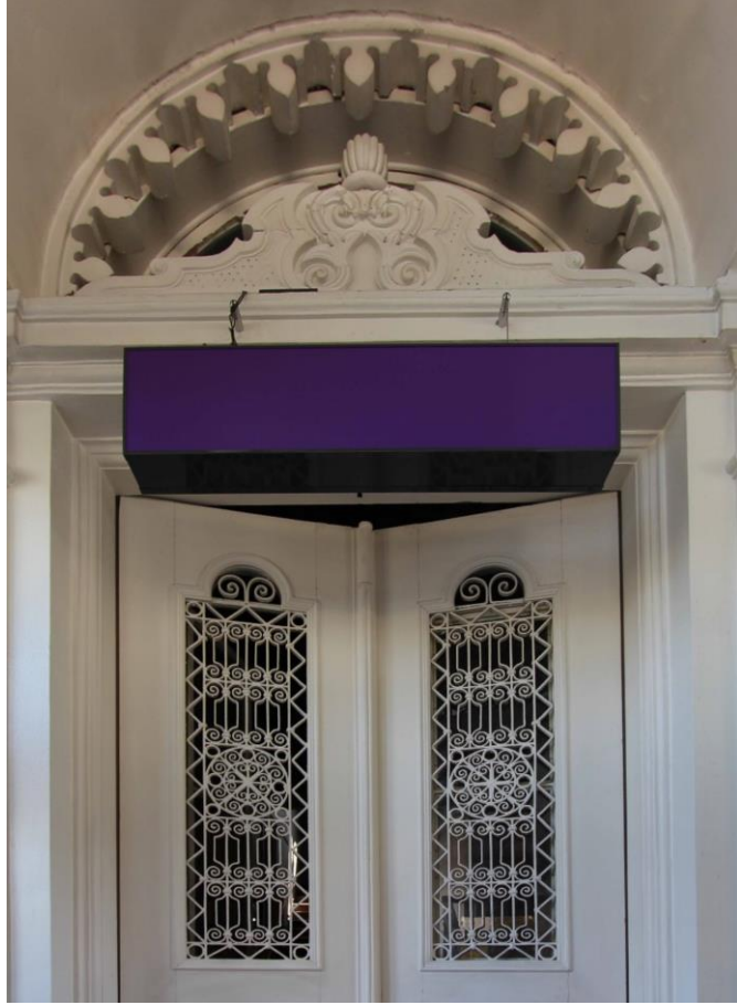
Foto. 579: Kent Müzesi Kuzeybatı Cephe Yapıya Geçiş Kapı Düzenlemesi
