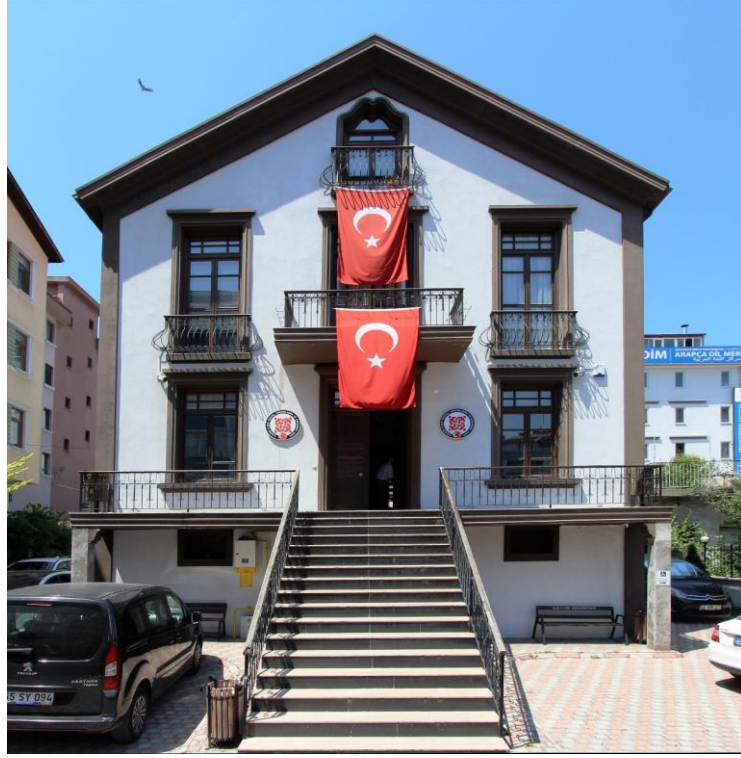
Foto. 301: Lazzade Kaşif Bey Evi'nin Doğu Cephe Görünümü
