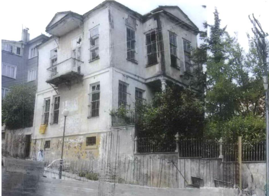
Foto. 2: Alemdarzadeler Evi Doğu ve Güney Cephe Görünümü (SKVKBK 2007)
