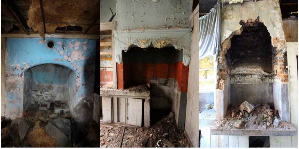
Foto. 163, 164, 165: Çayır Sokak 36 Numaralı Evin Bodrum, Zemin ve Birinci Kat Ocakları
