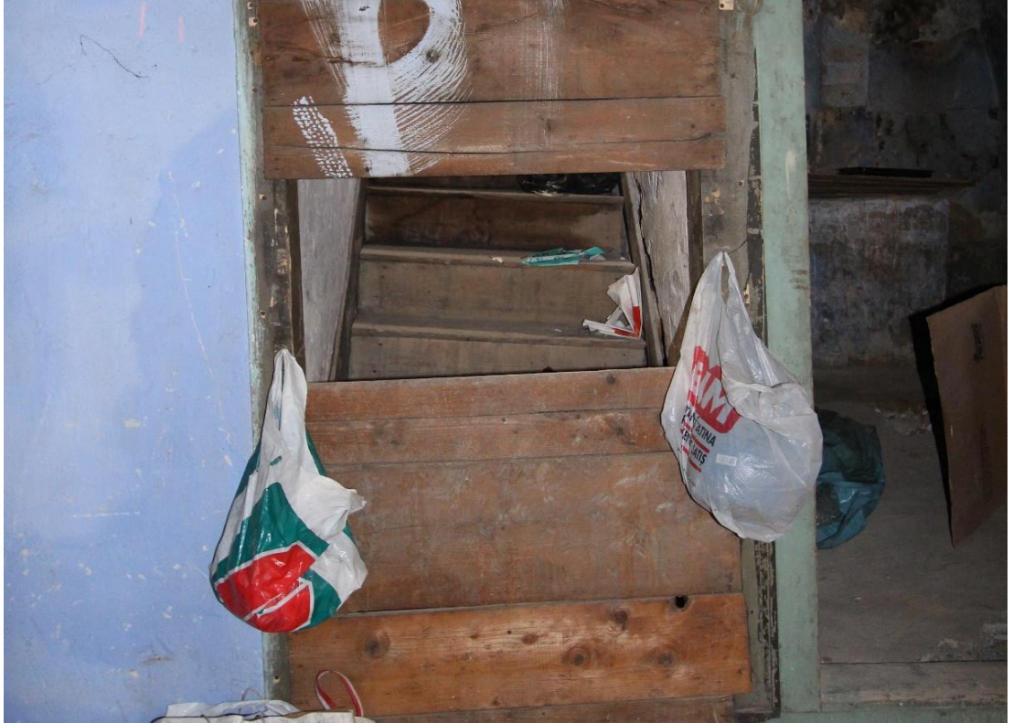
Foto. 211: İptal Edilen Bodrum ve Zemin Kat Arası Bağlantı Sağlayan Merdiveni
