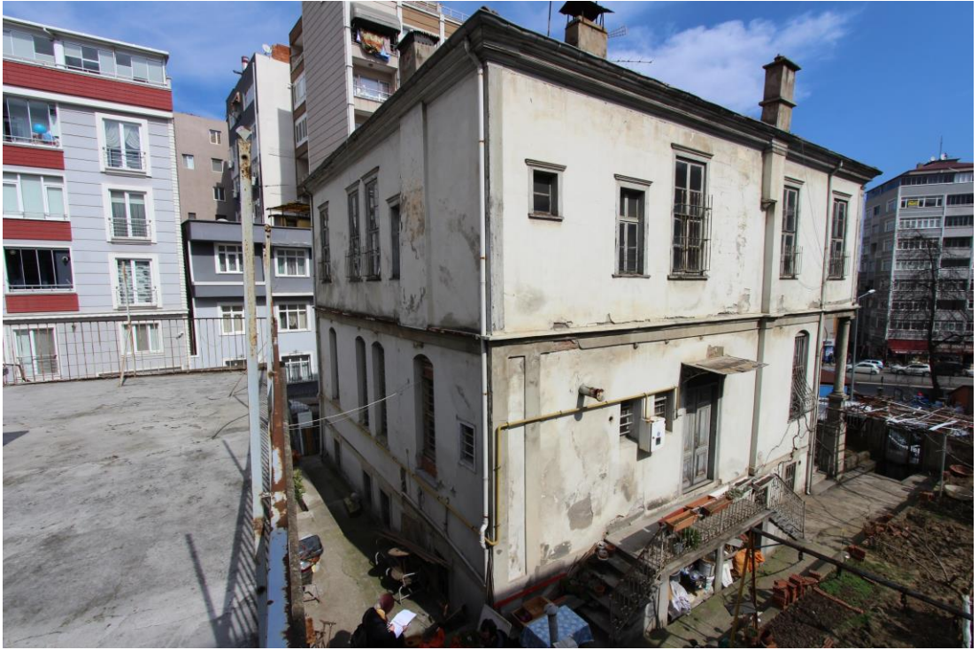
Foto. 201: Necip Özudođru Evi'nin Güneybatıdan Görünümü
