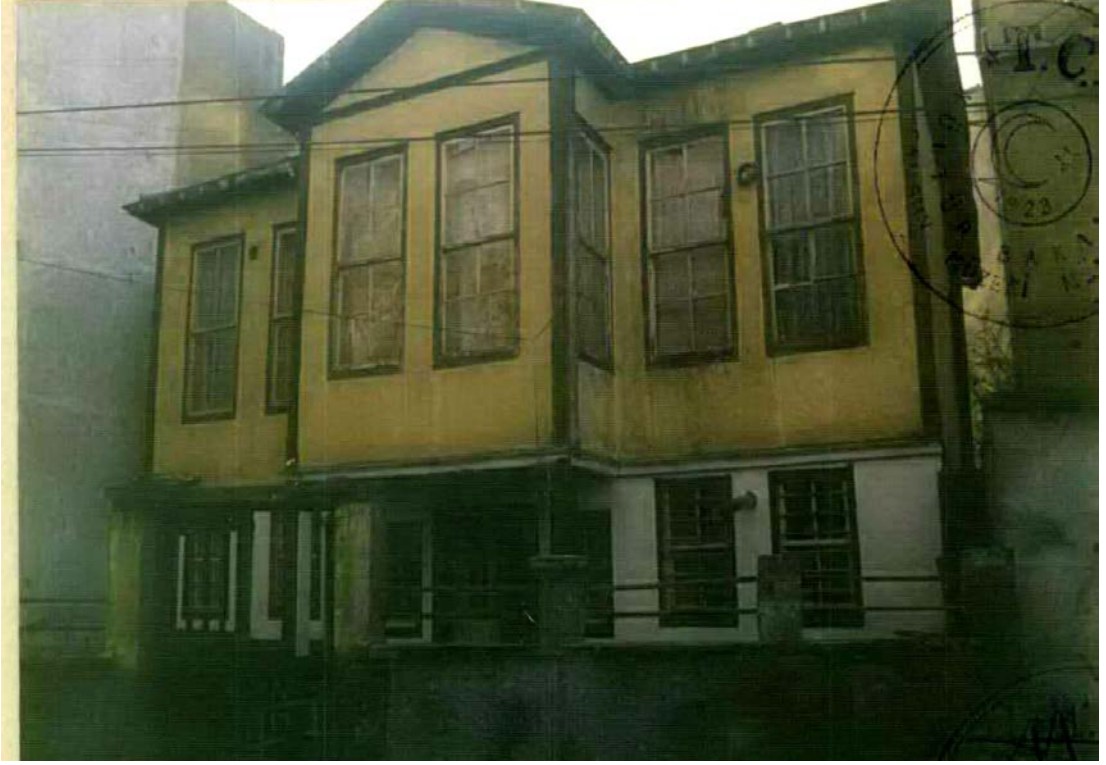
Foto. 692: Osman Şentürk Evi Kuzey Cephesi (SKVKBK 1990)
