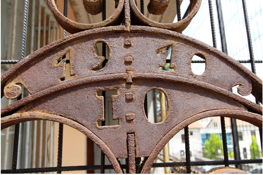
Foto. 286: İbrahim Fevzi Evi Güney Yöndeki Demir Kapı
