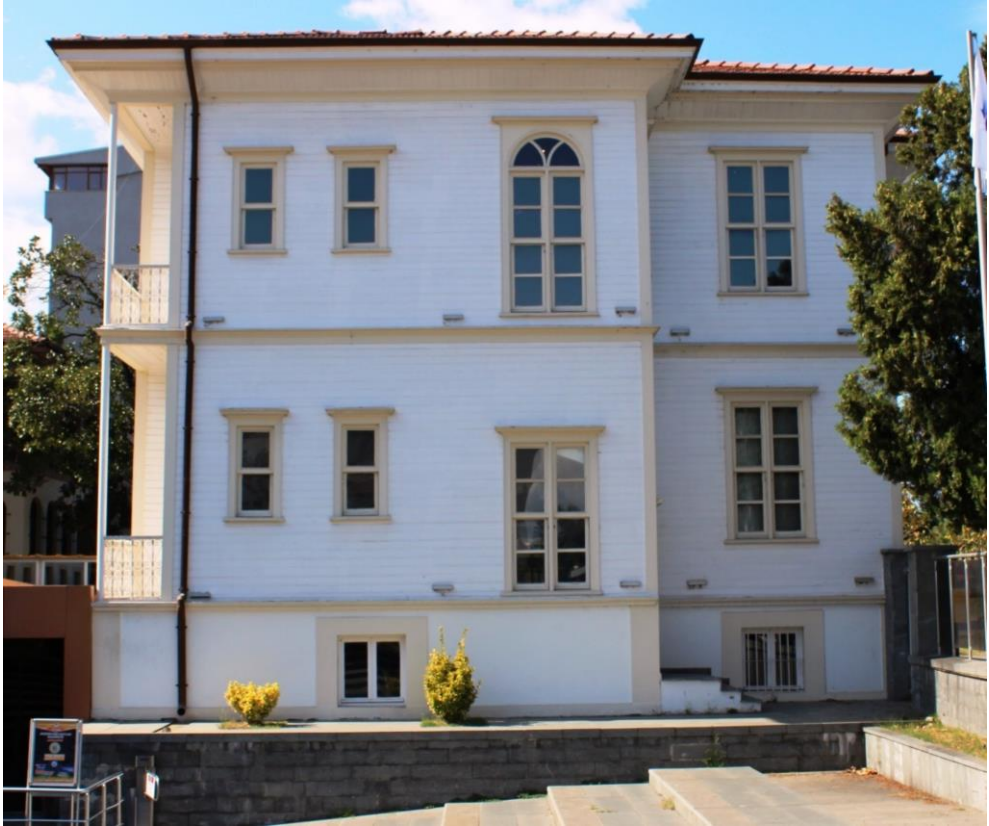
Foto. 573: Kent Müzesi A Blok Güneydoğu Cephesi
