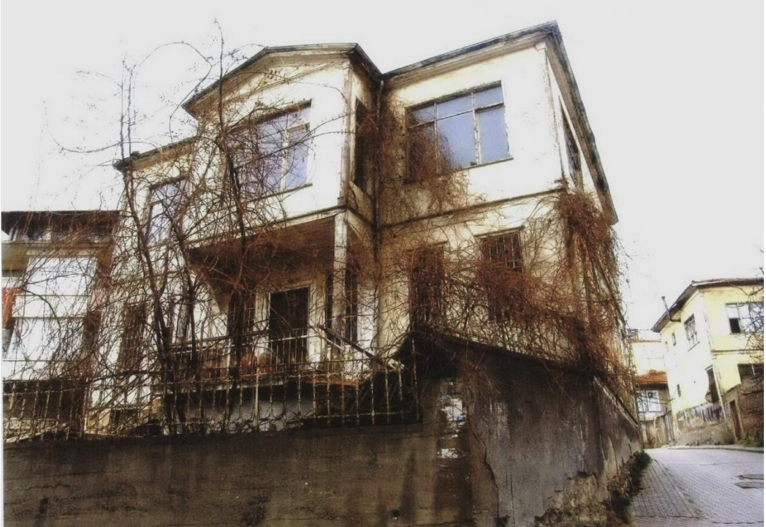
Foto. 79: Sandıkçızade Evi'nin Kuzeydoğu Cephesi Onarım Öncesi Görünümü (SKVKBK 2007)
