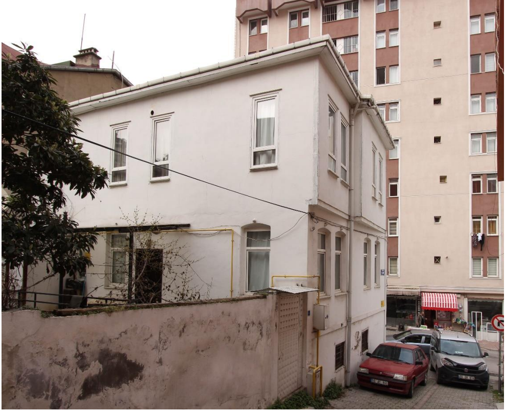
Foto. 58: Yusuf Sar Evi'nin Güneybatı Yönden Görünümü
