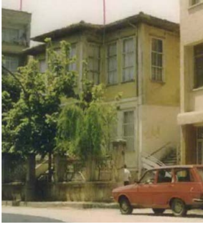
Foto. 653: Demireller Evi'nin Kuzey Cehesi (SKVKBK 1991)
