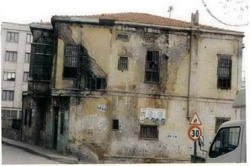
Foto. 645: Pirallar Evi'nin Doğu Cephesinden Görünüm (SKVKBK 2000)
