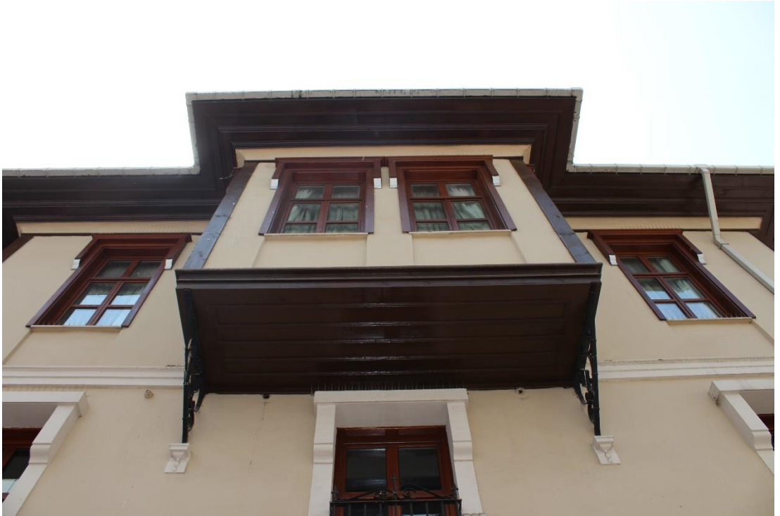
Foto. 419: Asuman Reyhan Evi Kuzeydoğu Cephe Birinci Kat Sofâ Çıkması
