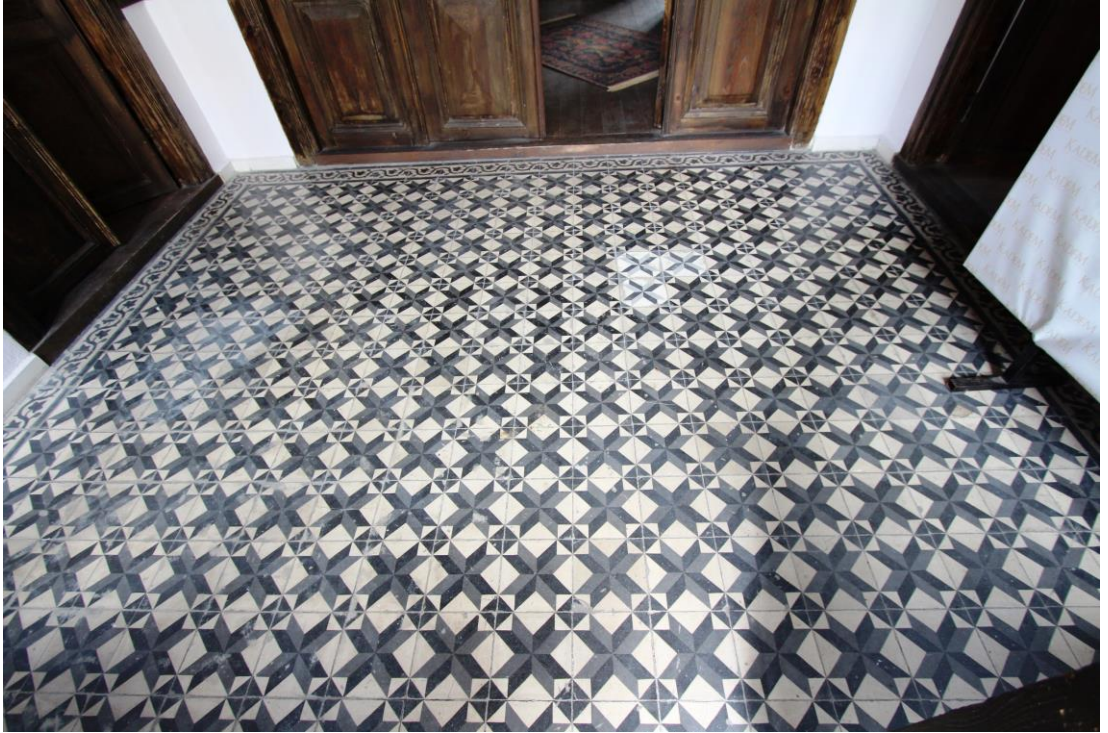
Foto. 249: Paşa Konağı'nın Giriş Sofası Döşemesi
