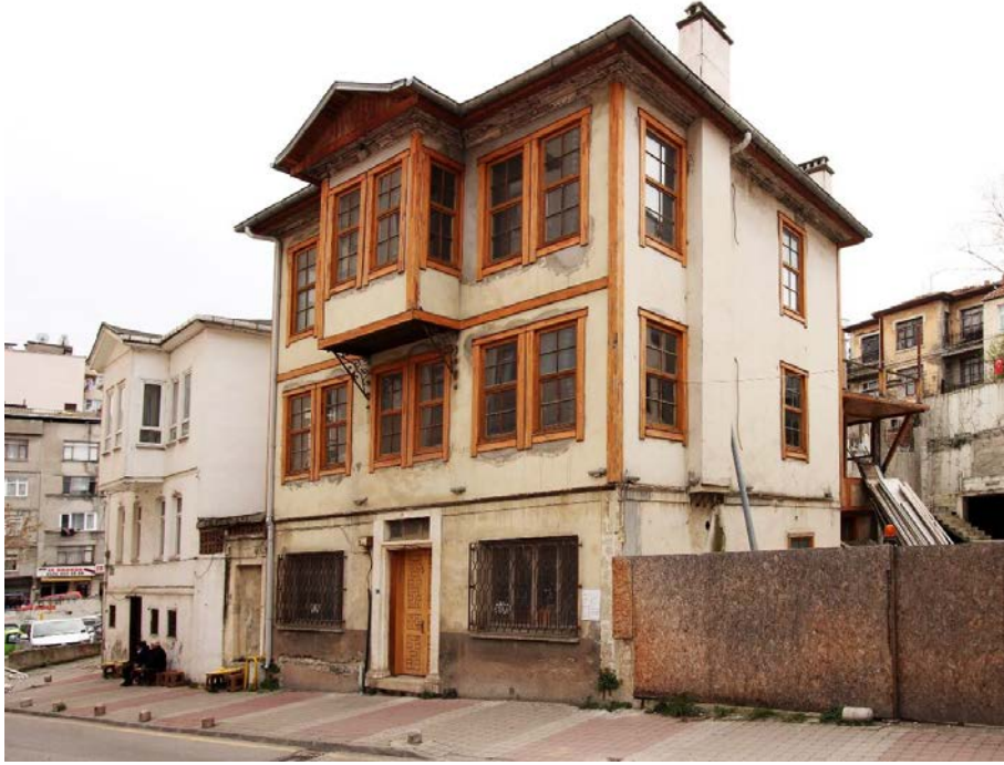
Foto. 61: Ahmet Özder-1 Evi'nin Kuzey Yönden Onarım Sonrası Görünümü
