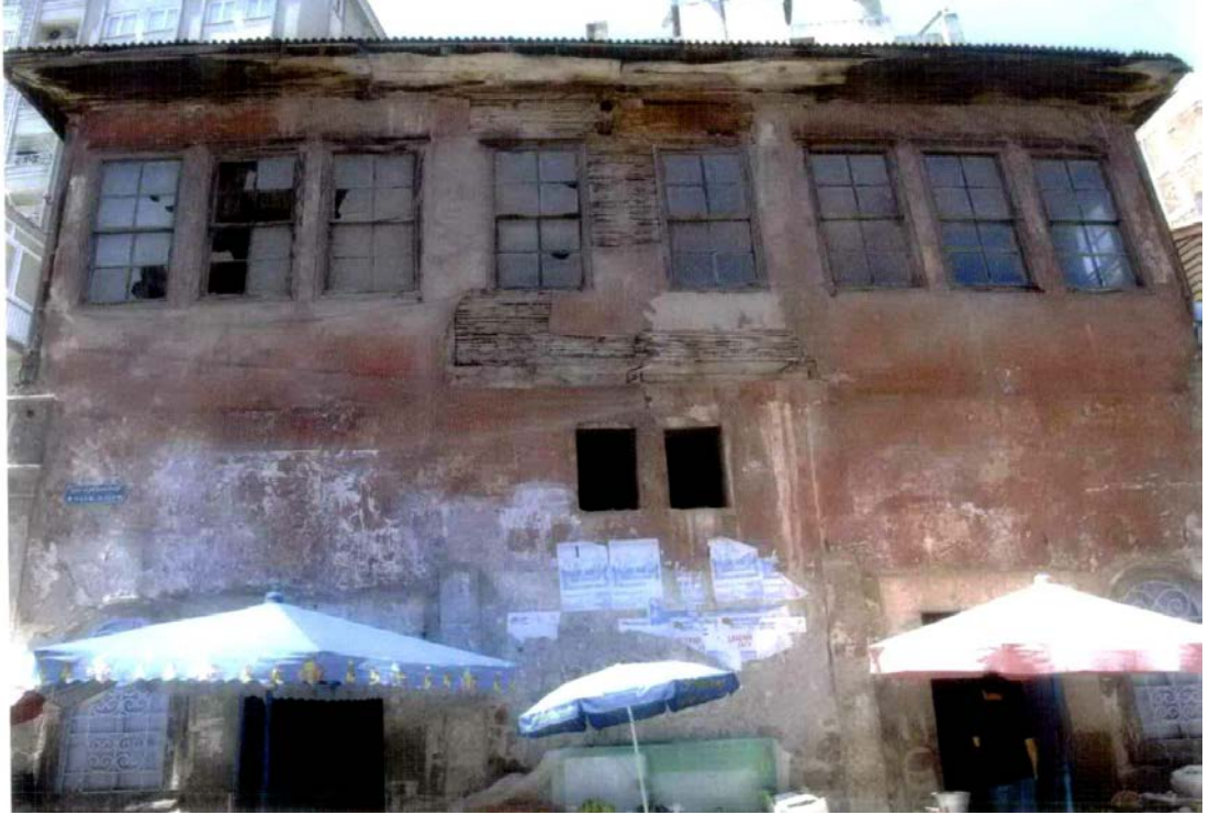
Foto. 531: Doğu Cephe Onarım Öncesi Görünümü (SKVKBK 2006)
