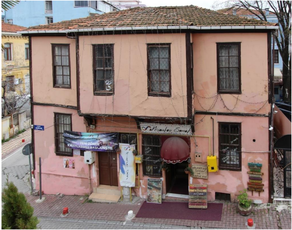
Foto. 344: Cengiz Günaydın Evi'nin Kuzeybatı Cephesi
