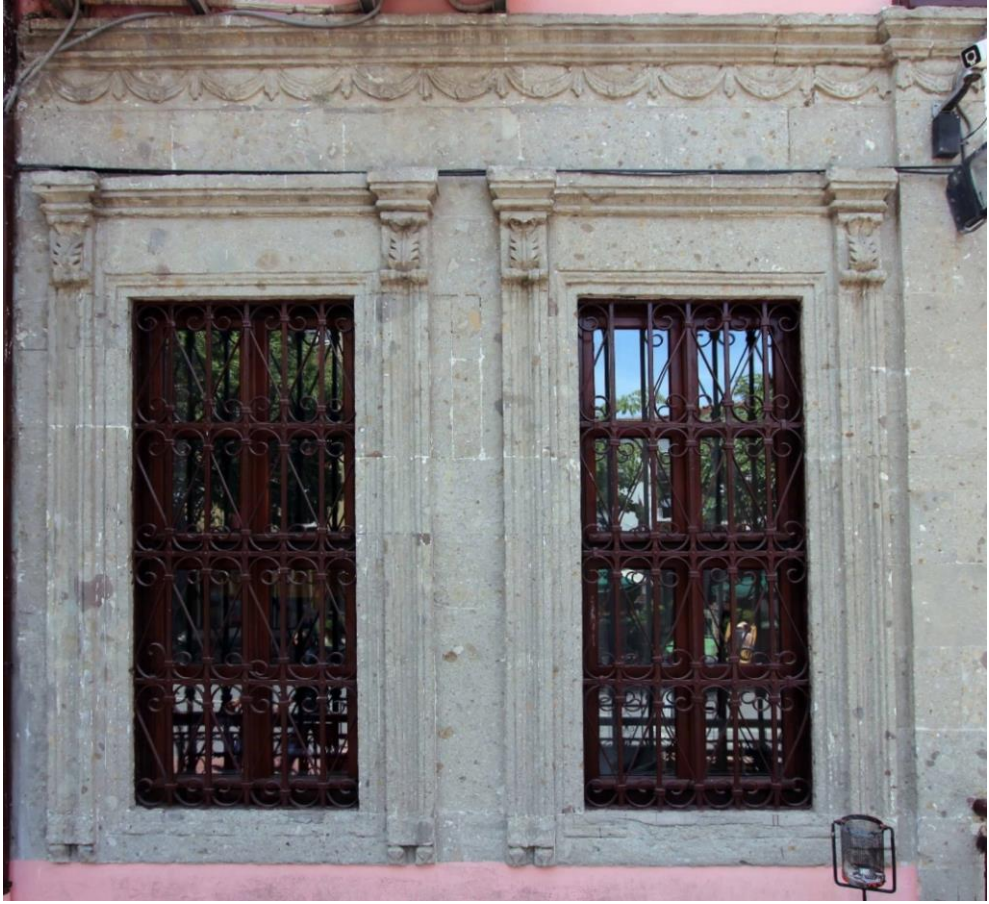
Foto. 499: Yol-İş Sendikası'nın Doğu Cephe Pencere Düzenlemesi
