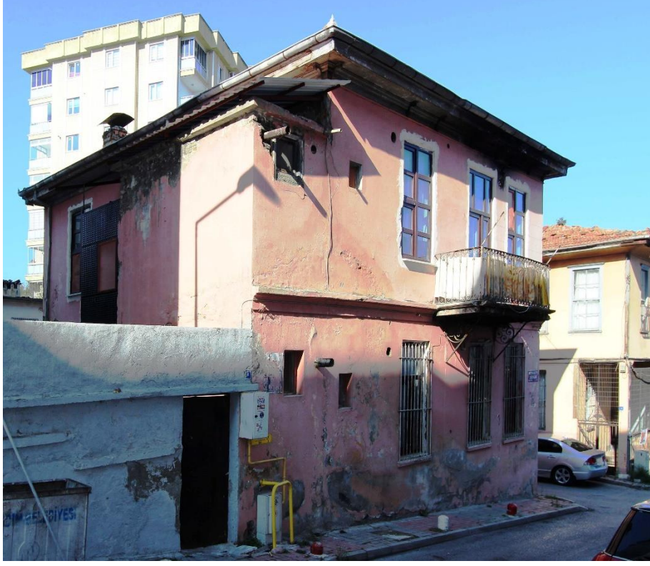
Foto. 260: Paşa Konağı'nın Güneydoğudan Görünümü
