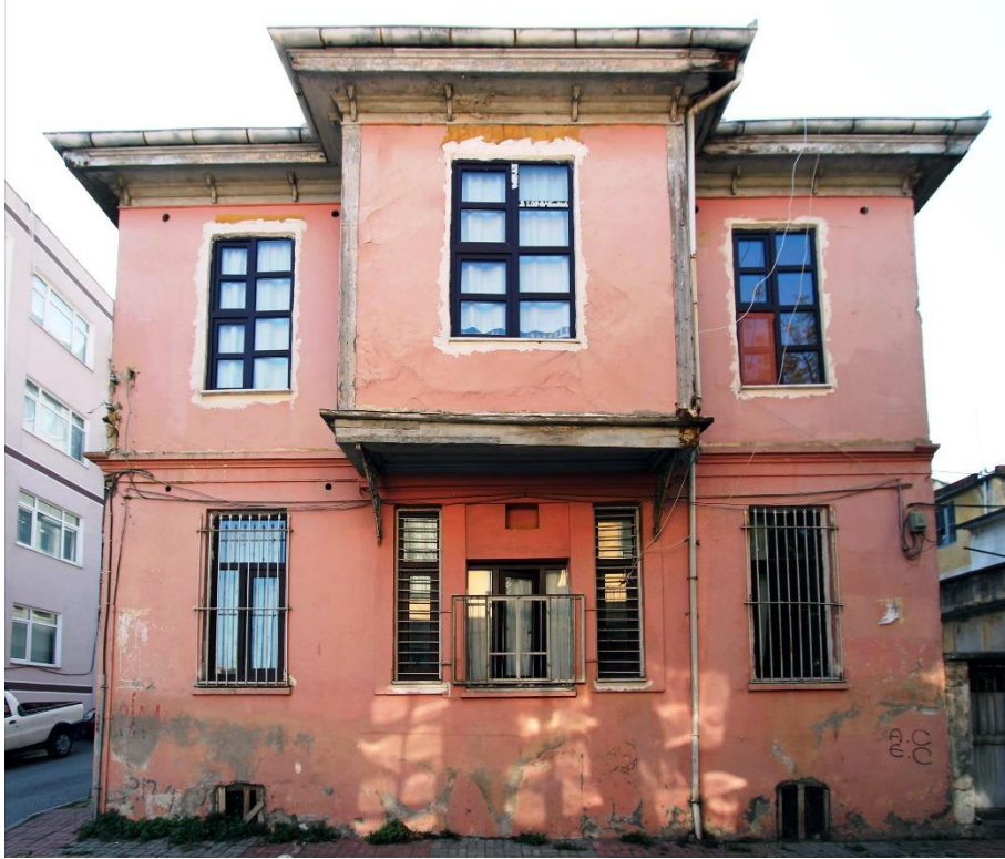
Foto. 259: Paşa Konağı'nın Doğu Cephesi
