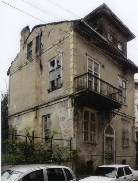
Foto. 268: İkiz Ev A Blok Onarım Öncesi (SKVKBK 2013)
