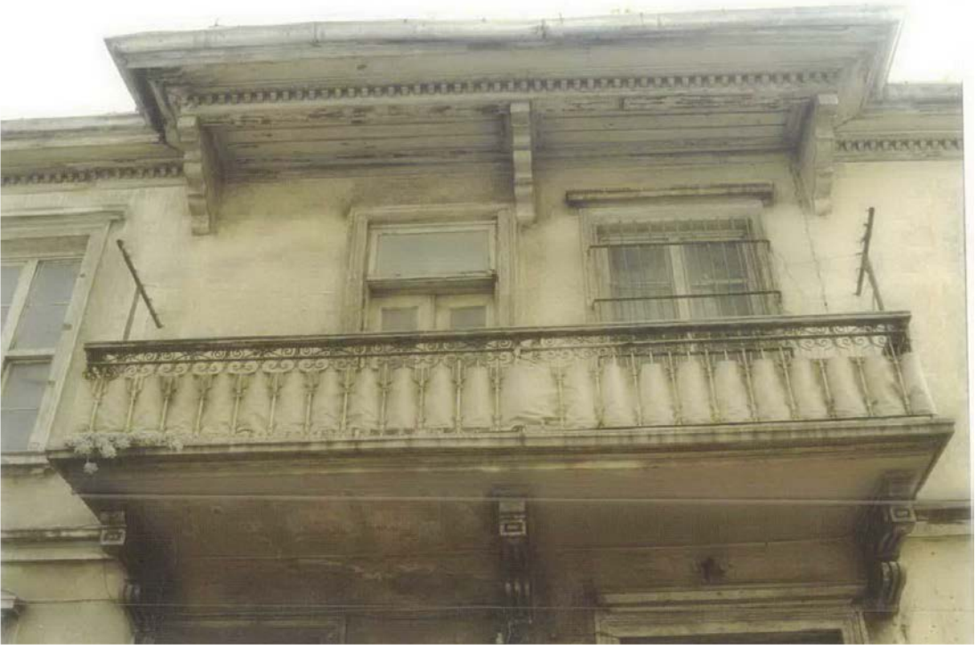
Foto. 611: Kuzeybatı Cephe Balkon ve Saçak Düzenlemesi (SKVKBK 1995)
