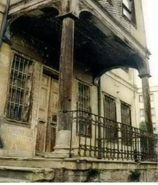
Foto. 646: Pirallar Evi Güney Cephe Sahanlık ve Çıkma Taşıyıcıları (SKVKBK 2000)
