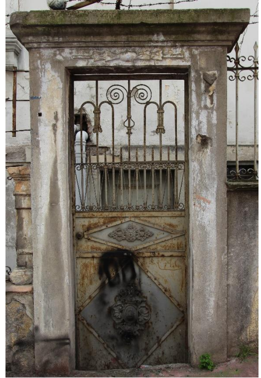
Foto. 204: Necip Özüdođru Evi'nin Kuzey Yöndeki Avluya Geçiş Kapısı
