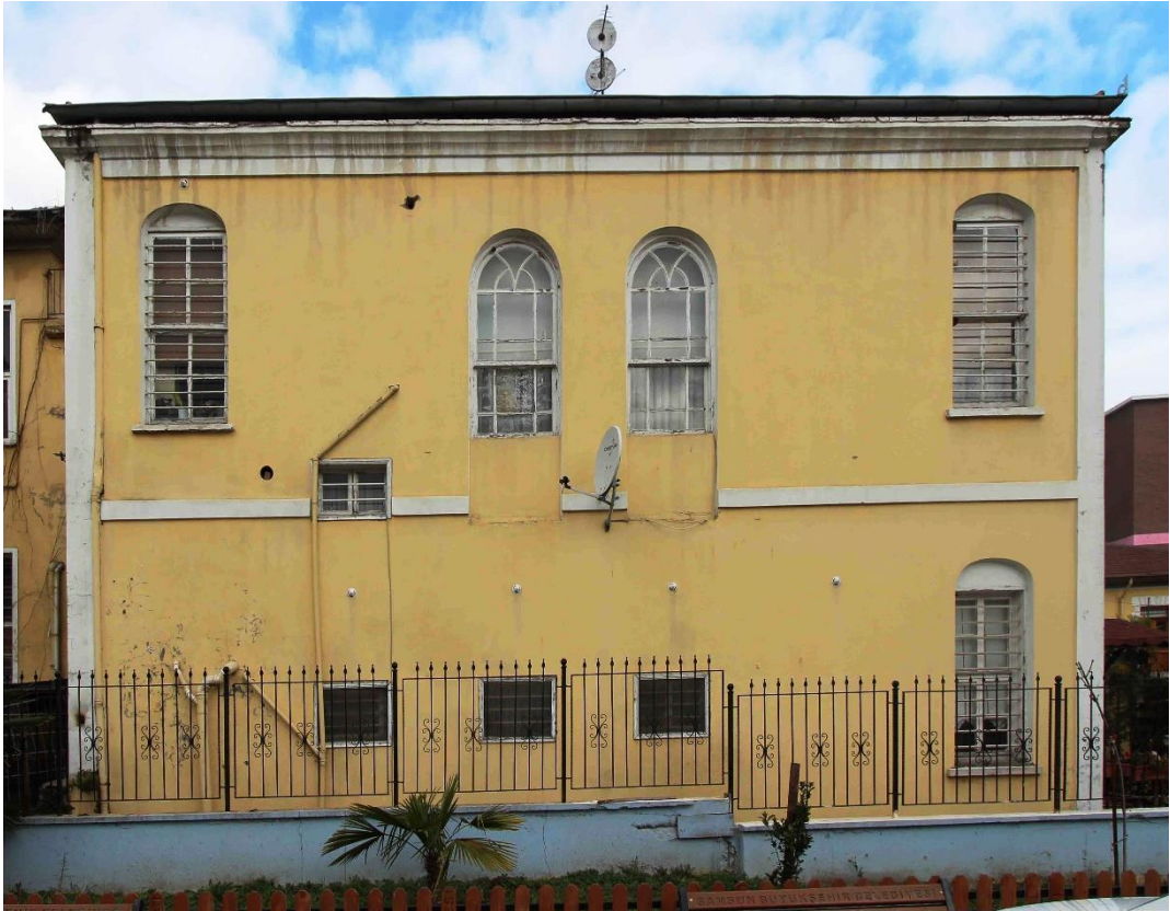
Foto. 354: Ayşe Kardel Evi'nin Güneybatı Cehesi
