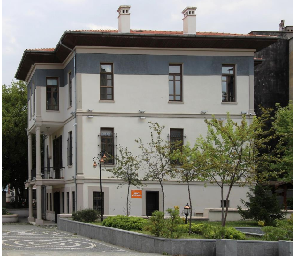
Foto. 246: Paşa Konağı'nın Batı Cephesi
