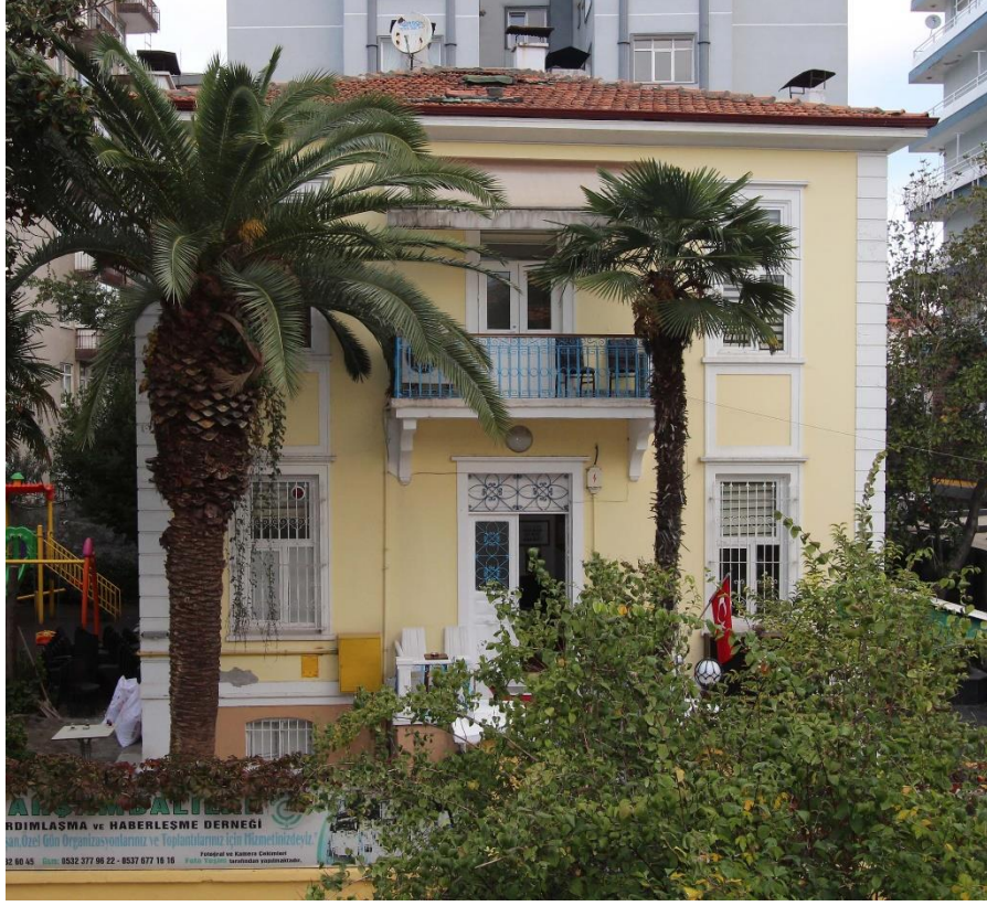
Foto. 380: Çarşambalılar Derneği Güneydoğu Cephesi
