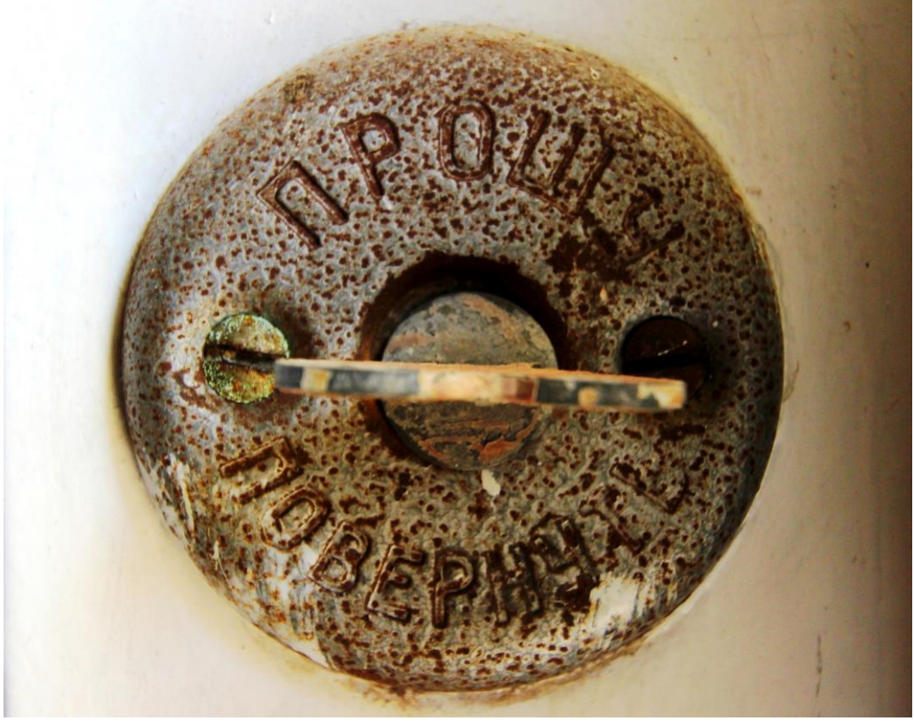
Foto. 355: Ayşe Kardel Evi'ne Geçiş Kapısı Üzerindeki Kilit
