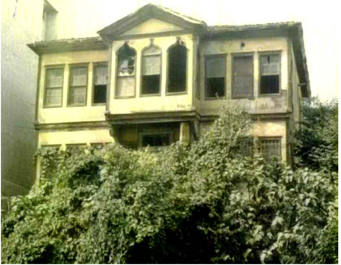
Foto. 627: Şerafettin Tüfekçi Evi'nin Doğu Cephesi (SKVKBK 1991)
