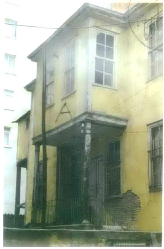
Foto. 734: Sefa Kolbakır Evi'nin Güney Cephesi (SKVKBK 1992)
