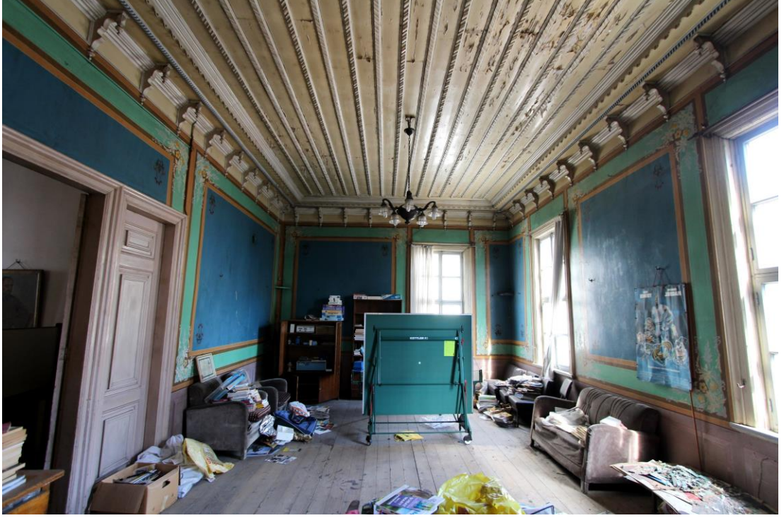
Foto. 219: Necip Özüdođru Evi Bařodanın Genel Görünümü
