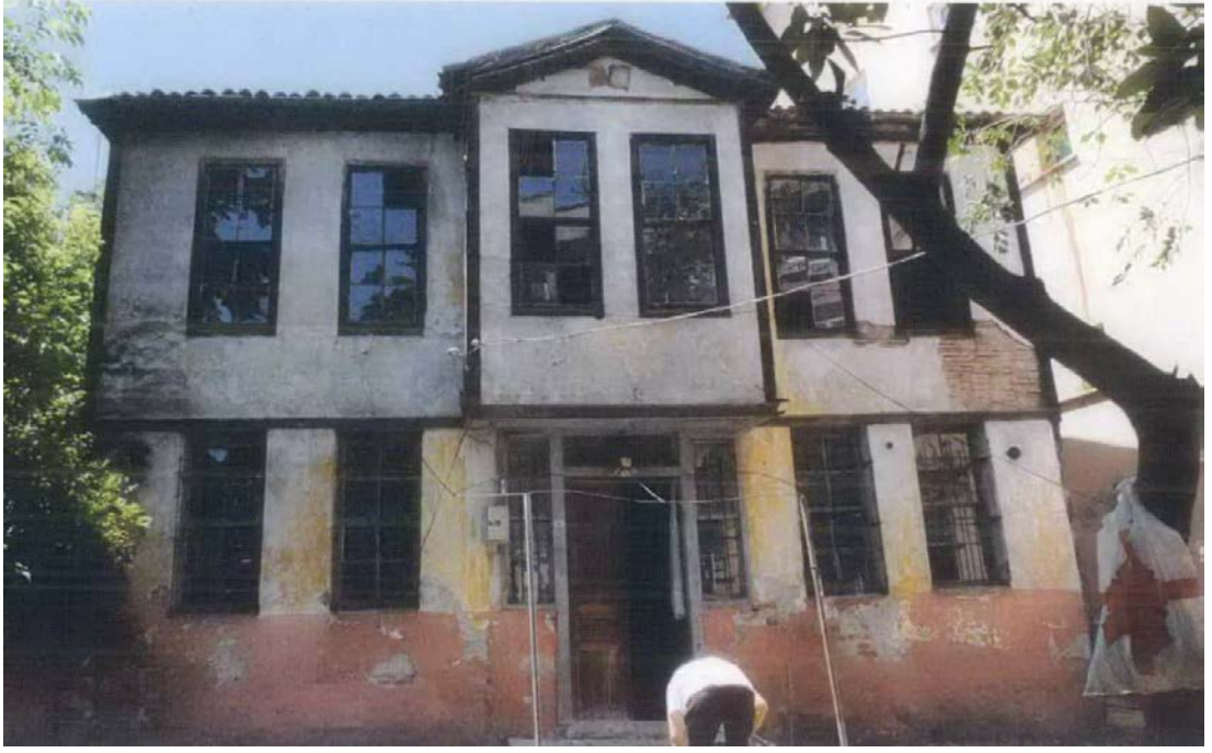
Foto. 175: Ahmet Şevki Özturan Evi'nin Güneydoğu Cephe Onarım Öncesi Görünümü (SKVKBK 2014)
