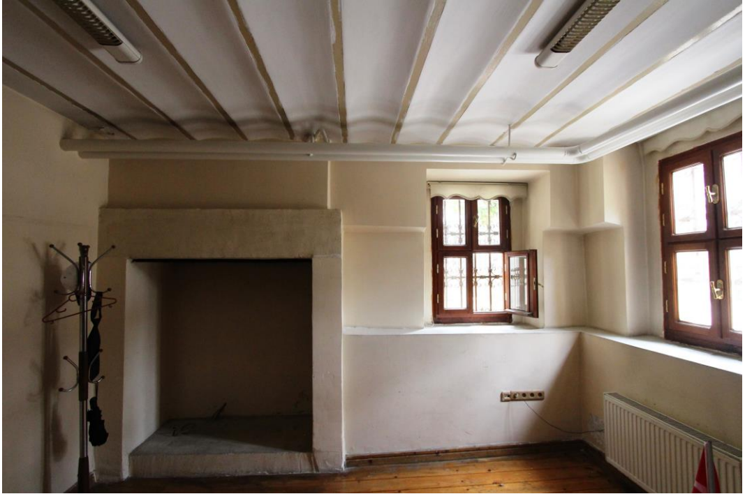
Foto. 317: Boroğlu Evi Bodrum Kat Güney Köşesindeki Odanın Güneydoğu Duvarı
