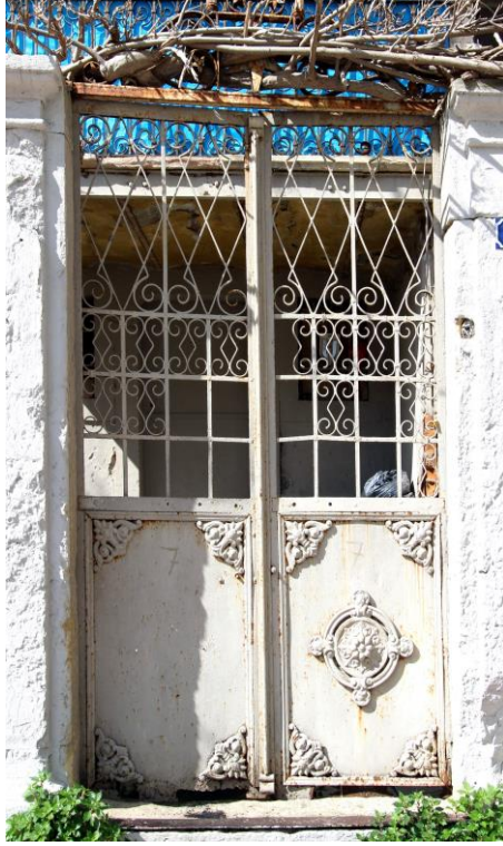
Foto. 22: Mürüvvet Çakır Evi'nin Kuzey Yöndeki Avluya Geçiş Kapısı
