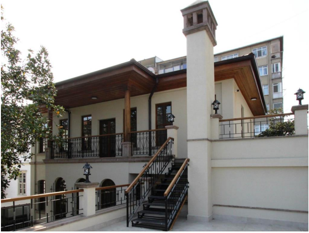
Foto. 596: Samsun Üniversitesi Rektörlük Ofisi Kuzeydoğu Cephe Balkon
