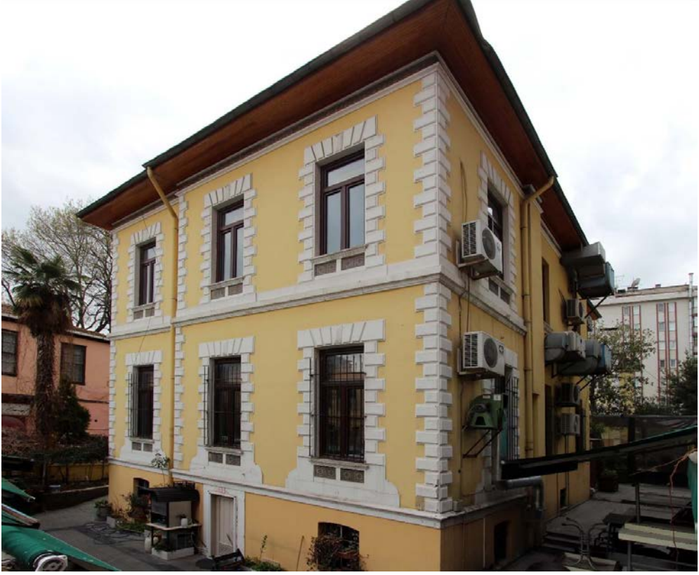
Foto. 371: Yeşilirmak Restaurant'ın Kuzeyden Görünümü
