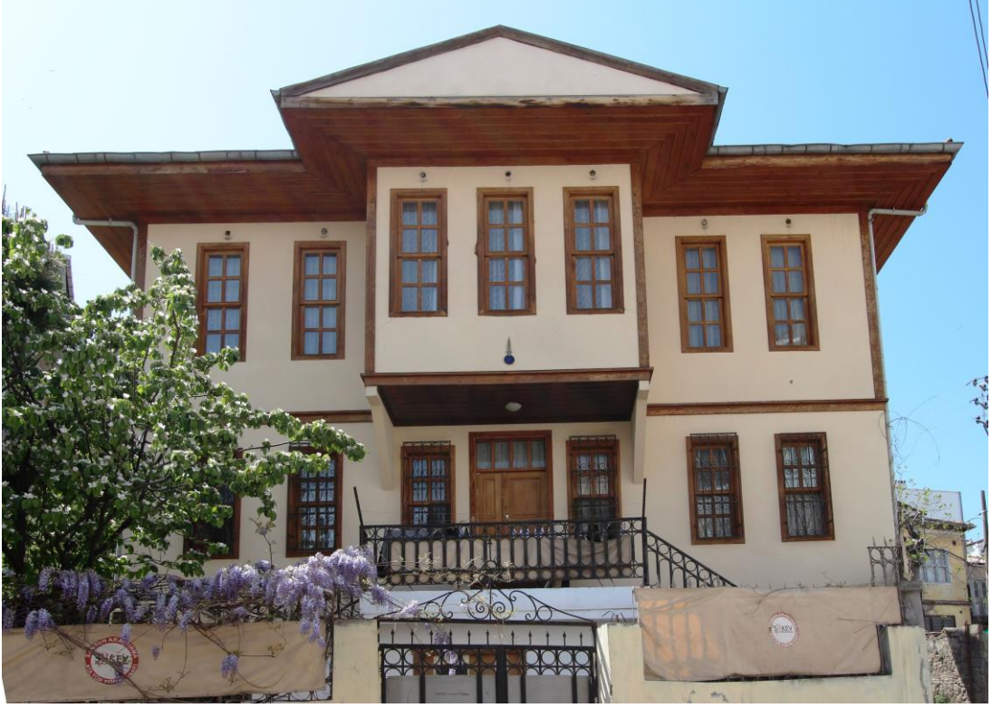
Foto. 78: Sandıkçızade Evi Kuzeydoğu Cephesi
