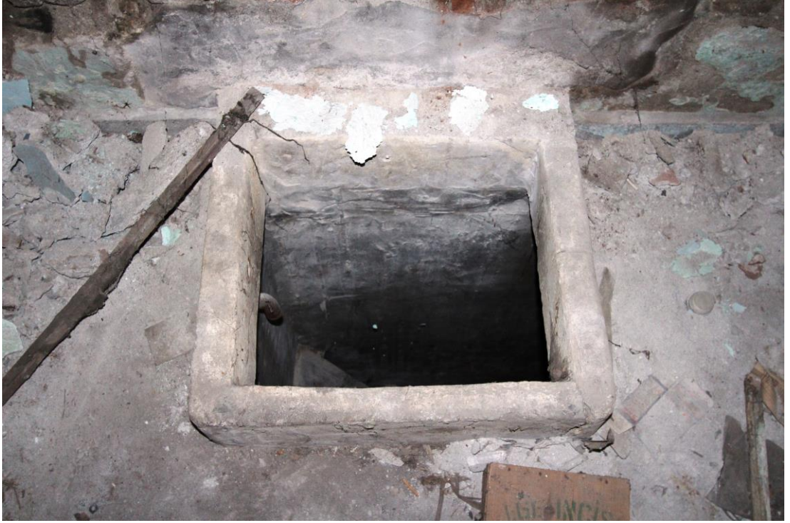
Foto. 162: ayır Sokak 36 Numaralı Evin Bodrum Katındaki Sarnıç
