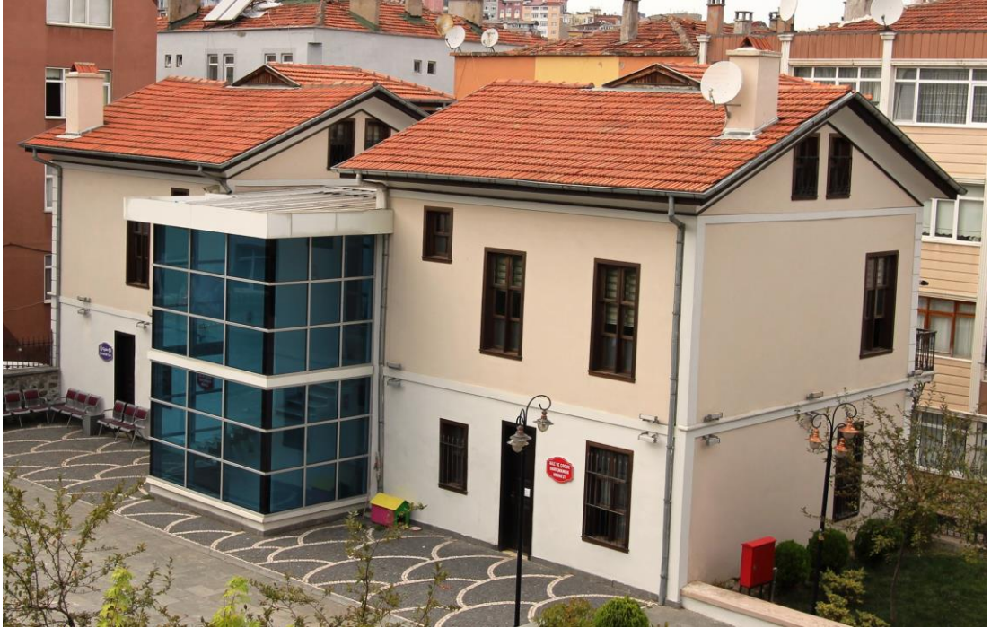
Foto. 267: İkiz Ev'in Güneydoğudan Görünümü
