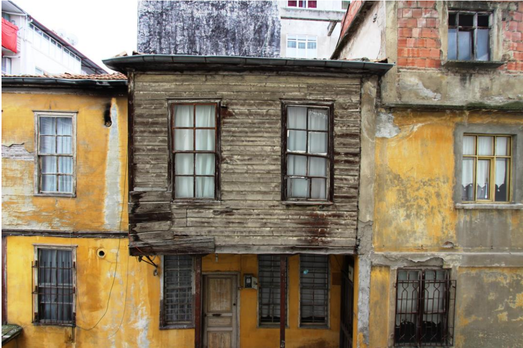
Foto. 231: Gündoğdu Evi'nin Kuzey Cephe Çıkma Ayrıntısı
