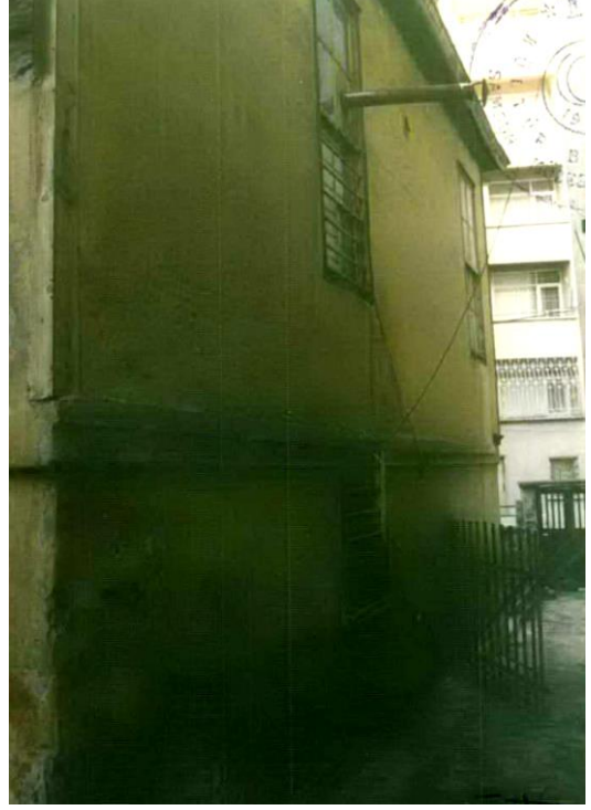
Foto. 695: Osman Şentürk Evi'nin Doğu Cepheden Görünümü (SKVKBK 1990)
