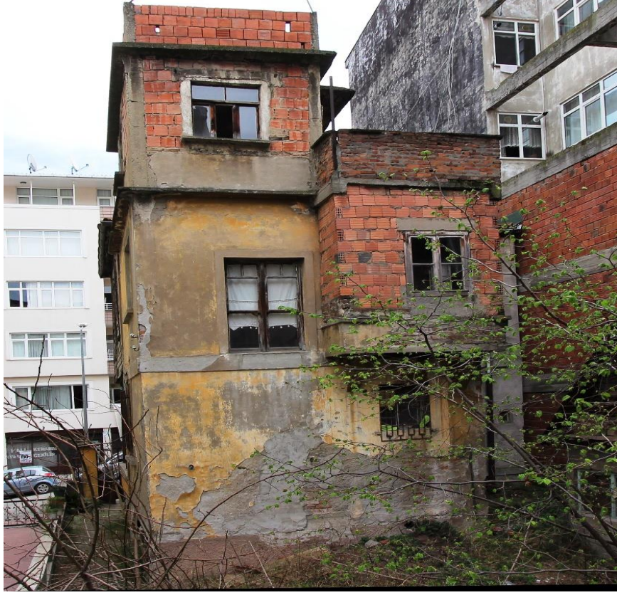
Foto. 232: Gündoğdu Evi'nin Güney Cephesi
