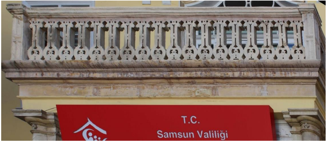
Foto. 461: Fuat Susuz Evi Doğu Cephe Balkon Korkuluğu
