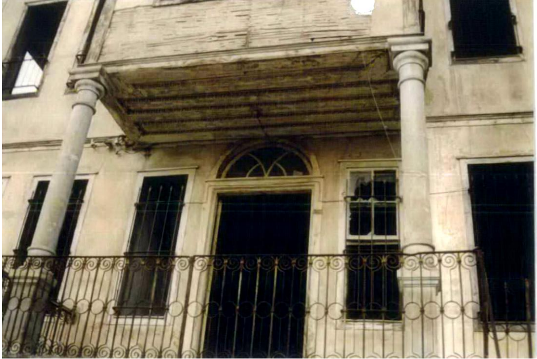
Foto. 46: Türk İslam Sanatları Merkezi'nde Çıkmayı Taşıyan Sütunların Özgün Görünümü (SKVKBK-1995)
