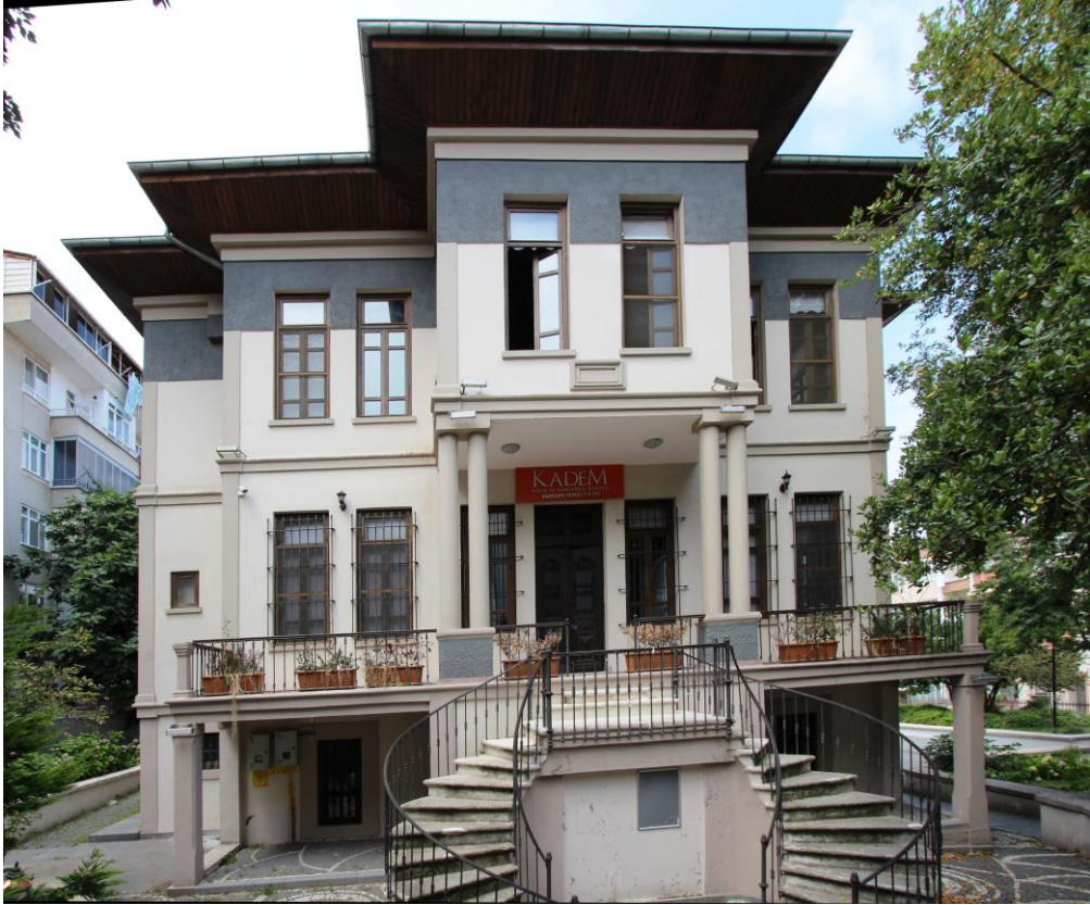
Foto. 243: Paşa Konağı Doğu Cephesi
