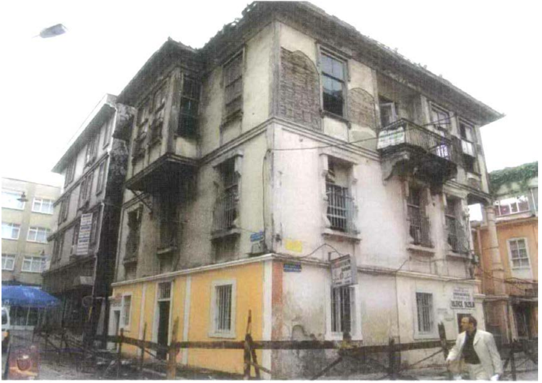
Foto. 418: Asuman Reyhan Evi'nin Onarım Öncesi Kuzeyden Görünümü (SKVKBK 2006)
