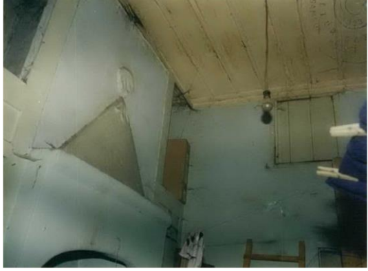
Foto. 697: Osman Şentürk Evi Zemin Kat Mutfak Ocağı (SKVKBK 1990)
