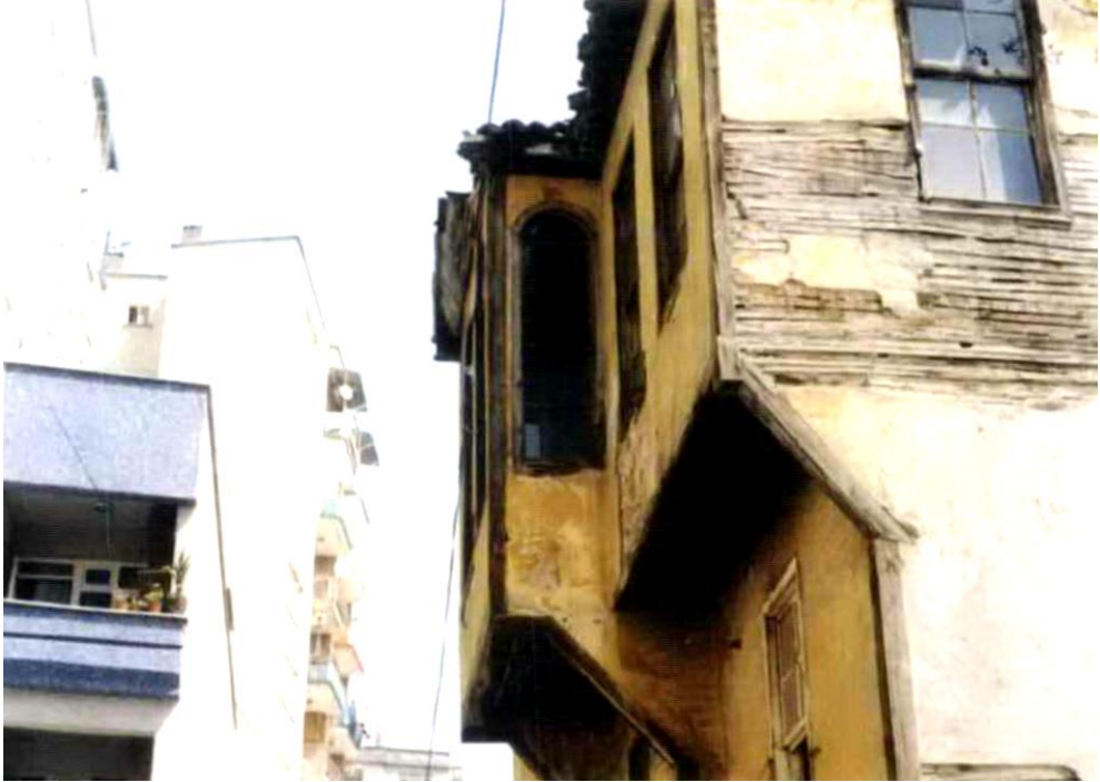
Foto. 745: Medrese Sokak ile Şeyh Hamza Sokağı'nın Kesiştiği Köşedeki Evin Çıkma Ayrıntısı (SKVKBK 2000)
