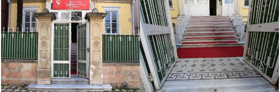
Foto. 465: Fuat Susuz Evi Doğu Cephe Avluya Geçiş Kapısı
