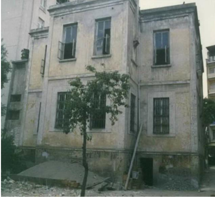
Foto. 333: Fahriye Hanım Konađı'nın Dođu Cephe Görünümü (SKVKBK 2002)
