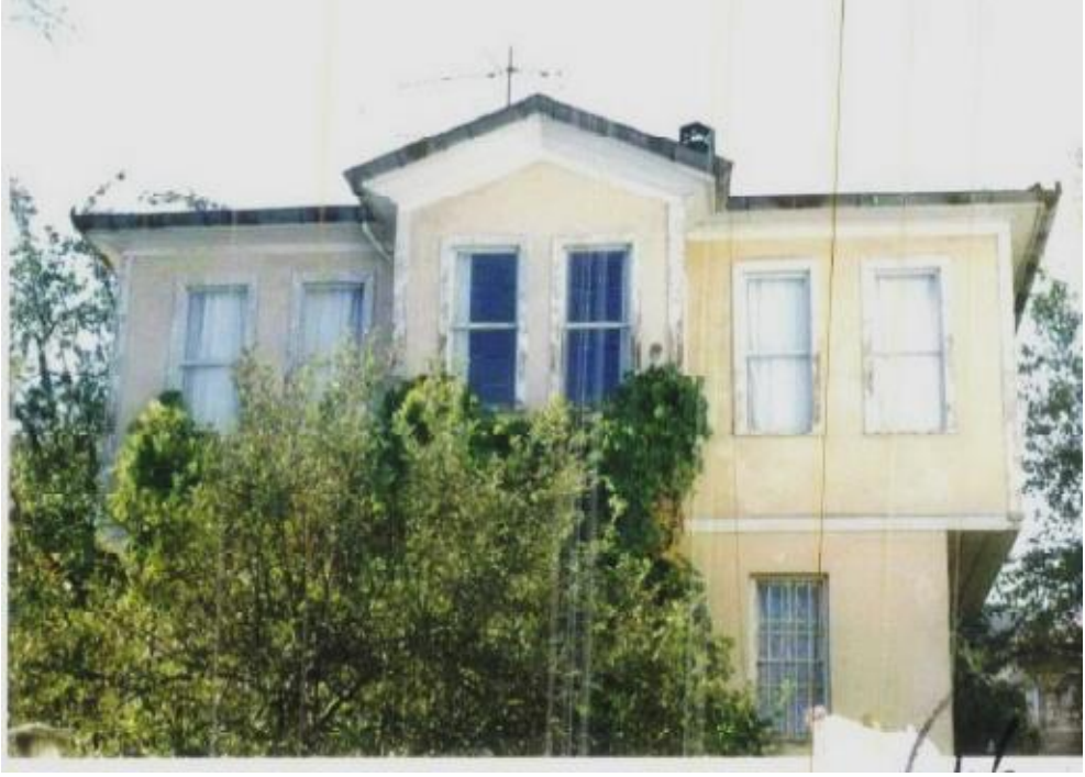
Foto. 666: Topçular Evi Ön Cepheden Görünüm (SKVKBK 1994)
