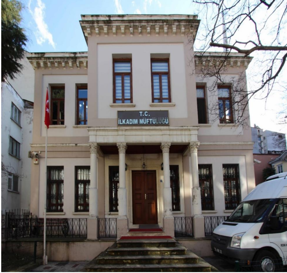
Foto. 480: İlkadım Müftülüğü'nün Kuzey Cephesi
