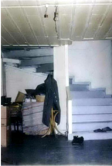
Foto. 690: Hakkıbey Sokak 44 Numaralı Evin Zemin Kat Sofası (SKVKBK 1991)
