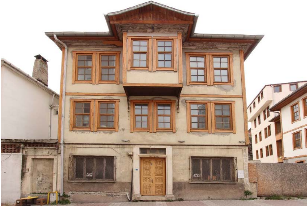
Foto. 59: Ahmet Özder-1 Evi'nin Kuzeydoğu Cephesi
