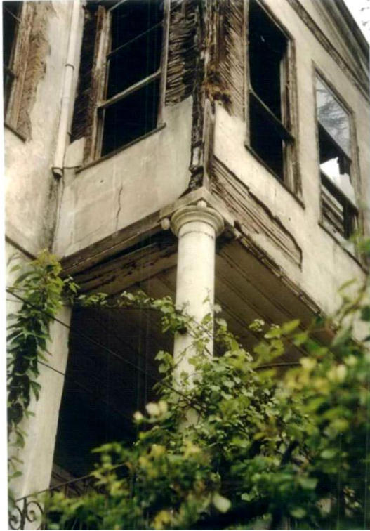
Foto. 35: Samsun B.B. Ait Evin Özgün Kuzey Cephesi Çıkma Ayrıntısı ve Sütun Başlığı (SKVKBK 1985)
