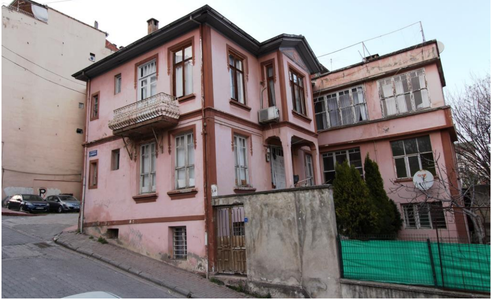
Foto. 182: Sezgin Kaya Evi'nin Doğu ve Güney Cephesi
