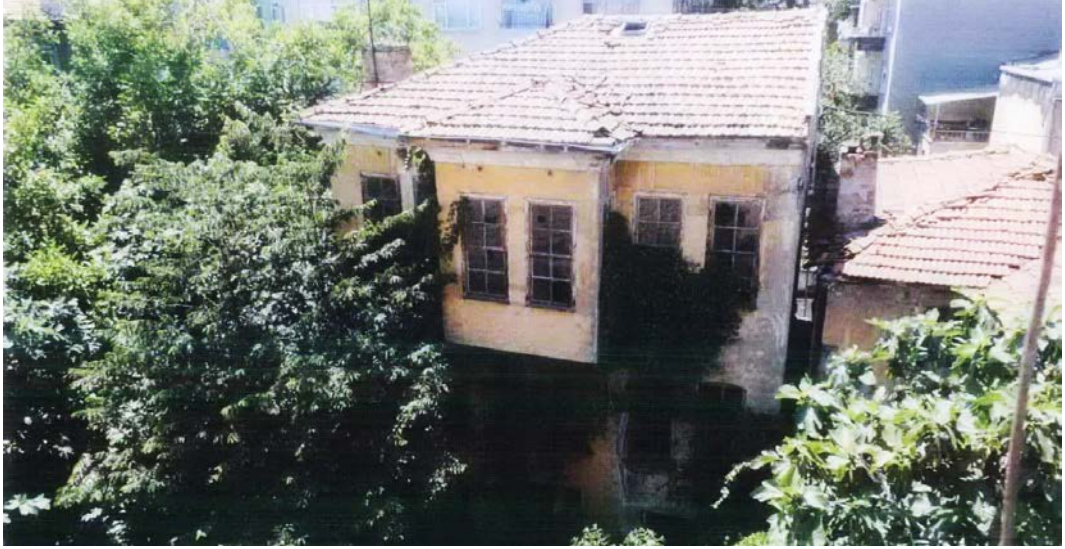
Foto. 158: Çayır Sokak 36 Numaralı Evin Doğu Cephe Görünümü (SKVKBK 2014)
