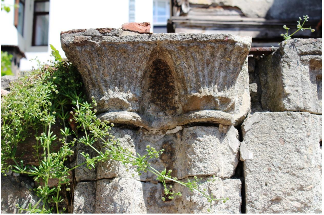
Foto. 92: Müftü Hamam Sokak 28 Numaralı Evin Avlu Kapısı Söve Ayrıntısı
