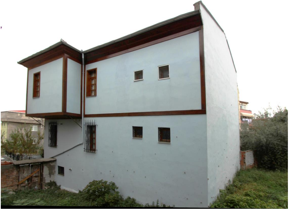
Foto. 107: Ali Haydar Aktaş-1 Evi'nin Kuzey ve Batı Cephesi
