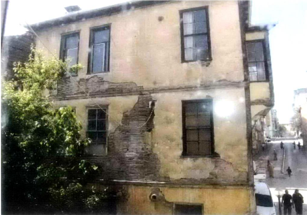
Foto. 71: Ahmet Özder-2 Evi'nin Güneydoğu Cephesi (SKVKBK 2009)
