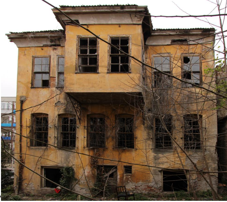
Foto. 157: Çayır Sokak 36 Numaralı Evin Doğu Cephe Görünümü
