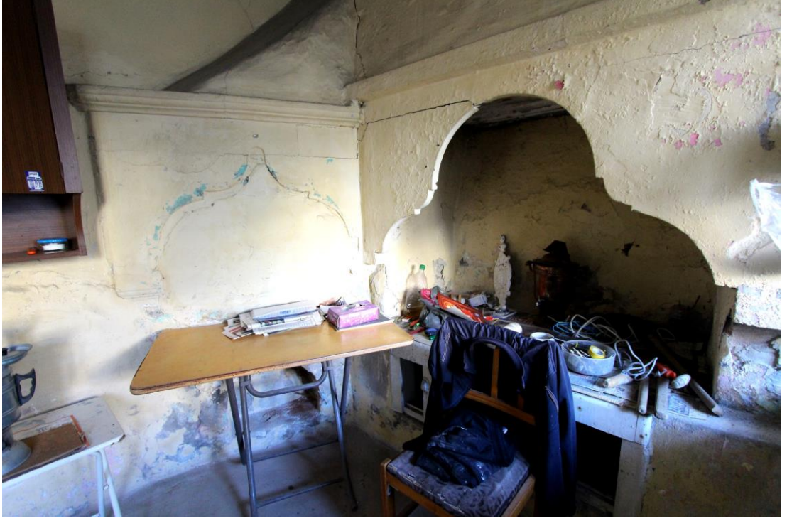
Foto. 145: Aslan Geviz Evi'nin Bodrum Kat Mutfak Ocađı
