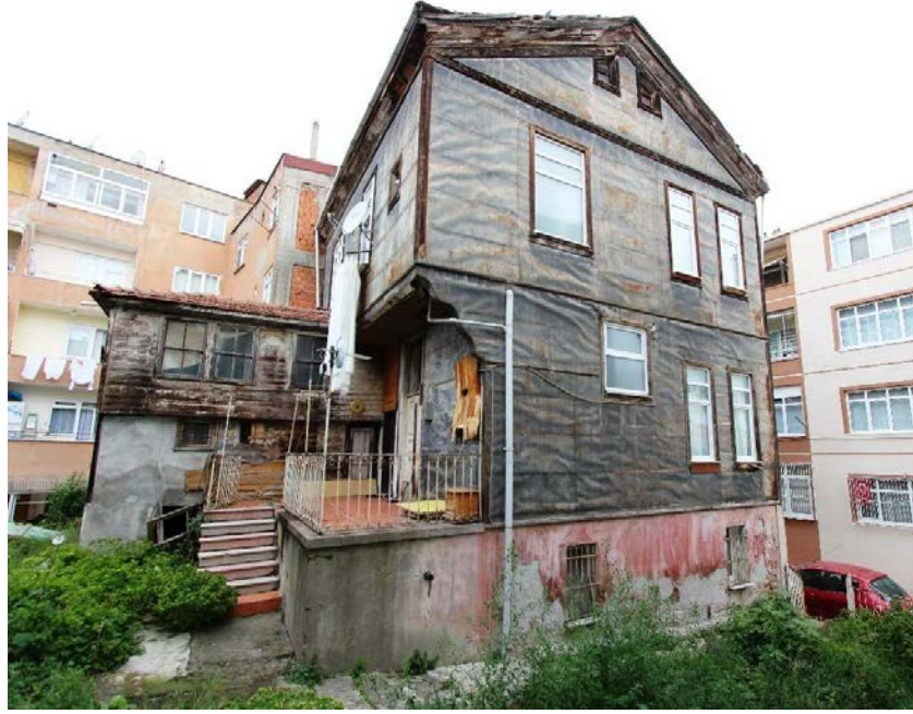
Foto. 98: Esin-Birkan Sevinç Evi'nin Güney ve Doğu Cephesi
