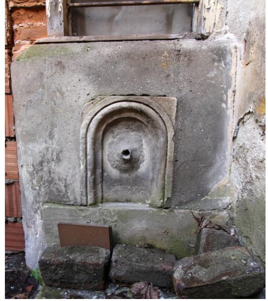
Foto. 24: Mürüvvet Çakır Evi'nin Yıkılan Çamaşırılık Bölümündeki Çeşme
