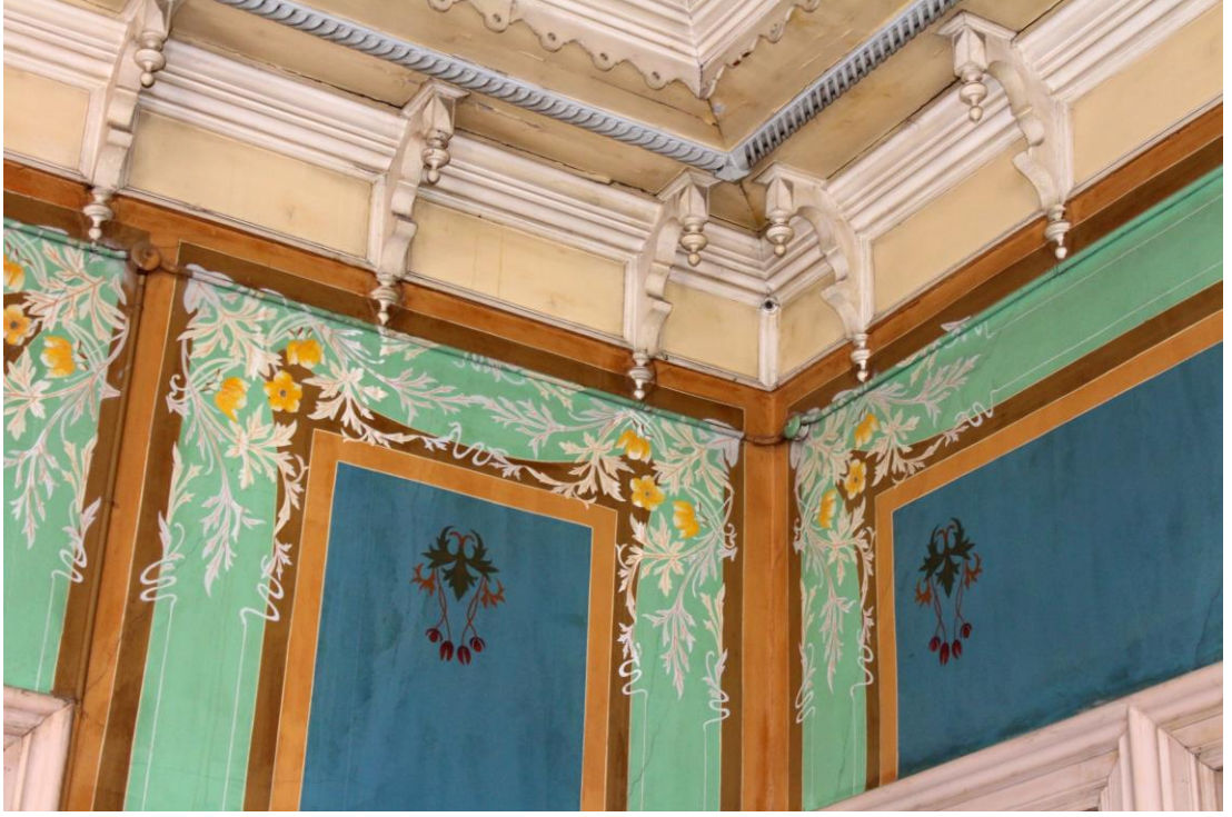
Foto. 221: Necip Özüdođru Evi'nin Tavan ve Duvar Süsleme Detayları
