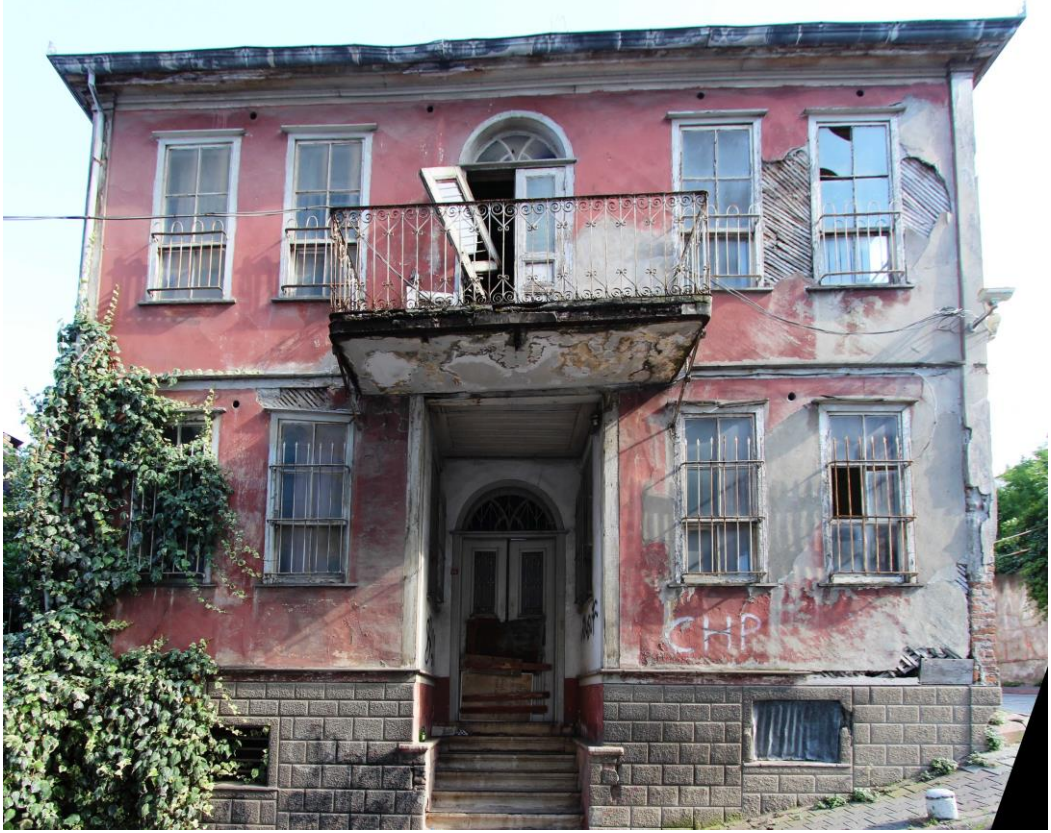
Foto. 154: Kalkavanlar Evi Kuzey Cephe Görünümü
