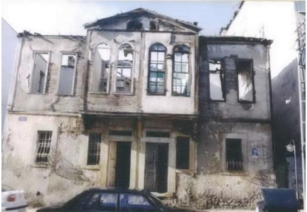
Foto. 634: Zeynep Temiz Evi Ön Cephe Görünümü (SKVKBK 2000)
