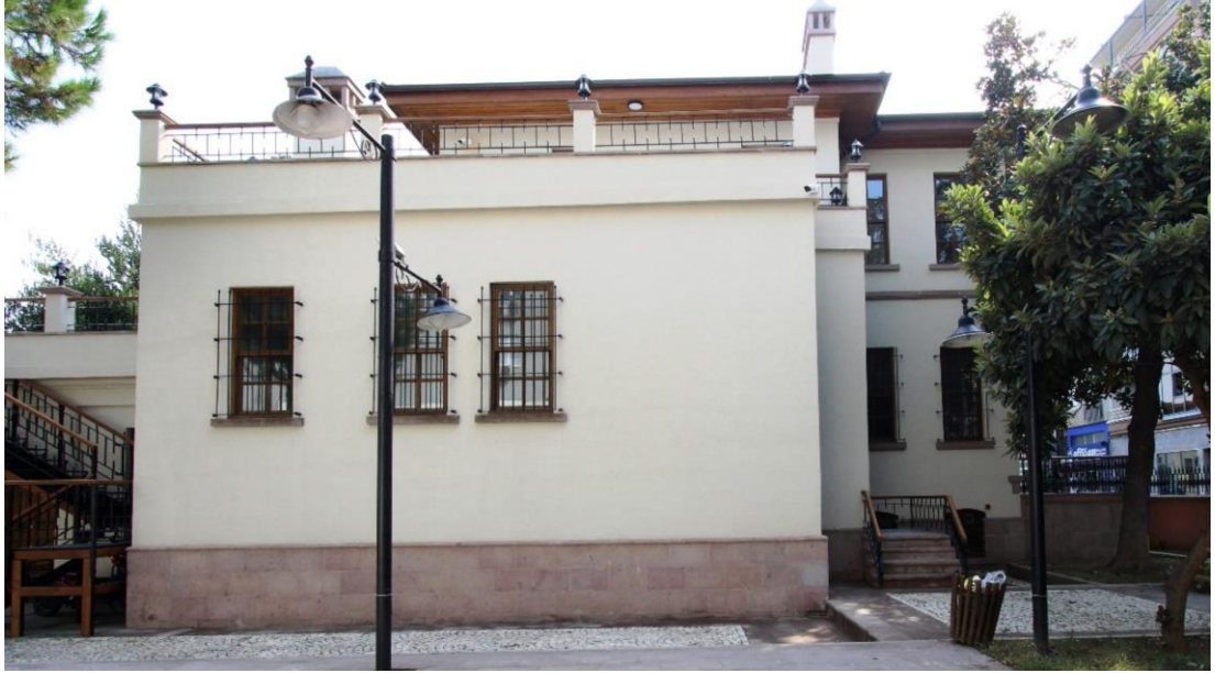
Foto. 597: Samsun Üniversitesi Rektörlük Ofisi Kuzeybatı Cephe Görünümü
