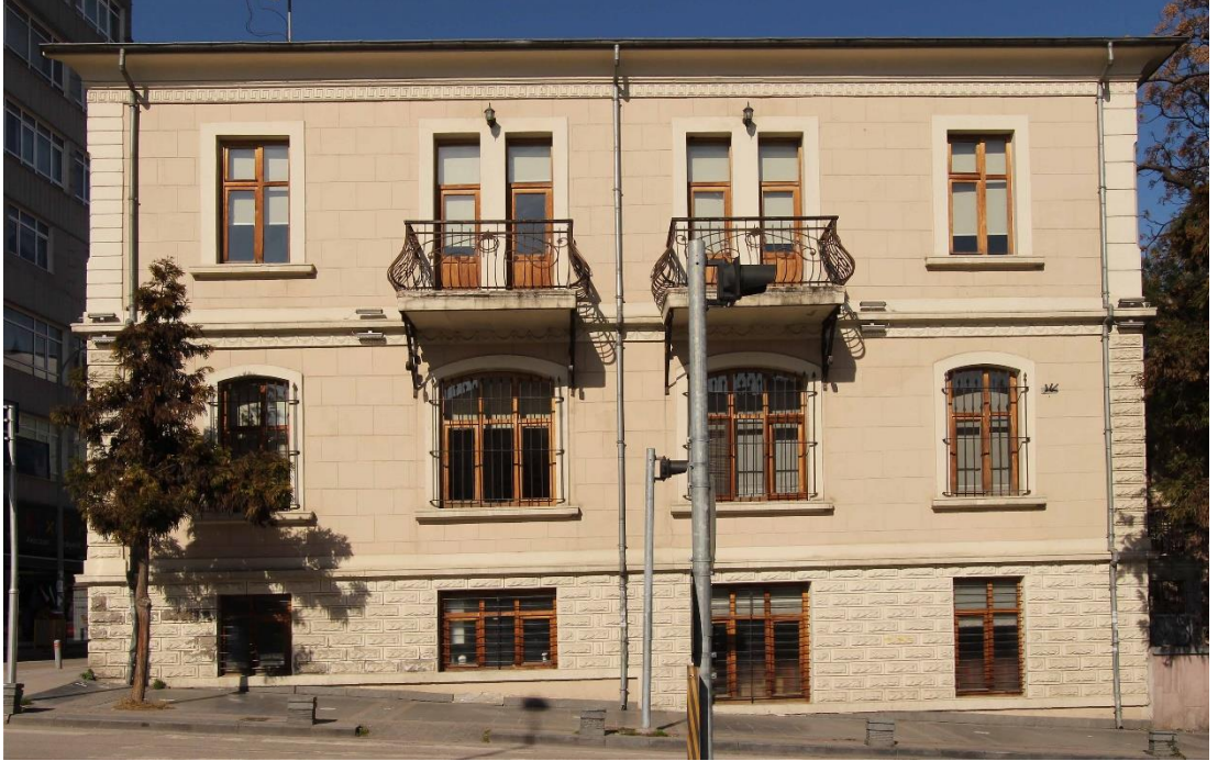
Foto. 553: Şahinzade Remzi Bey Evi A Bloğun Güneydoğu Cephesi
