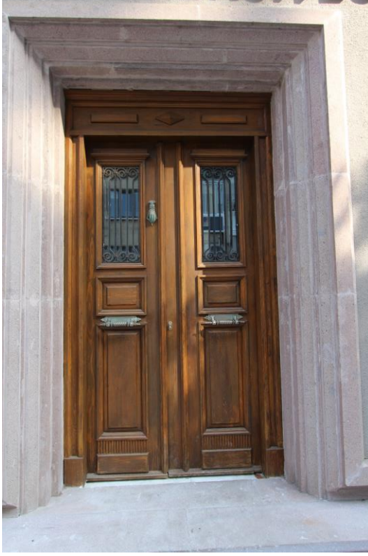
Foto. 598: Samsun Üniversitesi Rektörlük Ofisi Güneybatı Cephe Yapıya Geçiş Kapısı
