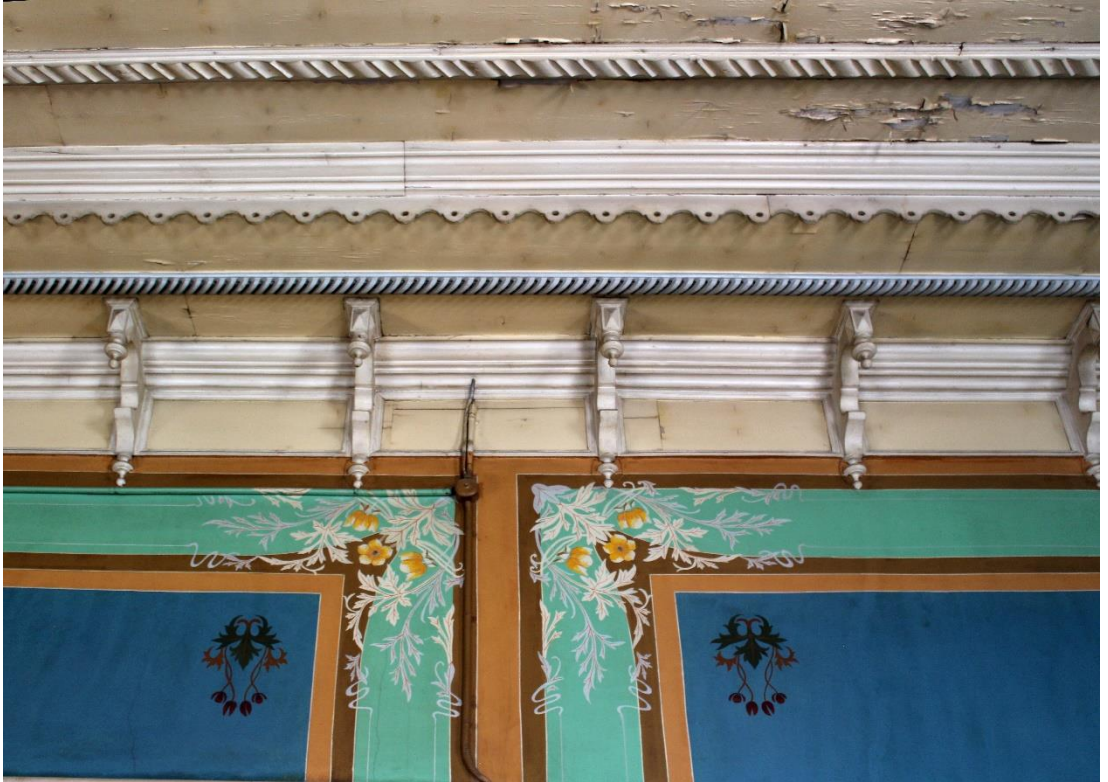
Foto. 222: Necip Özüdođru Evi'nin Tavan ve Duvar Süsleme Detayları
