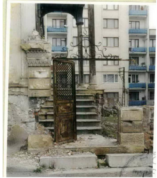
Foto. 647: Pirallar Evi Doğu Cephe Avlu Kapısı (SKVKBK 2000)
