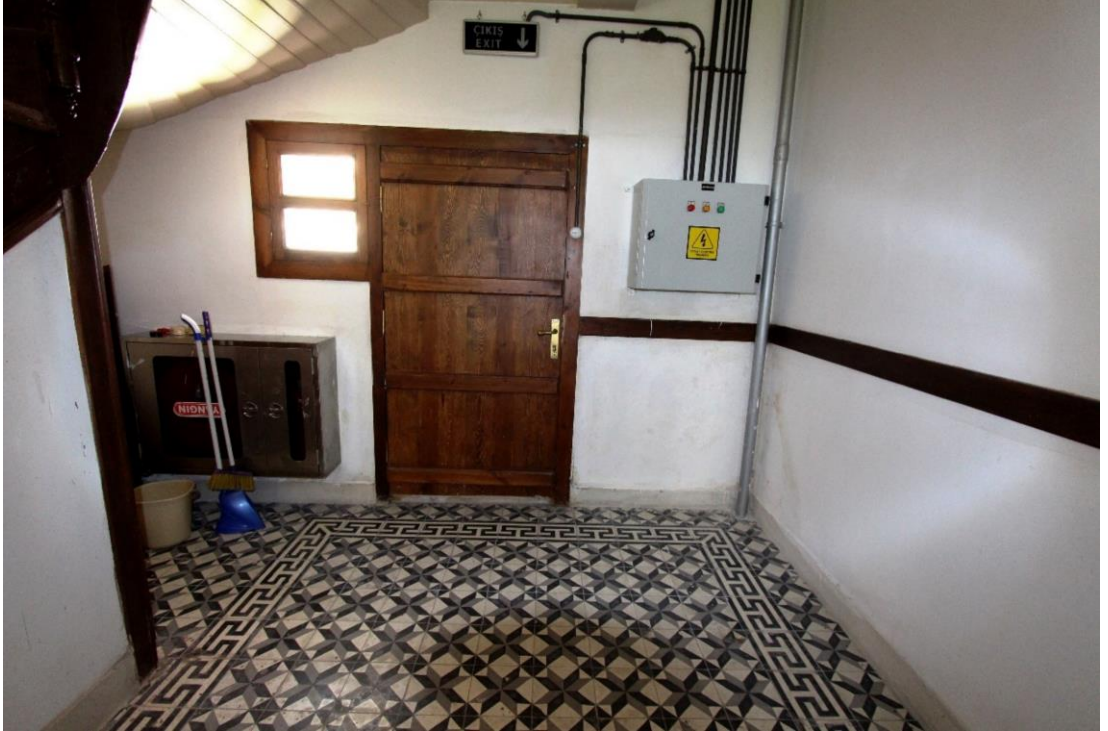
Foto. 511: OMÜ İlim Sanat ve Kültür Evi Zemin Kat Pabuçluğu
