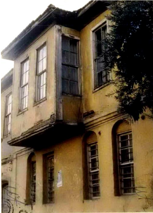
Foto. 124: Şehit-Gazi ve Anı Evi'nin Doğu Cephe Onarım Öncesi Görünümü (SKVKBK 1995)
