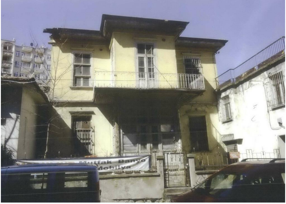
Foto. 518: Musa Arslan Evi'nin Doğu Cephe Onarım Öncesi Görünümü (SKVKBK 2012)
