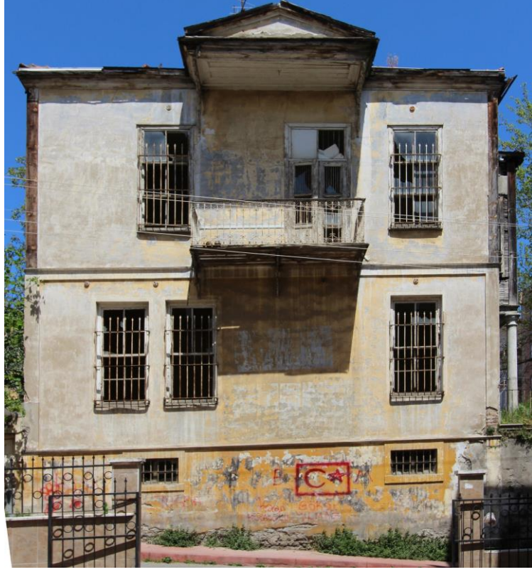
Foto. 3: Alemdarzadeler Evi Güney Cephesi
