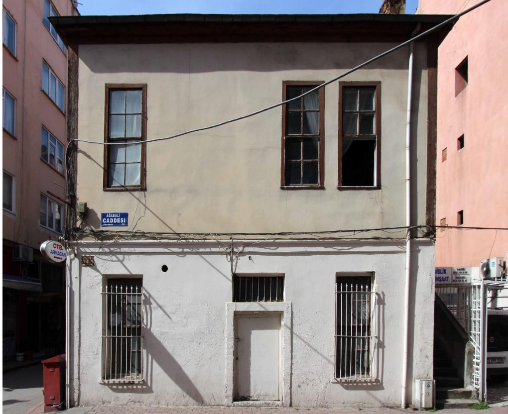
Foto. 441: İrfan Tamtürk Evi'nin Güneydoğu Cephesi
