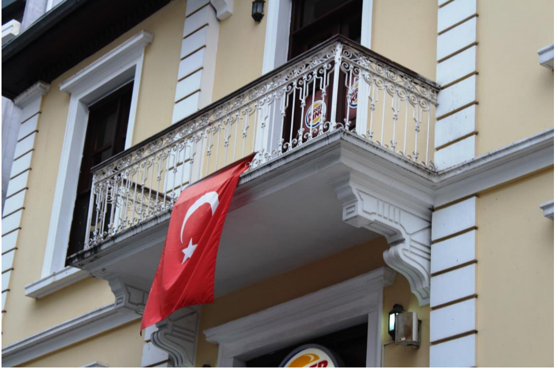
Foto. 609: Elmas Hanım Konağı Kuzeydoğu Cephe Balkon Görünümü
