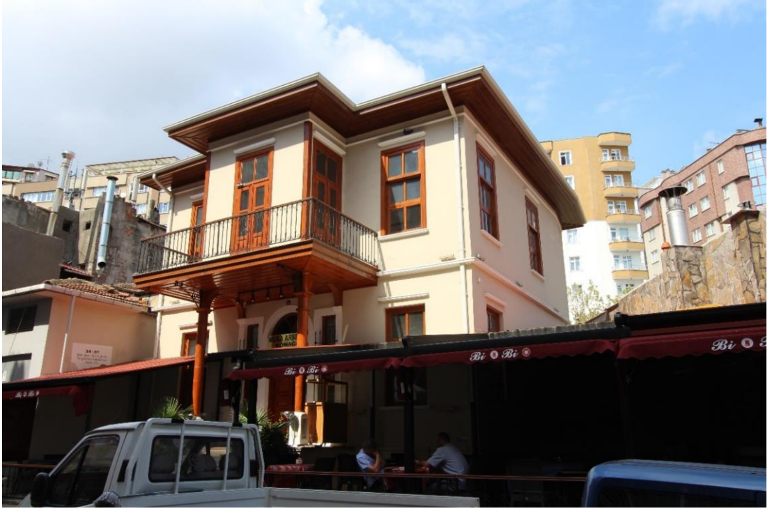
Foto. 520: Musa Arslan Evi'nin Kuzeydoğudan Görünümü
