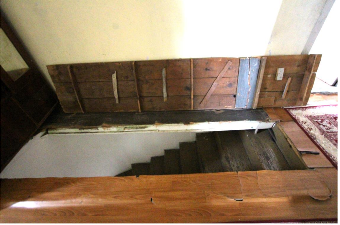
Foto. 27: Mürüvvet Çakır Evi'nin Birinci Kat Ahşap Merdiven Kapağı
