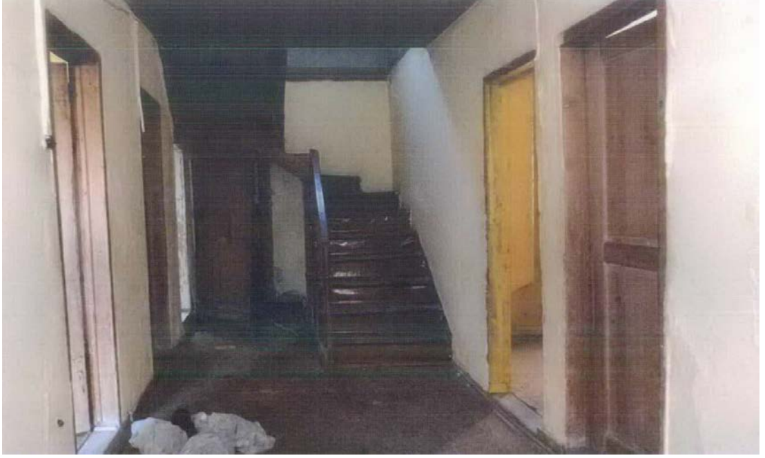
Foto. 179: Ahmet Şevki Özturan Evi'nin Zemin Kat Sofası (SKVKBK 2014)
