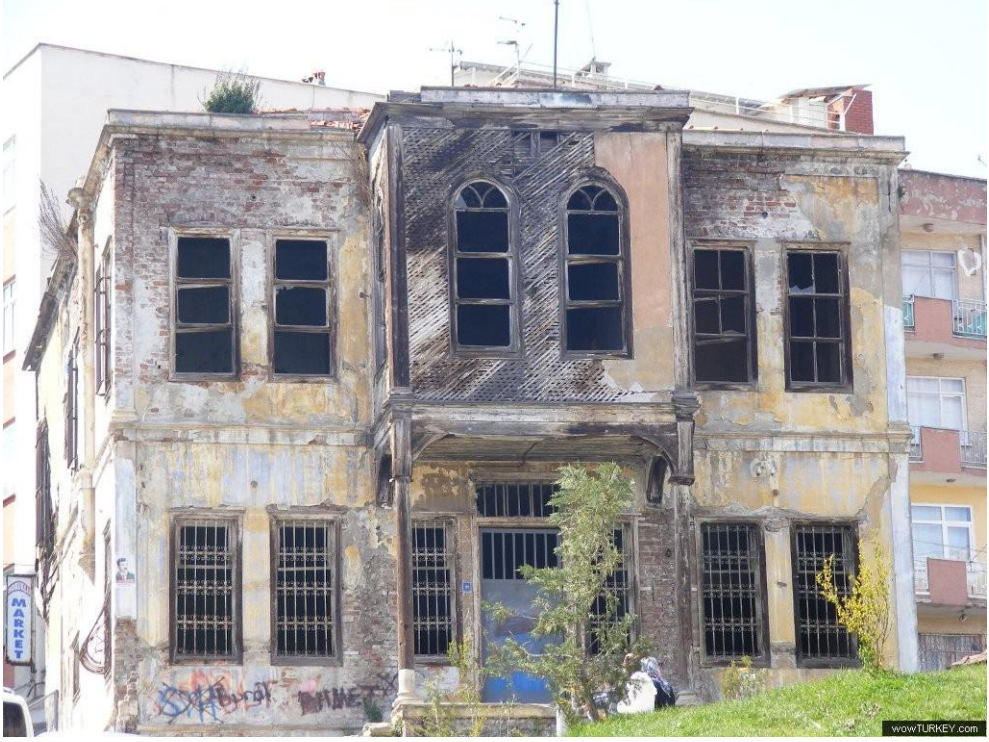
Foto. 642: Pirallar Evi Kuzey Cephesi Yıkılmadan Önceki Hali ( http://wowturkey.com/ )
