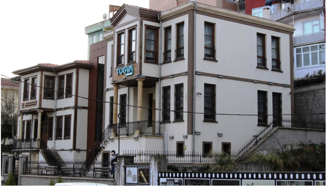
Foto. 31: Samsun Büyükşehir Belediyesi'ne Ait Yapının Çevresiyle Birlikte Görünümü
