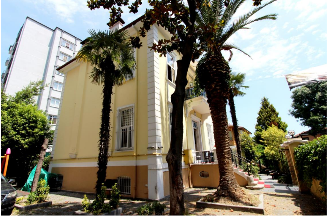
Foto. 382: Çarşambalılar Derneği Güneyden Görünümü
