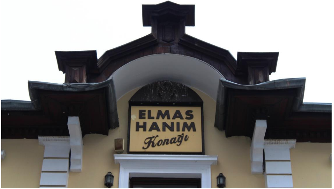
Foto. 613: Elmas Hanım Konağı Kuzeydoğu Cephe Alınlık
