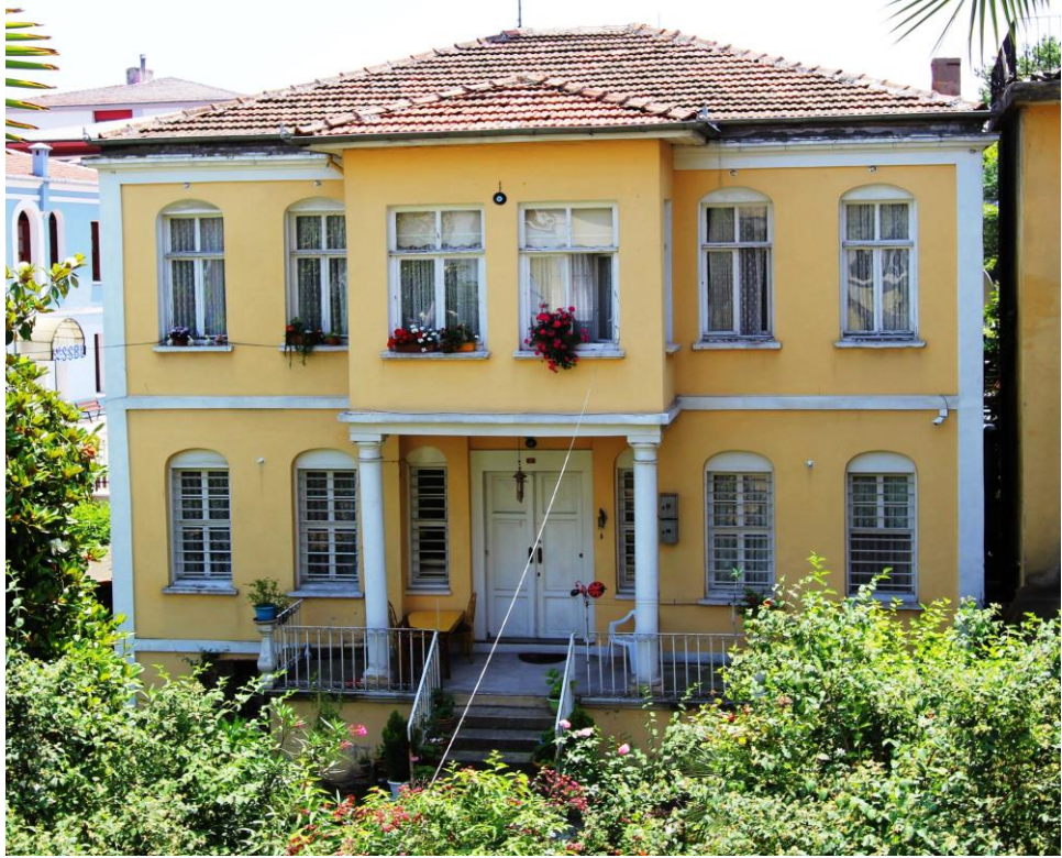
Foto. 352: Ayşe Kardel Evi Kuzeydoğu Cephesi
