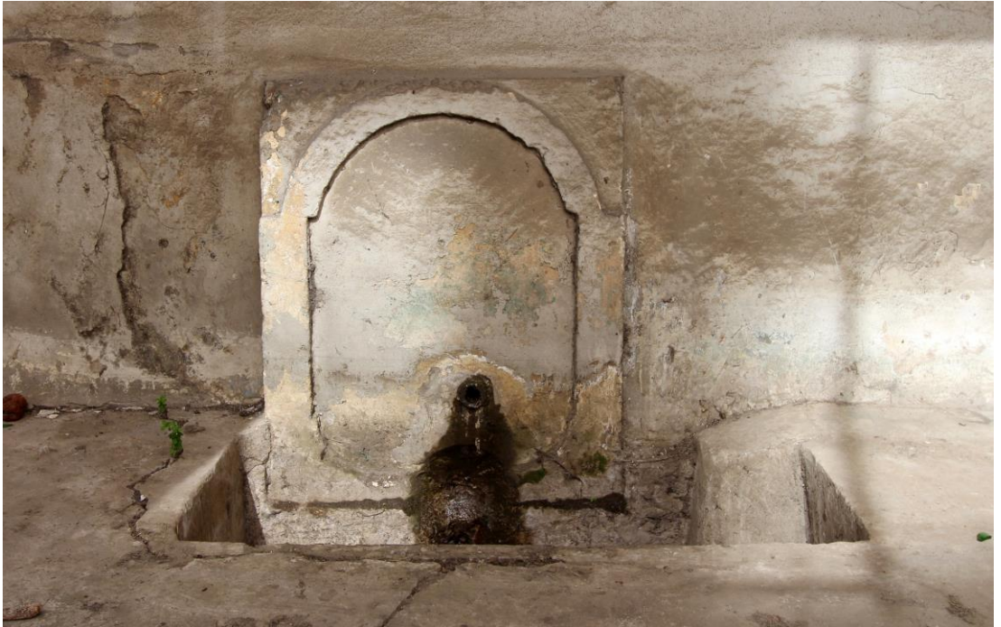
Foto. 206: Necip Özüdođru Evi Dođu Cephede, Sarnıcın Kuzey Duvarındaki Çeşme
