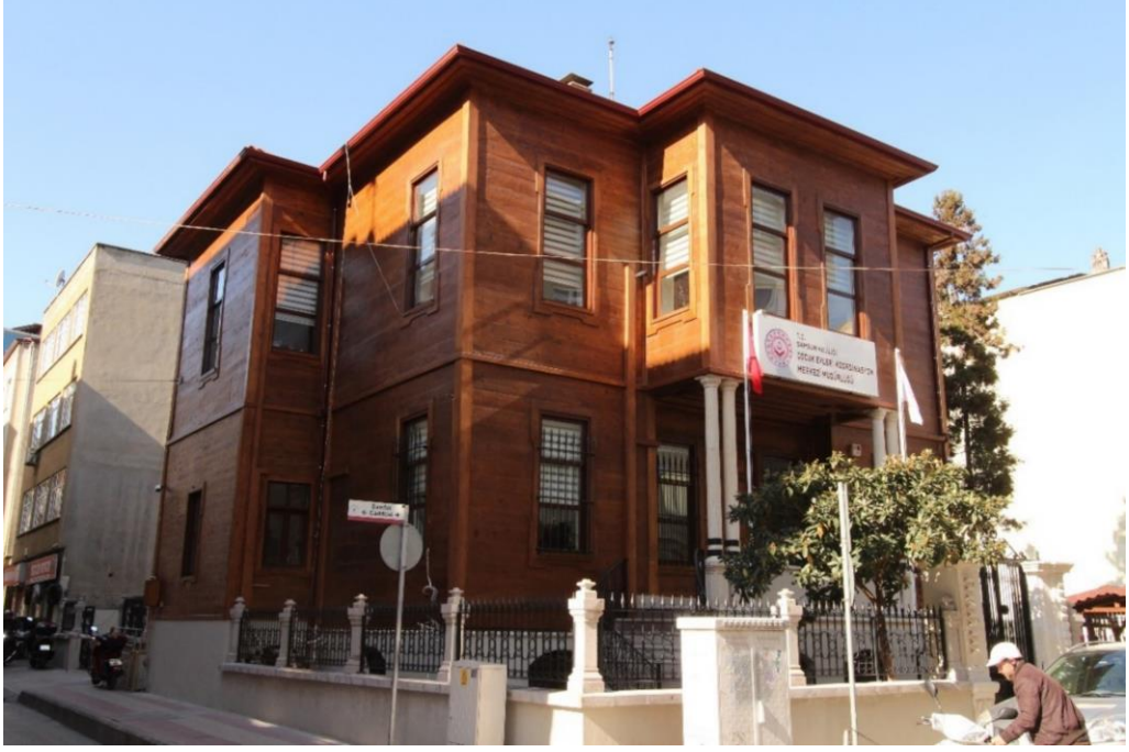
Foto. 434: Çocuk Evleri Koordinasyon Merkezi'nin Kuzeydoğudan Onarım Sonrası Görünümü
