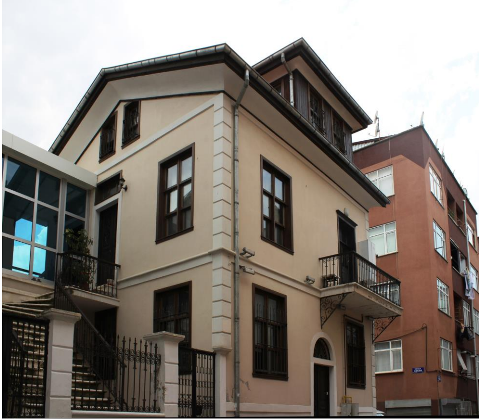
Foto. 263: İkiz Ev B Blok Kuzey Cephe Görünümü
