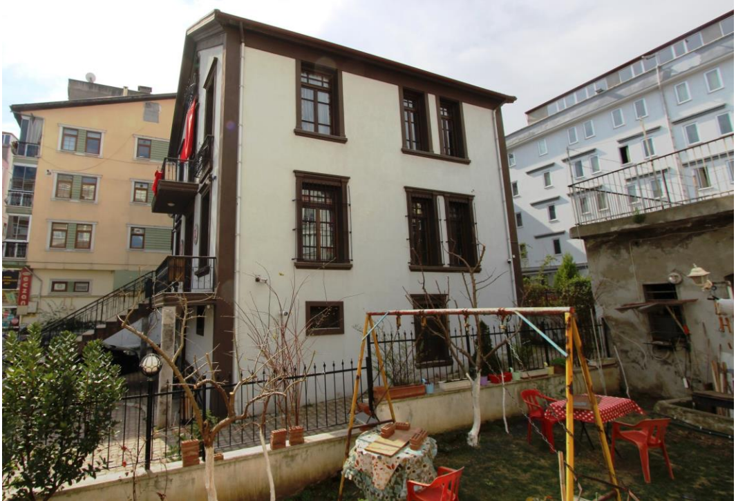
Foto. 304: Lazzade Kaşif Bey Evi'nin Kuzey Cephesi
