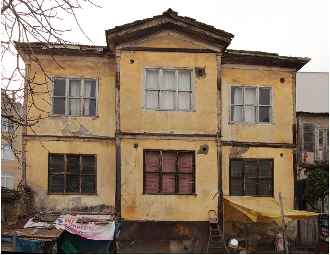
Foto. 90: Müftü Hamam Sokak 28 Numaralı Evin Doğu Cephe Görünümü
