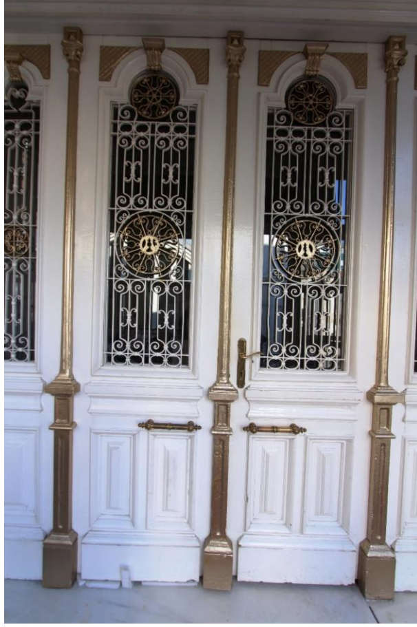
Foto. 467: Fuat Susuz Evi Doğu Cephe Eve Geçiş Kapısı
