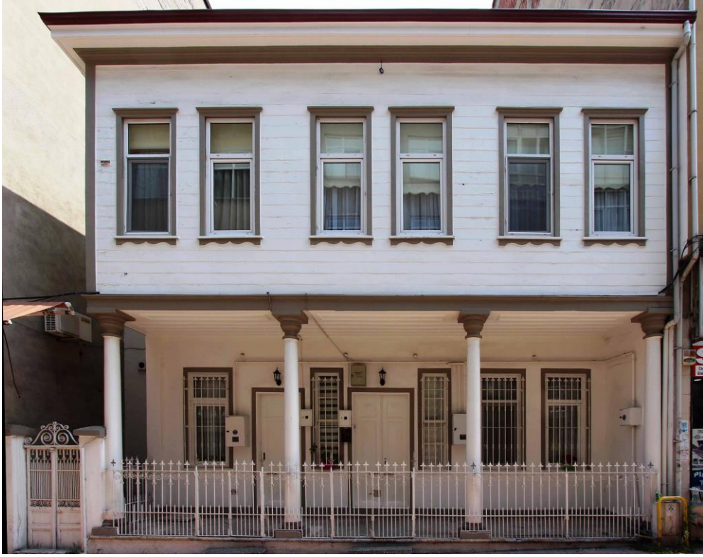
Foto. 429: Ali Yücel Evi Batı Cephesi
