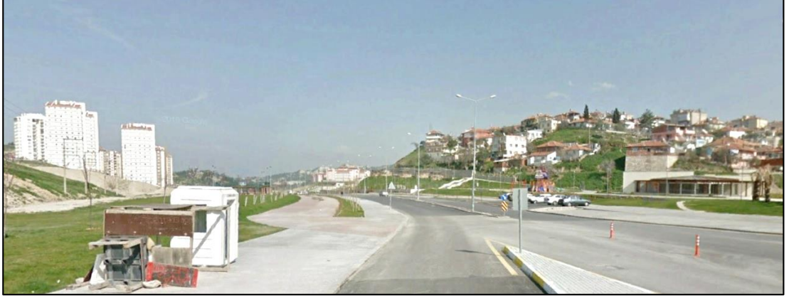
Şekil 4.31: Akvadi bölgesi gecekondu yapıları ve toplu konutlar, (Kişisel Arşiv, 2020).
