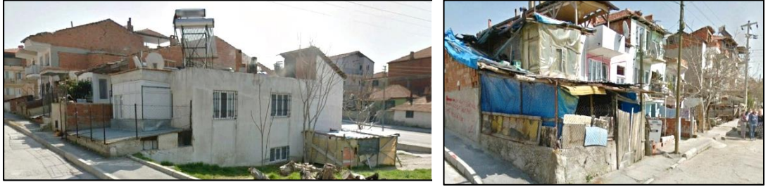
Şekil 4.25: Karşıyaka Mahallesi güvenlik riski taşıyan konut bölgesi, (Kişisel Arşiv 2020).
