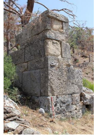
Fig. 5. Ana Mekânın güneybatı köşesi, duvar detayı
