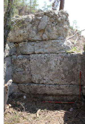
Fig. 9. Mekân 1'in duvar detayı
