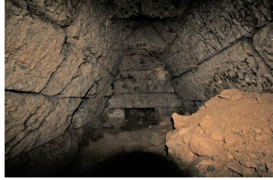
Fig. 6. Kaçak kazılar sonucu odaların tabanına yığılan toprak ve istiflenmiş taşlar, B Odası
