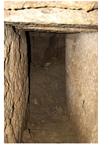
Fig. 14. B odasını C odasına bağlayan ve yekpare kesme taştan yapılan geçiş
