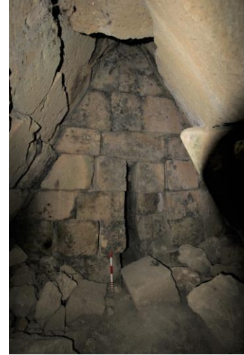
Fig. 7. A odası, güneyden kuzeye bakış, tahribat sonucu odanın tabanına düşen taş bloklar
