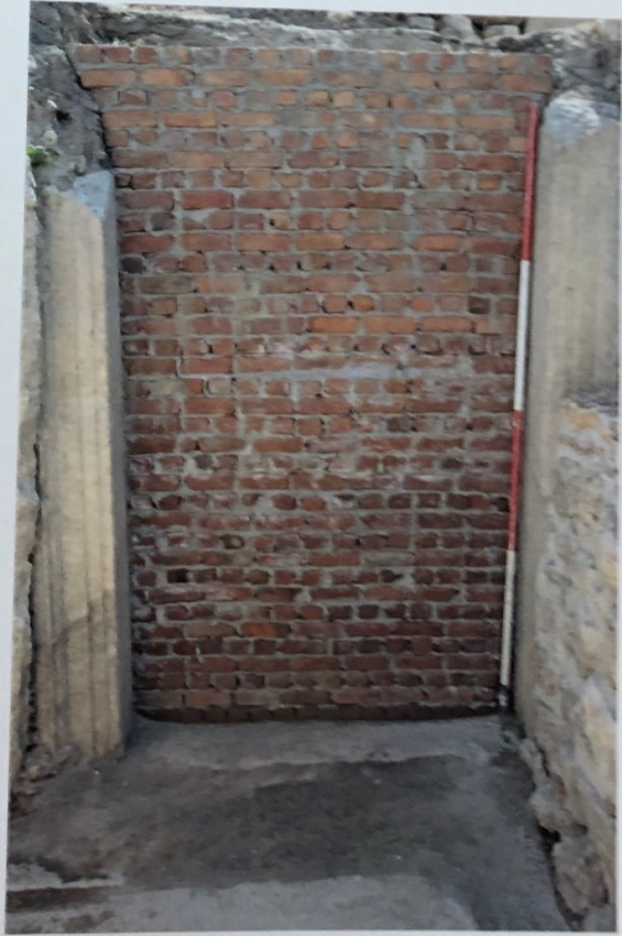
Fot.8: Güney parados üzerinde bulunan giriş. / An entrance on south parados.
