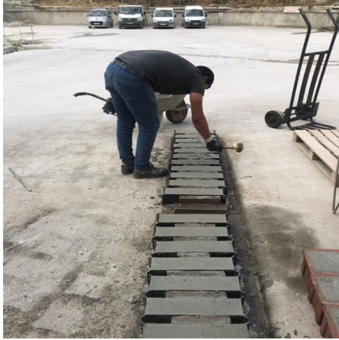
Şekil 4.5: Çekiç ile boşluk giderme
