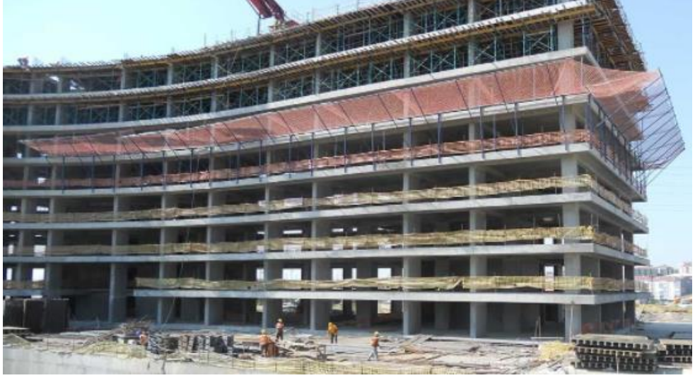
Şekil 1.5: İnşaatlarda güvenlik ağı uygulaması (Url_4)
