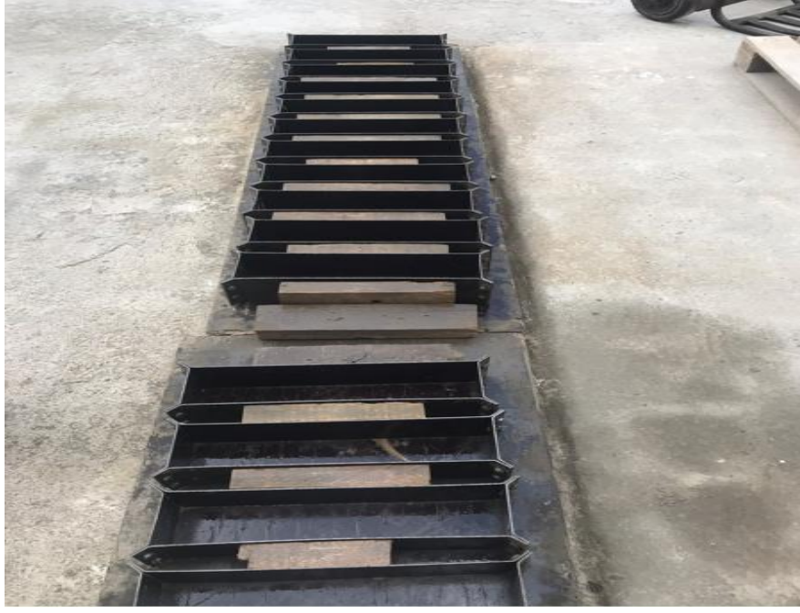
Şekil 4.3: Beton kiriş numune kalıbı
