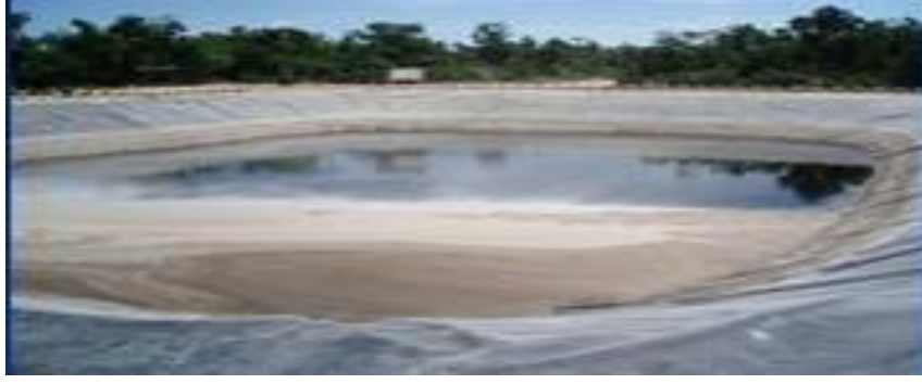
Şekil 1.3: Sulama amaçlı yapılmış gölette tekstil ürünü kullanımı (Url_3)
