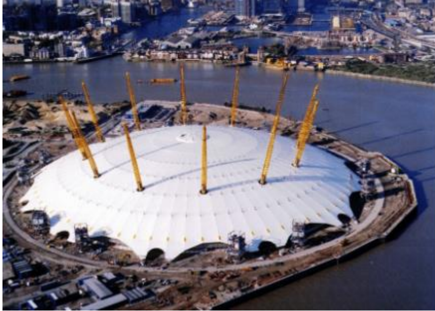
Şekil 1.1: Membran çatı uygulaması Greenwich Millenium Dome (Url_1)
