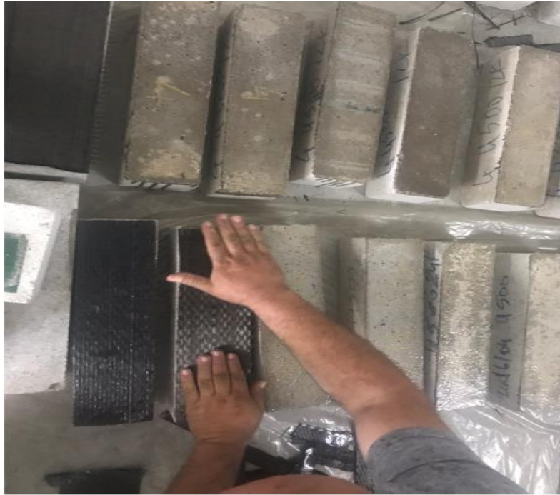
Şekil 4.13: Karbon kumaşın yapıştırılması
