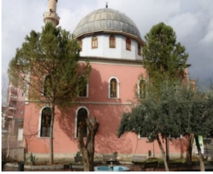
Foto. 33: Kayalık Camisi Güney Cephe
