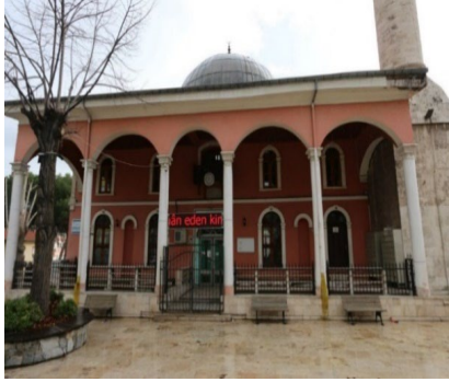
Foto. 31: Kayalık Camisi Kuzey Cephe
