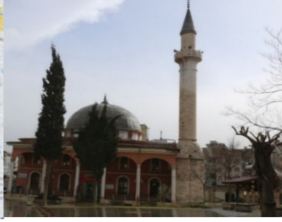
Foto. 2: Caminin Kuzey Cepheden Görüntüsü ve Son Cemaat Yeri
