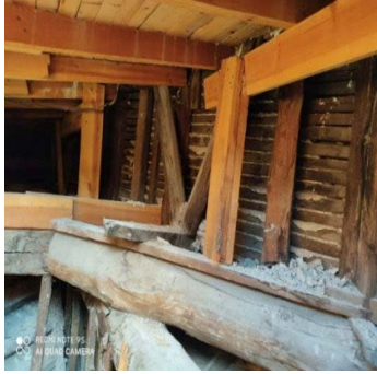
Foto. 6: Kubbede Görülen Bağdadi Duvar Örgüsü
