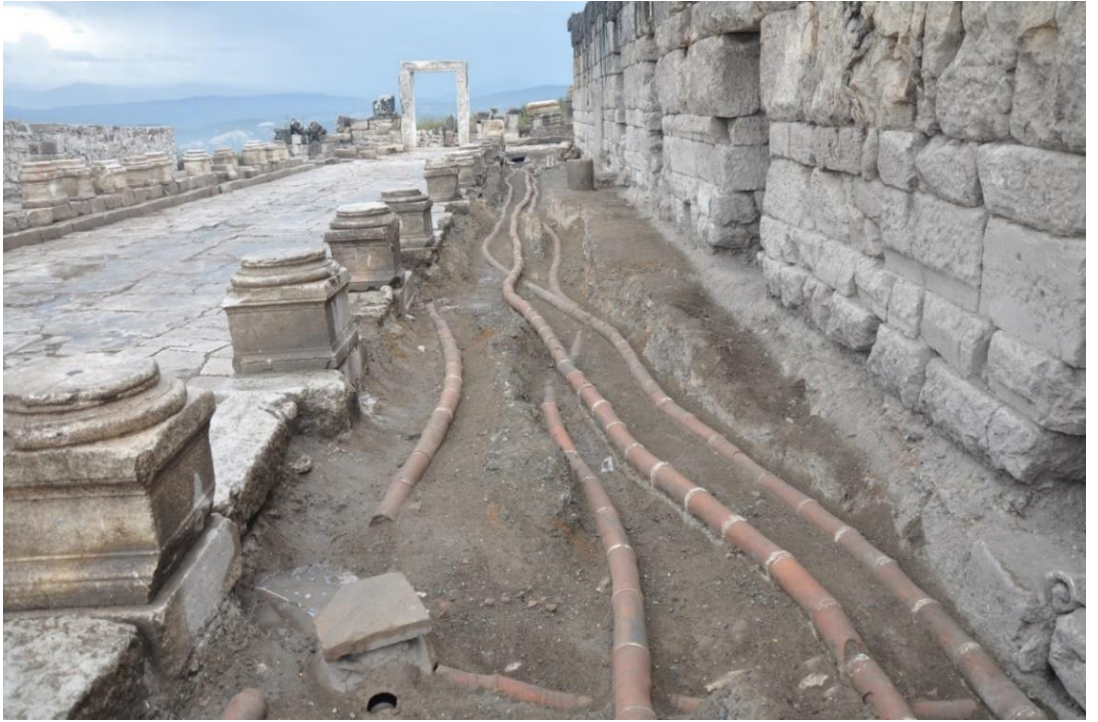
Figür 70: I. teras caddesi, batı stoa su dağıtım sistemi
