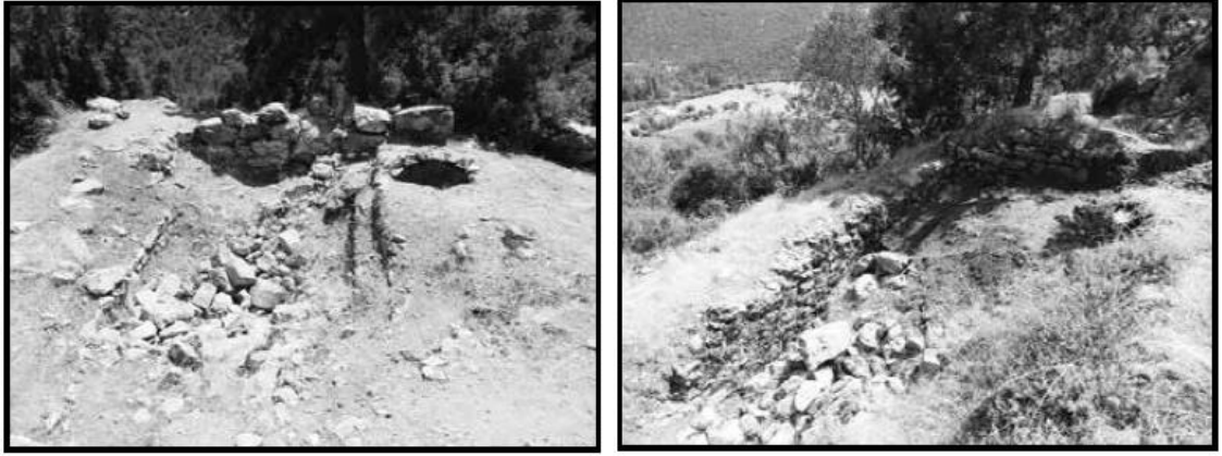
Figür 212-213: Kale Yıkığı Mevkii, mekânlar
