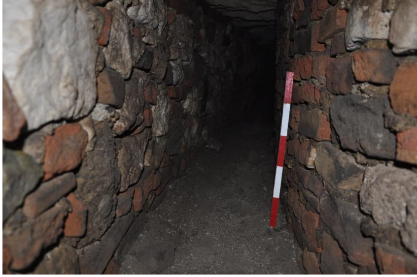
Figür 173: Roma hamam kompleksi kanalizasyon sistemi
