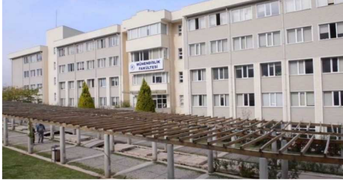
Şekil 3 Mühendislik Fakültesi (Kınıklı Kampusu yeni bina)
