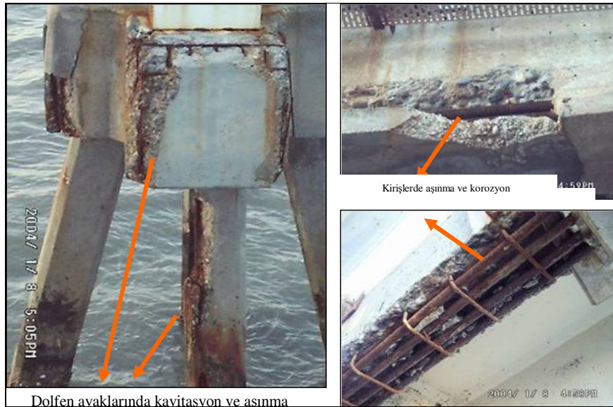
Resim 2. Kerkük-Ceyhan petrol boru hattı ceyhan platformunda hasar.
