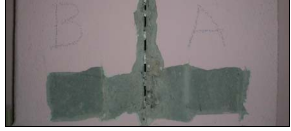
Şekil 23: Tavşanlı Cumhuriyet Lisesi Binası ilk üç katında derz uygulaması, (Kaplan ve ark., 2006c).
