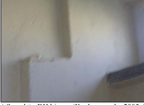
a) Sarayköy DH binası, (Kaplan ve ark., 2005g).
