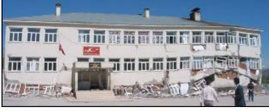
Şekil 2. 1.5.2003 Bingöl Depreminde yıkılan İlköğretim Okulu binası
