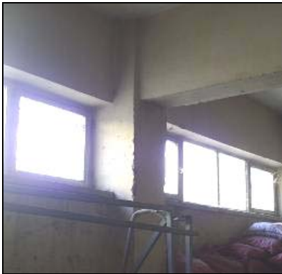
Şekil 19. Denizli, Sevil Kaynak İÖO binasında kısa kolon uygulaması (Kaplan ve ark., 2005f).
