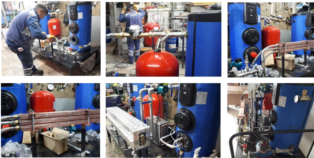
Şekil 3.37: Sıcak/Soğuk su sirkülasyon sistemi montaj aşamaları.
