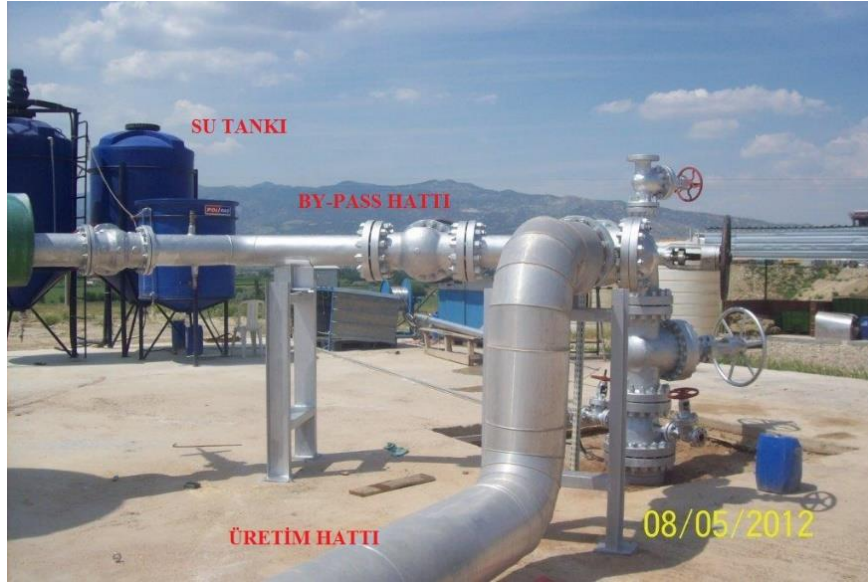
Şekil 3.2: Jeotermal santral kuyusu, by-pass ve üretim hatları.
