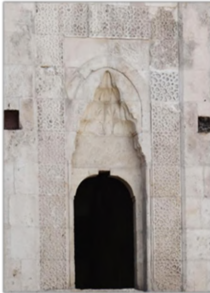
Fotoğraf 11: Giriş eyvanından avluya açılan taçkapı modelindeki bursa kemerli açıklık
