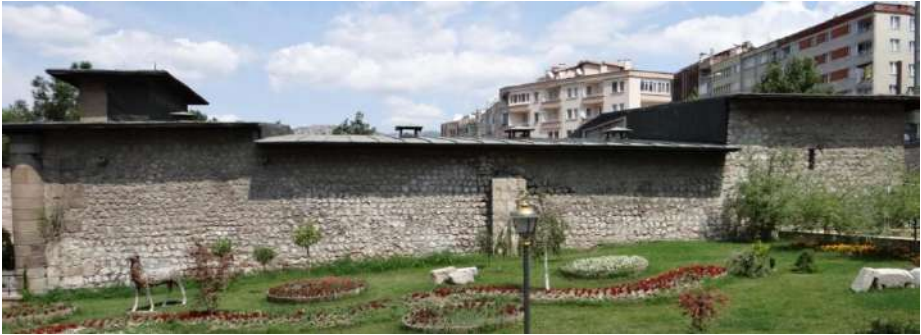
G. 2: Amasya Darüşşifası'nın güney cephesi
