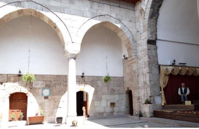
G. 17: Amasya Darüşşifası'nda avlunun kuzeydoğu köşesi (güneyden)
