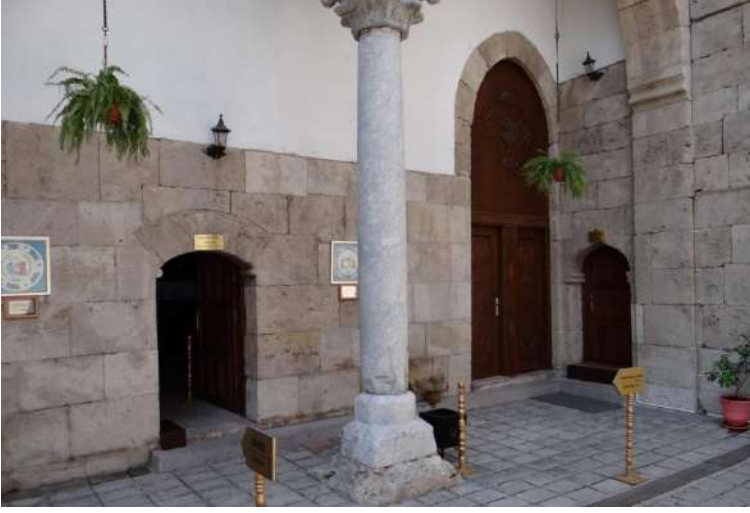
G. 14: Amasya Darüşşifası, avlunun güneybatı köşesi (kuzeydoğudan)
