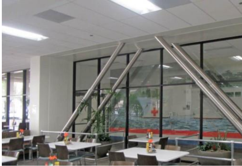
Şekil 1.6: Akışkan Viskoz Sönümleyici Uygulama Örneği
