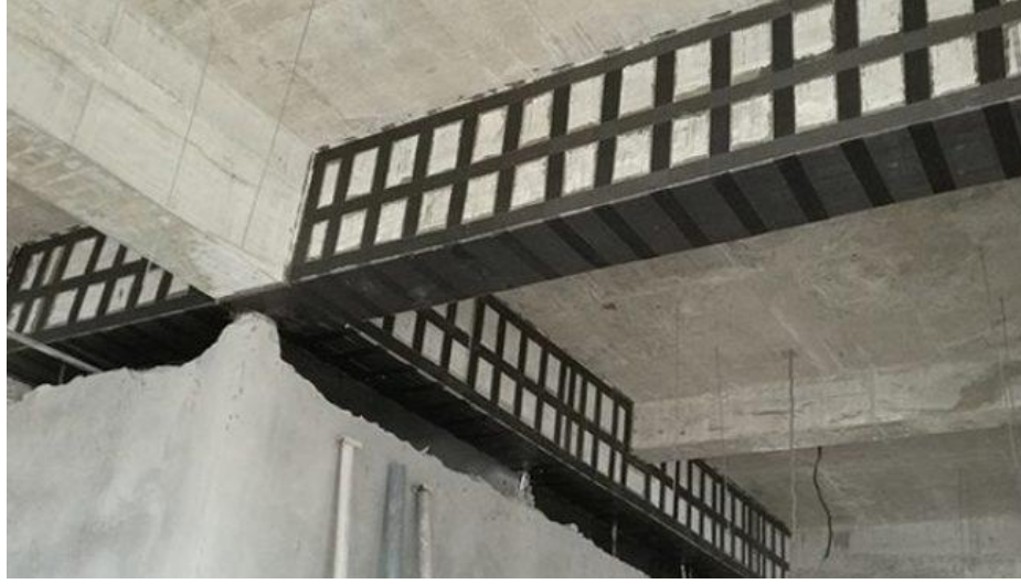
Şekil 1.3: Kiriş Güçlendirme İşlemi
