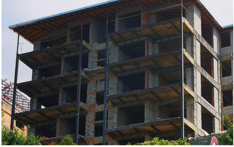
Şekil 1.4: Hatalı Çelik Mantolama İşlemi
