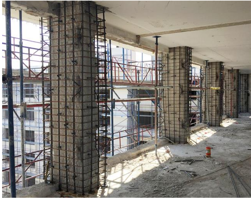
Şekil 1.2: Betonarme manto ile kolon güçlendirilmesi
