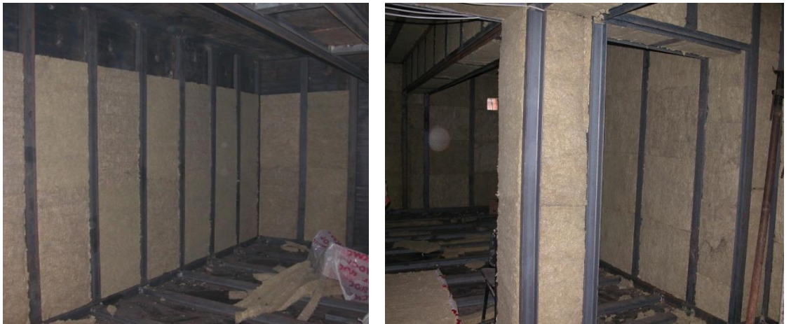
Fig. 120-121: Birinci Kat Yazma Eser Deposunun Yapılış Aşamaları (KYEBM Arşivi)
