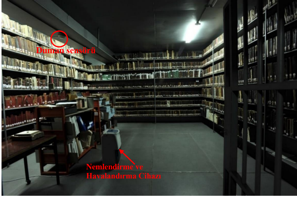
Fig. 140: Bodrum Kat Yazma Eser Deposu (KYEBM Arşivi)
