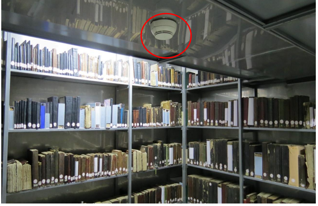
Fig. 149: Birinci Kat Yazma Eser Deposu, Duman Sensörü (KYEBM Arşivi)
