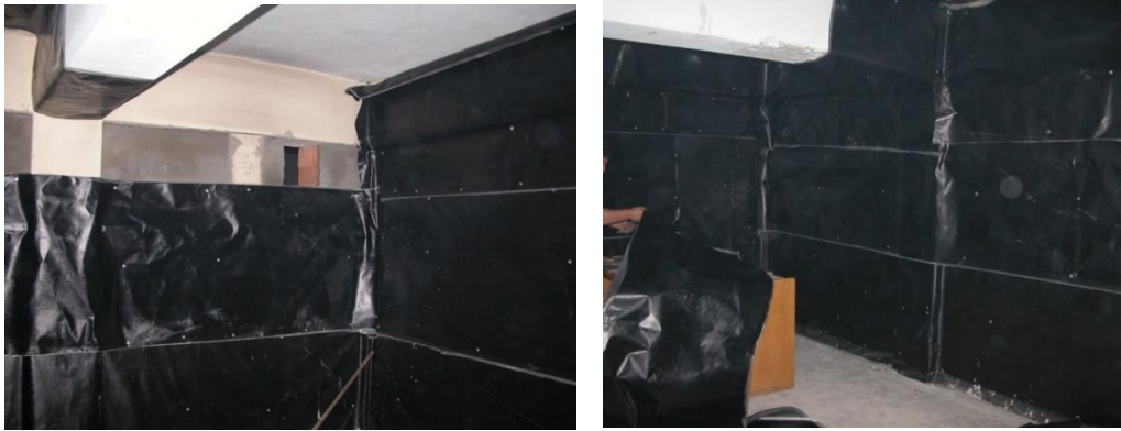
Fig. 114-115: Birinci Kat Yazma Eser Deposunun Yapılış Aşamaları (KYEBM Arşivi)
