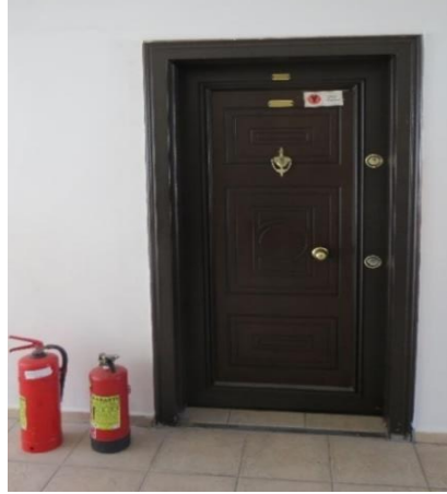
Fig. 147: İkinci Kat Matbu Eser Deposu Önünde Yer Alan Yangın Tüpleri (KYEBM Arşivi)
