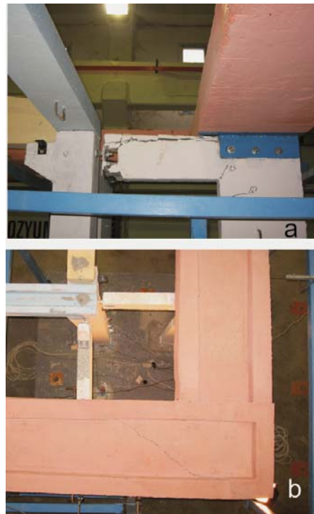
Şekil 16. Gözlenen hasarlar (Observed damages)
