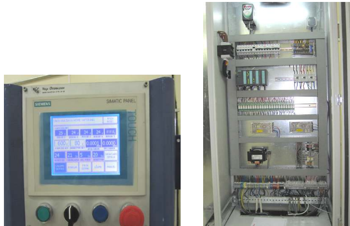
řekil 10. (a) Dokunmatik kontrol paneli (b) PLC ve otomasyon panosuna
