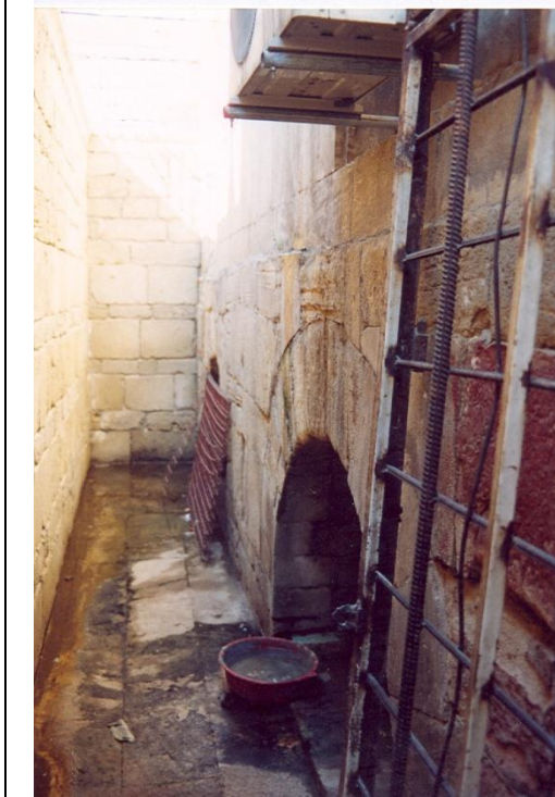
Fotoğraf 12 Bakü Aşur Mescidi güneydoğu cephesi altkati
