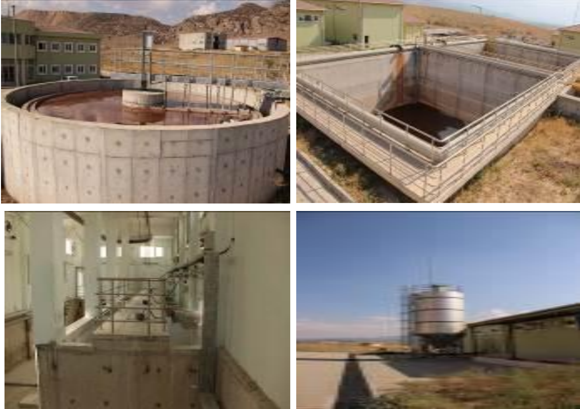
Fotoğraf 9-10-11-12: Denizli Deri İhtisas Organize Sanayi Bölgesi Arıtma Tesisleri
