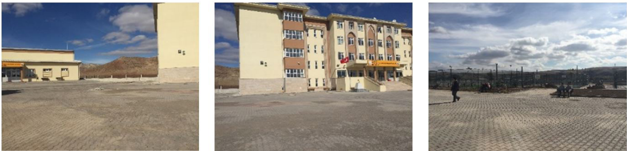
Şekil 2. Araştırma alanının mevcut durumu görünümü
