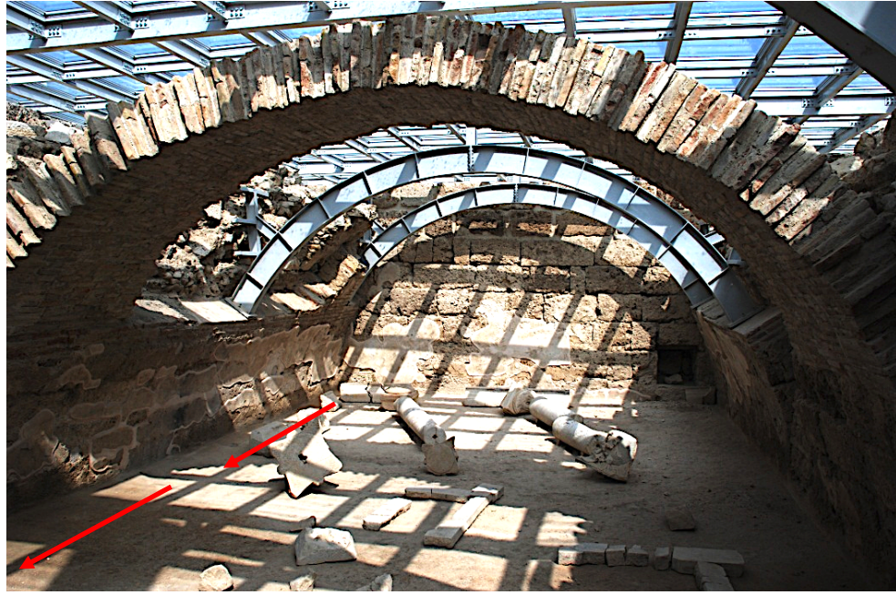
Figür 56. Tonozlu mekan batı bölümü
