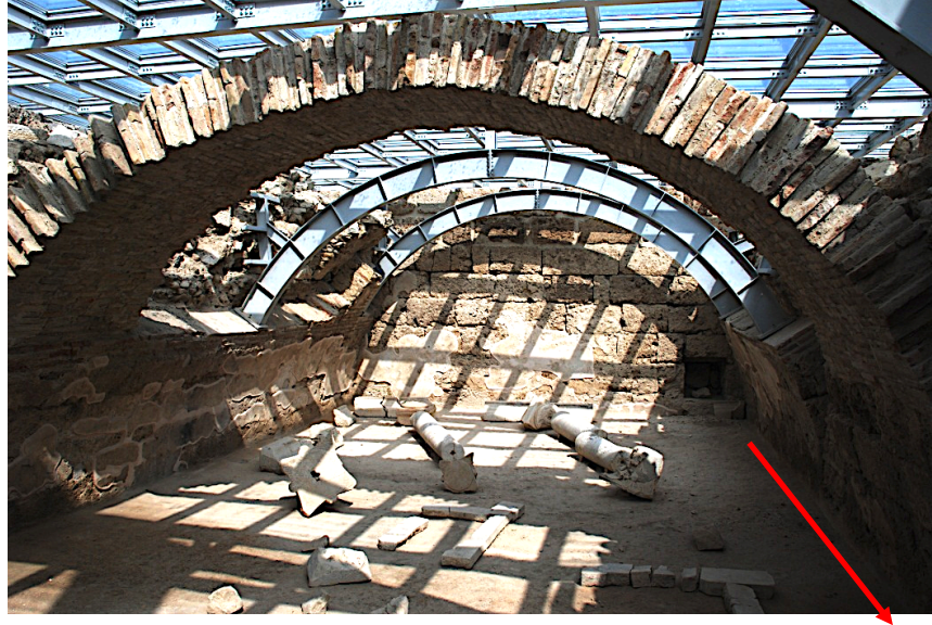
Figür 57. Tonozlu mekan güneydoğu bölümü
