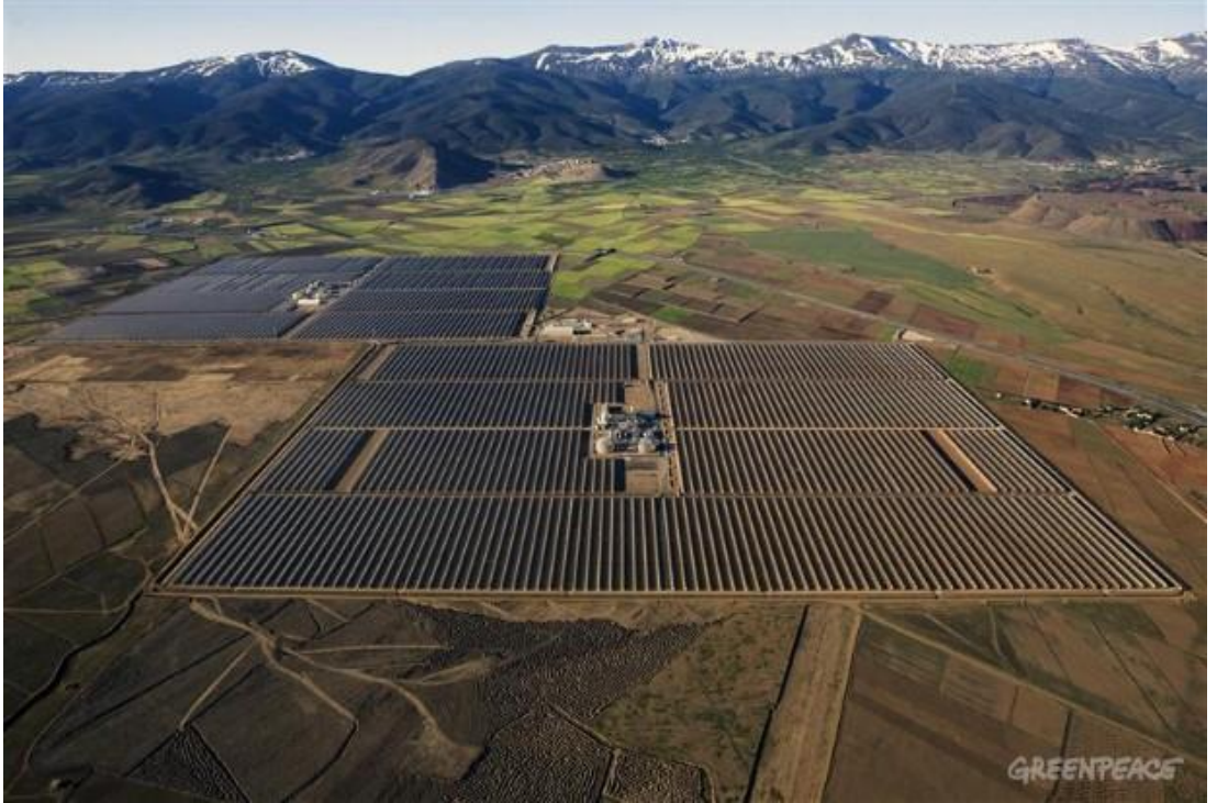
Şekil 3.4: İspanya-Andasol Güneş Enerji Santrali (Greenpeace, 2016)
