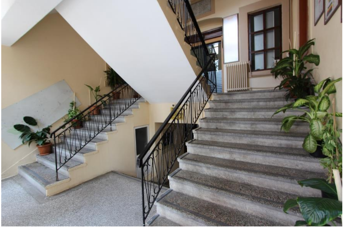
Fotoğraf 277: Balıkesir Gureba Hastanesi, Zemin ve Birinci Katlara Geçişi Sağlayan Merdiven
