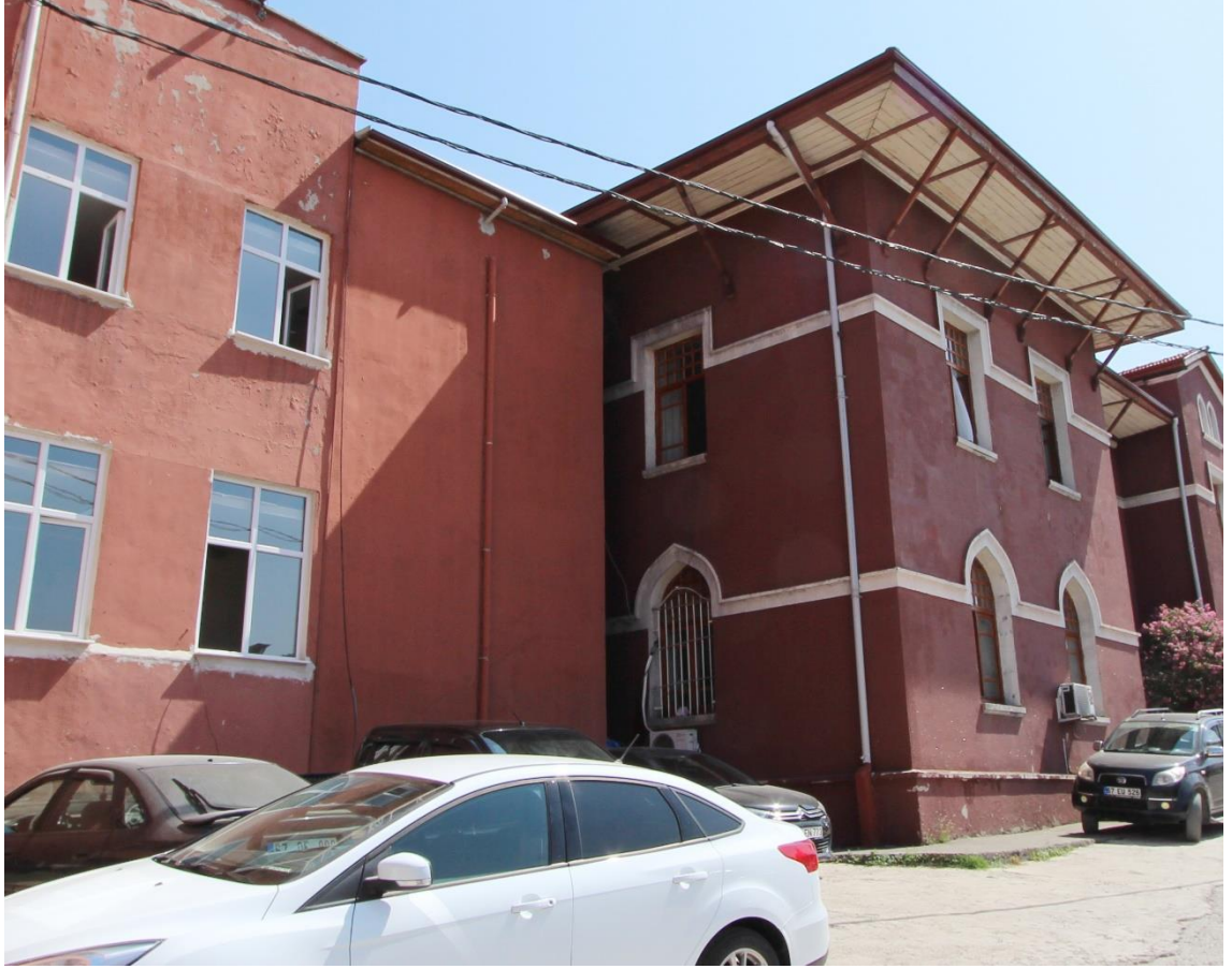
Fotoğraf 771: Zonguldak Amele (Memleket) Hastanesi, Kuzey Cephesi
