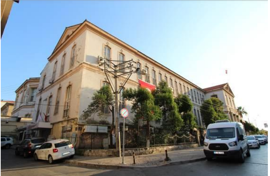
Fotoğraf 353: İzmir Gureba-i Müslimin Hastanesi Kuzeydoğudan Görünüşü
