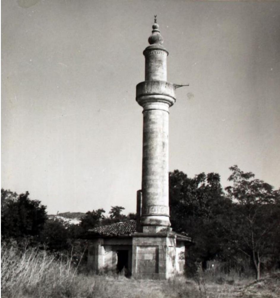
Fotoğraf 275: Edirne Merkez Hastanesi Camii (Edirne Kùltür Varlıklarını Koruma Bölge Kurulu Müdürlüğü Arşivi)
