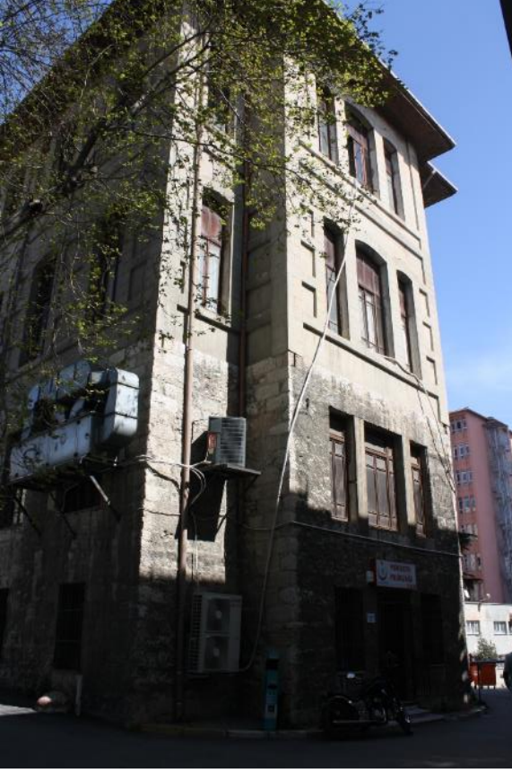
Fotoğraf 507: Haydarpaşa Numune Hastanesi, Beşinci Blok, Güney Cephesi
