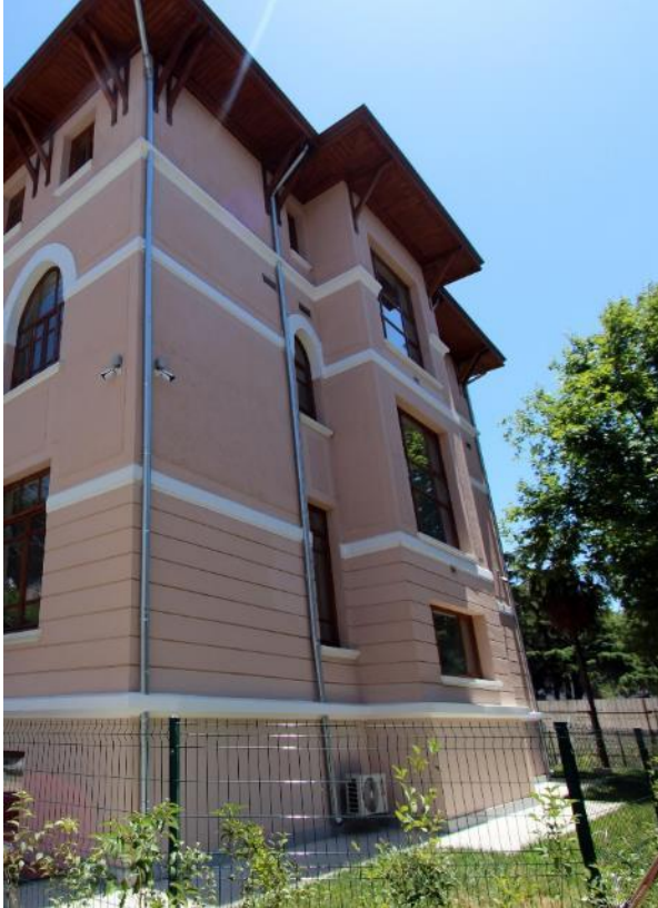
Fotoğraf 686: Cerrahpaşa Hastanesi, Merkez Dairesi, Batı Cephesi
