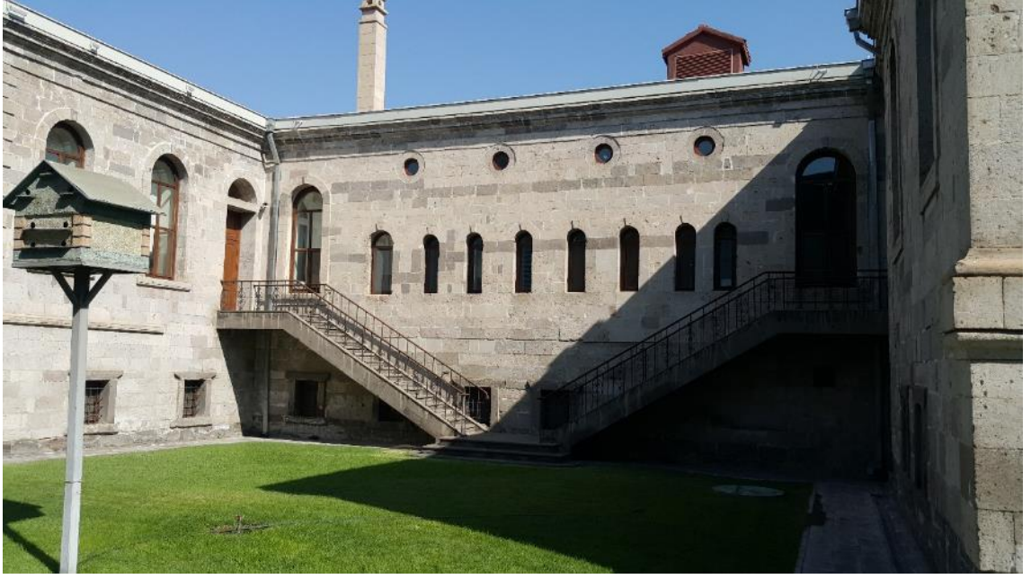
Fotoğraf 198 :Kayseri Memleket Hastanesi, Doğu Kanat ile Orta Kolun Arasında Kalan Ana Bloğun Güney Cephesi
