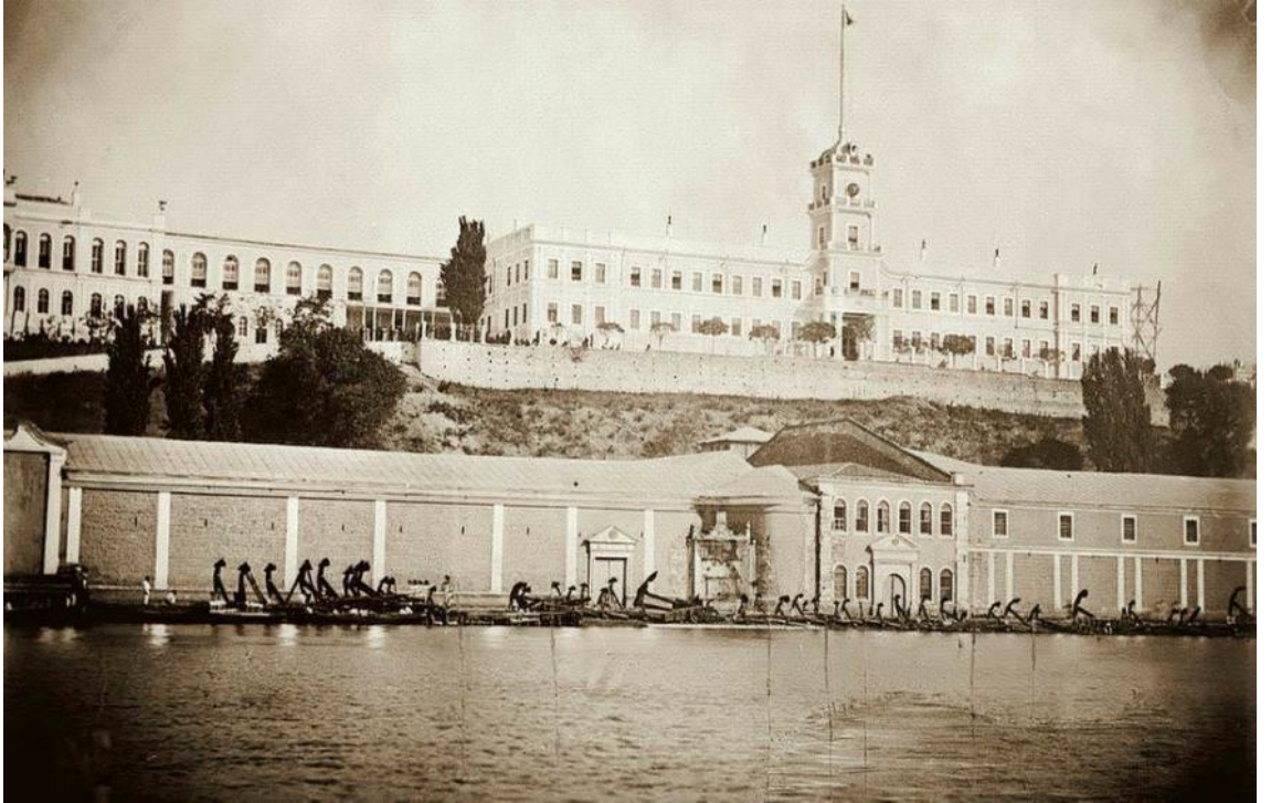
Fotoğraf 646: Kasımpaşa Bahriye (Tersane-İ Âmire) Hastanesi Cerrahi Binası, Güneybatı Cephesi ( http://www.eskiistanbul.net/4960/kasimpasa-deniz-hastanesi#lg=0&slide=0 )
