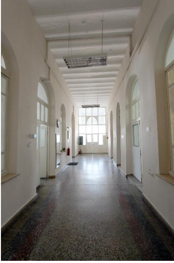
Fotoğraf 637: Kasımpaşa Bahriye (Tersane-İ Âmire) Hastanesi Cerrahi Binası, Zemin Kat, Güneydoğu Koridoru
