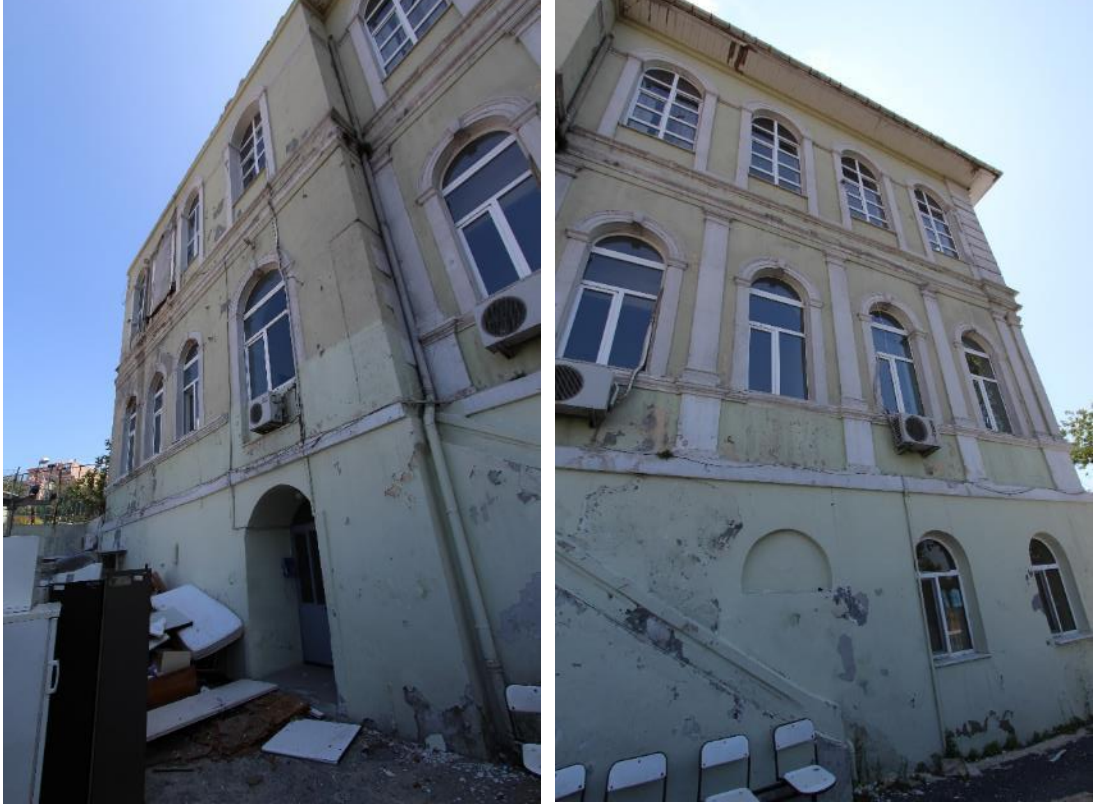
Fotoğraf 643: Kasımpaşa Bahriye (Tersane-İ Âmire) Hastanesi Cerrahi Binası, Kuzeybatı Cephesi
