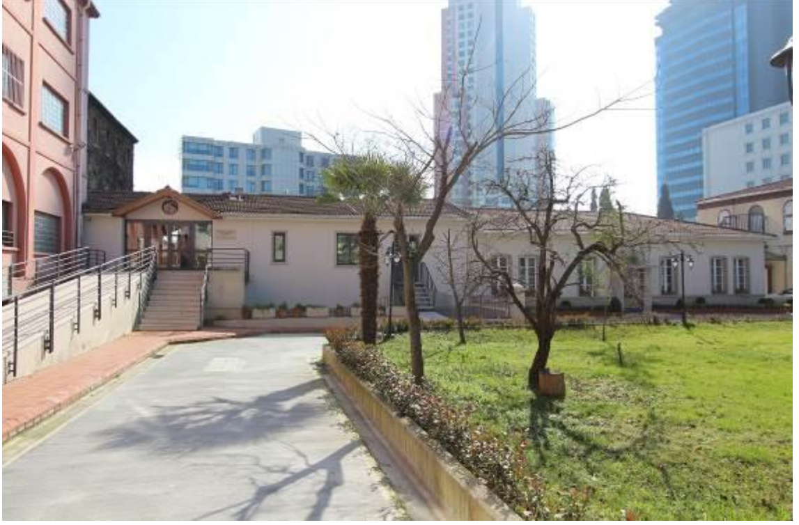
Fotoğraf 114: Fransız Lape Hastanesi, C Blok, Kuzeybatı Cephesi
