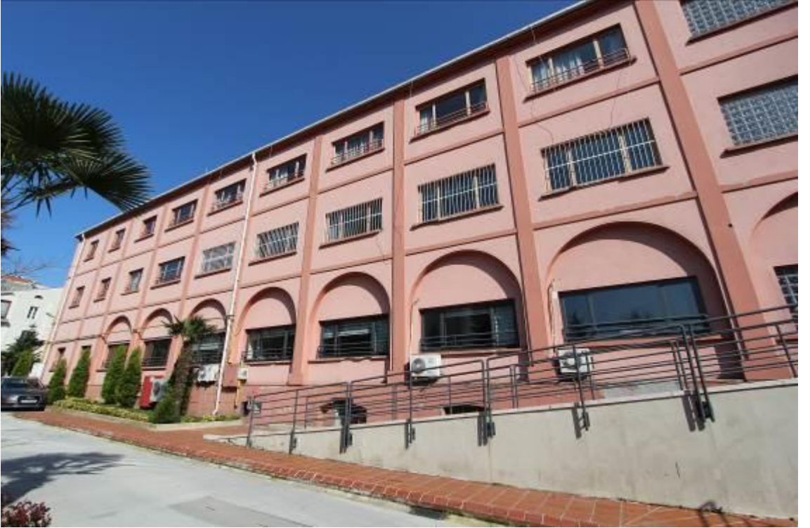
Fotoğraf 113: Fransız Lape Hastanesi, B Blok, Güneybatı Cephesi
