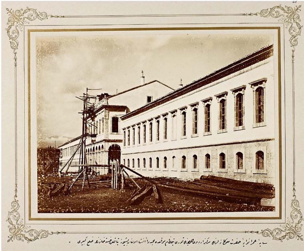
Fotoğraf 808: Erzincan Kurutilek Askeri Hastanesi, Ana Kanadın Bahçeye Bakan Cephesi (İstanbul Üniversitesi Nadir Eserler Kütüphanesi, Ftg. No: 91121/29)
