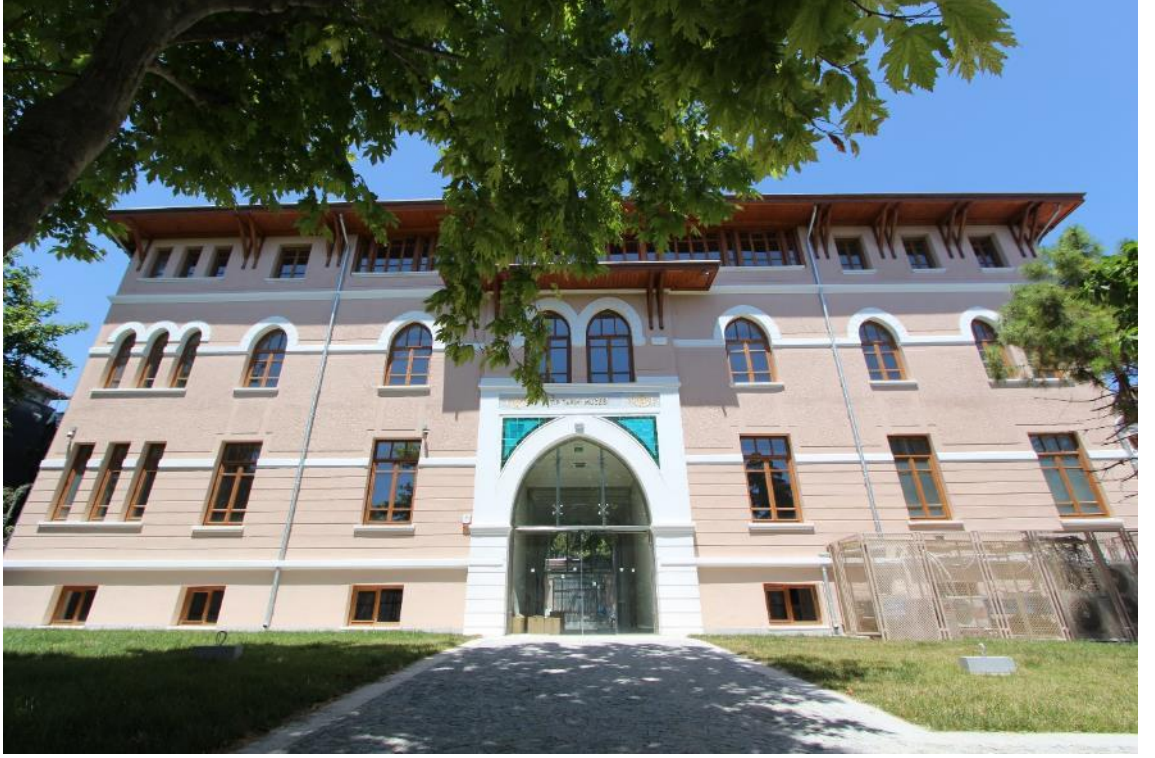
Fotoğraf 685: Cerrahpaşa Hastanesi, Merkez Dairesi, Güney Cephesi
