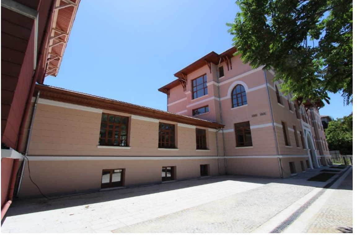
Fotoğraf 689: Cerrahpaşa Hastanesi, Merkez Dairesi, Doğu Cephesi
