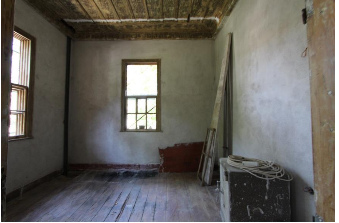
Fotoğraf 517: Kayseri Talas Amerikan Hastanesi, Zemin Kat Giriş Holünün Kuzeyindeki Oda
