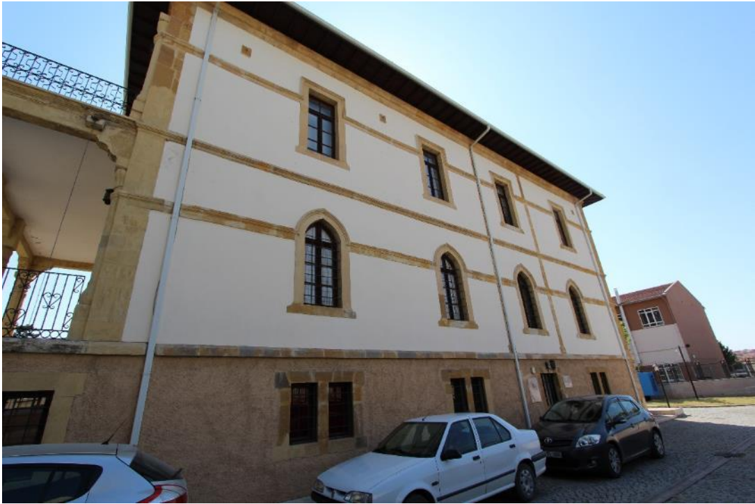
Fotoğraf 728: Çorum Emrâz-ı Umumiye Hastanesi, Batı Cephesi
