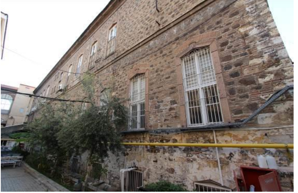
Fotoğraf 358: İzmir Gureba-i Müslimin Hastanesi, İkinci Blok Güney Cephesinin Doğusu
