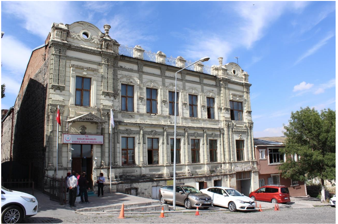
Fotoğraf 778: Kars İl Sağlık Müdürlüğü Binası (Kars Eski Hastanesi), Genel Görünüşü
