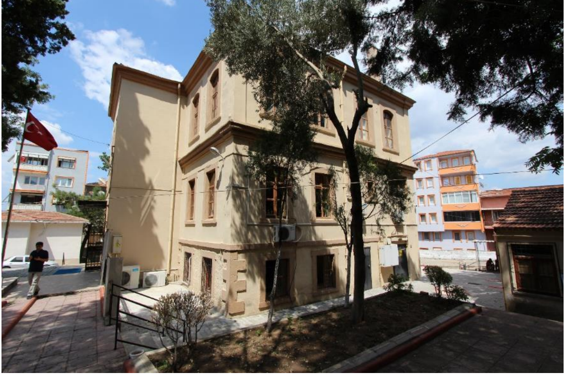
Fotoğraf 286: Balıkesir Gureba Hastanesi, Kuzey Cephesi
