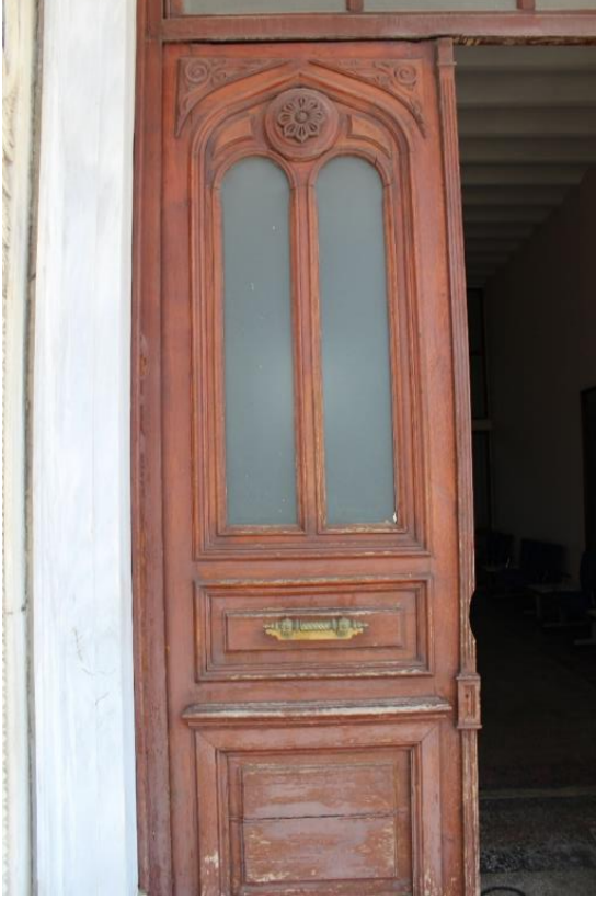
Fotoğraf 651: Kasımpaşa Bahriye (Tersane-İ Âmire) Hastanesi Cerrahi Binası, Ana Kapı Ahşap Kanadı
