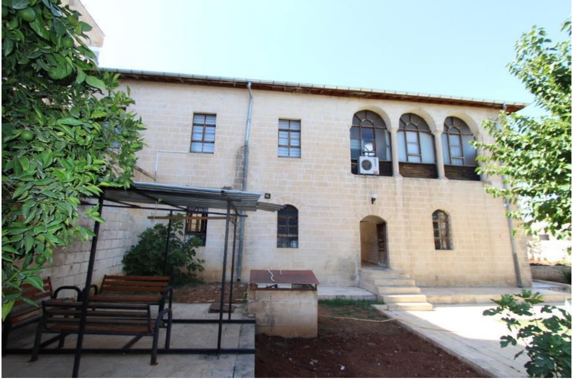
Fotoğraf 553: Urfa İsviçre Hastanesi, Ana Bina, Güney Cephesi
