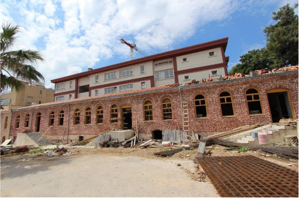
Fotoğraf 398: Zeytinburnu Askeri Hastanesi, Güneybatı Ek Binası
