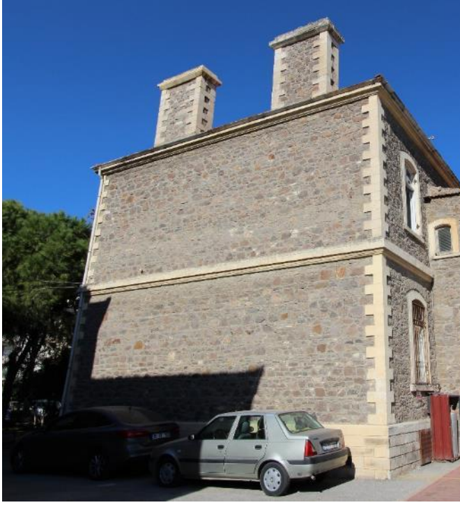
Fotoğraf 424: İzmir İngiliz Hastanesi, A Blok, Güney Cephesi
