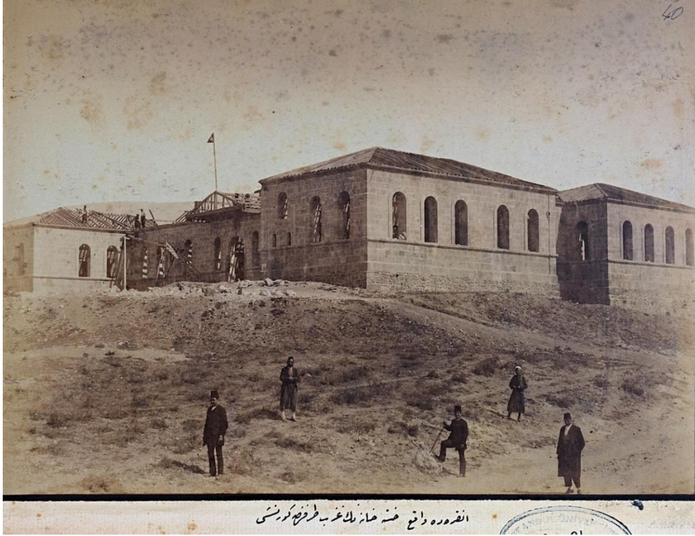
Fotoğraf 803: Ankara Gureba Hastanesi Kuzey ve Batıdan Görünüŧü (İstanbul Üniversitesi Nadir Eserler Kütüphanesi, Ftg. No: 90431/40)
