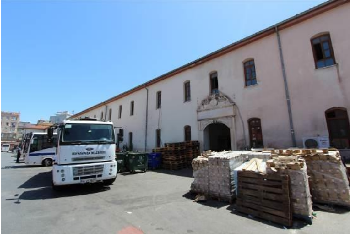
Fotoğraf 5: Maltepe Hastanesi, Kuzeybatı Cephesi
