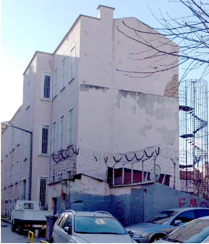
Fotoğraf 316: İstanbul Jeremy Hastanesi Kuzeydoğu Cephesi
