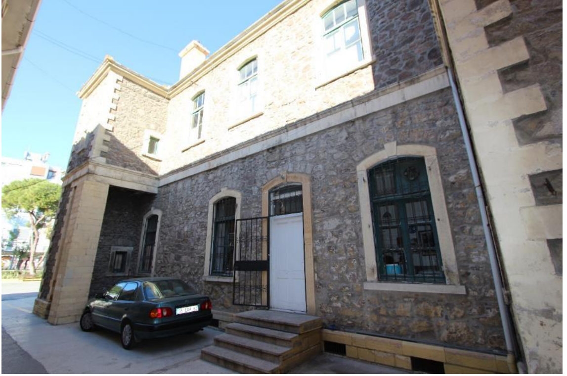
Fotoğraf 438: İzmir İngiliz Hastanesi, B Blok, Güney Cephesi
