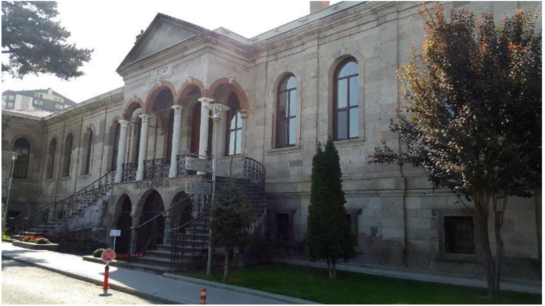
Fotoğraf 193: Kayseri Memleket Hastanesi, Kuzey Cephesi
