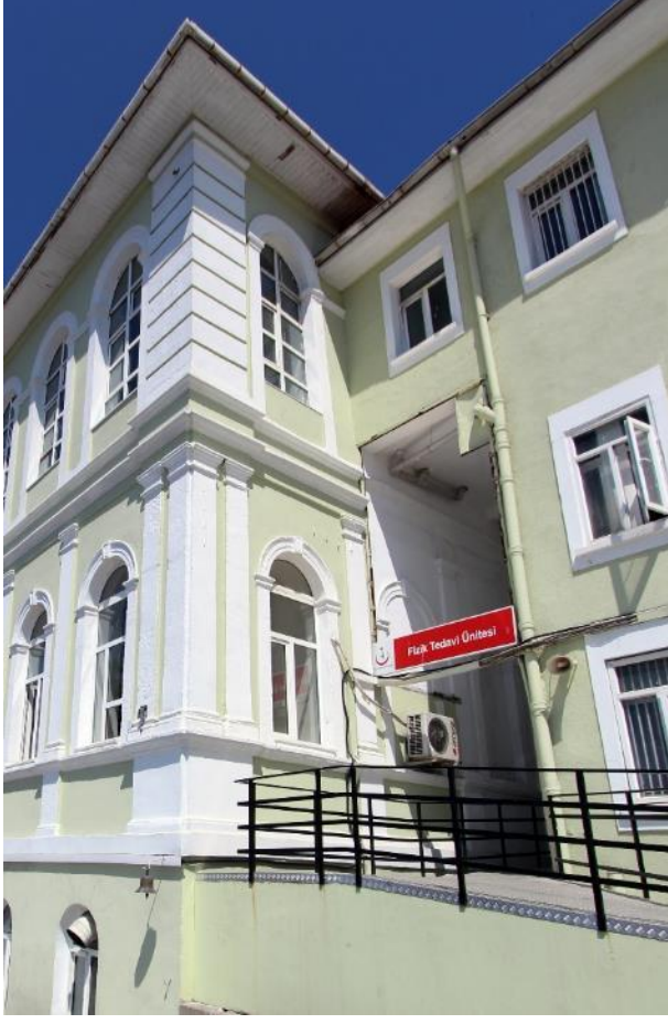
Fotoğraf 645: Kasımpaşa Bahriye (Tersane-İ Âmire) Hastanesi Cerrahi Binası, Güneydoğu Cephesi
