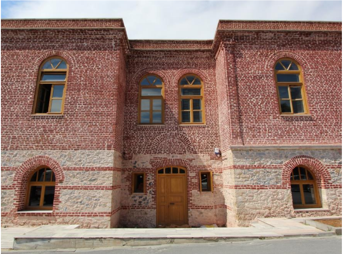
Fotoğraf 391: Zeytinburnu Askeri Hastanesi, Kuzeydoğu Cephenin Ortasındaki Girintili Kısım
