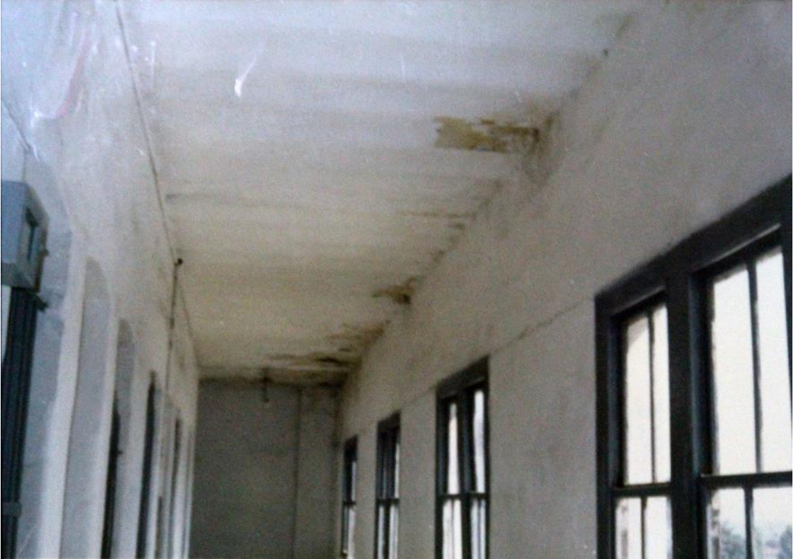
Fotoğraf 85: Gülhane Seririyat Hastanesi, Yıkılmadan Önce İç Kısımın Volta Tonozla Örtülü Koridor Tavanı (İstanbul 5 Numaralı Kültür Varlıklarını Koruma Bölge Kurulu Müdürlüğü Arşivi)
