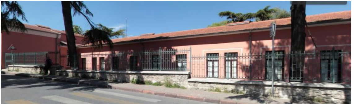
Fotoğraf 45: Bezmialem Vakıf Gureba Hastanesi, Güney Cephesi (Google Earth'den)
