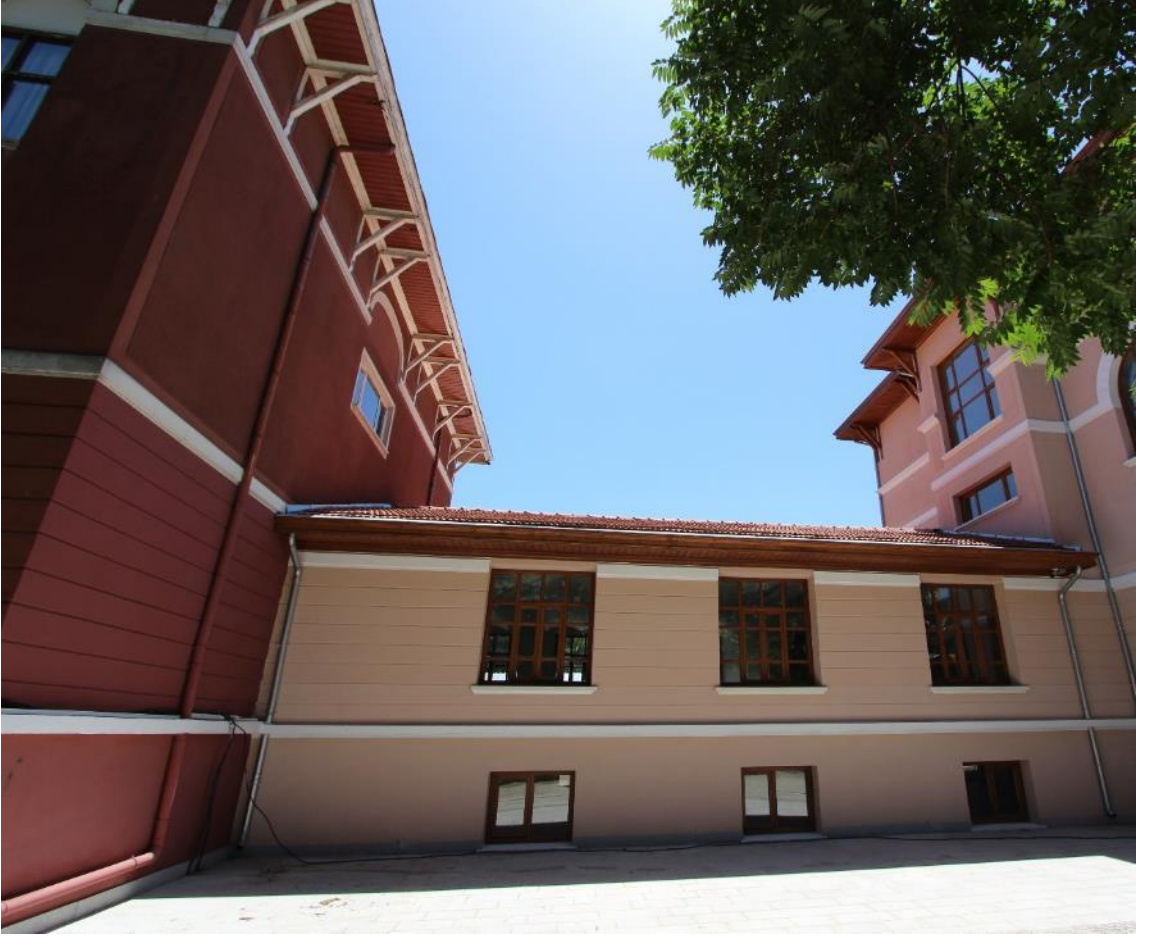
Fotoğraf 681: Cerrahpaşa Hastanesi, Cerrahi Binası, Batı Cephesi
