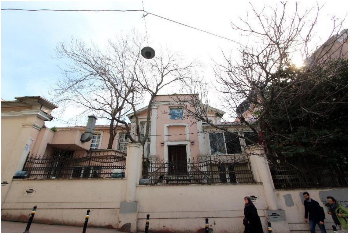
Fotoğraf 185: Alman Hastanesi, I Blok, Batı Cephesi
