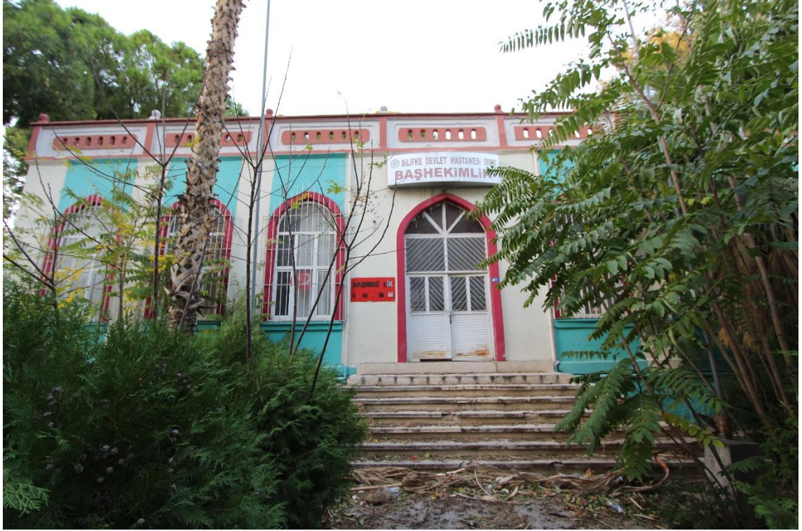
Fotoğraf 735: Mersin Silifke Gureba Hastanesi Güney Cephesi
