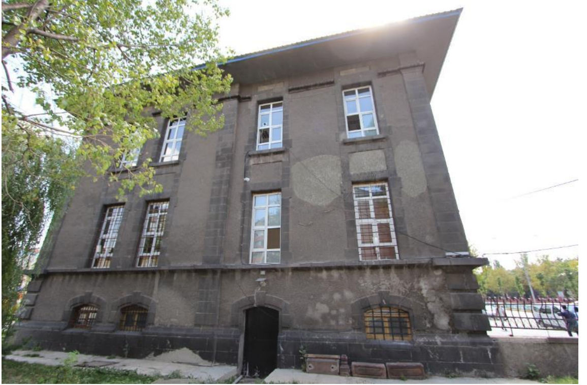
Fotoğraf 566: Erzurum Gureba Hastanesi, Kuzey Cephesi
