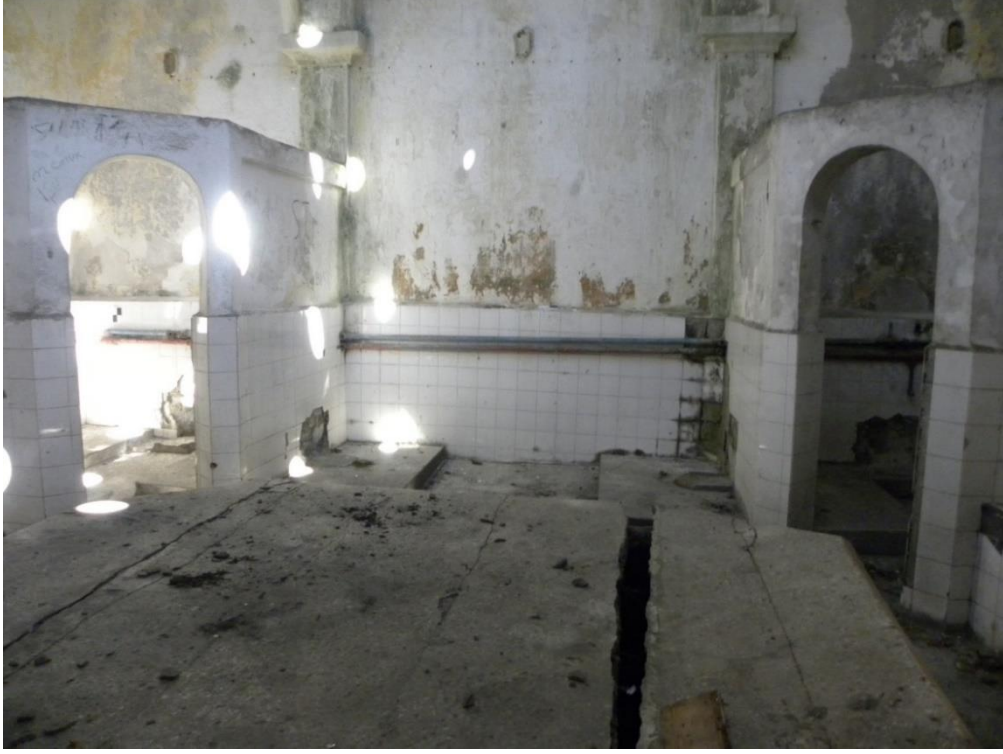
Fotoğraf 152: Trabzon Hamidiye Asker ve Gureba Hastanesi Hamamı Sıcaklığı (Trabzon Kültür Varlıklarını Koruma Bölge Kurulu Müdürlüğü Arşivinden)
