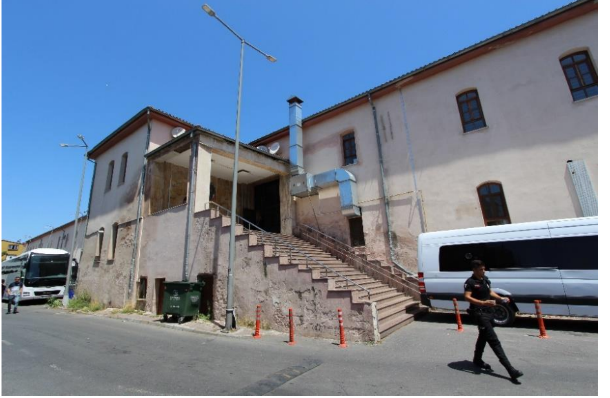
Fotoğraf 7: Maltepe Hastanesi, Güneybatı Cephesi
