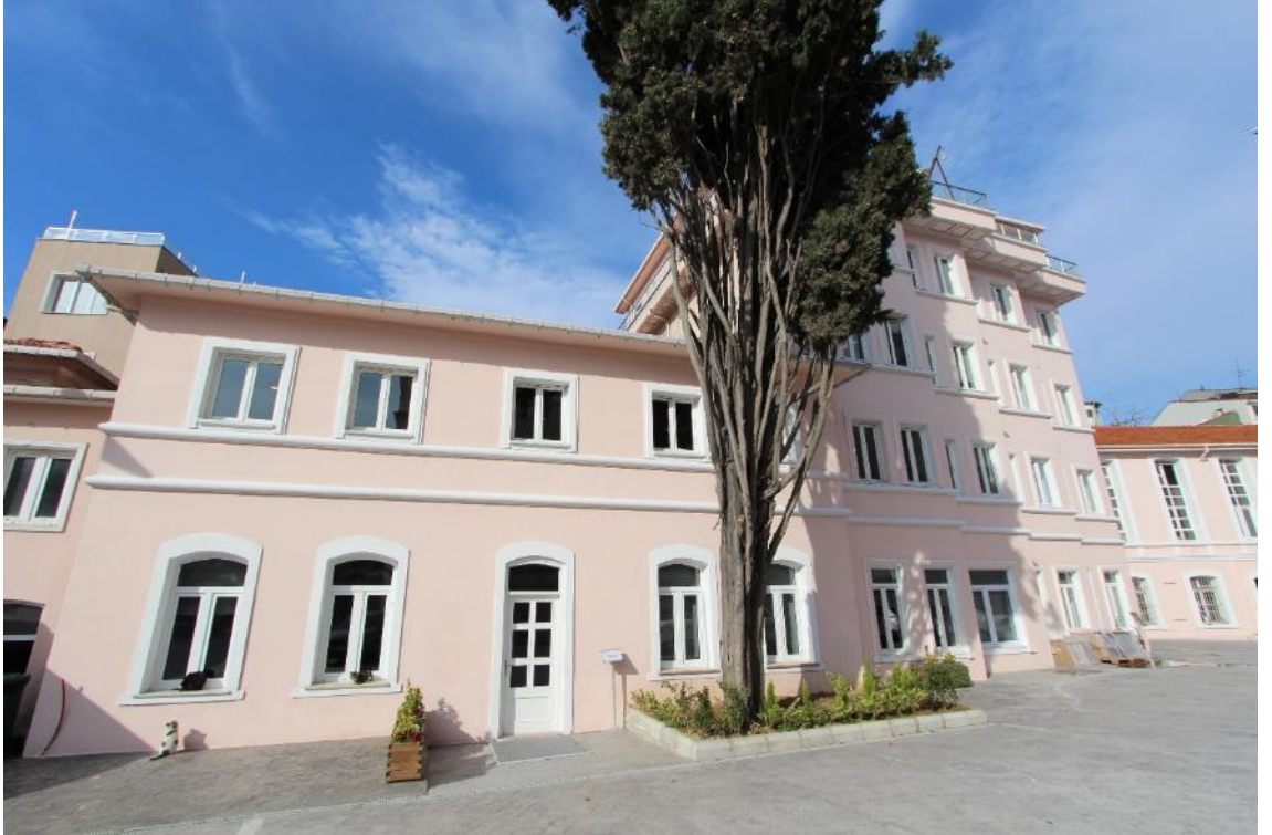
Fotoğraf 181: Alman Hastanesi, G ve H Blok, Doğu Cephesi
