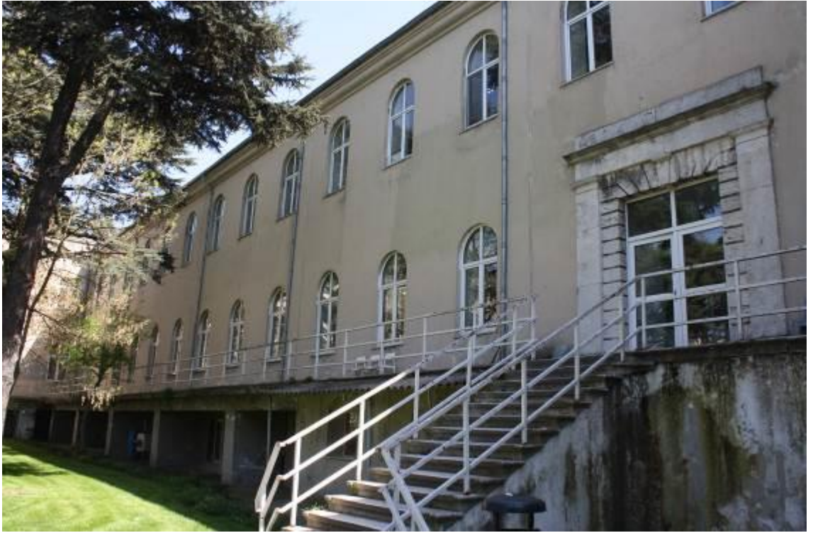
Fotoğraf 75: Haydarpaşa Askeri Hastanesi, Güneydoğu Kanat Avlu Cephesi
