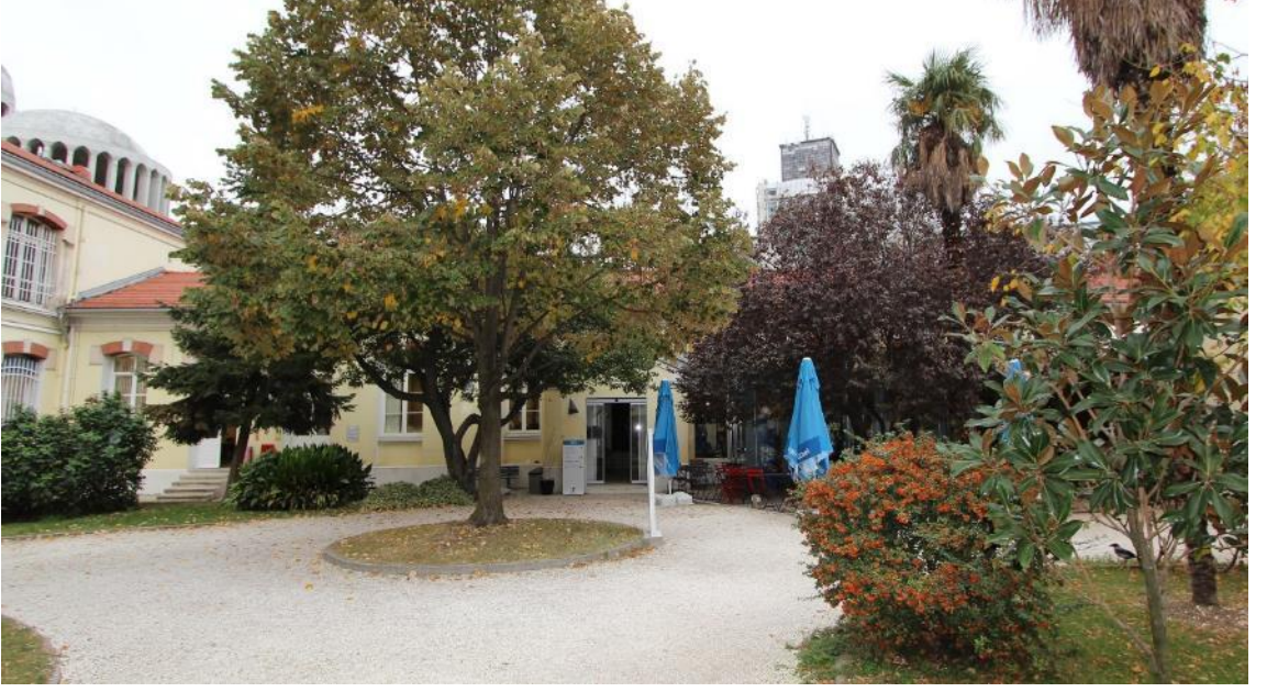
Fotoğraf 410: Henri Giffard Hastanesi, Doğu Kanadın Avluya Bakan Cephesi
