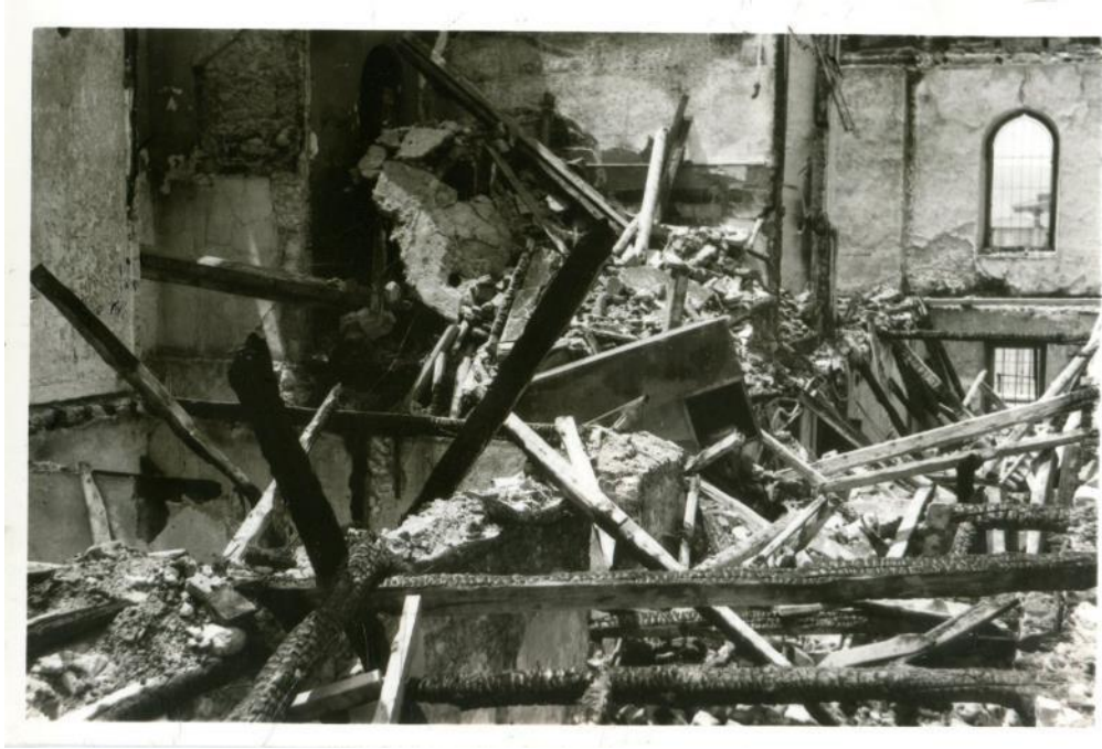
Fotoğraf 717: Çorum Emrâz-ı Umumiye Hastanesi, 1988 Yılı Yangınından Sonra İç Kısmından Görünüşü (Çorum Müzesi Arşivinden)
