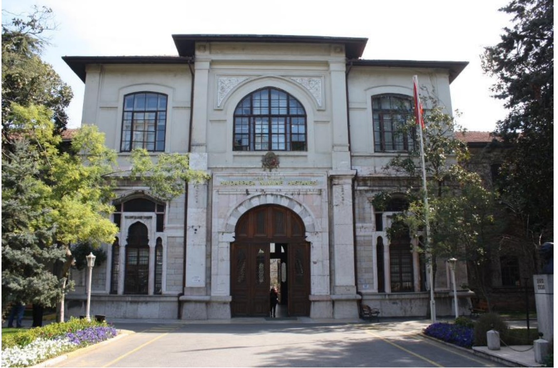
Fotoğraf 496: : Haydarpaşa Numune Hastanesi, Ana Blok, Batı Cephenin Ortasındaki Ana Girişi
