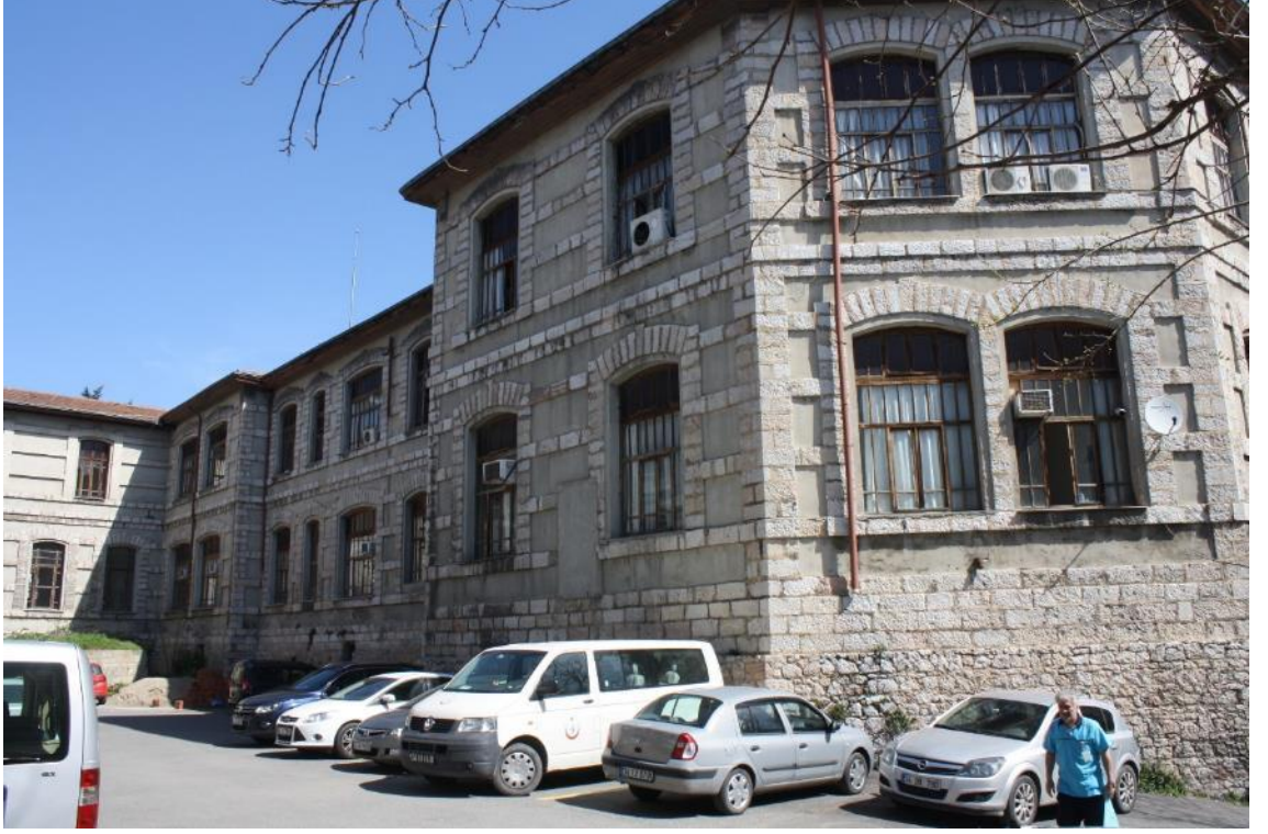
Fotoğraf 503: Haydarpaşa Numune Hastanesi, Dördüncü Blok, Batı Cephesi
