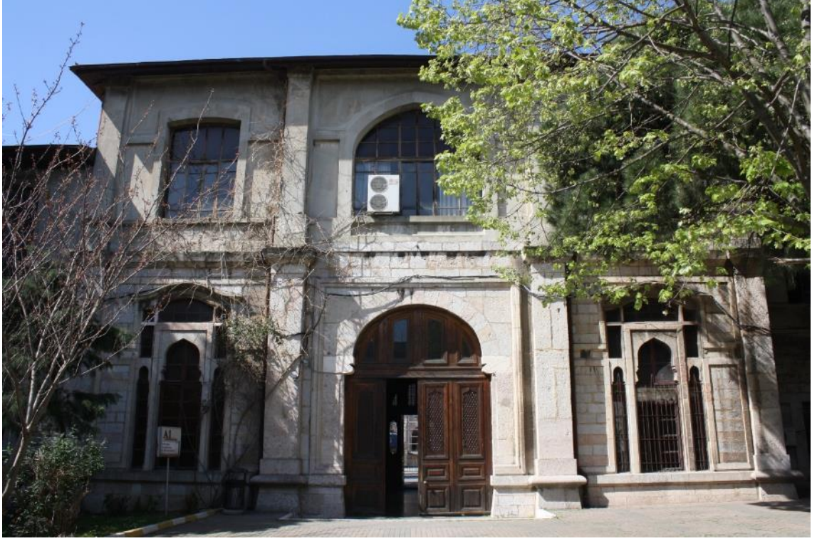
Fotoğraf 511: Haydarpaşa Numune Hastanesi, Ana Blok, Doğu Cephenin Ortasındaki Giriş Kısmı
