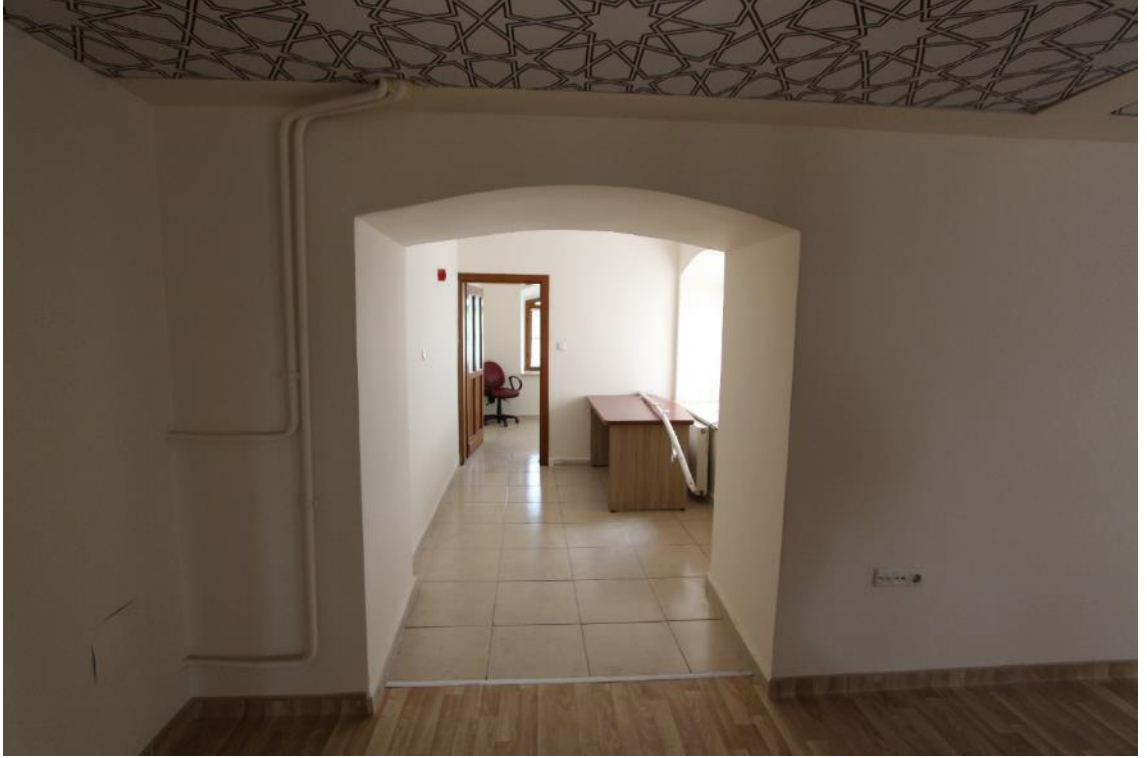
Fotoğraf 699: Balıkesir Reşit Bey Hastanesi, Bodrum Kat, Kuzey Mekânı
