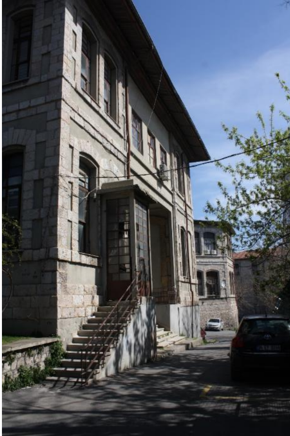
Fotoğraf 500: Haydarpaşa Numune Hastanesi, Üçüncü Blok, Güney Cephesi
