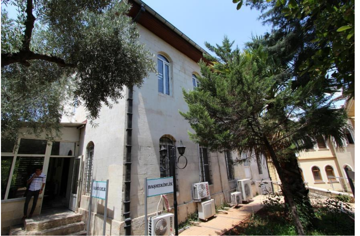
Fotoğraf 225: Antep Amerikan Hastanesi, İdare Binası, Güneybatıdan Görünüşü
