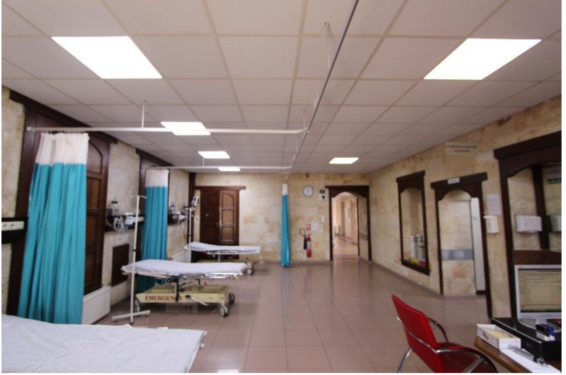
Fotoğraf 214: Antep Amerikan Hastanesi, Marston Binası, Zemin Kat Kuzeydoğu Odası
