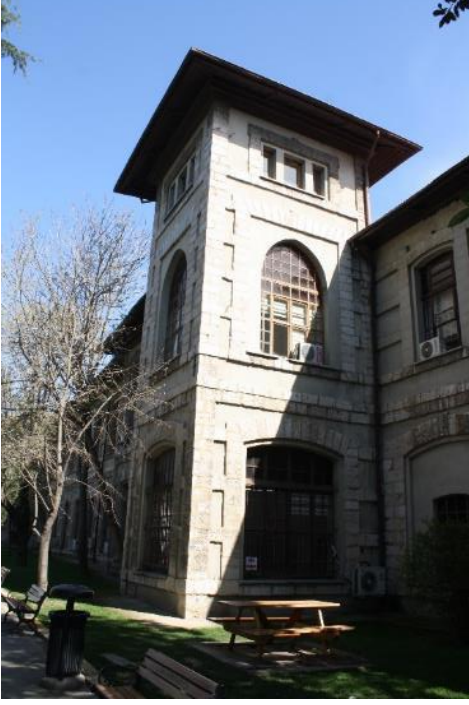
Fotoğraf 497: Haydarpaşa Numune Hastanesi, Ana Blok, Batı Cephenin Kuzeyindeki Kule
