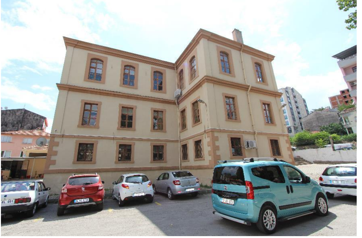
Fotoğraf 284: Balıkesir Gureba Hastanesi, Güney Cephesi
