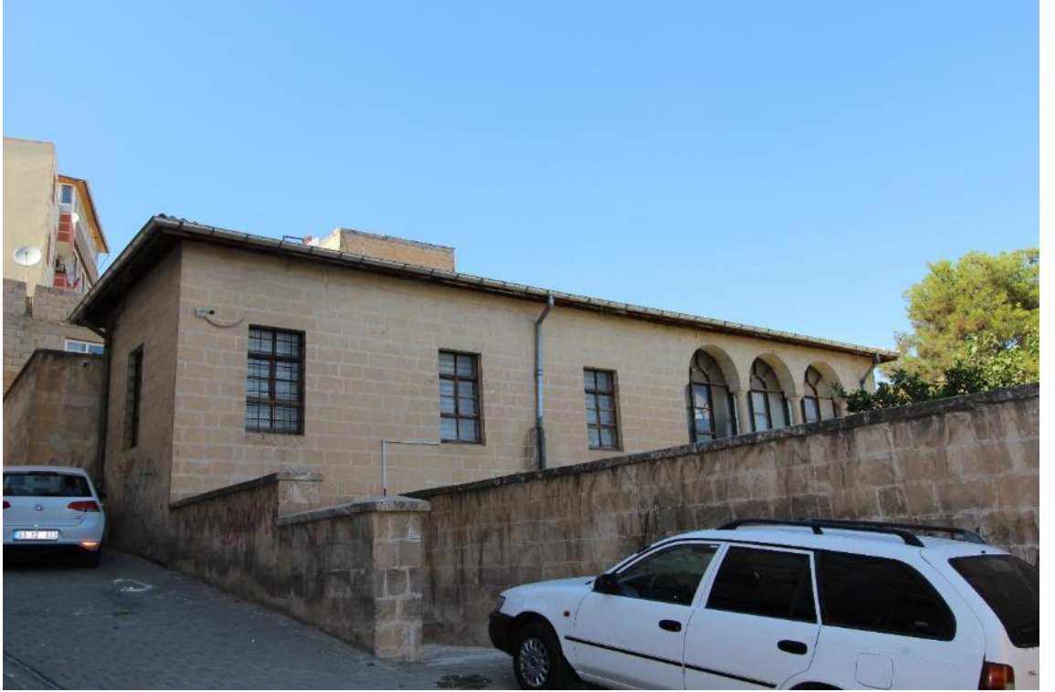
Fotoğraf 554: Urfa İsviçre Hastanesi, Ana Bina, Güney ve Batı Cephelerden Görünüşü
