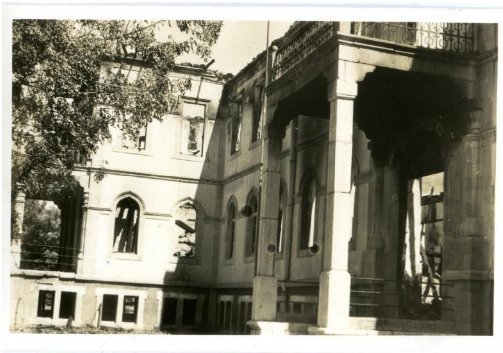
Fotoğraf 716: Çorum Emrâz-ı Umumiye Hastanesi, 1988 Yılı Yangınından Sonra Kuzey Cephenin Durumu (Çorum Müzesi Arşivinden)
