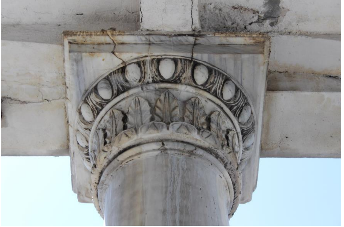
Fotoğraf 647: Kasımpaşa Bahriye (Tersane-İ Âmire) Hastanesi Cerrahi Binası, Sütun Başlığı Detayı
