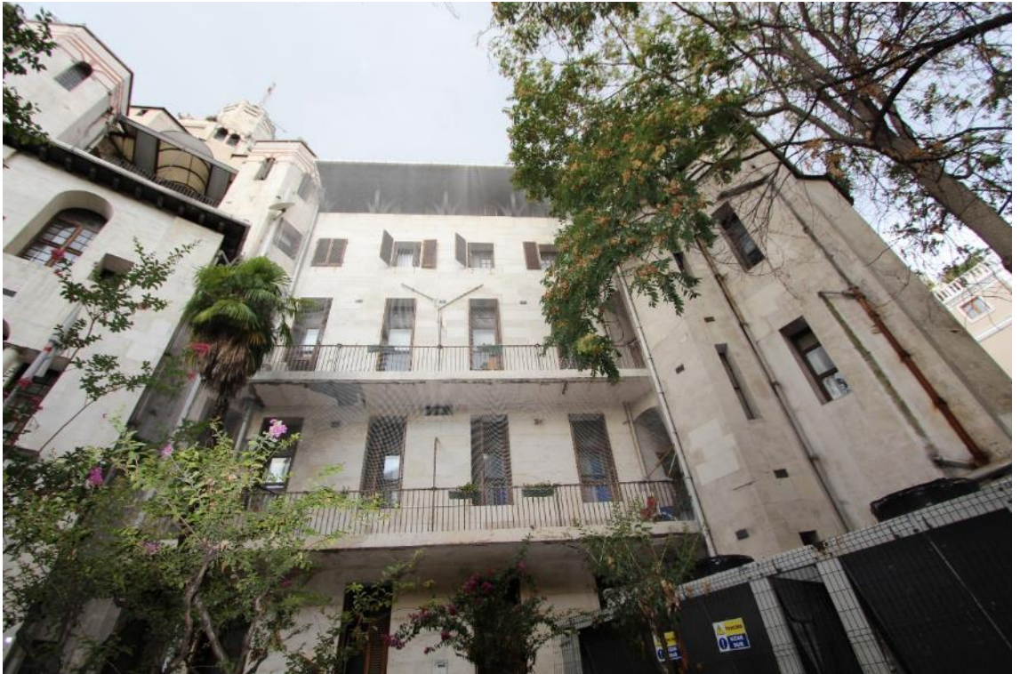
Fotoğraf 580: İstanbul İngiliz Hastanesi, Kuzeydoğu Kanadın Doğu Cephesi
