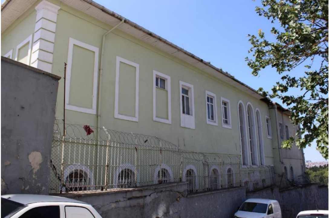
Fotoğraf 644: Kasımpaşa Bahriye (Tersane-İ Âmire) Hastanesi Cerrahi Binası, Kuzeydoğu Cephesi
