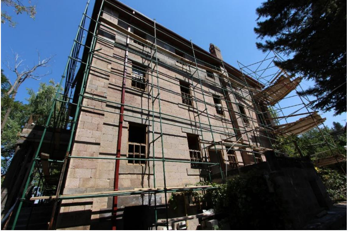
Fotoğraf 525: Kayseri Talas Amerikan Hastanesi, Güney Cephesi
