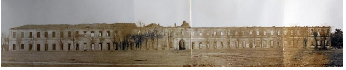
Fotoğraf 268: Edirne Merkez Hastanesi Güneybatı Cephesi (Edirne Kültür Varlıklarını Koruma Bölge Kurulu Müdürlüğü Arşivi)
