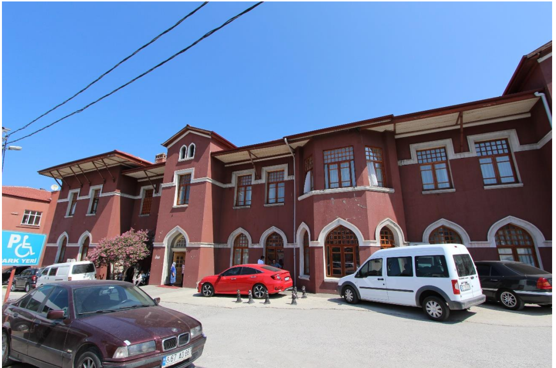
Fotoğraf 772: Zonguldak Amele (Memleket) Hastanesi, Batı Cephesi
