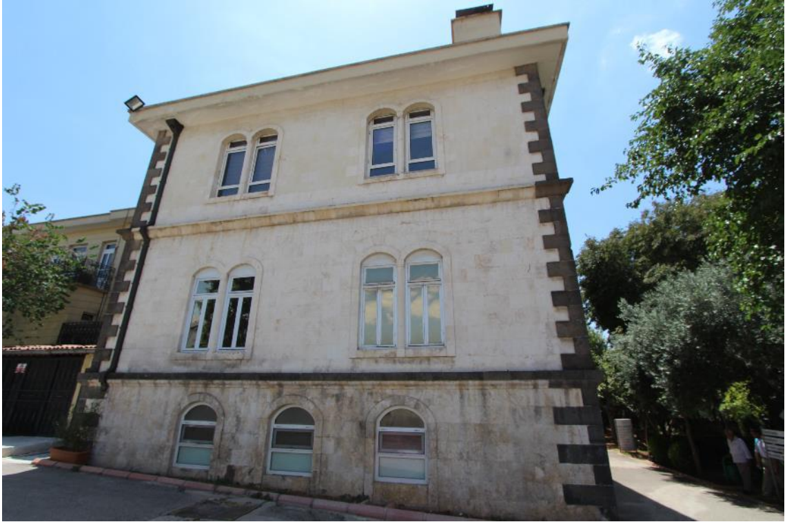
Fotoğraf 207: Antep Amerikan Hastanesi, Ana Bina, Batı Kanadın Kuzey Cephesi
