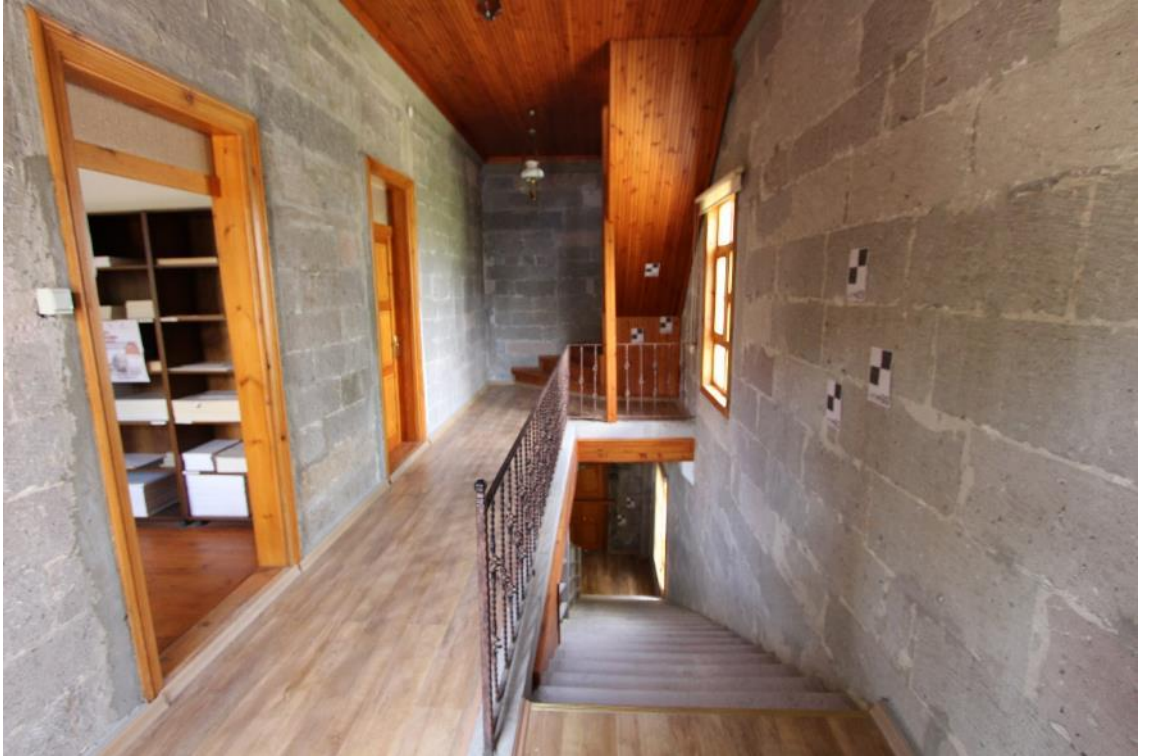
Fotoğraf 532: Kayseri Talas Amerikan Hastanesi, Dispanser Binası, Birinci Kat Koridoru
