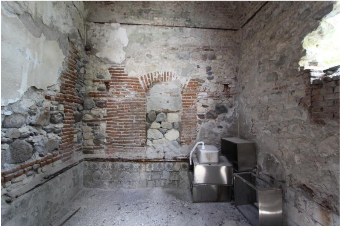
Fotoğraf 710: Balıkesir Reşit Bey Hastanesi Hamamı Sıcaklık Bölümü
