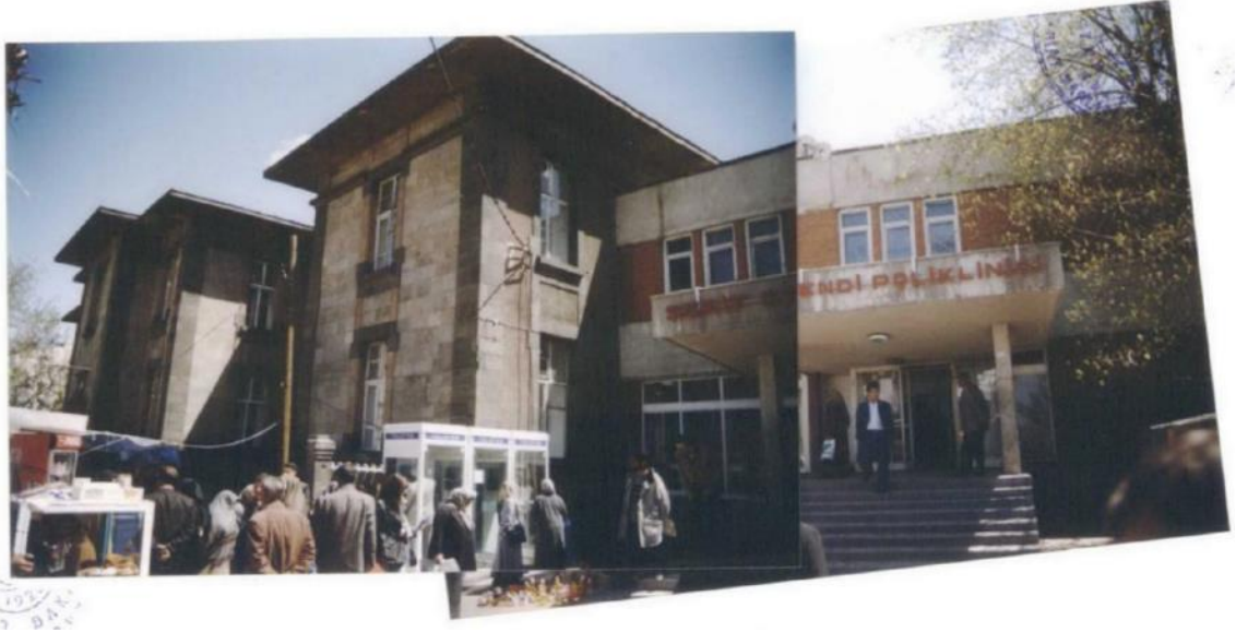
Fotoğraf 559: Erzurum Gureba Hastanesi, Güney Cepheye Bitişik Olarak Yapılmış Olan Ek Binanın Yıkılmadan Önceki Hali (Erzurum Kültür Varlıklarını Koruma Bölge Kurulu Arşivinden)
