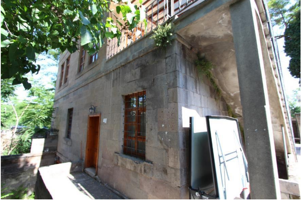
Fotoğraf 535: Kayseri Talas Amerikan Hastanesi, Dispanser Binası, Güney Cephesi
