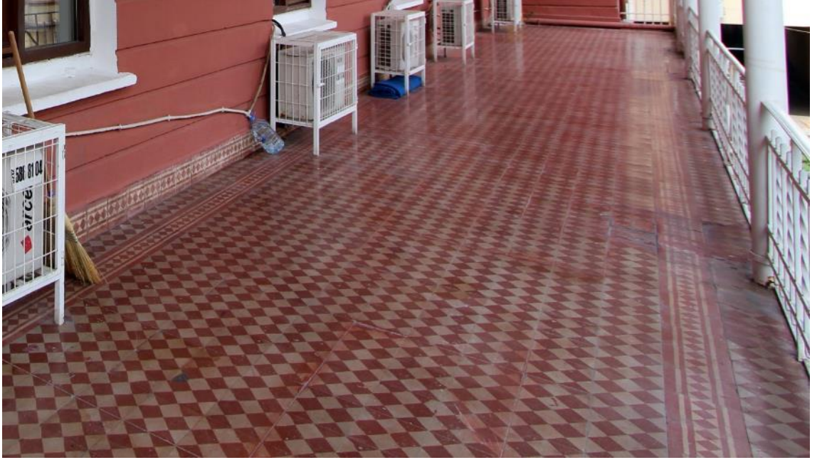
Fotoğraf 690: Cerrahpaşa Hastanesi, Cerrahi Binası Balkonü Karo Süslemeleri
