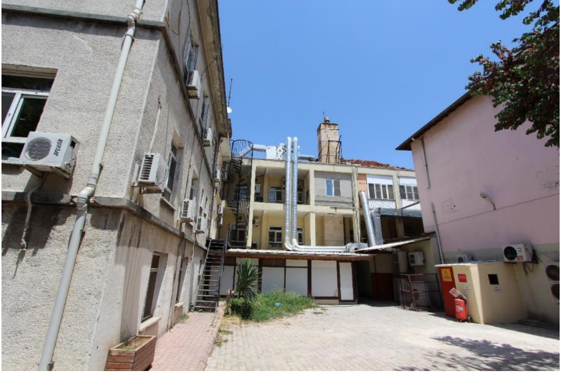
Fotoğraf 204: Antep Amerikan Hastanesi, Ana Bina, Güney Cephesi
