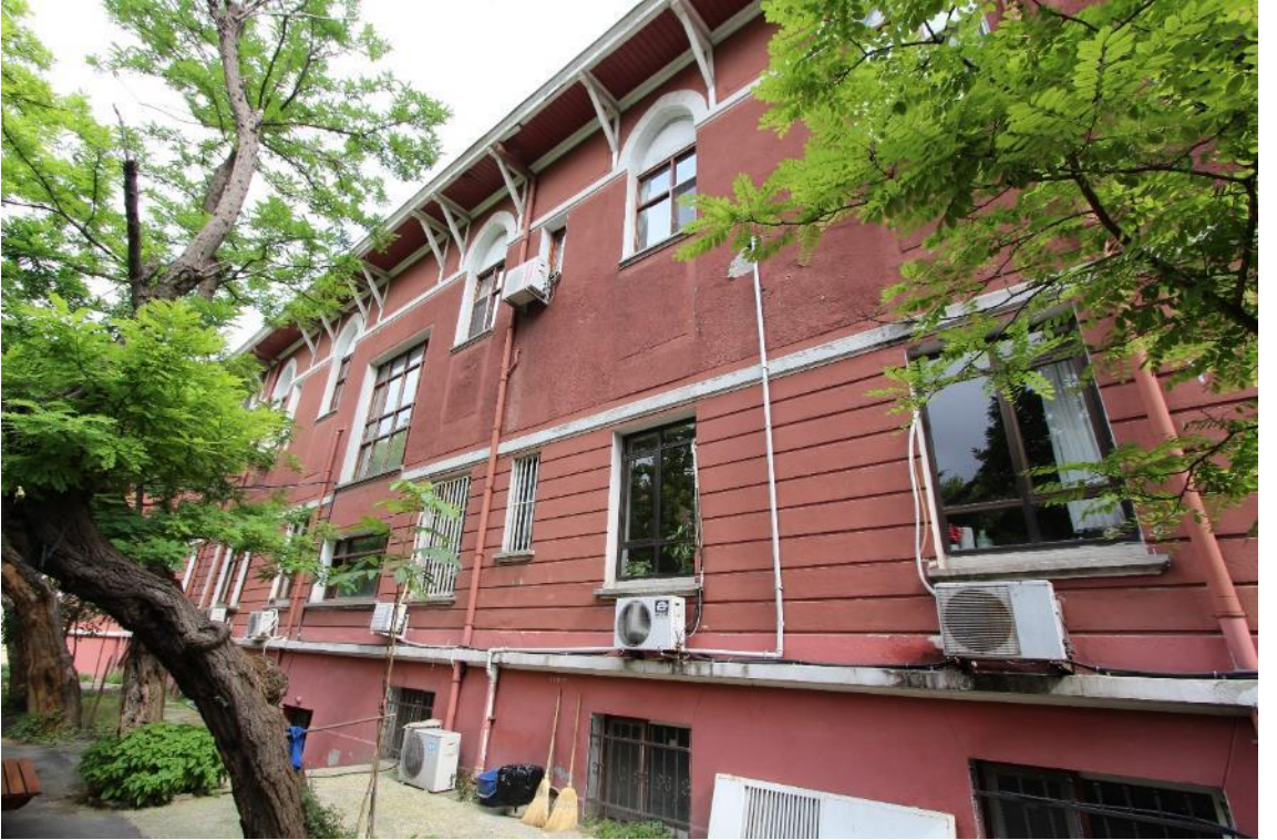
Fotoğraf 682: Cerrahpaşa Hastanesi, Cerrahi Binası, Kuzey Cephesi
