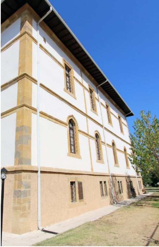
Fotoğraf 729: Çorum Emrâz-ı Umumiye Hastanesi, Doğu Cephesi
