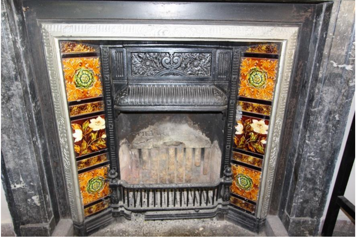
Fotoğraf 449: İzmir İngiliz Hastanesi, B Blok, Zemin Kat Koridorunun Batısındaki Odanın Şöminesi
