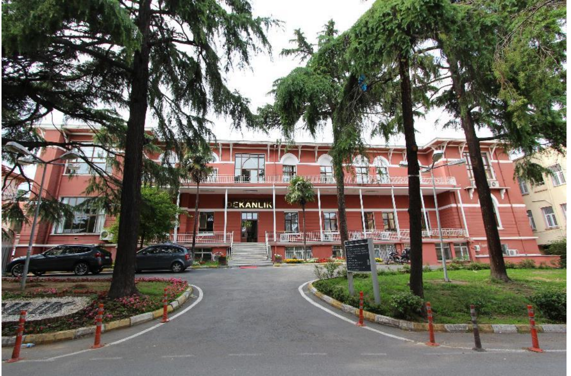
Fotoğraf 680: Cerrahpaşa Hastanesi, Cerrahi Binası, Güney Cephesi
