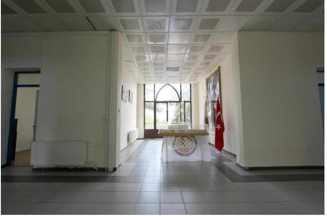
Fotoğraf 675: Cerrahpaşa Hastanesi, Cerrahi Binası, Birinci Kat, Koridora Eyvan Şeklinde Açılan Mekân
