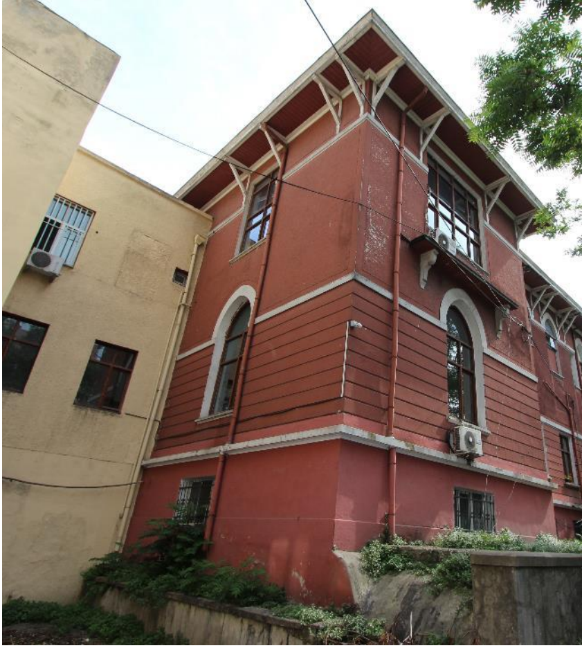
Fotoğraf 683: Cerrahpaşa Hastanesi, Cerrahi Binası, Doğu Cephesi
