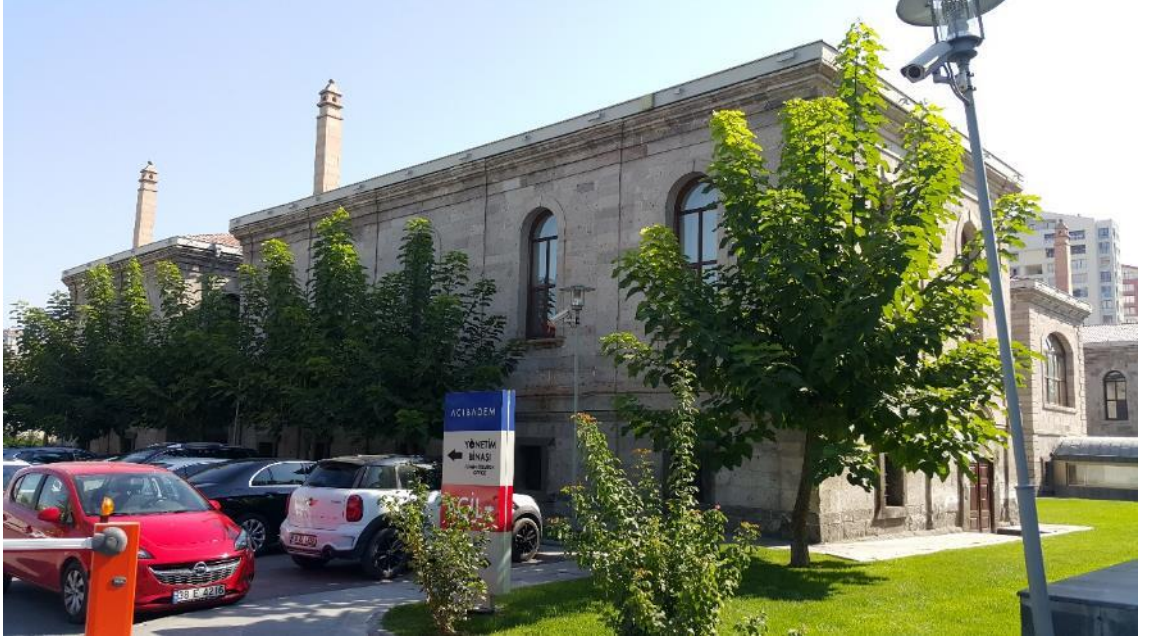
Fotoğraf 196: Kayseri Memleket Hastanesi, Batı Cephesi
