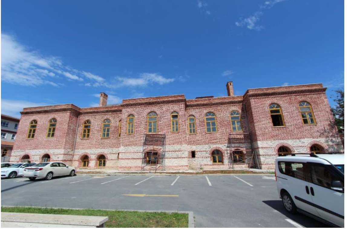
Fotoğraf 394: Zeytinburnu Askeri Hastanesi, Kuzeybatı Cephesi
