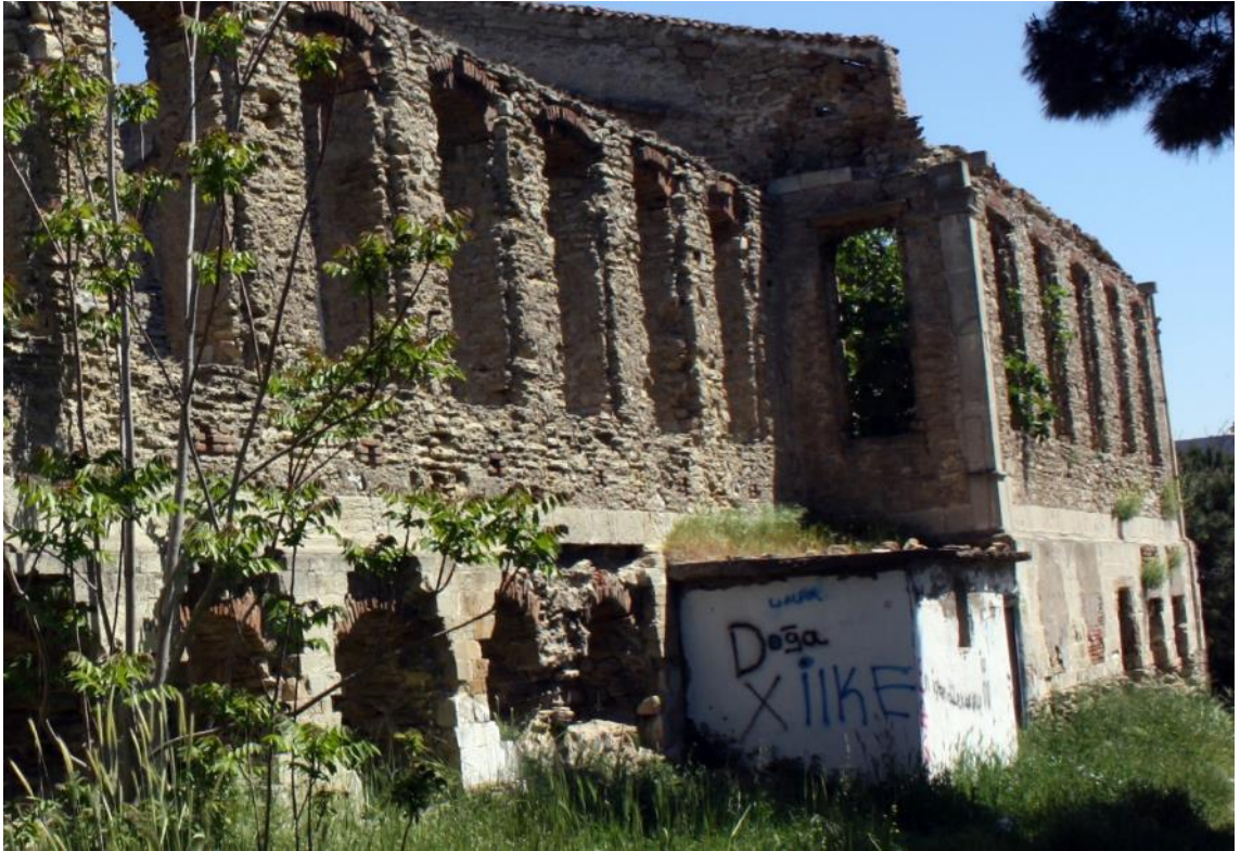
Fotoğraf 335: Çanakkale Merkez Askeri Hastanesi, Güneydoğu Köşesi
