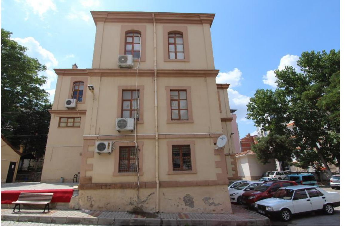
Fotoğraf 285: Balıkesir Gureba Hastanesi, Batı Cephesi
