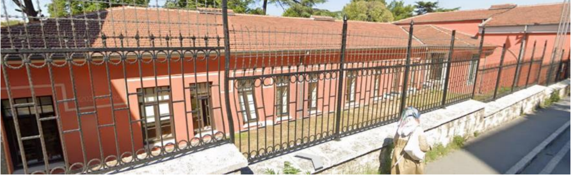
Fotoğraf 46: Bezmialem Vakıf Gureba Hastanesi, Güney Cephesi (Google Earth'den)
