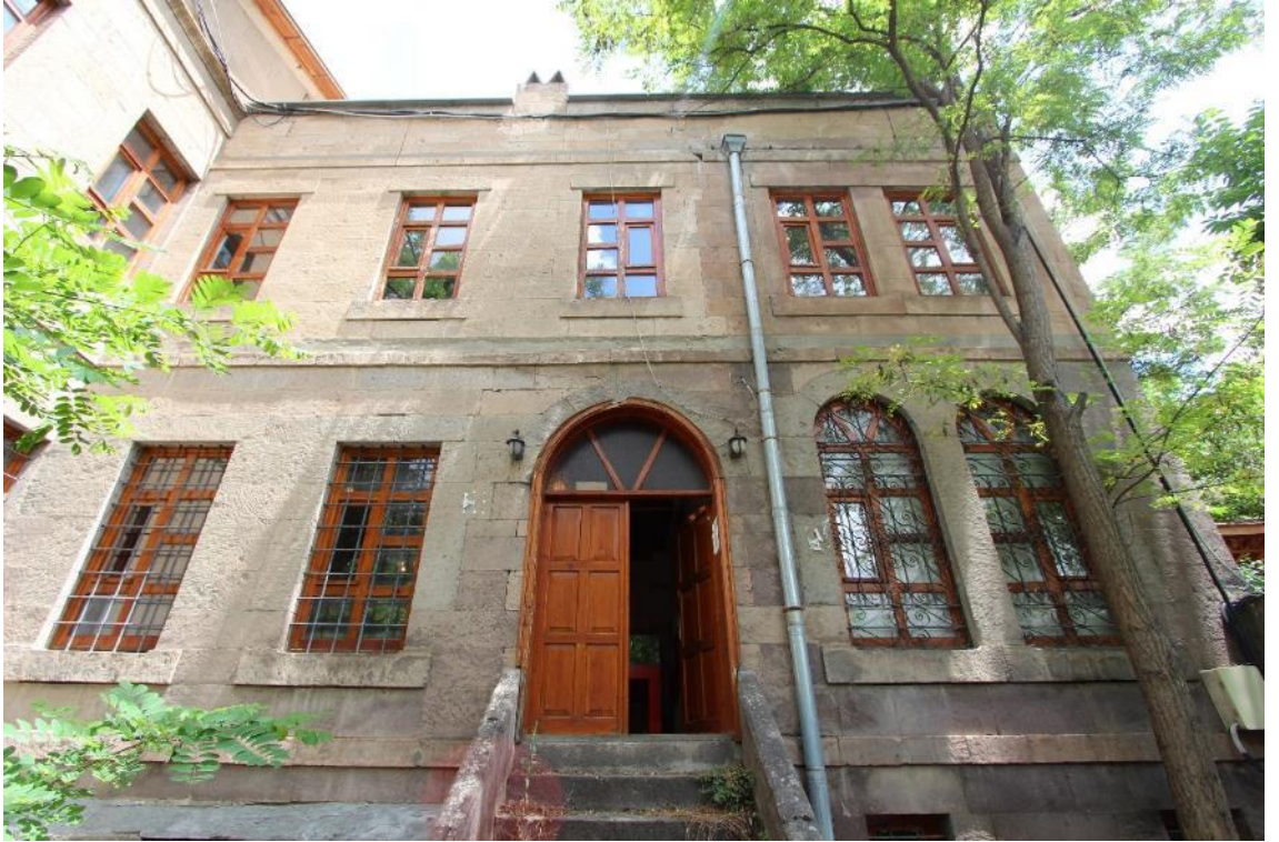
Fotoğraf 534: Kayseri Talas Amerikan Hastanesi, Dispanser Binası, Batı Cephinin İçte Kalan Güney Bölümünün Görünüşü
