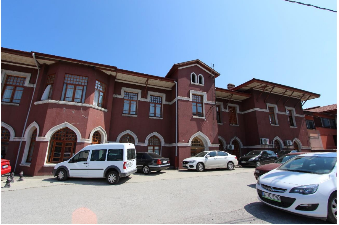
Fotoğraf 773: Zonguldak Amele (Memleket) Hastanesi, Batı Cephesi
