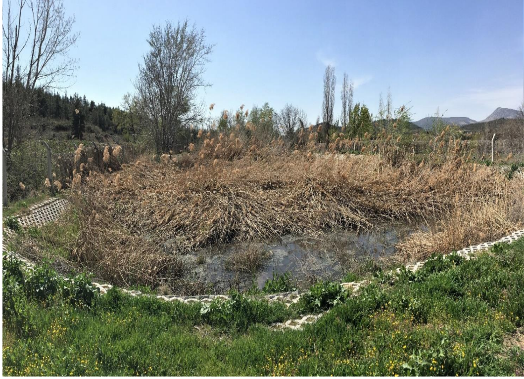
Şekil 4.3: Alikurt Doğal Atıksu Arıtma Tesisi'ne ait genel bir görüntü
