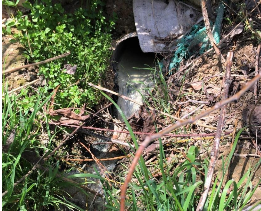
Şekil 4.7: Alikurt Doğal Atıksu Arıtma Tesisi arıtılmış su numunesine ait deşarj noktası
