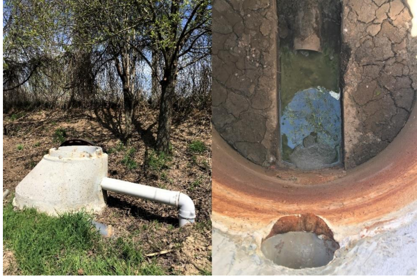
Şekil 4.6: Alikurt Doğal Atıksu Arıtma Tesisi arıtılmış atıksu numunesi toplama istasyonu
