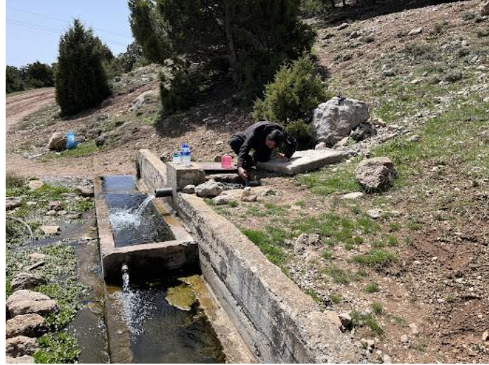
Şekil 4.7: Çakıroluk kaynağı kaptajı ve çeşmesi.
