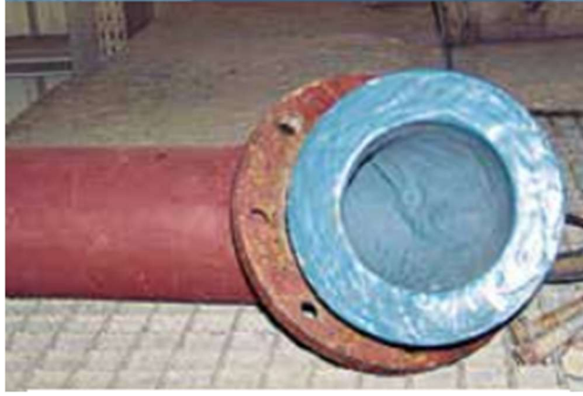
Şekil 2.6: Boru dirseklerinde epoksi kaplama uygulaması (Url-3)
