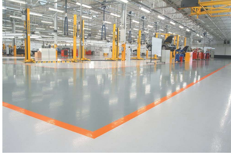
Şekil 2.2: Fabrika zemininde epoksi kaplama uygulaması (Url-1)
