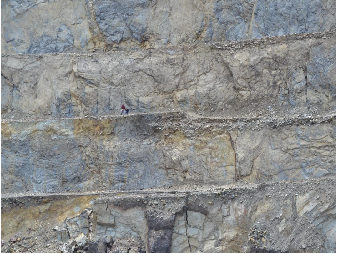
Şekil 3.4: Gri renkli çörtlü kireçtaşlarının sahadaki görünümü
