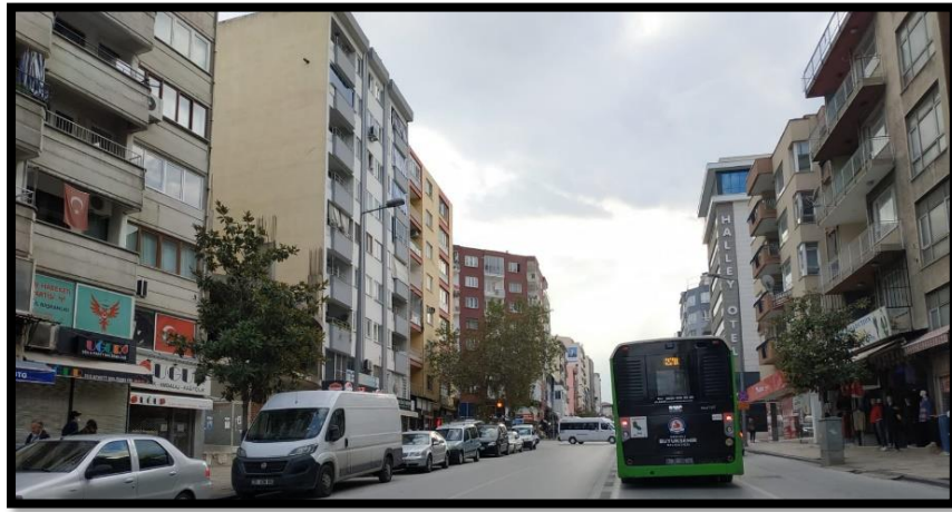
Şekil 3.18: Çıkmların Yapıldığı ve Yapılmadığı Durumlarda Cephelerde Oluşan Görünüm (Çelik 2020 Arşivi)
