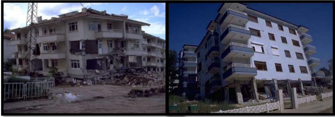
Şekil 3.11: Yumuşak Kat Sorunu İzmit ve Yalova Örnekleri (Halit Coza Arşivi)
