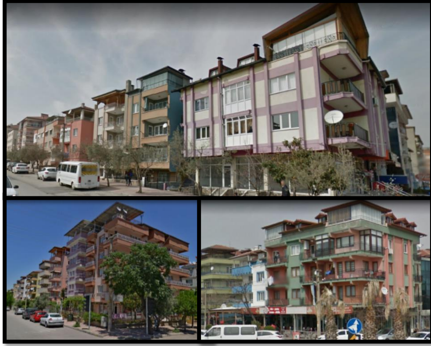
Şekil 3.24: Çatı Kullanımının Oluşturduğu Doku (Çelik 2020 Arşivi)
