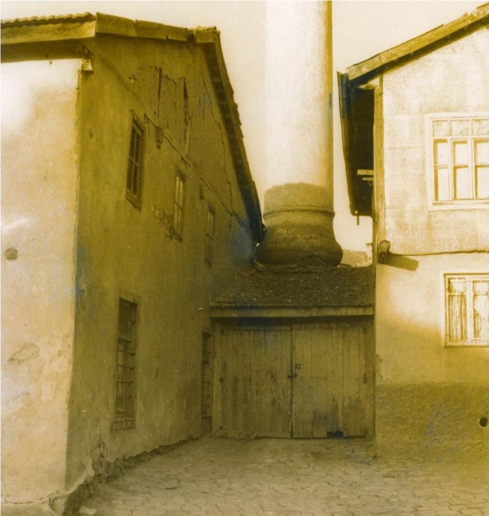
Fotoğraf 66: Hamamönü Camii, 1971 Onarım Öncesi Güney Cephe (V.G.M. Arşivi)
