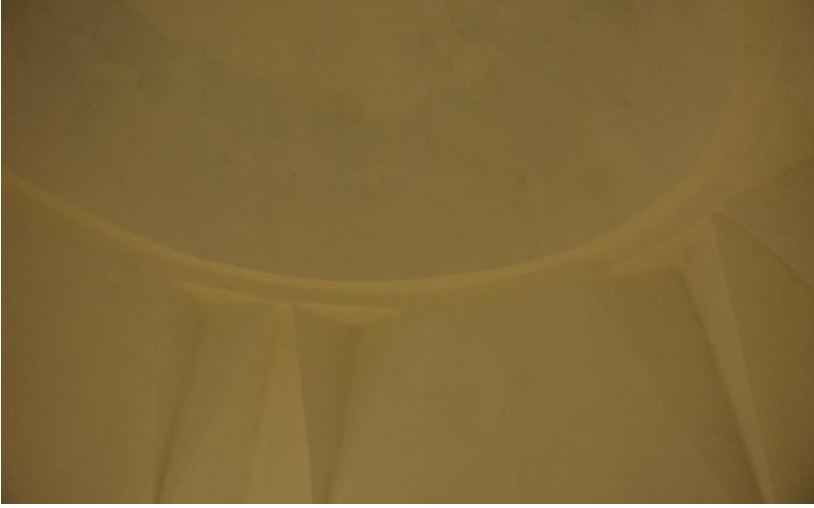
Fotoğraf 256: Küçük (Ece) Hamamı, Sıcaklık Bölümü, Kubbe Detay
