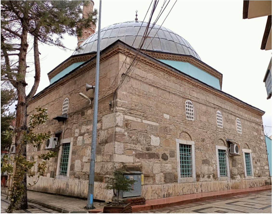
Fotoğraf 4: Ulu Camii, Güney ve Doğu Cephe, Genel Görünüm
