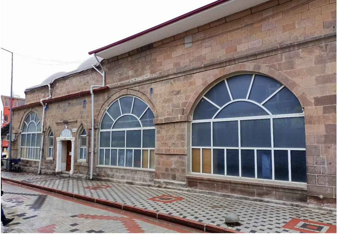
Fotoğraf 199: Yeni (Keçe Müslehaddin) Camii Doğu Cephe
