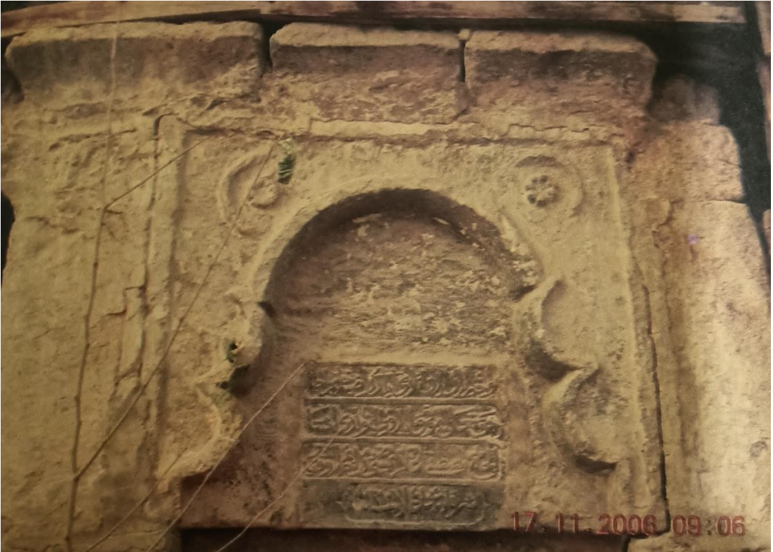
Fotoğraf 310: Raziye Hanım Çeşmesi, Ön Cephe Görünümü (G. Aydoğdu'dan)
