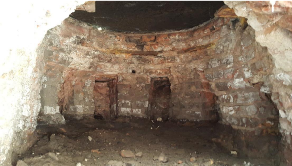
Fotoğraf 252: Küçük (Ece) Hamamı, Su Deposu Kazanı
