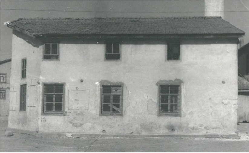
Fotoğraf 61: Hamamönü Camii, 1971 Onarım Öncesi Batı Cephe (V.G.M. Arşivi)
