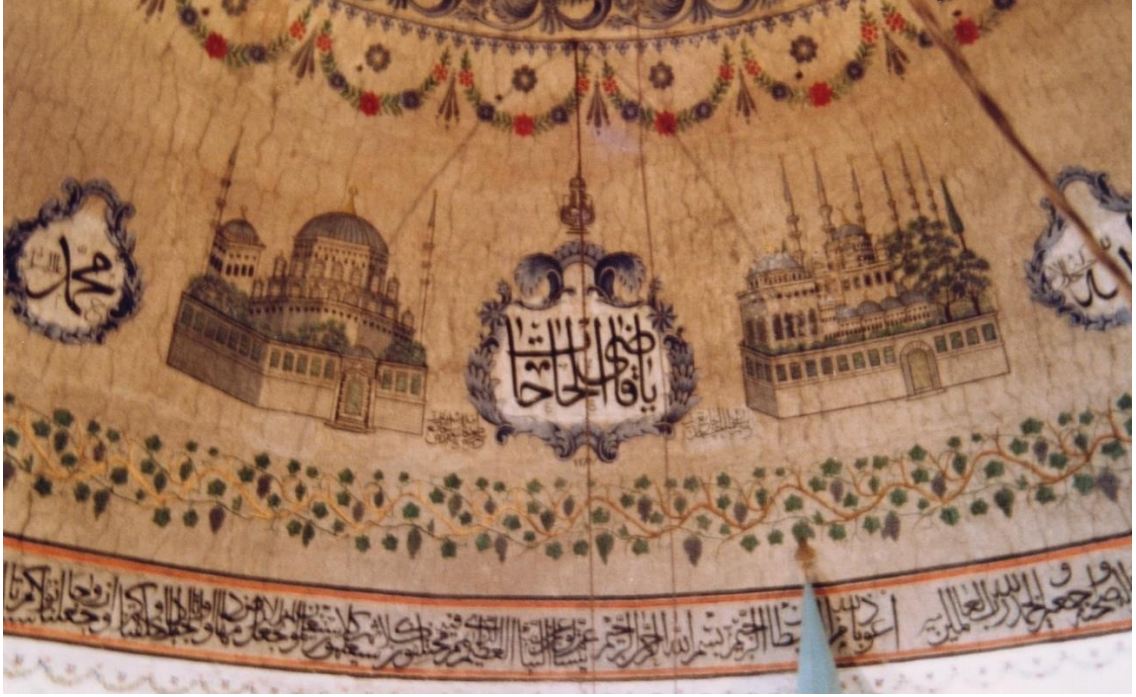
Fotoğraf 55: Ulu Camii, Restorasyon Öncesi Kubbe Yüzeyi, Mimari Tasvirleri (V.G.M Arşivi)
