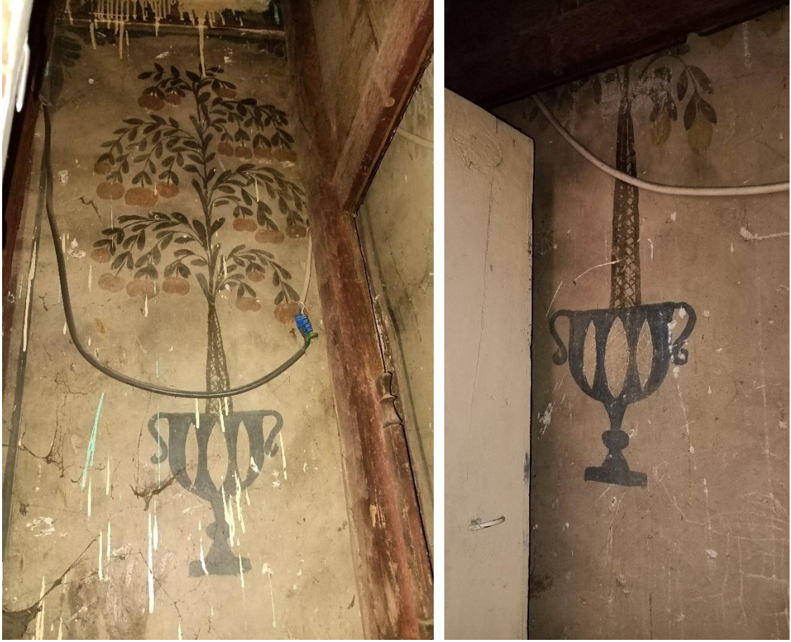
Fotoğraf 143: Çolak Mescid Camii, Minber, Güney ve Doğu Duvar Yüzü Süsleme
