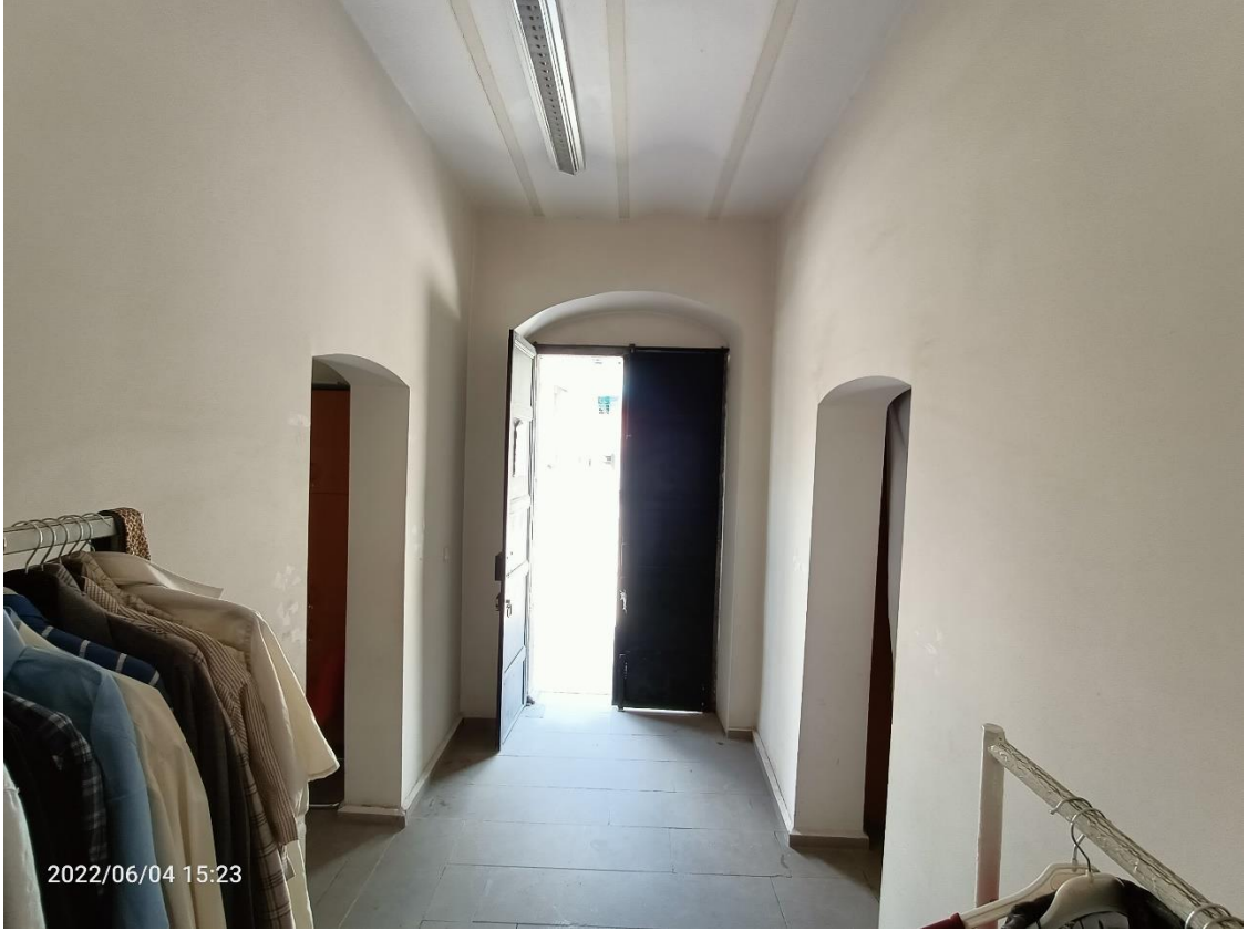
Fotoğraf 325: Sandıklı Ziraat Bankası Eski Binası, T Formlu Koridor
