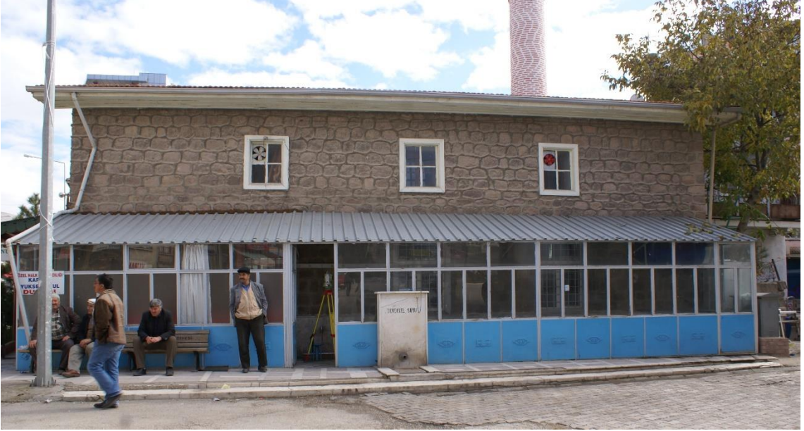
Fotoğraf 65: Hamamönü Camii, Batı Cephe
