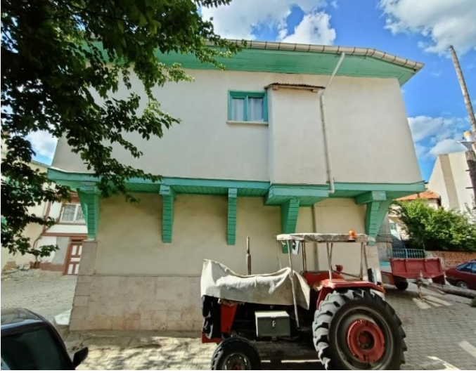
Fotoğraf 106: Yeşildirek Camii, Güney Cephe Görüşü
