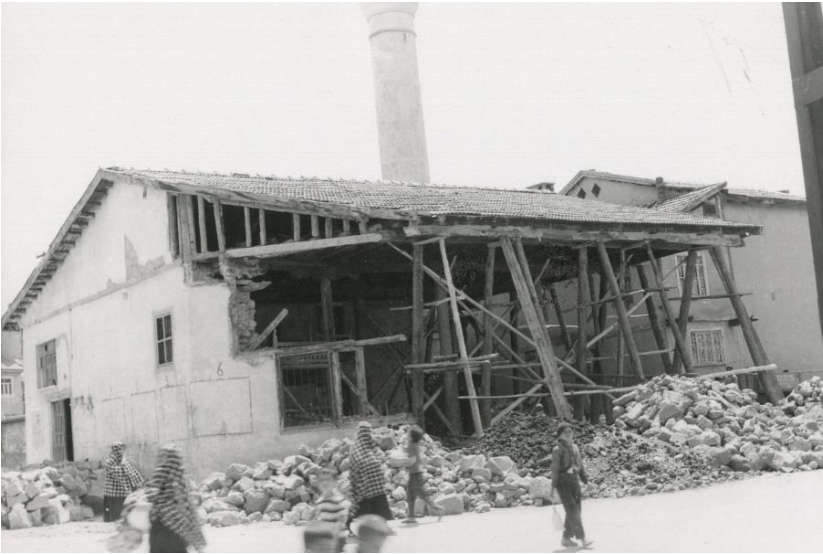
Fotoğraf 62: Hamamönü Camii, Onarım Esnası Güney ve Batı Cephe (V.G.M. Arşivi)
