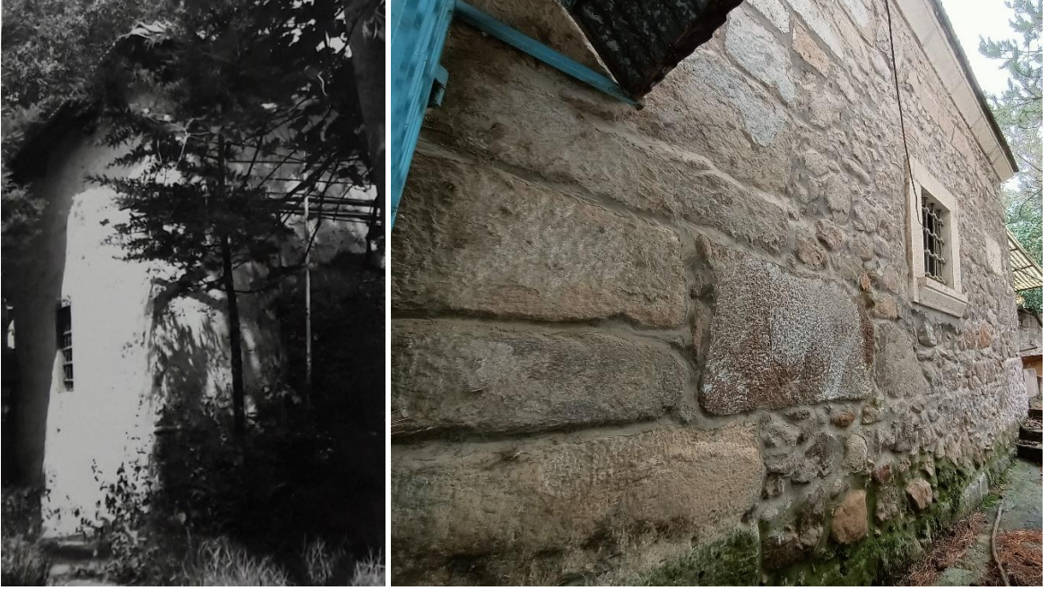
Fotoğraf 224: Muradin Türbesi, Batı Cephe, 1986 Onarım Öncesi ve Sonrası
