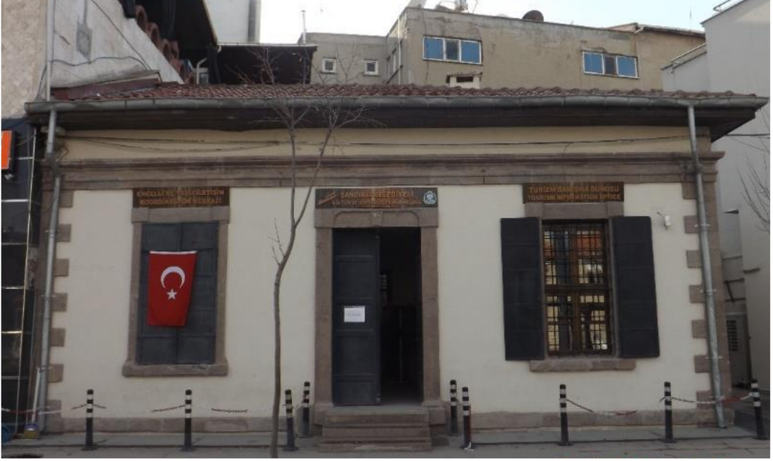
Fotoğraf 323: Sandıklı Ziraat Bankası Eski Binası, Doğu Cephe Genel Görünüm
