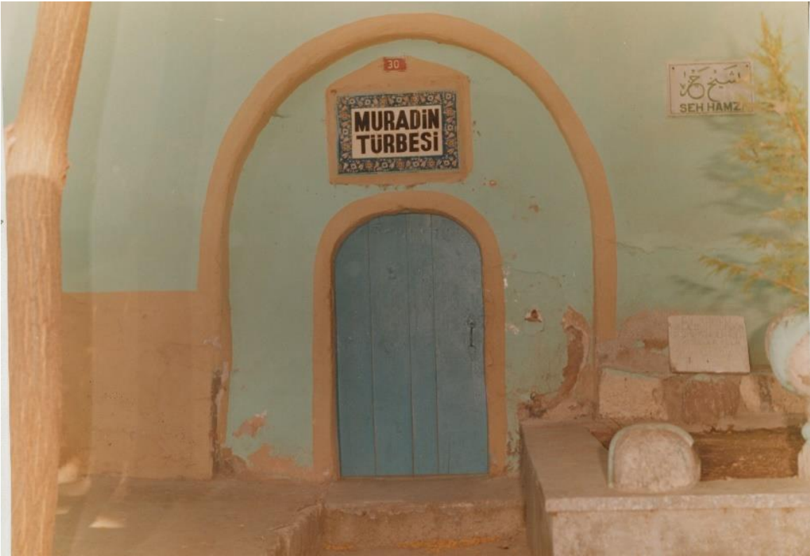
Fotoğraf 221: Muradin Türbesi 1986 Yılı Onarım Öncesi Kuzey Cephe (V.G.M Arşivi)
