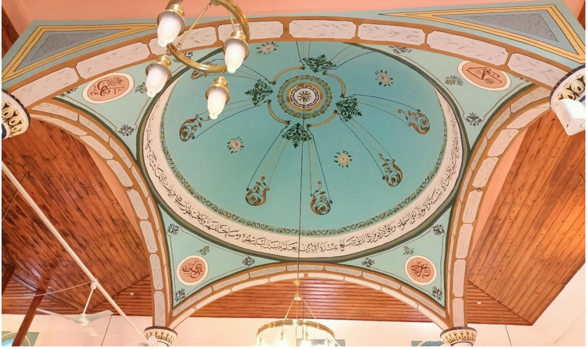
Fotoğraf 189: Havai Camii, Kubbe Detayı
