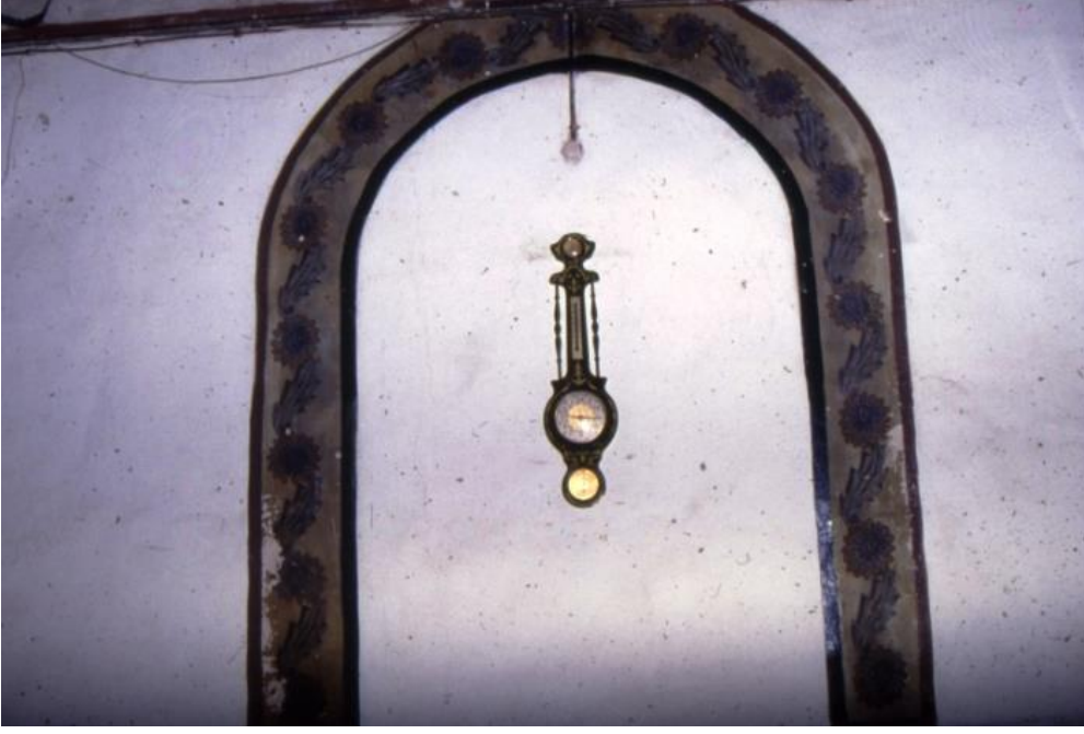
Fotoğraf 29: Ulu Camii, 1992 Onarım Öncesi Batı Duvarı, Sahte Pencere Detayı (V.G.M Arşivi)
