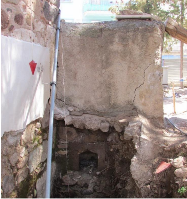
Fotoğraf 266: Havai Camii Çeşmesi, Arka Cephe Görünümü, Restorasyon Sırası (V.G.M Arşivi)
