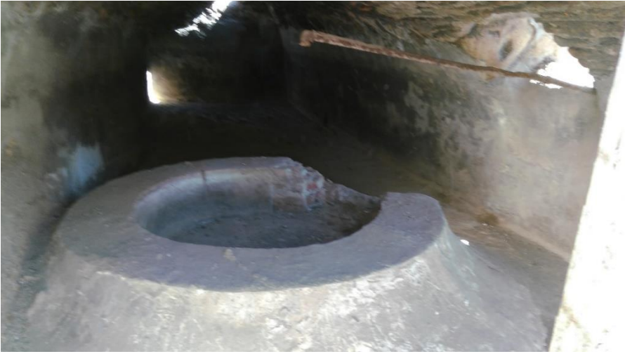
Fotoğraf 251: Küçük (Ece) Hamamı, Su Deposu Kazanı
