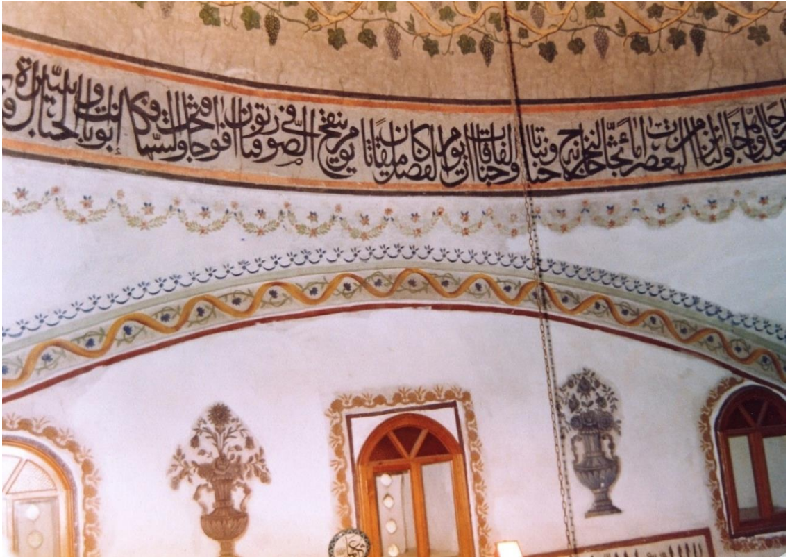
Fotoğraf 32: Ulu Camii, Harim, Doğu Duvarı Onarım Öncesi (V.G.M Arşivi)
