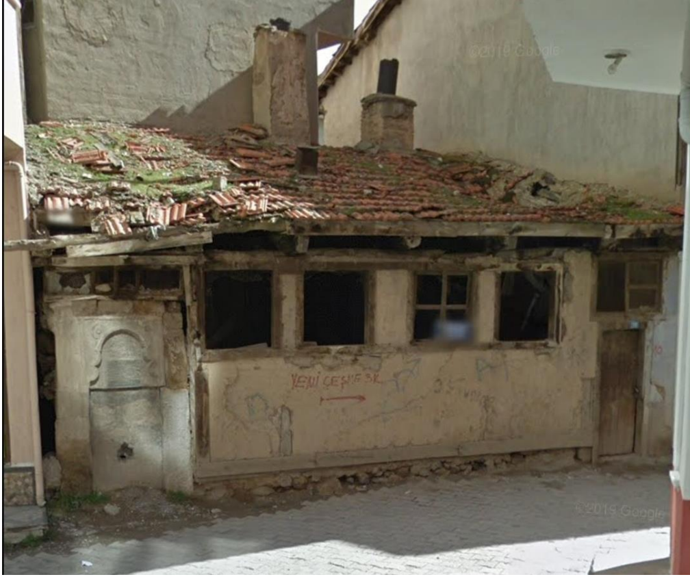
Fotoğraf 311: Raziye Hanım Çeşmesi, Ön Cephe Görünümü (G. Aydoğdu'dan)
