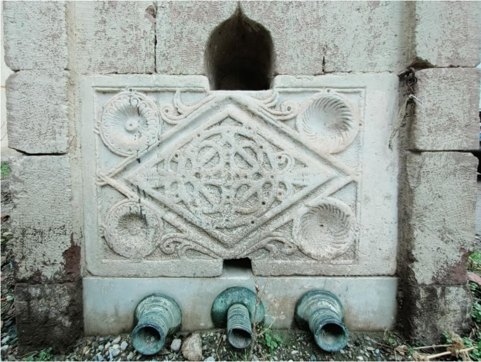
Fotoğraf 262: Hacı Osman Ağa (Trafo Önü) Çeşmesi, Devşirme Malzeme Detay
