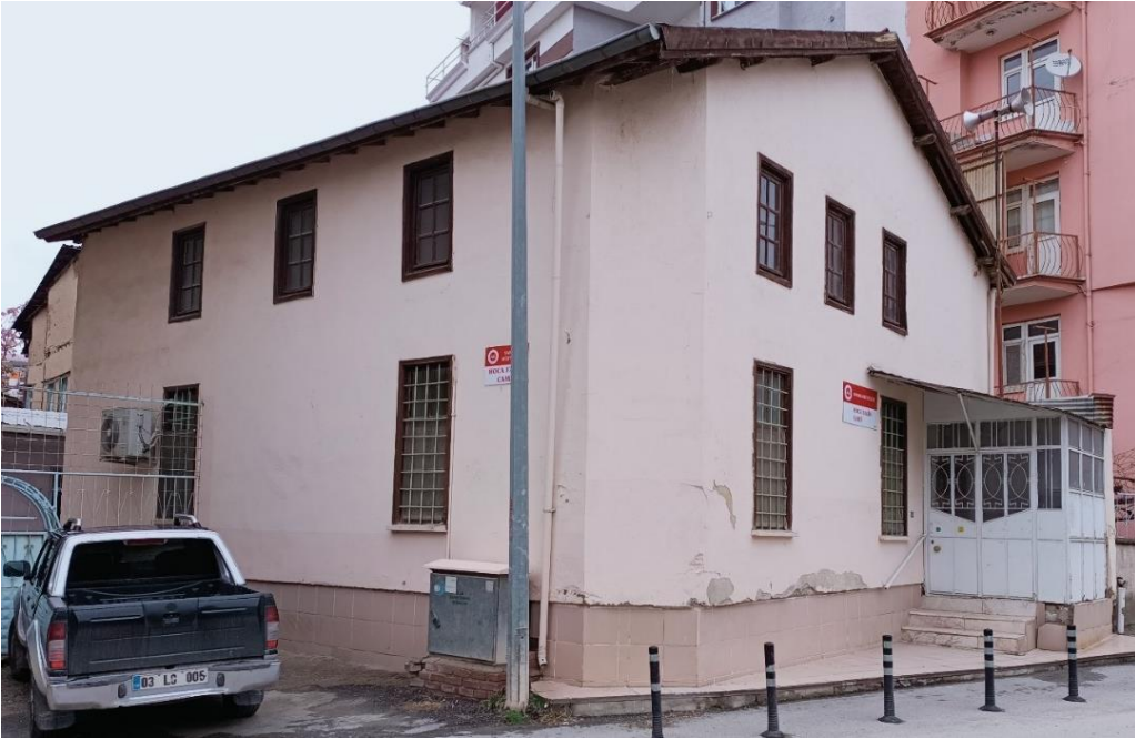
Fotoğraf 115: Hoca Fakih Camii, Güney ve Doğu Cephe Genel Görünüm
