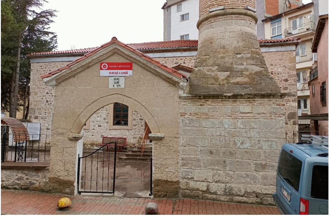
Fotoğraf 161: Havai Camii, Avlu Kapı Açıklığı
