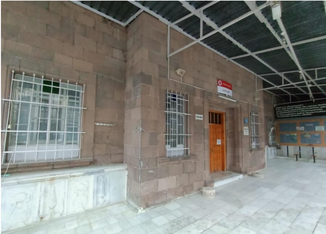
Fotoğraf 202: Yeni (Müslehaddin) Camii, Son Cemaat Yeri, Kuzey Cephe Kapı Açıklığı
