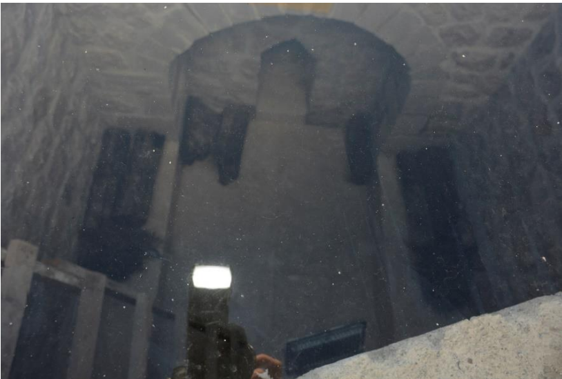
Fotoğraf 258: Küçük (Ece) Hamamı, Ateşlik Bölümü Kapı Açıklığı
