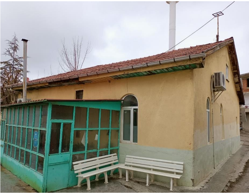
Fotoğraf 126: Yunusemre Eski Camii, Güney Cephe, Genel Görünüm
