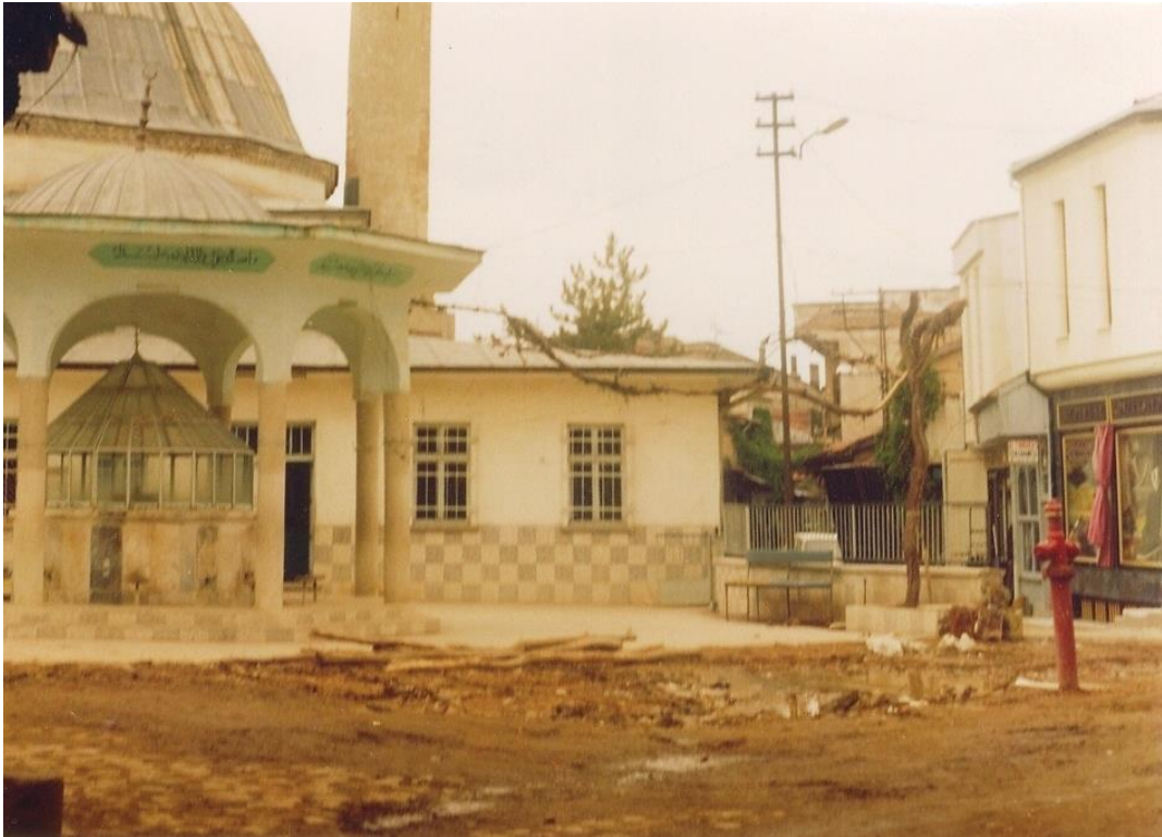
Fotoğraf 16: Ulu Camii, Yıkılan Müftülük Binası Arsası ve Şadırvan Görünüşü (E.K.T.V.K.B.K. Arşivi)
