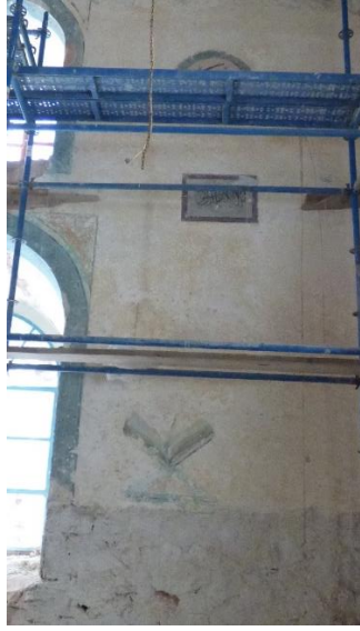
Fotoğraf 180: Havai Camii, 2014 Yılı Raspa sırası ve Sonrası Güney Duvarı Detay
