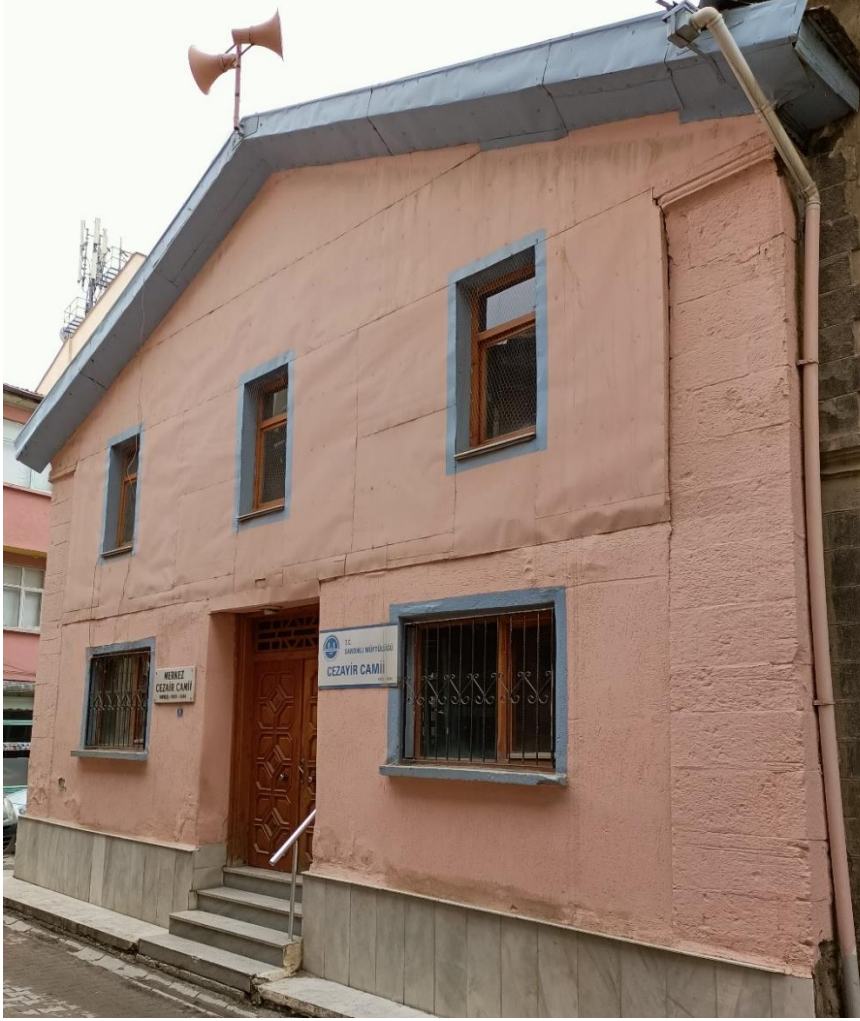
Fotoğraf 147: Cezayir Camii, Kuzey Cephesi, Genel Görünüm
