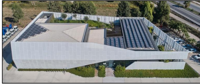
Şekil 6.20: FNN Sürdürülebilirlik Merkezi Çatıya Entegre Edilmiş PV Paneller (32. URL)
