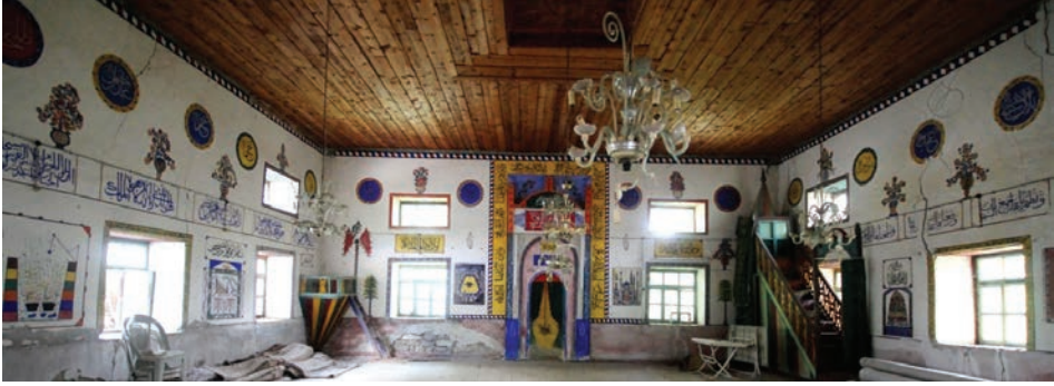
Görsel 11: Harim Mekânı Genel Görünüşü 2
