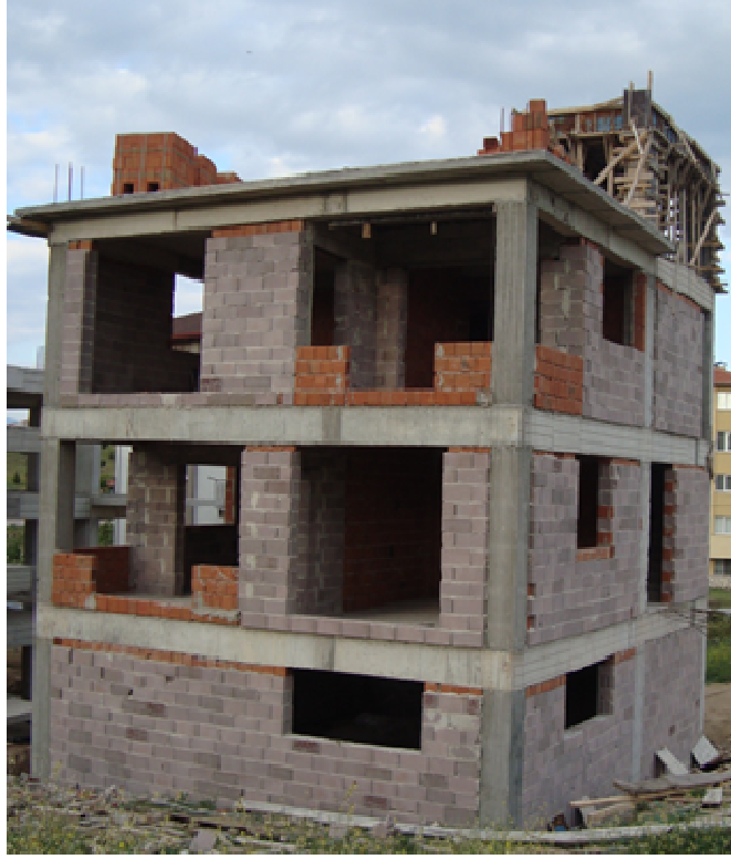
Şekil 4.1: Mikrotremör ölçümü yapılan bina (S1-12 Nolu Bina)
