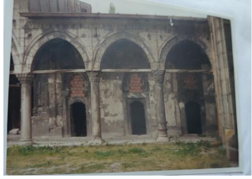
Şekil 1. Sivas Gök Medresede Öğrenci Odalarının Önündeki Revaklar
