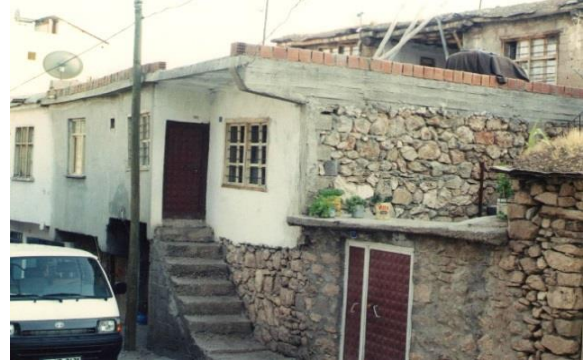
Şekil 3: Hanın genel görünüşü ve kuzey duvarı
