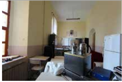
Foto. 12. Yozgat Lisesi Z-11 Numaralı Derslik (2017)
