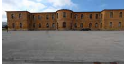
Foto. 40. Yozgat Lisesi Kuzey Cephe (2017)
