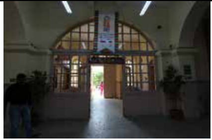
Foto. 8. Yozgat Lisesi Giriş Holü (2017)
