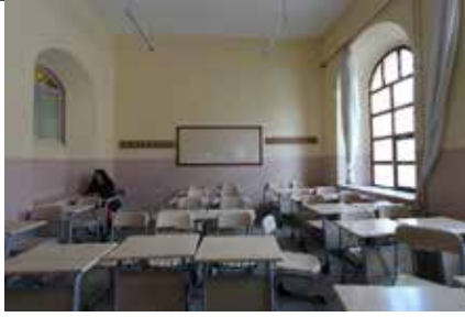
Foto. 19. Yozgat Lisesi Z-06 Numaralı Derslik (2017)
