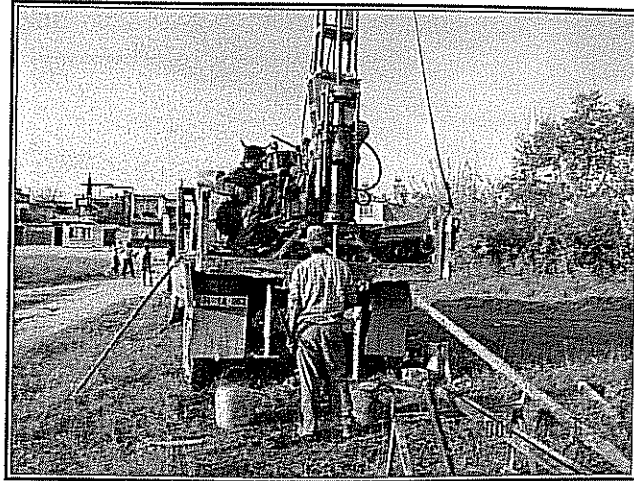
Şekil 4.125. SK 1 (Sinanpaşa Mah.) no'lu sondaj çalışmasından görünüm.
