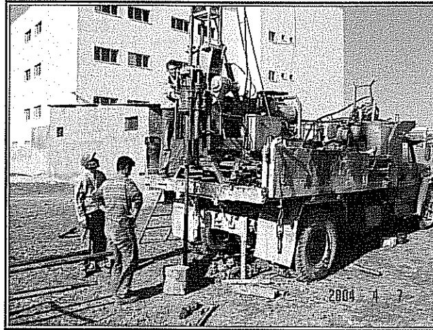
Şekil 4.126. SK 2 (Başak Mah.) no’lu sondaj çalışmasından görünüm.
