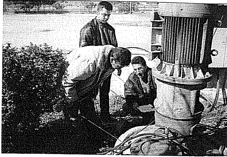
Şekil 4.165. Yüreğir Belediyesi veri noktasında yeraltı su seviye ölçer ile kuyu başında seviye ölçüm işlemi.
