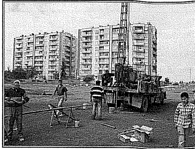
Şekil 4.149. SK 15 (Pınar Mah.) no’lu sondaj çalışmasından görünüm.
