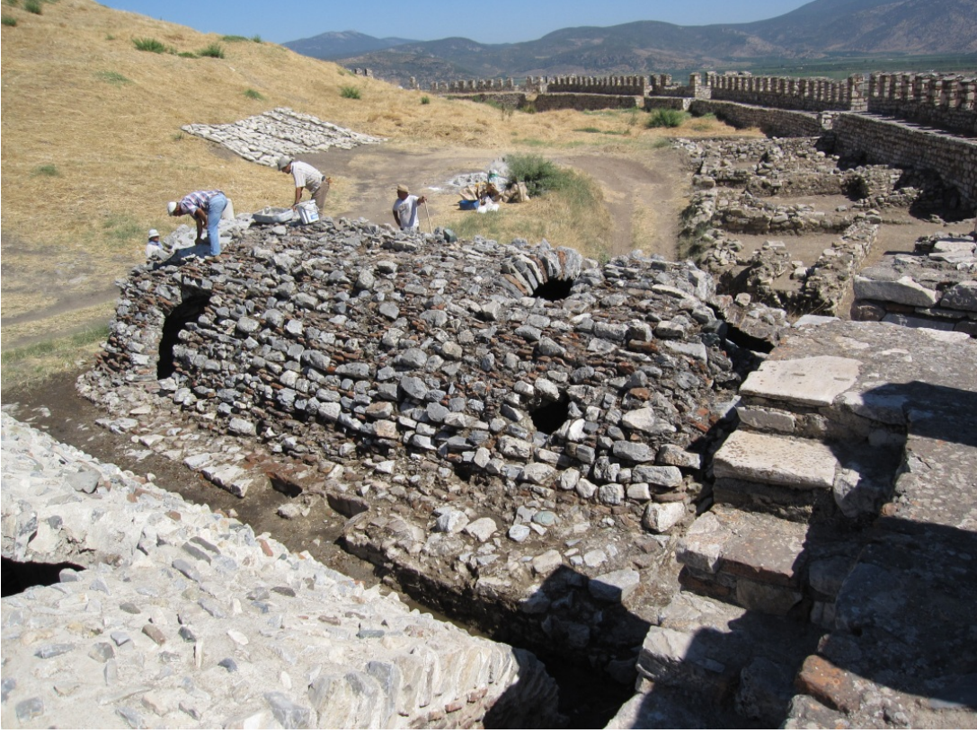
Resim 191: Doğu Sarnıçlarından DS2 tonozu konservasyon çalışmaları sırasında.
