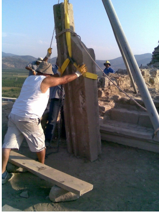
Resim 163: Kale Köşkü Güney Kapısı batı sövesi onarım sırasında.
