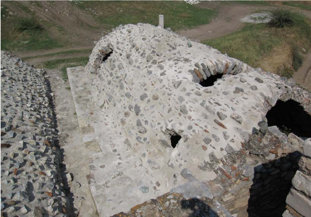
Resim 192: Doğu Sarnıçlarından DS2 tonozu konservasyon çalışmaları sonunda.
