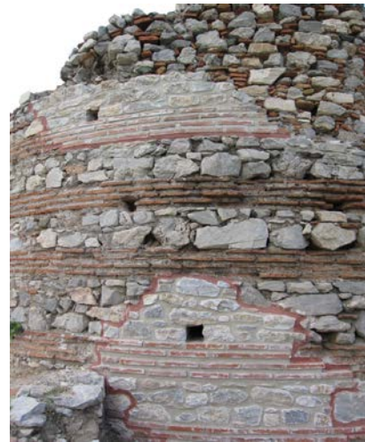
Resim 193: Bazilika-Sarnıç apsis dışındaki bozulmalar onarım öncesi ve sonrası.
