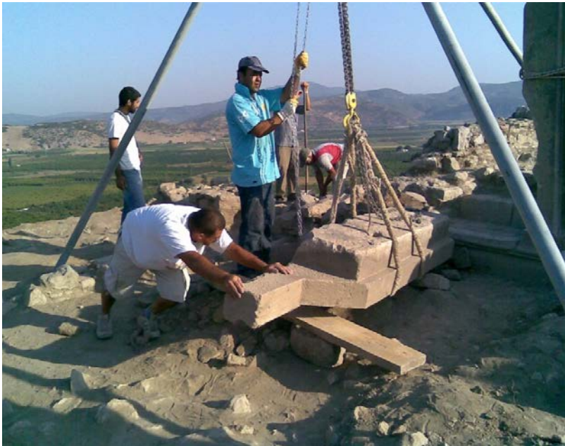
Resim 162: Kale Köşkü Güney Kapısının batı sövesi onarım sırasında.
