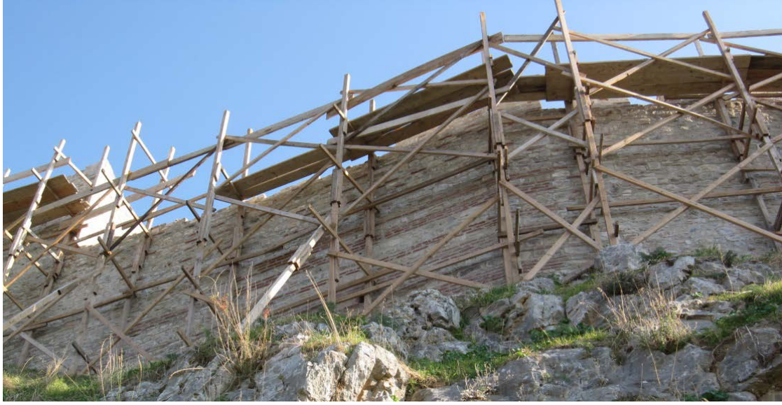
Resim 118: BK 3 – BK 4 arasındaki sur duvarları onarım sırasında.
