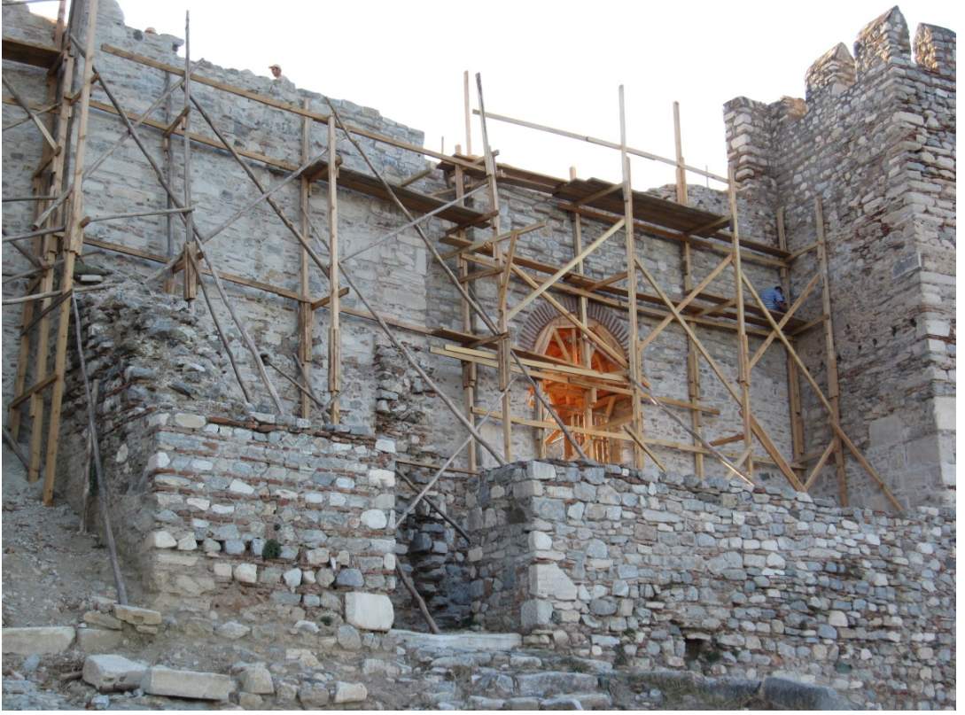
Resim 82: İç Kale Batı Sur Duvarları Batı Girişi çevresi restorasyon sırasında.
