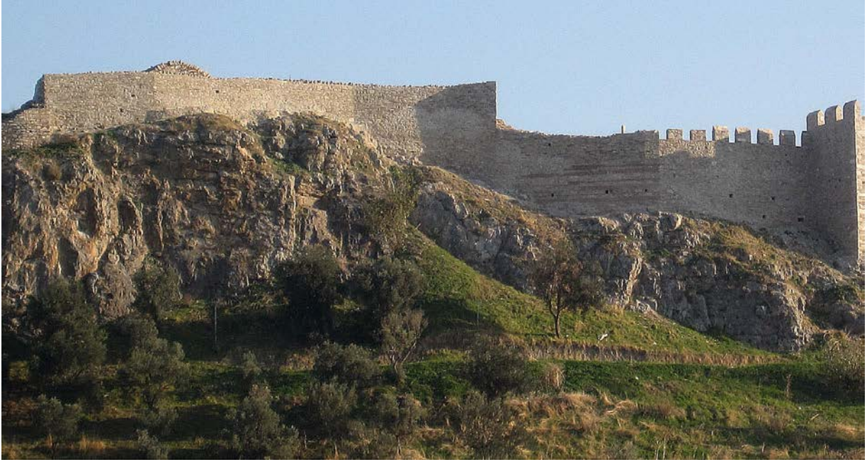
Resim 137: BK 3 – BK 5 kuleleri arasındaki beden duvarı ve BK4 Kulesi onarımdan sonra.
