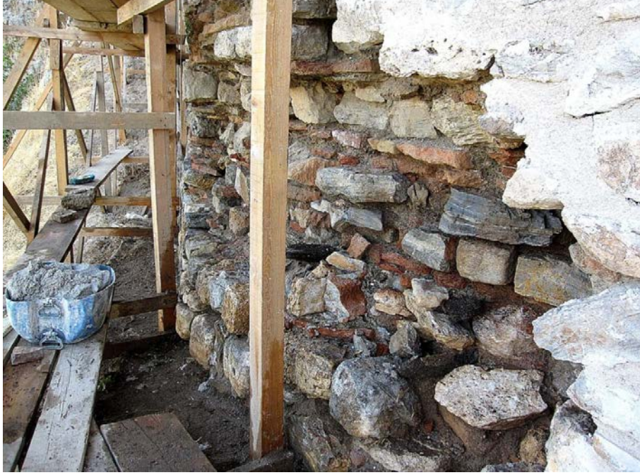
Resim 138: BK 4 – BK 5 kuleleri arasındaki beden duvarından bir bölüm temizlik sırasında.
