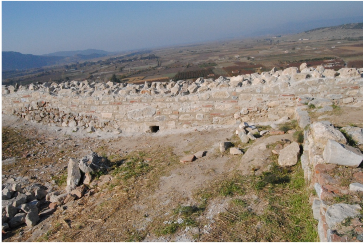
Resim 143: BK 4 – BK 5 arasındaki sur duvarları (Kuzey bölüm) iç yüzü onarımdan sonra.
