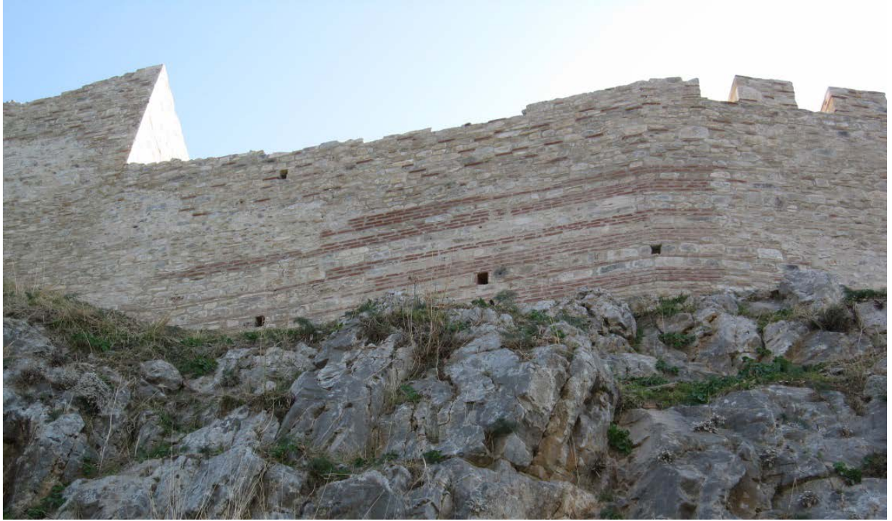
Resim 119: BK 3 ve BK 4 arasındaki sur duvarları onarımdan sonra.
