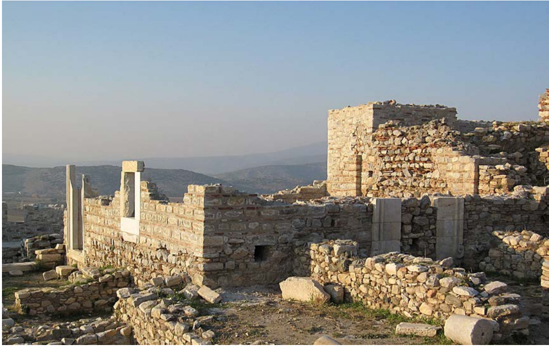
Resim 177: Kale Köşkü güney-doğu köşe duvarı onarımdan sonra.
