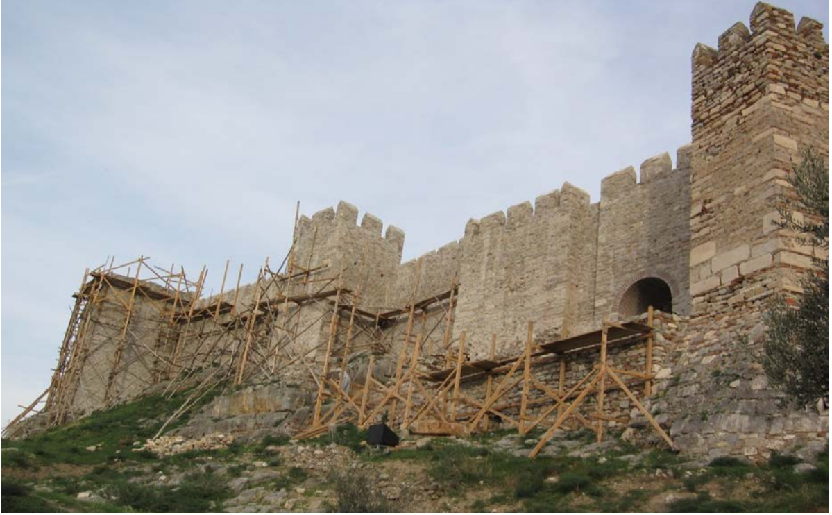
Resim 106: İç Kale Batı Sur Duvarları 1-3 Kule arası restorasyonun son aşamalarında.
