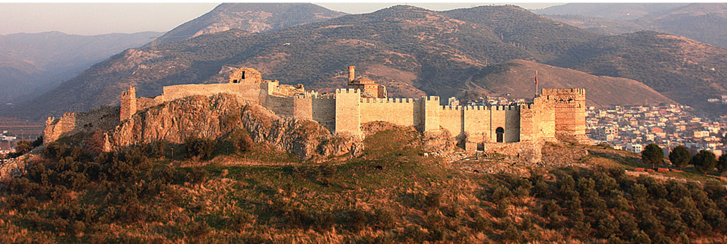
Ayasuluk İç Kale, Batı Sur Duvarları, 2011 sonu.
