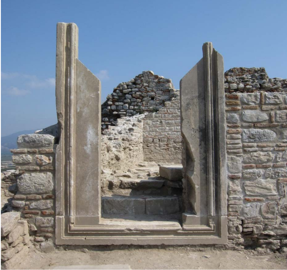
Resim 14: Kale Köşkü Güney Kapısı onarım sonrası.
