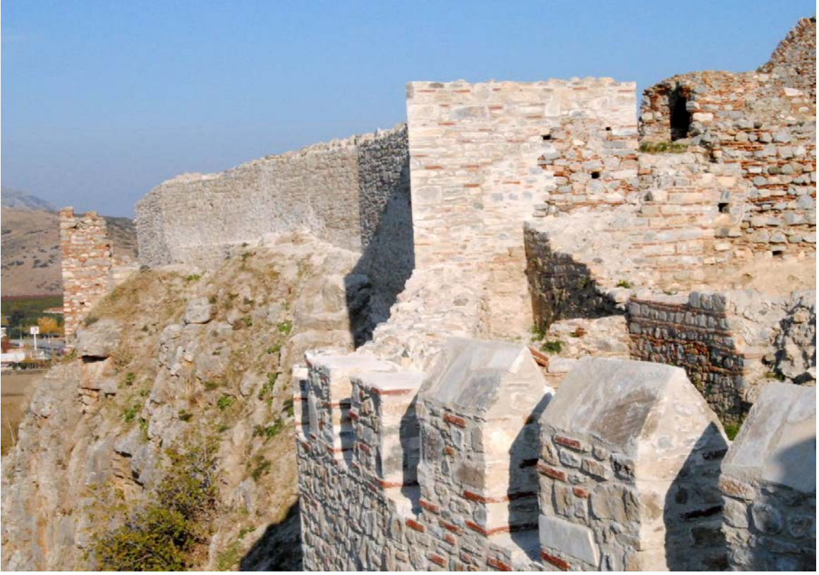
Resim 148: BK 3 – BK 5 kuleleri ile arasındaki sur duvarları onarımdan sonra.
