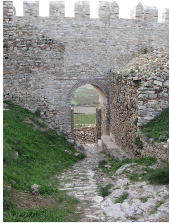
Resim 87: Batı Sur Girişi üzerindeki kemerin ve duvarın onarım sonrası görünümü.
