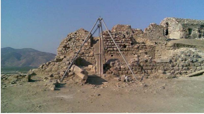
Resim 161: Kale Köşkü güney kapısının onarım çalışmaları sırasında.
