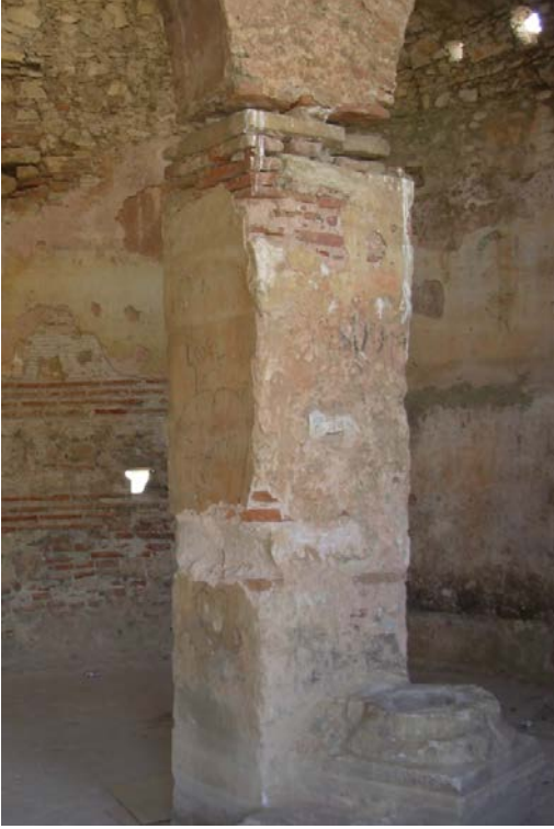
Resim 194: Bazilika-Sarnıç tonoz taşıyıcı ayak onarım öncesi ve sonrası.
