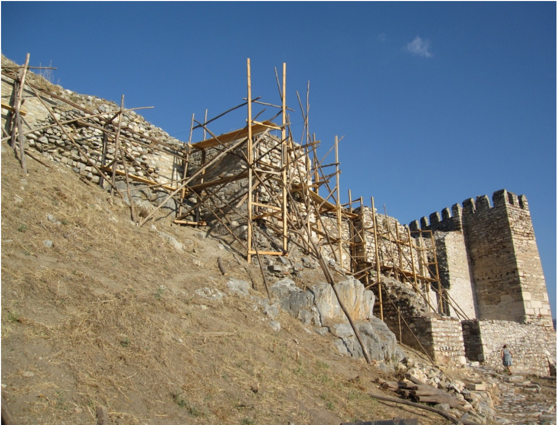
Resim 77: İç Kale Batı Sur Duvarlarının restorasyon başında görünümü.
