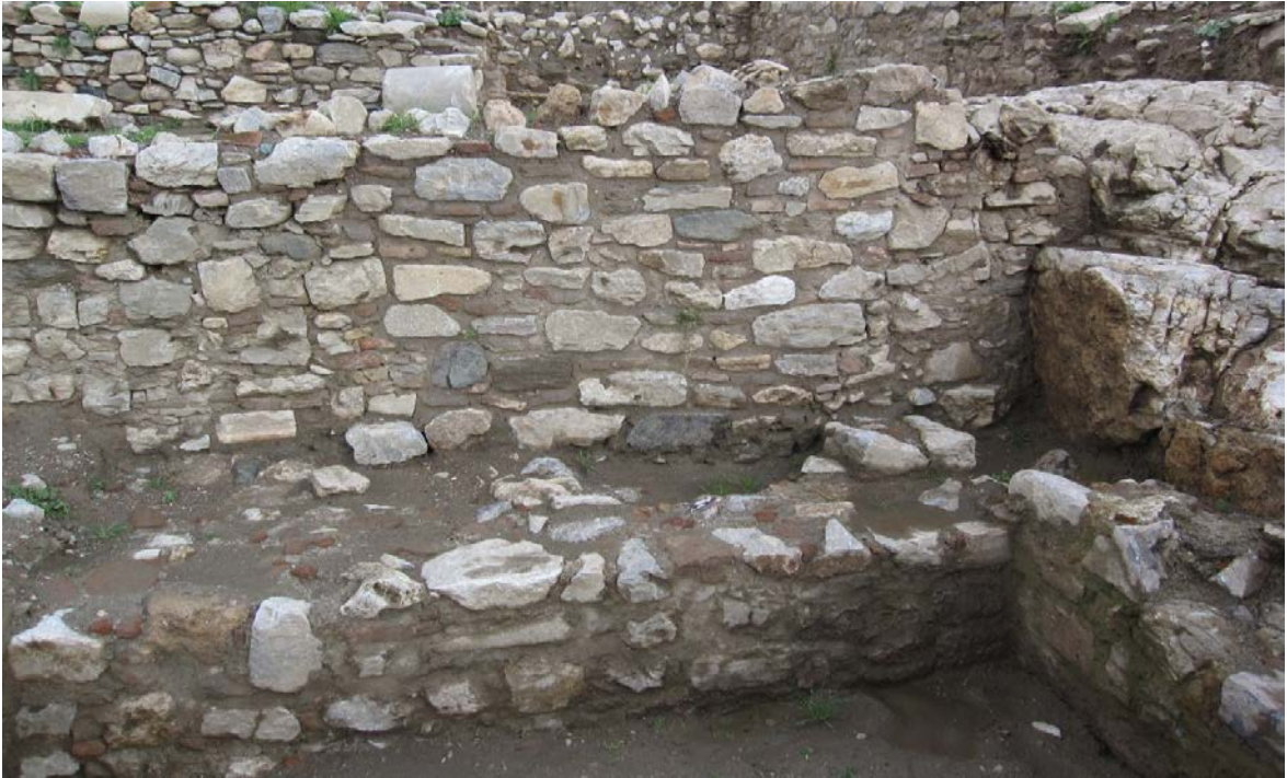
Resim 196: Kale Köşkü güney doğusundaki konut duvarında çamur harçlı onarım.
