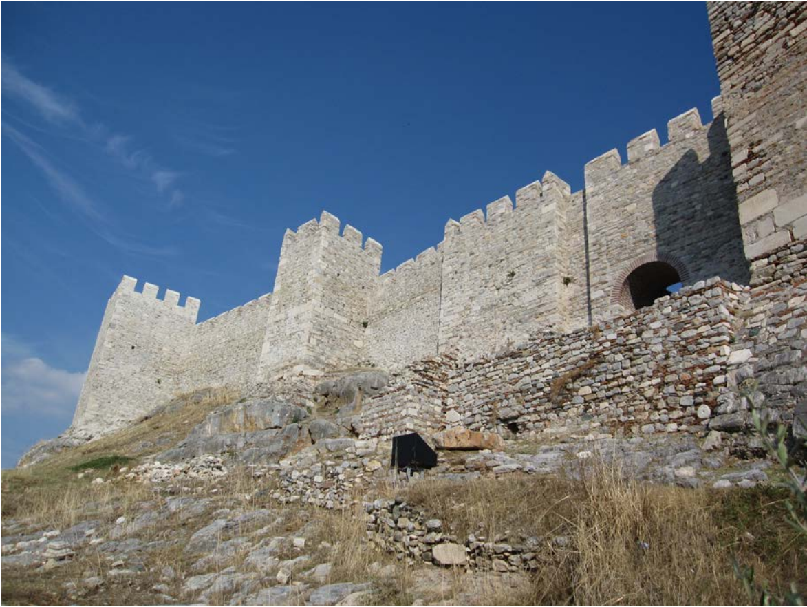
Resim 107: İç Kale Batı Sur duvarları ve kuleler restorasyon sonrasında (2010 sonu).
