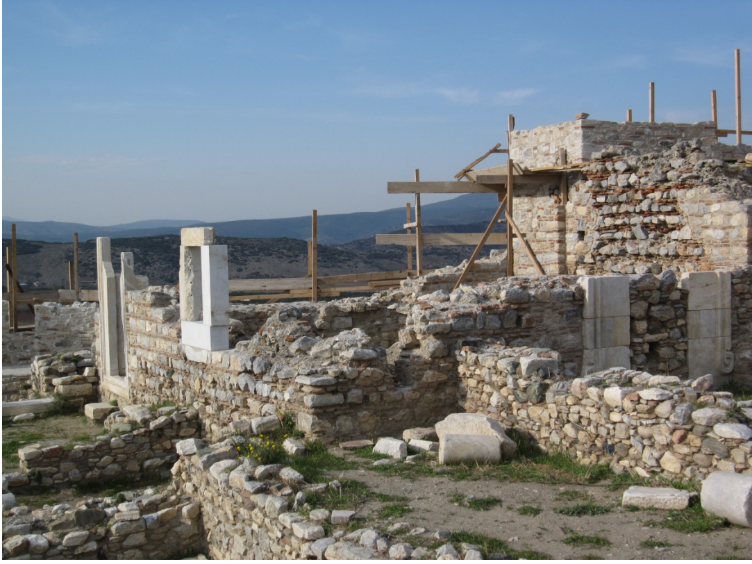
Resim 176: Kale Köşkü güney -doğu köşe duvarı onarımdan önce.
