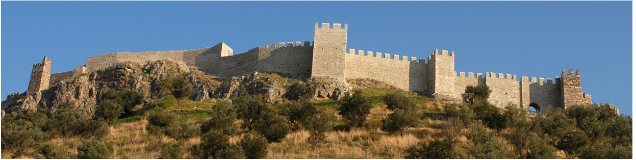
Resim 152: İç Kale batı sur duvarları, 2011 onarımı sonrası.
