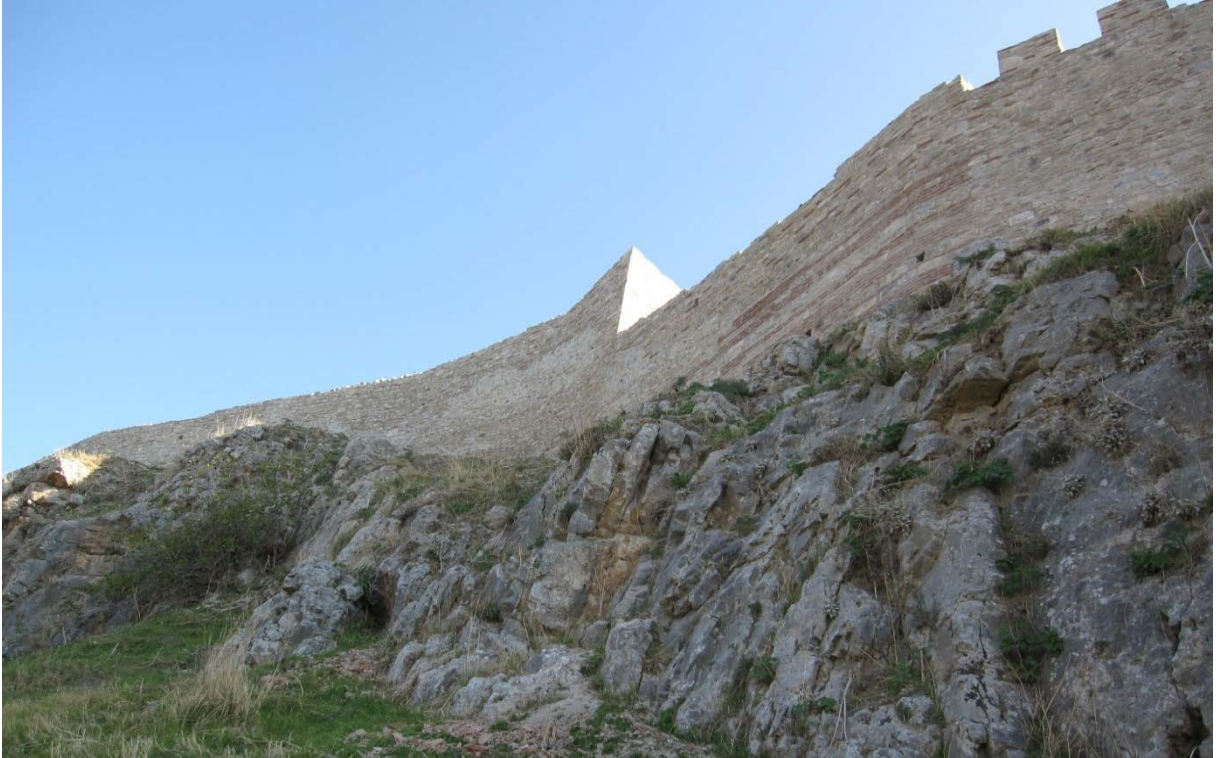
Resim 149: BK 3 – BK 5 arasındaki sur duvarları onarımdan sonra.
