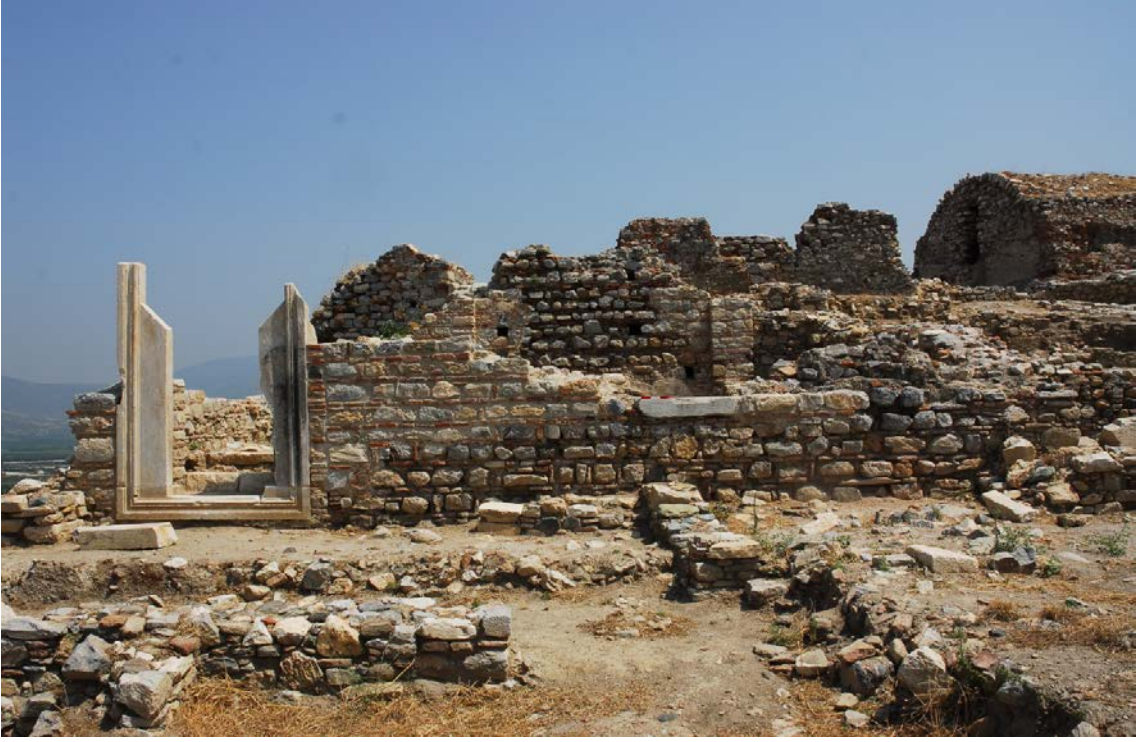
Resim 170: Kale Köşkü güney duvarı kapısı 2009 yılı onarımı sonrası.
