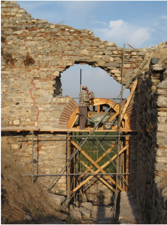
Resim 86: Batı Sur Girişi üzerine kemerin yerleştirilmesi ve kemer onarım başlangıcı.
