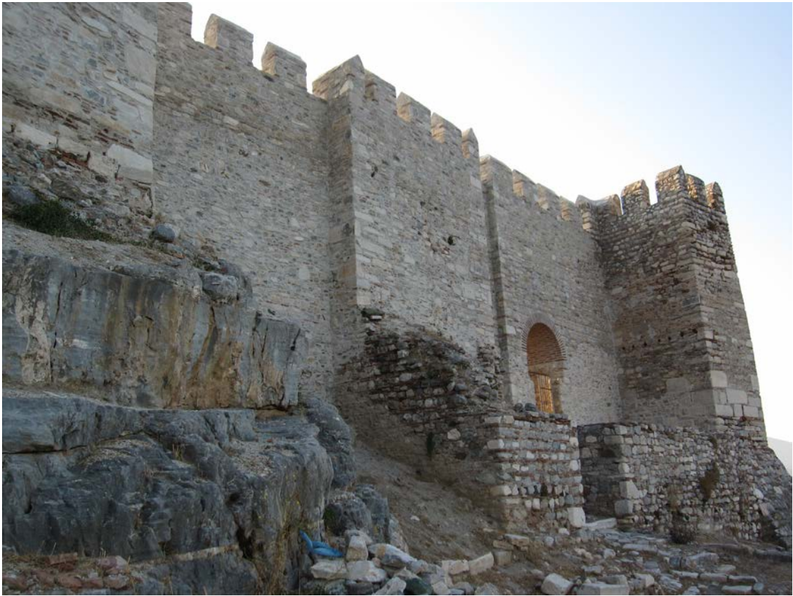
Resim 85: Batı Sur Duvarları BK1-BK2 arasının restorasyon sonrası görünümü.
