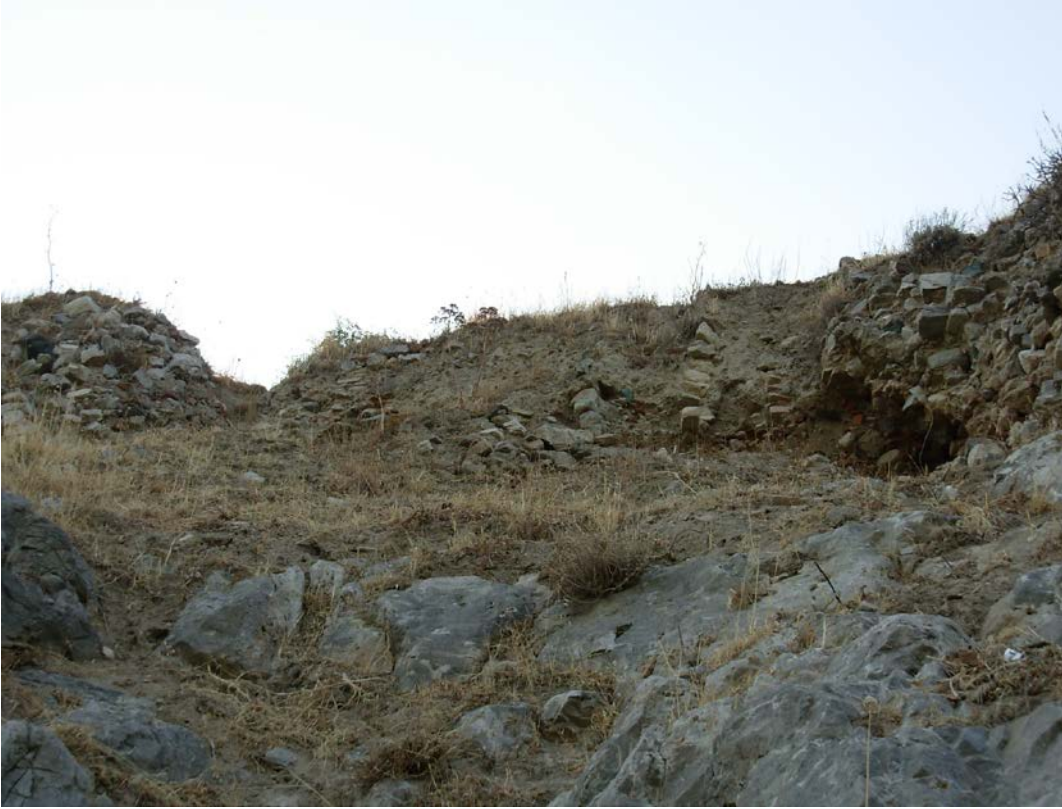
Resim 114: BK 3 Kulesi ve kuzeyindeki sur duvarları onarım öncesi (2010).
