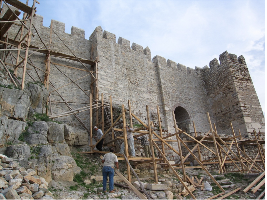
Resim 83: İç Kale Batı Sur Duvarları ve BK1-BK2 arası restorasyon sonlarında.
