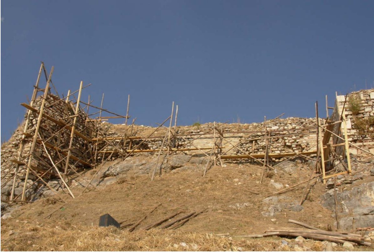
Resim 96: İç Kale BK2 - BK3 arasında restorasyon öncesi iskele kurum aşaması.
