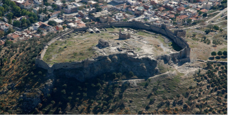
2009 Yılı Onarım Çalışmaları Sonrası
