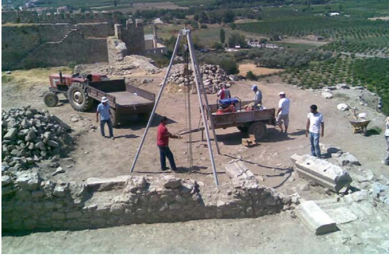
Resim 160: Kale Köşkü Güney kapısının kazı sonrası, onarım hazırlıkları.
