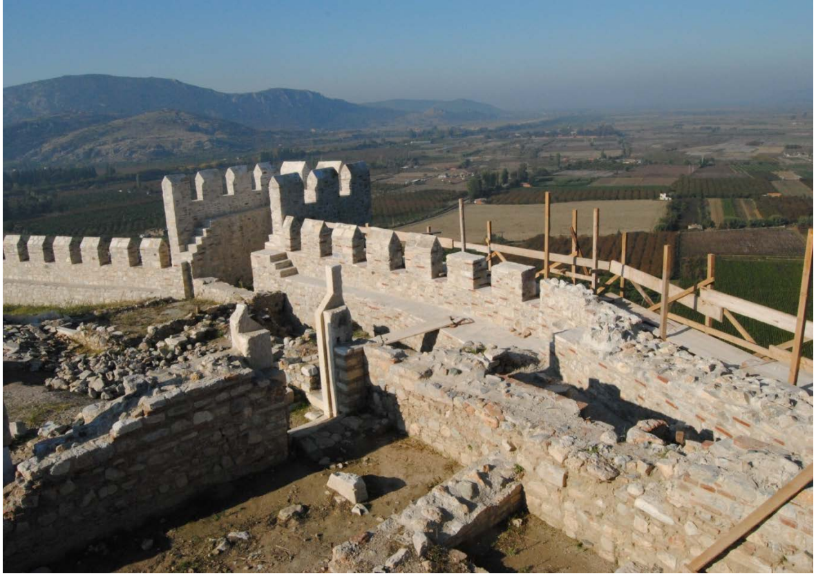
Resim 126: BK 3 ve BK 4 arasındaki sur duvarları onarım sonlarında.
