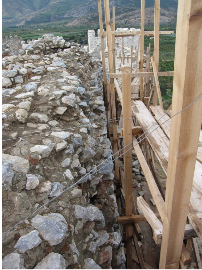
Resim 147: BK 4 – BK 5 arasındaki sur duvarları onarımdan önce.
