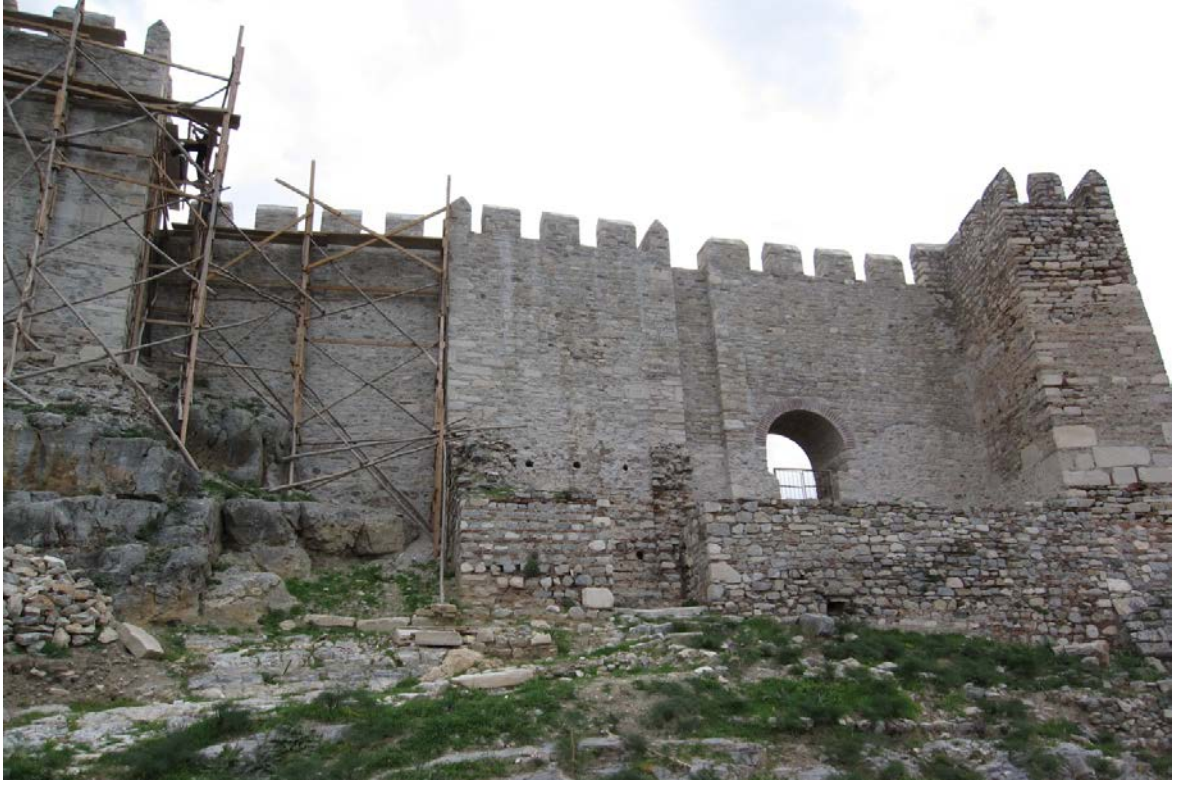
Resim 84: İç Kale Batı Sur Duvarları ve Bk 1-BK2 arası restorasyon sonlarında.
