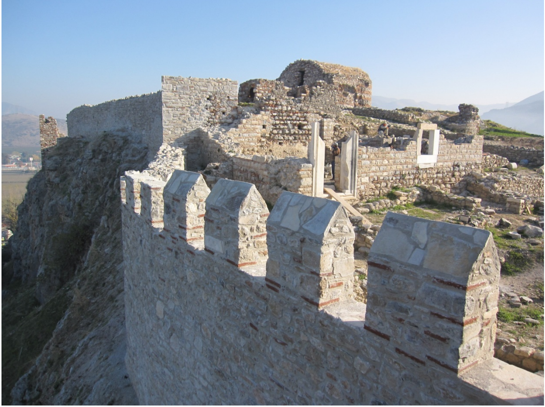
Resim 178: BK4 Kulesi ve Kale Köşkü güney cephesinin onarımdan sonra genel görünümü.
