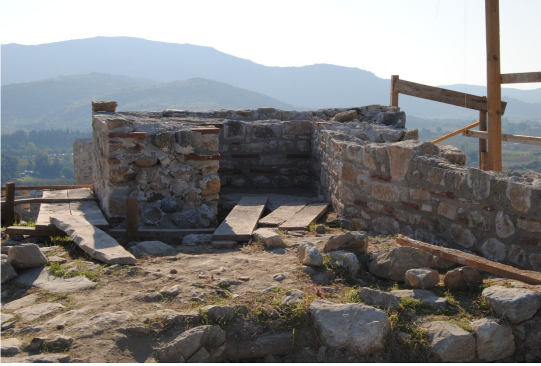
Resim 129: BK 4 kulesi onarım sonrası.
