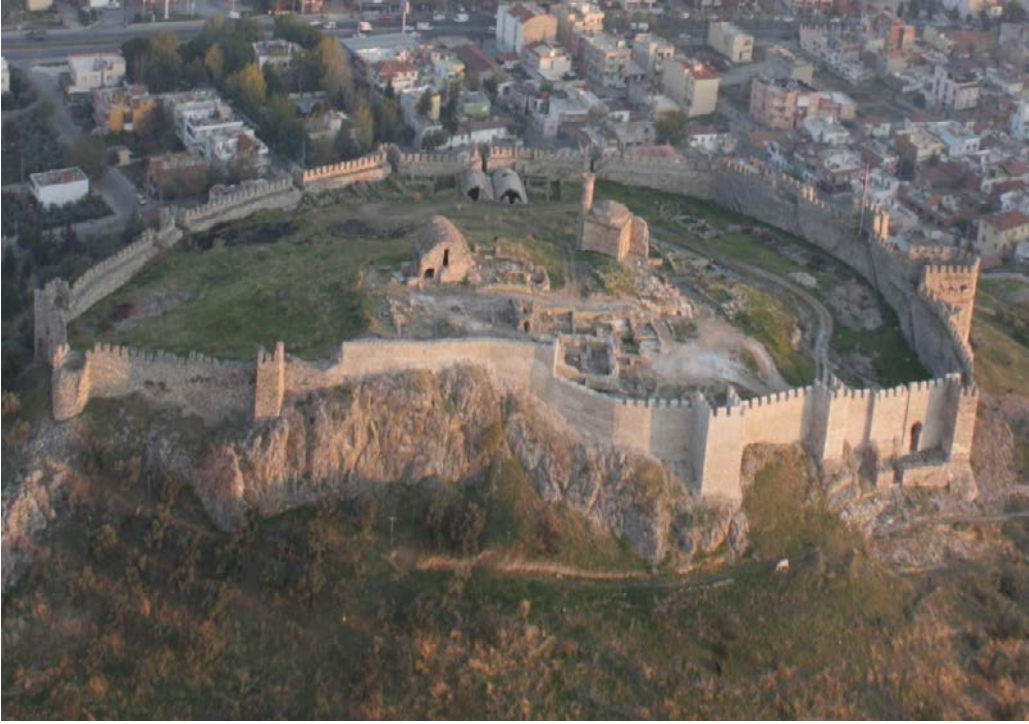
Resim 157: Ayasuluk İç Kale Batı sur duvarı 2011 yılı onarımlarından sonra.
