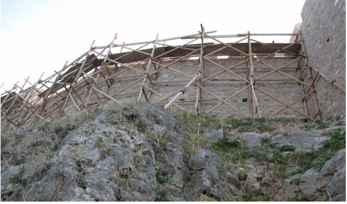
Resim 115: BK 3 ve BK 4 arasındaki sur duvarları onarım sırasında (2011).
