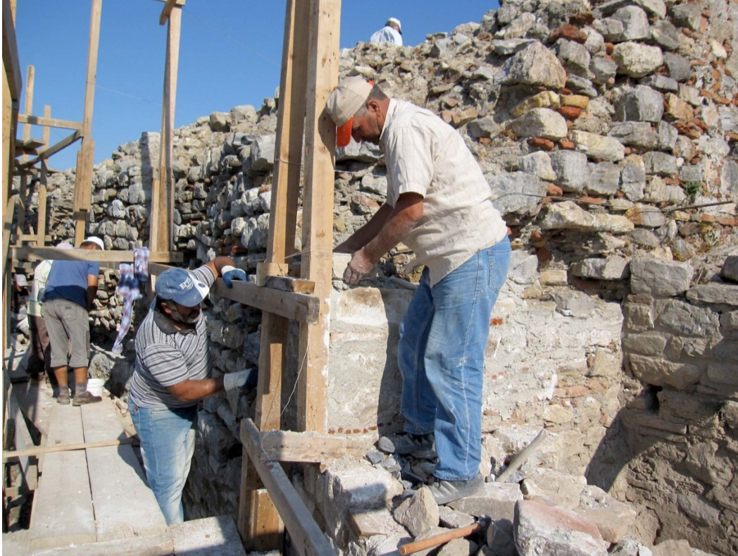
Resim 132: BK 4 Kulesi GB köşe onarım sırasında.
