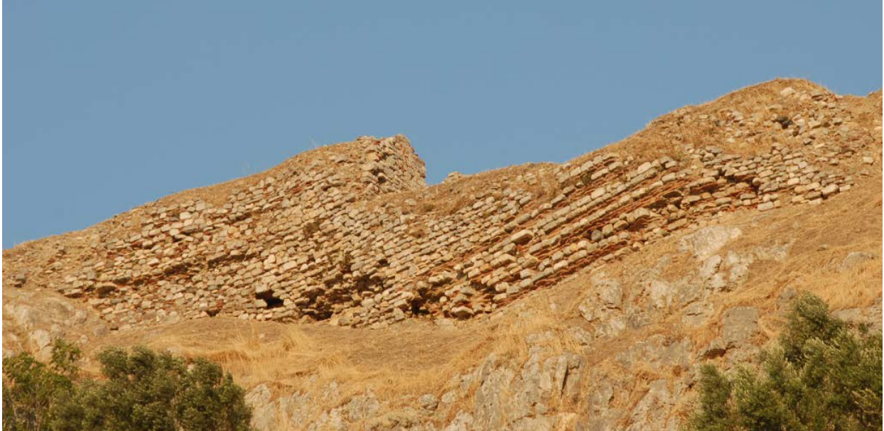
Resim 117: BK 3 – BK 4 arasındaki sur duvarları onarımdan önce (2011 başı).
