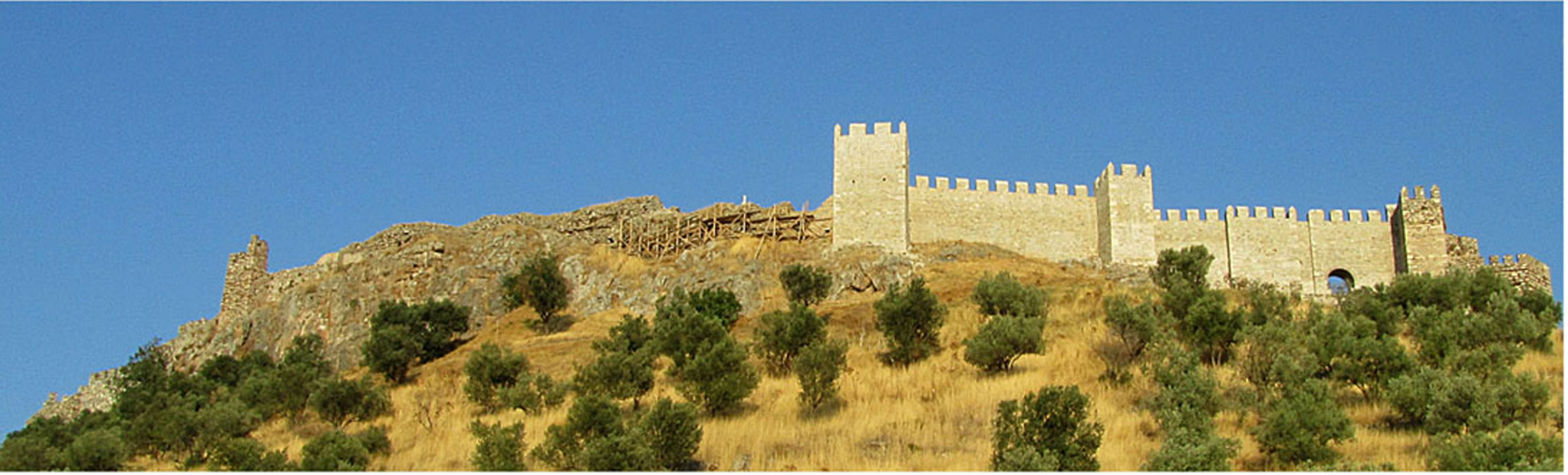
Ayasuluk İç Kale, Batı Sur Duvarları, 2010 sonu.
