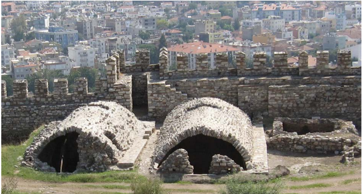
Resim 190: Doğu Sarnıçları genel DS2 konservasyon ve onarım sonrası.
