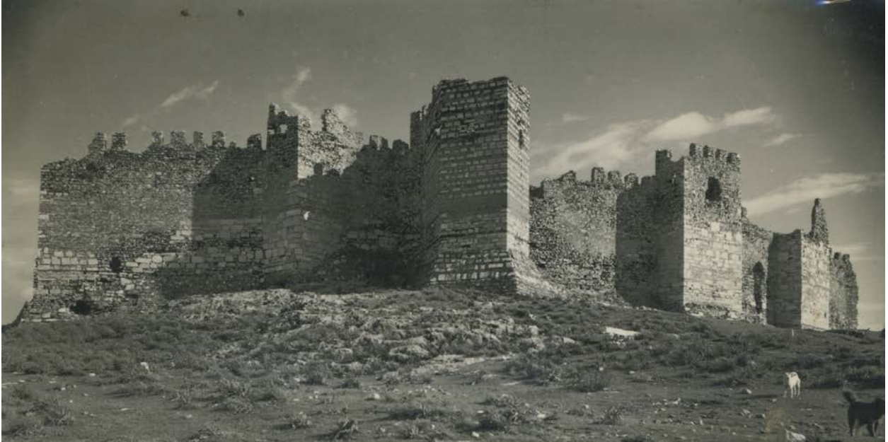
Resim 3: 1860 yıllarında Ayasuluk İ Kalesi Gney Duvarı ve Kuleleri.
