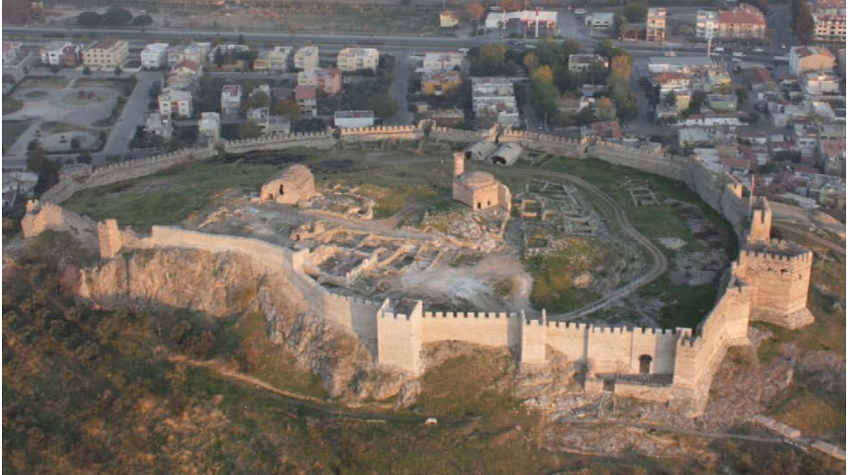
Resim 179: Ayasuluk, İç Kale Batı Sur Duvarı onarımlardan sonra (2011 sonu ).
