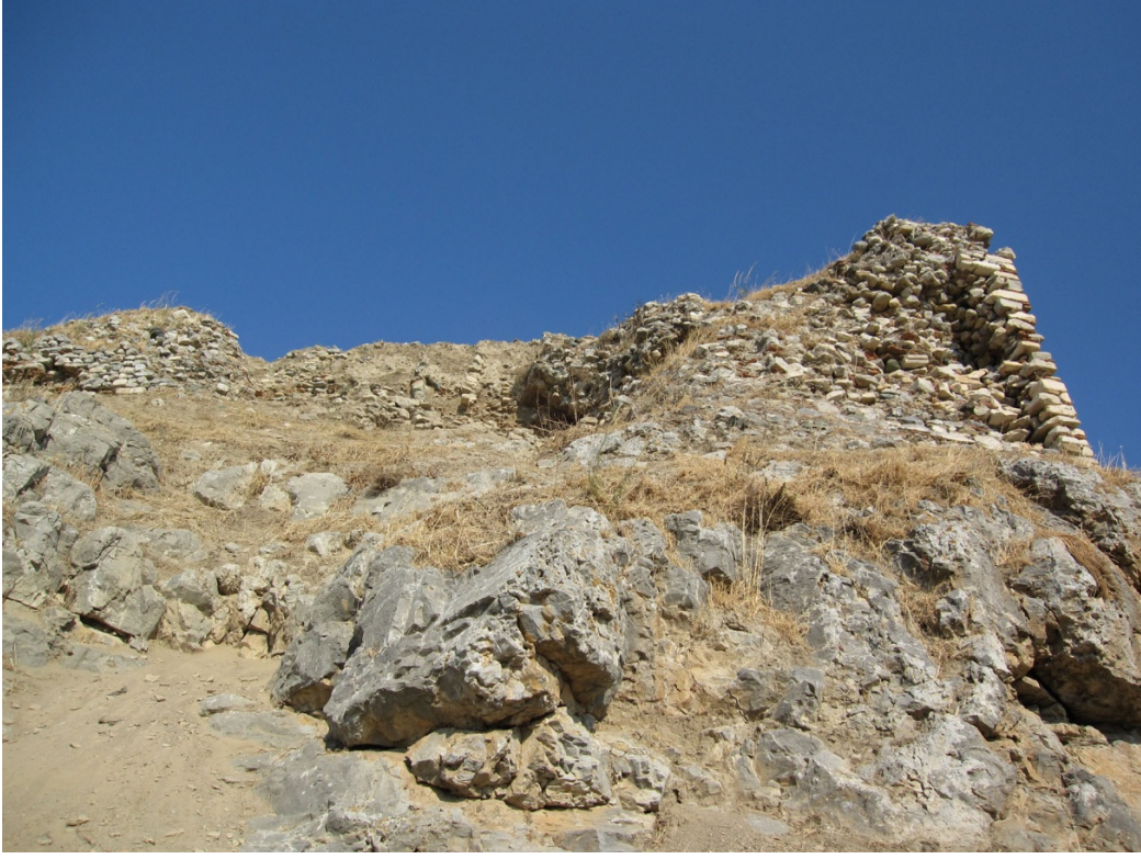
Resim 113: BK 3 ve BK 3 – BK4 arasındaki sur duvarları onarım öncesi (2009).
