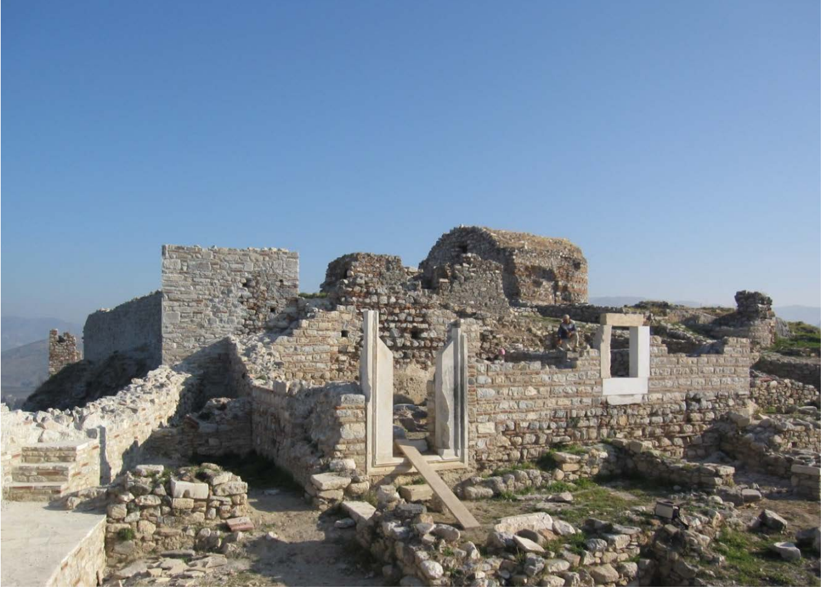
Resim 173: Kale Köşkü güney cephe penceresi ve duvarı onarımdan sonra.
