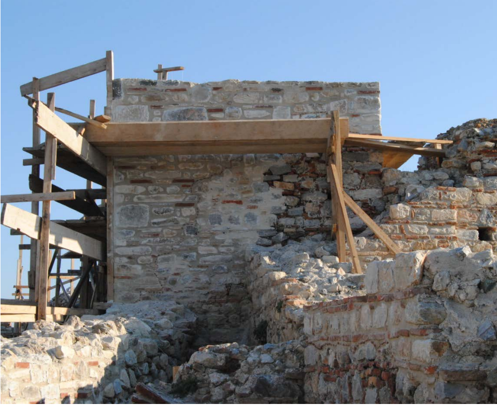
Resim 133: BK 4 Kulesi gney cephe onarım sonlarında.
