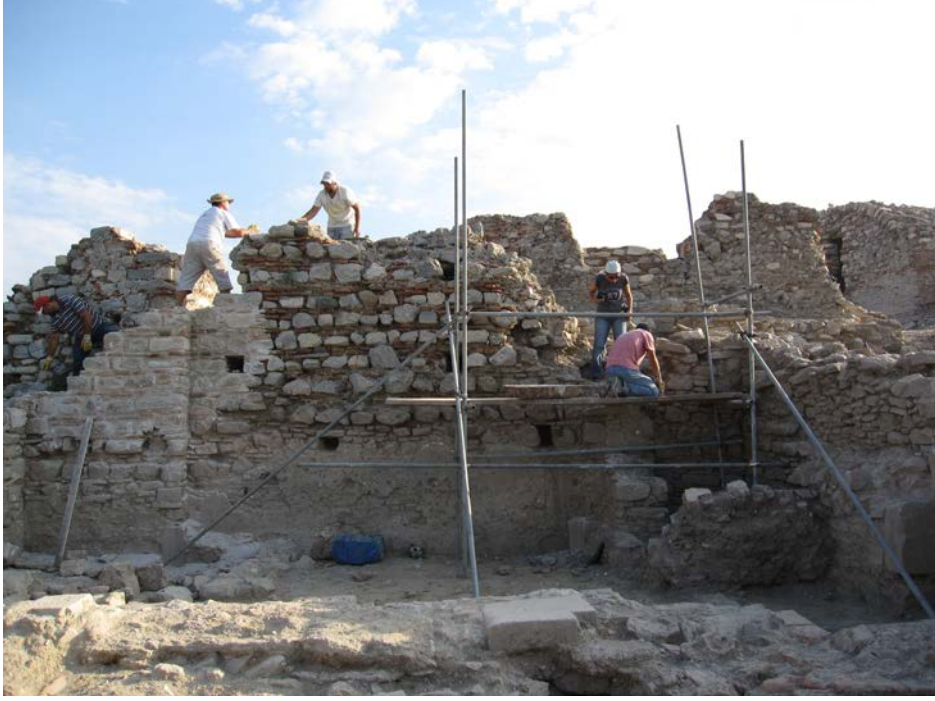
Resim 168: Dizdar Evi kuzey duvarının konservasyon sırasında görünümü.
