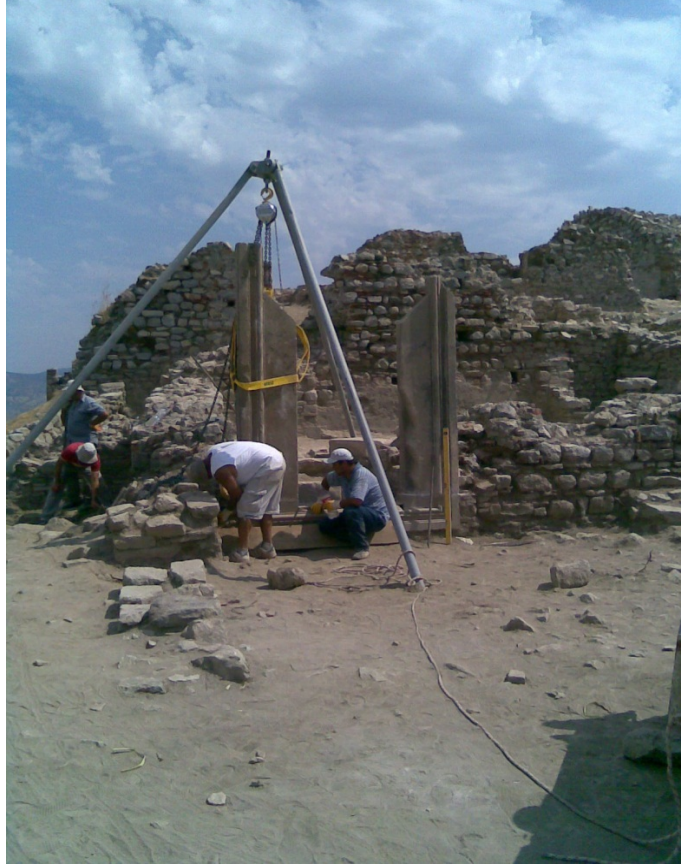
Resim 164: Kale Köşkü Güney kapısının onarım sonrası görünümü.
