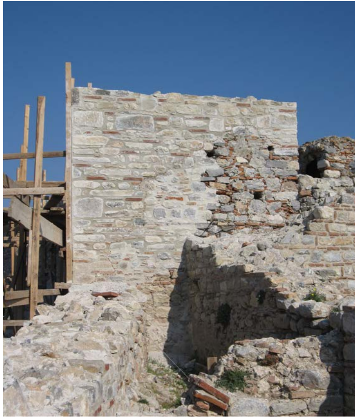
Resim 134: BK 4 Kulesi gney cephe onarım sonunda.
