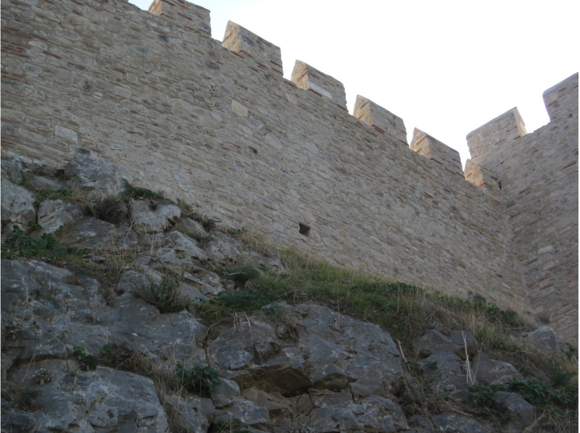
Resim 116: BK 3 ve BK 4 arasındaki sur duvarları onarımdan sonra (2011 sonu).
