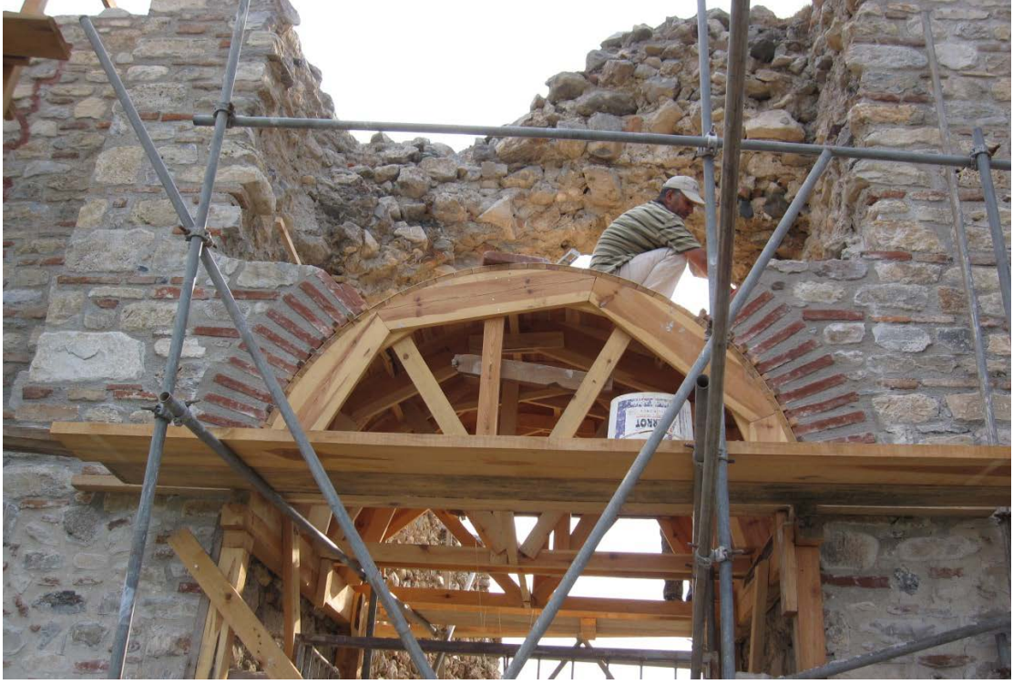
Resim 80: İç Kale Batı Sur Girişi kemi restorasyon sırasında.
