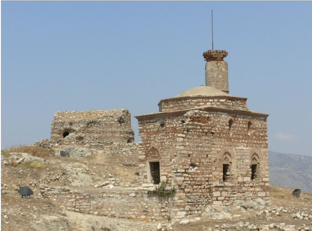
Resim 180: Kale Camii onarım çalışması öncesi genel durum.
