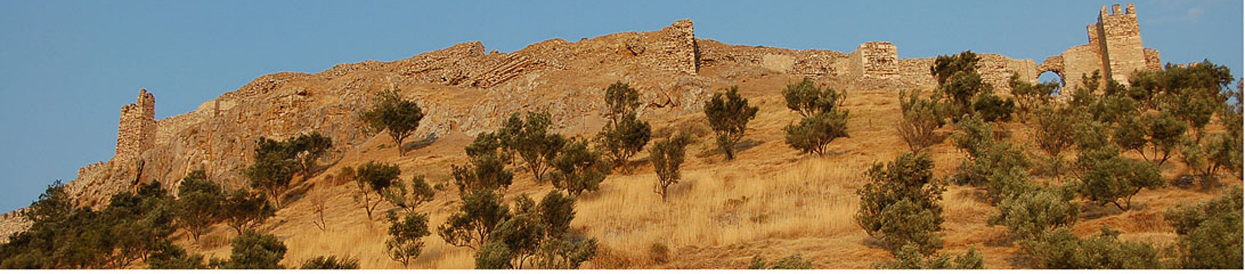
Ayasuluk İç Kale, Batı Sur Duvarları, 2009.
