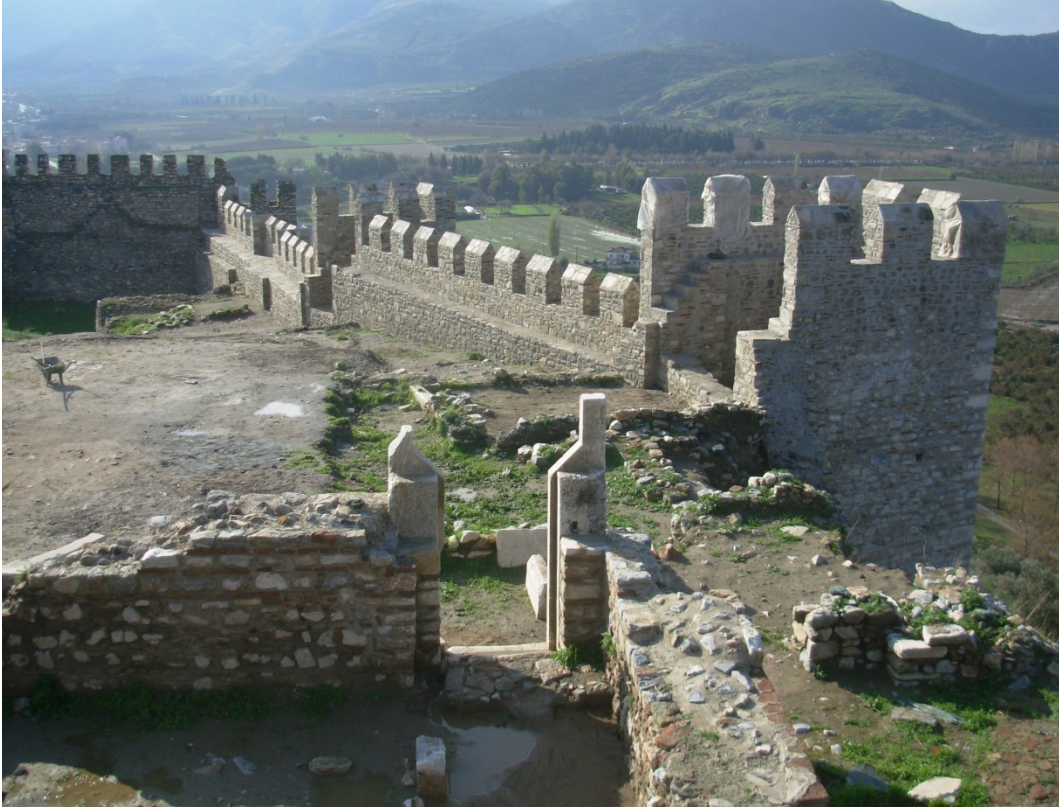
Resim 120: BK 3 ve BK 4 arasındaki sur duvarları 2011 onarımından önce.
