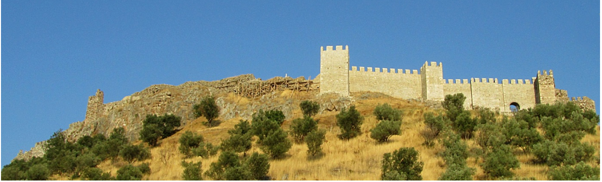
Resim 151: İç Kale batı sur duvarları, 2010 onarımı sonrası.
