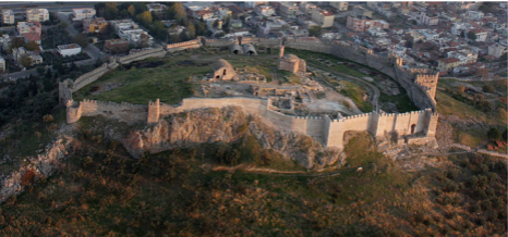
2011 Yılı Onarım Çalışmaları Sonrası
