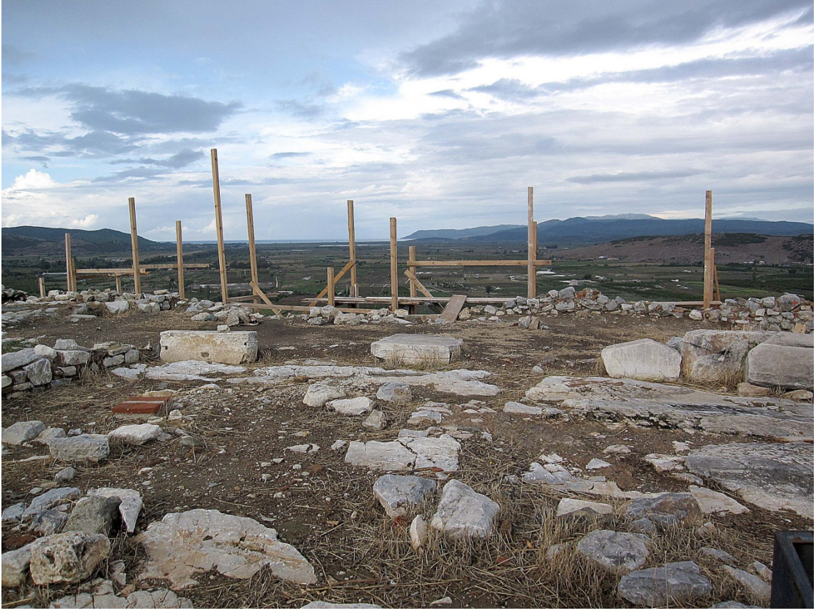
Resim 144: BK 4 – BK 5 arasındaki sur duvarları (Güney bölüm) iç yüzü onarımdan önce.
