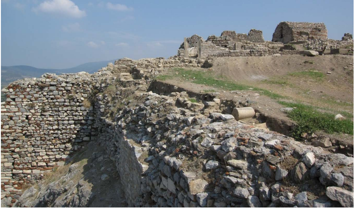
Resim 31: Batı Sur Duvarları BK2 - BK3 arasındaki bölüm.
