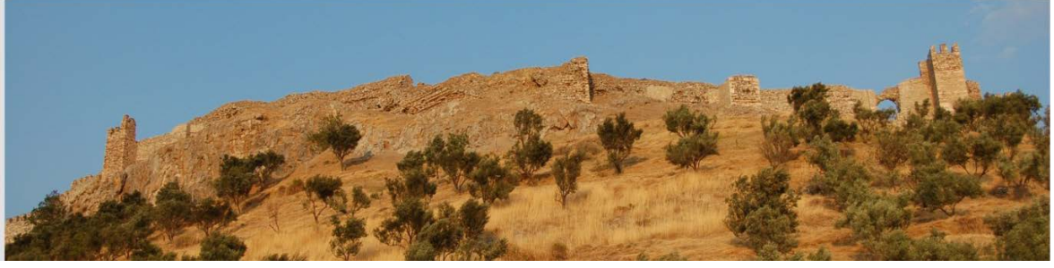
Resim 150: İç Kale batı sur duvarları, 2009.
