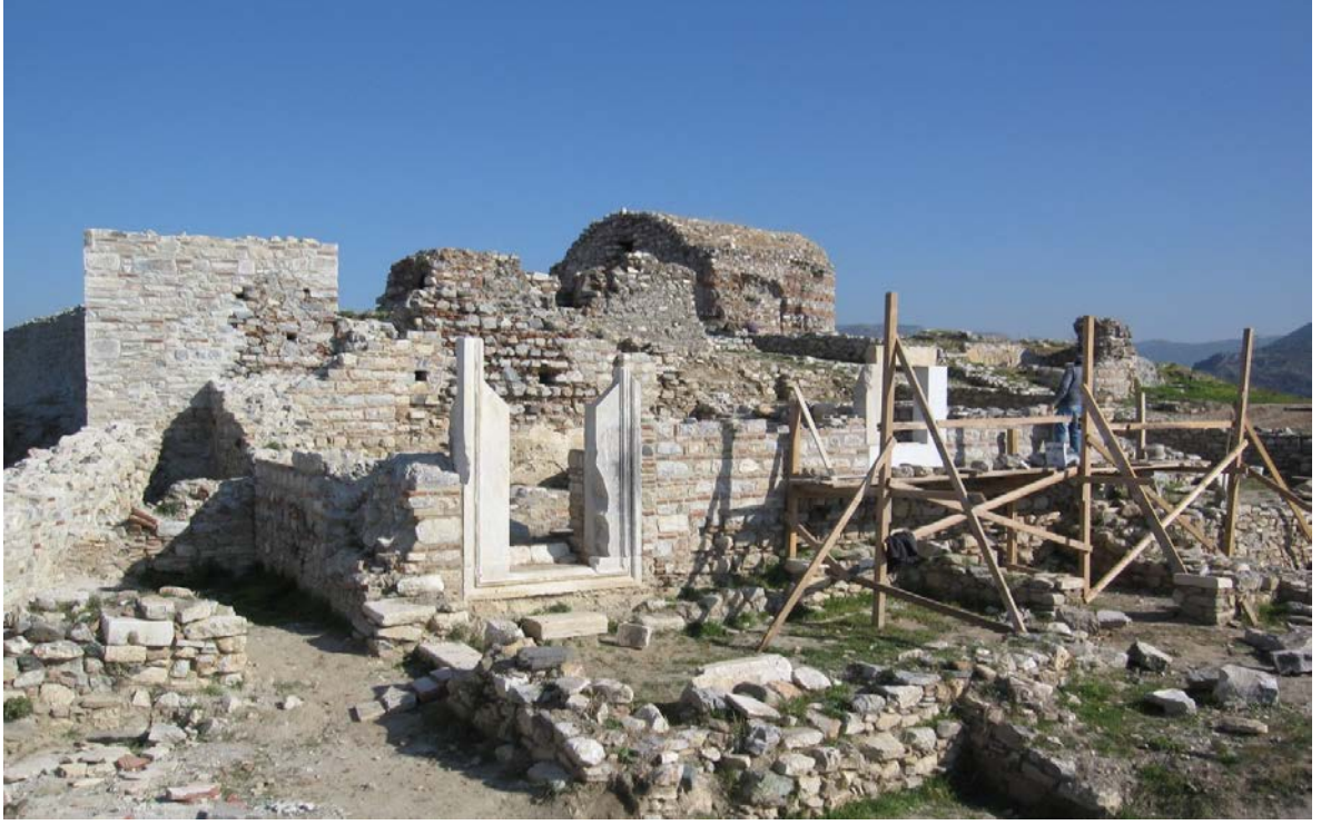
Resim 172: Kale Köşkü güney cephe duvarı onarım sırasında.
