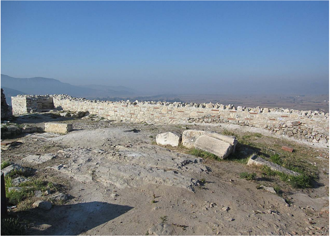
Resim 145: BK 4 – BK 5 arasındaki sur duvarları (Güney bölüm) iç yüzü onarımdan sonra.
