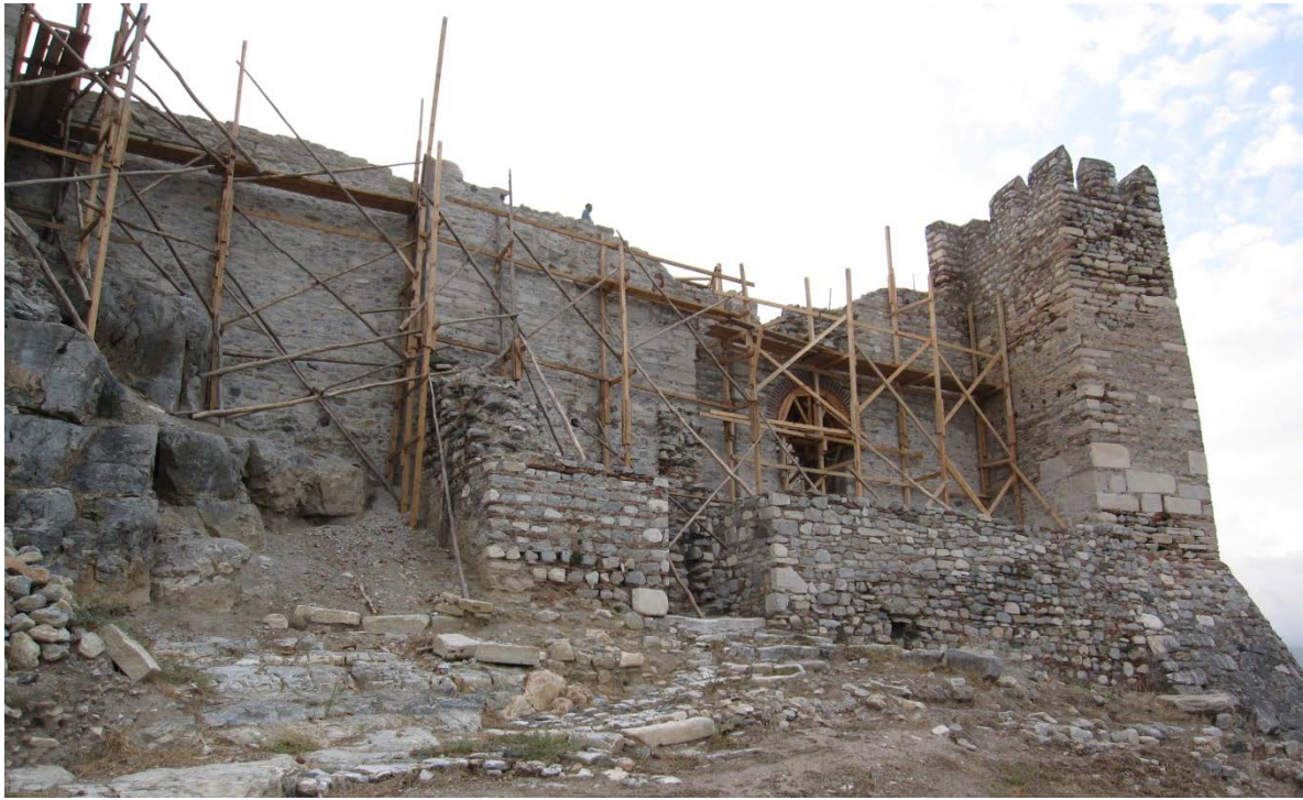
Resim 79: Batı Sur Duvarları BK1-BK2 arasının restorasyon sırasında görünümü.
