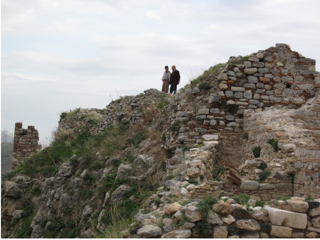
Resim 127: BK 4 ve BK 5 arasındaki sur duvarları onarımdan önce.
