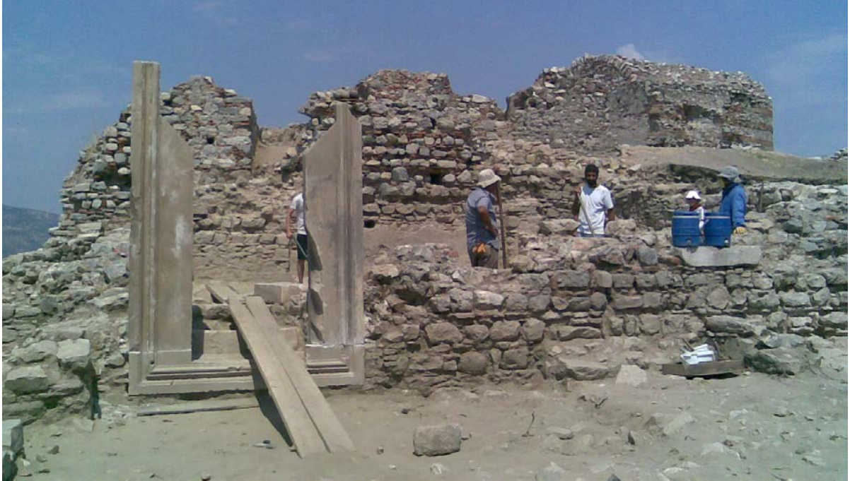
Resim 165: Kale Köşkü duvarları kazı sonrası, konservasyon öncesi görünümü.
