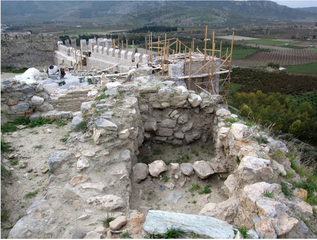
Resim 128: BK 4 kulesi onarımdan önce.
