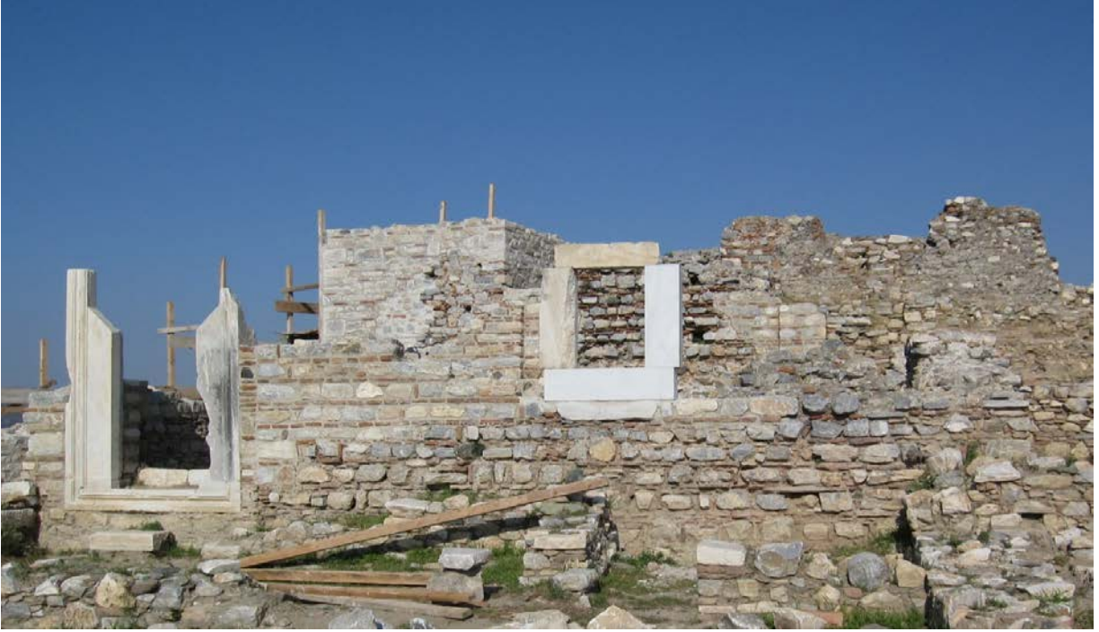
Resim 174: Kale Köşkü güney cephe duvarı onarımı öncesi.
