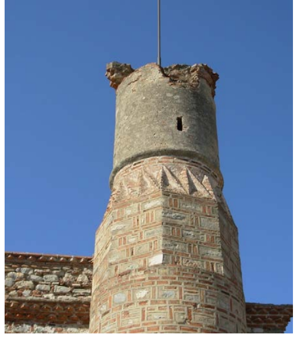
Resim 182: Minare 1963 yılı onarım sonrası.
