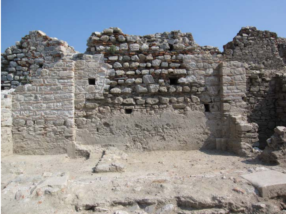
Resim 169: Kale Köşkü kuzey duvarının acil onarımlar sonrası görünümü.
