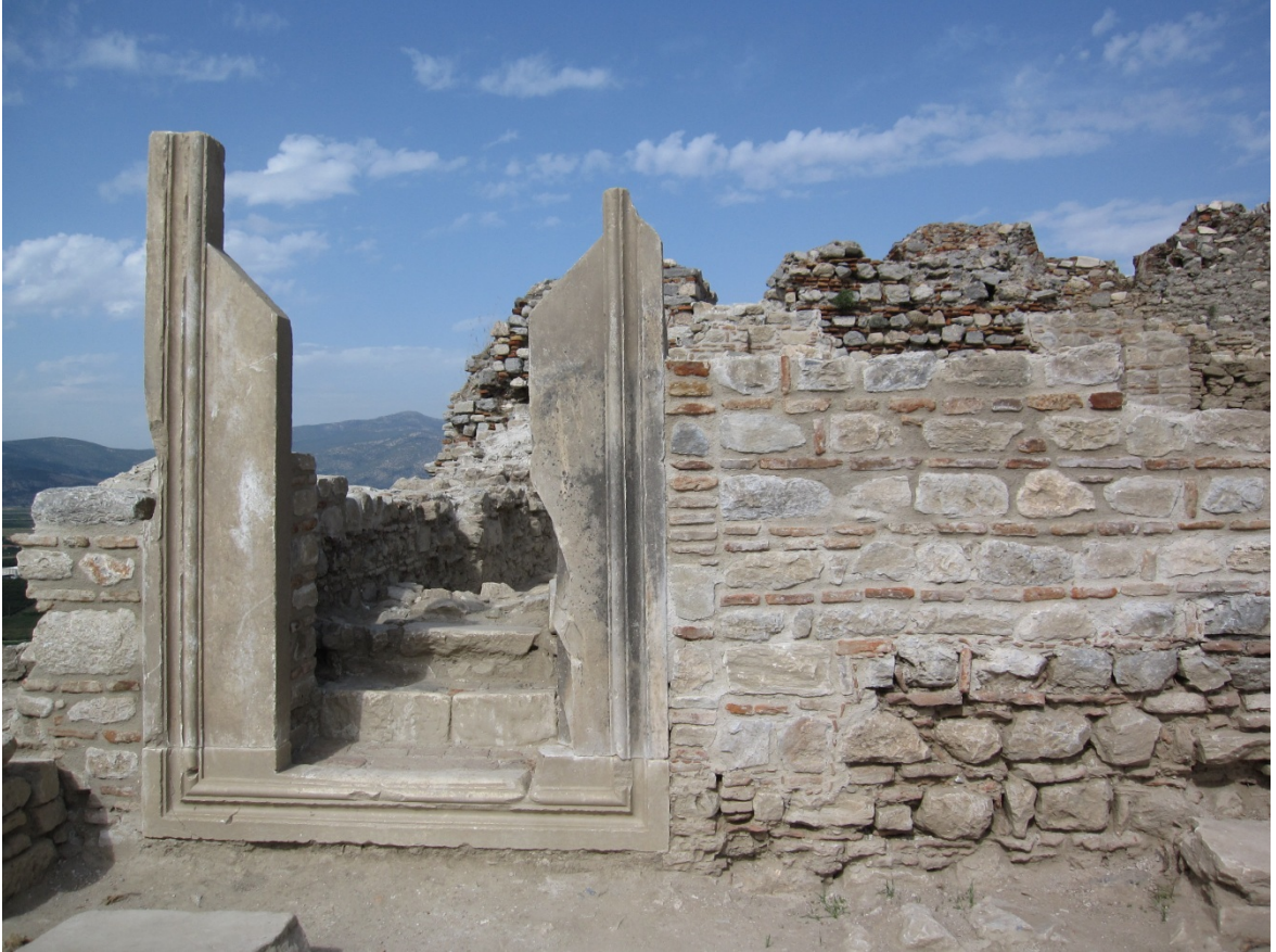
Resim 167: Kale Köşkü güney kapı ve duvarın konservasyon sonrası görünümü.
