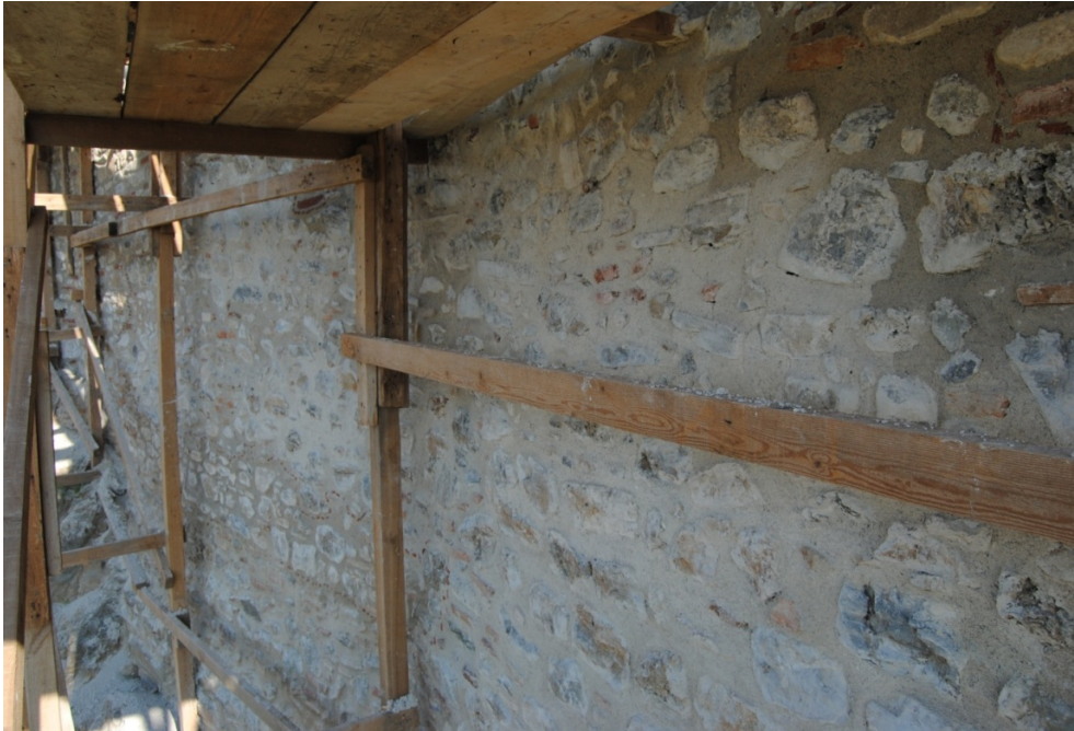
Resim 141: BK 4 – BK 5 arasındaki sur duvarları dış yüz derzleme ve onarımdan sonra.
