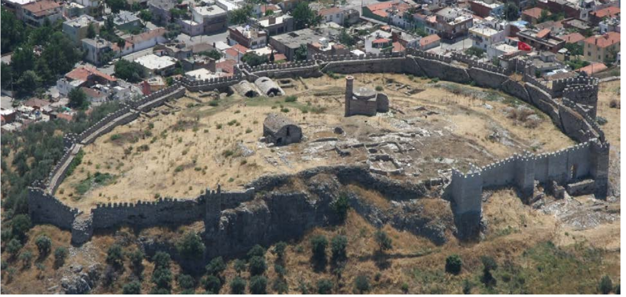
Resim 156: Ayasuluk İç Kale Batı sur duvarı 2010 yılı onarımlarından sonra.
