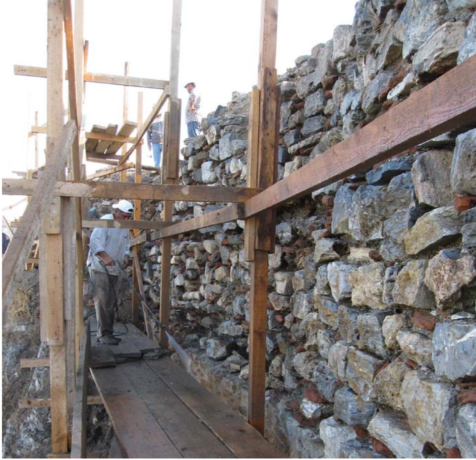
Resim 140: BK 4 - BK 5 arasındaki beden duvarı onarım öncesi yıkılıyor.
