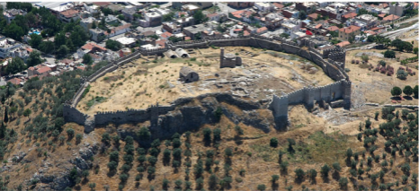
2010 Yılı Onarım Çalışmaları Sonrası
