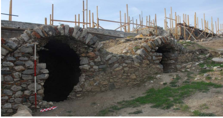
Resim 59: Batı Sarnıç I ve Batı Sarnıç II önlerinden genel görünüm.
