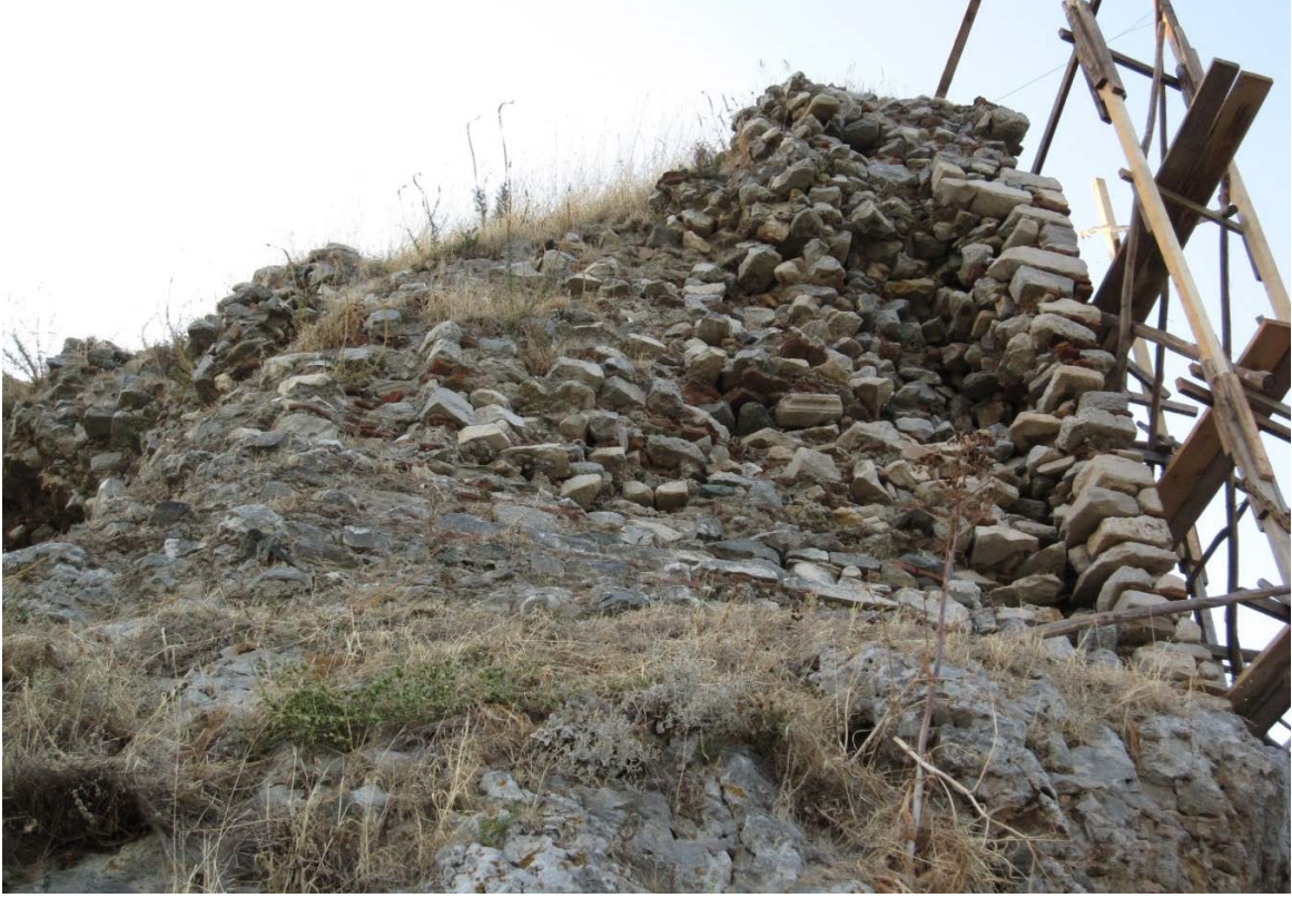
Resim 100: İç Kale Batı Kule 3 (BK3) batı duvarı restorasyon öncesi.
