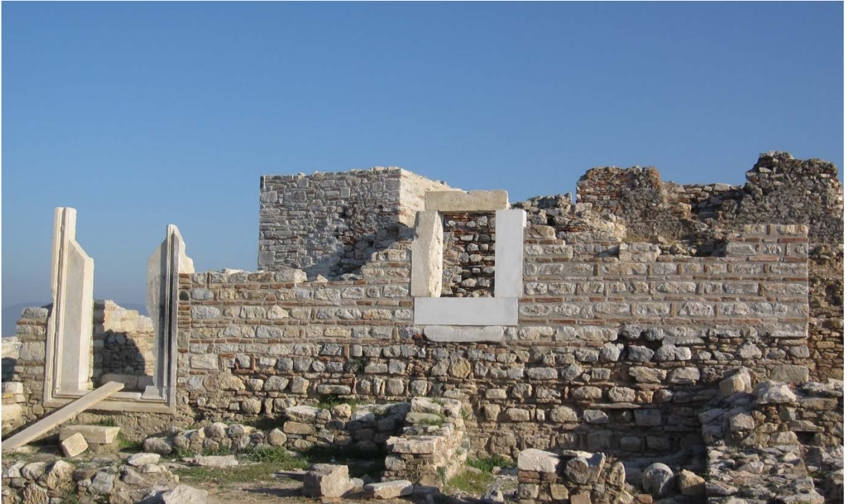
Resim 175: Kale Köşkü güney cephe penceresi ve duvarı onarımdan sonra.
