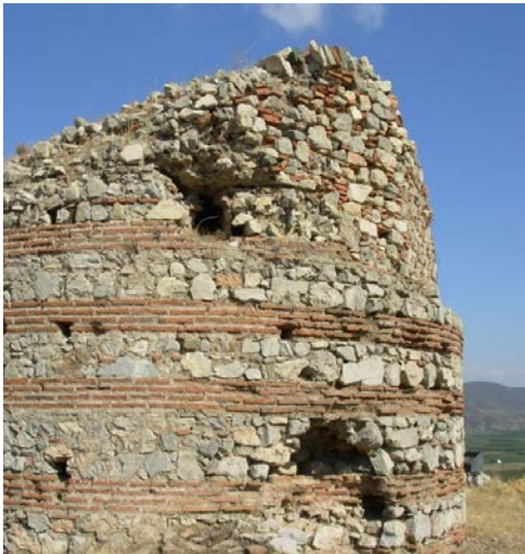
Resim 193: Bazilika-Sarnıç apsis dışındaki bozulmalar onarım öncesi ve sonrası.
