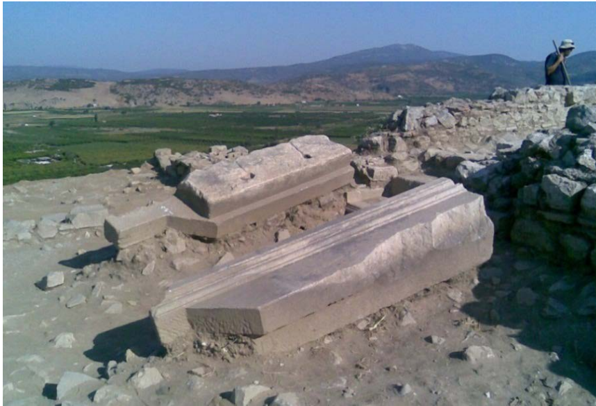
Resim 159: Kale Köşkü güney kapısının kazı sonrası, onarım öncesi görünümü.
