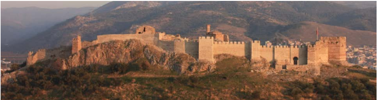
Resim 153: İç Kale batı sur duvarları, 2011 onarımı sonrası.
