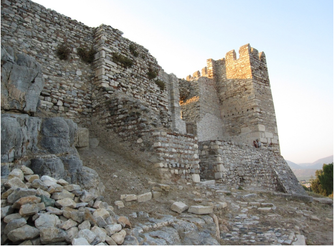
Resim 76: İç Kale Batı Sur Duvarlarının restorasyon öncesi görünümü.
