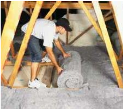
Şekil 58. Tekstil atıklarının binalarda yalıtım malzemesi olarak kullanımı
