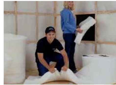
Şekil 58. Tekstil atıklarının binalarda yalıtım malzemesi olarak kullanımı
