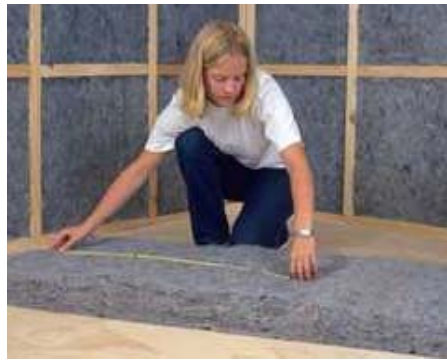
Şekil 58. Tekstil atıklarının binalarda yalıtım malzemesi olarak kullanımı
