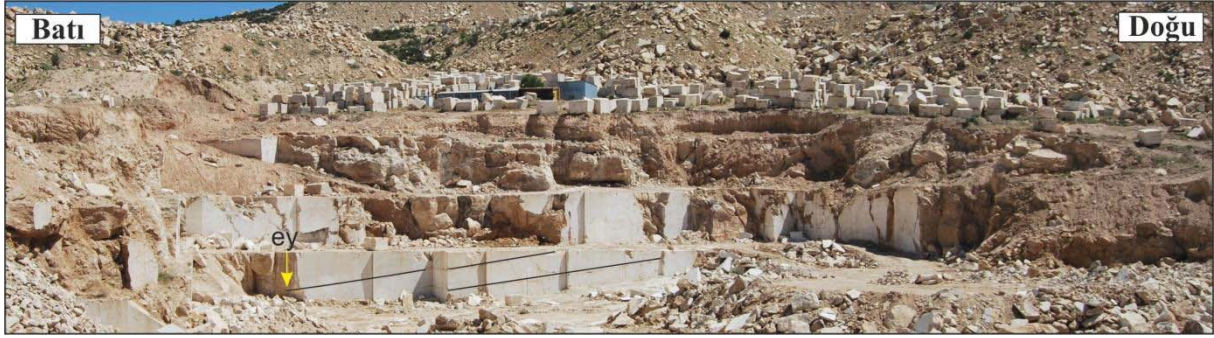
Şekil 12. Terkedilmiş Sirmersan ocağının genel görüntüsü (ey: erozyonel yüzey). Kuzeye bakış.
