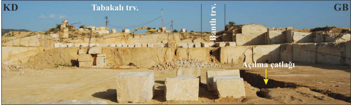
Şekil 8. Akköy çatlak sırtını oluşturan bantlı ve tabakalı travertenler. Güneydoğuya bakış.
