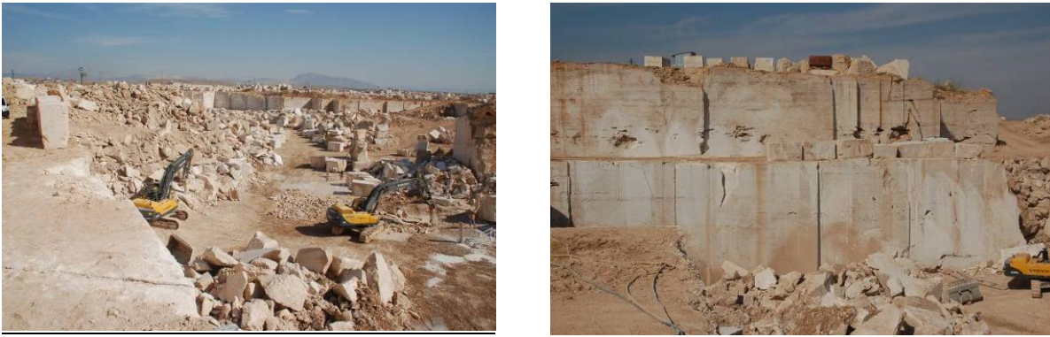
Şekil 33. Erdem Mermer firmasına ait ocağın yaygın kırık ve çatlaklılık ile gözenekliliğinin görünümü.
