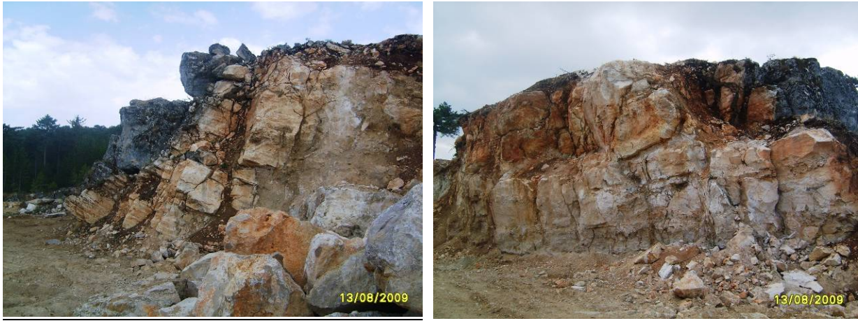
Şekil 138. Ocakta tektonizmaya bağlı olarak oluşmuş yaygın kırık ve çatlaklılık.
