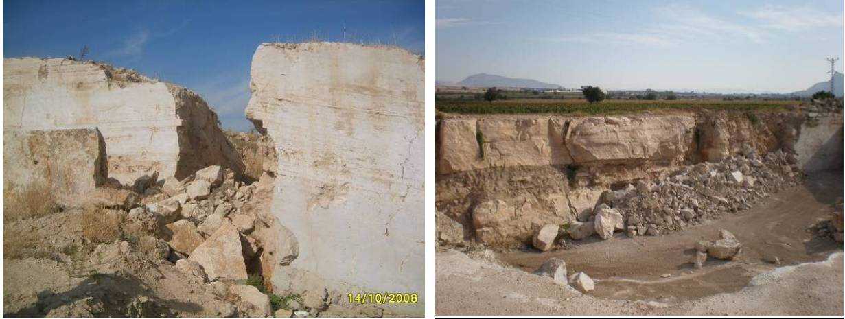
Şekil 31. Aydın Mermer firmasına ait ocağın ve ocak içindeki faylarla açılmış çatlakların görünümü.
