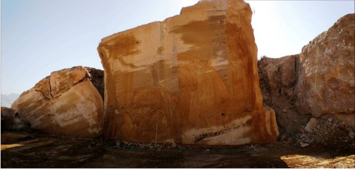
Şekil 123. Ocak içinde belirlenen 2 ayrı açılma çatlaklarının konumu.
