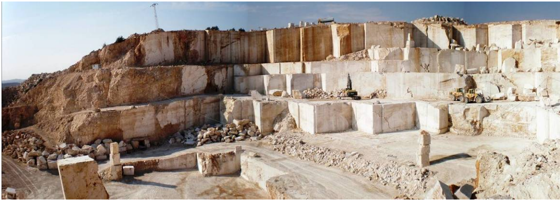
Şekil 98. Kırık ve çatlaklılık ile ovaya doğru eğimli tabakalanmanın olduğu ocağın genel görünümü.
