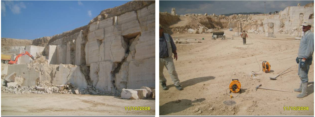
Şekil 24. Özhan Mermer firmasına ait ocakta kırık ve çatlaklılık ve yapılan sismik serim çalışmasından görünüm.
