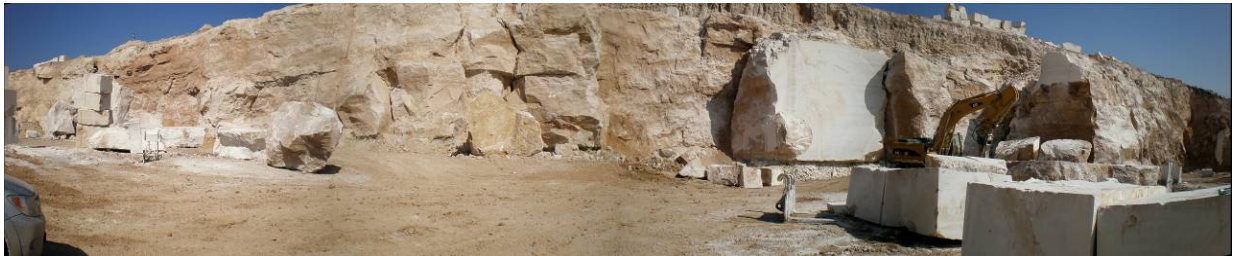
Şekil 76. Travertine Bros. firmasına ait tek kademe olarak işletilen ocakta yaygın ve düzensiz gelişmiş kırık ve çatlaklılığın görünümü.
