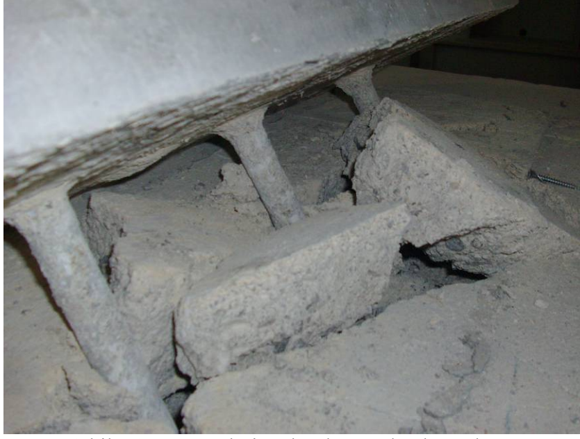
Şekil 5.3 Numunelerin çıkarılmasında oluşan hasar
