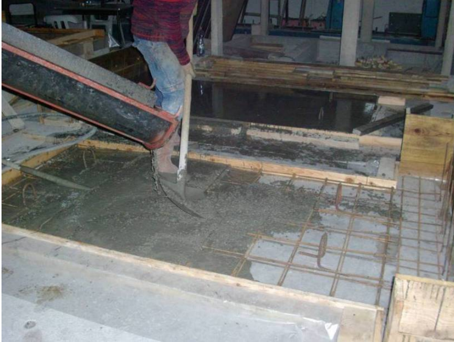
Şekil 6.10 Perdelerin beton dökümü
