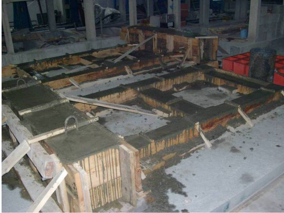
Şekil 6.8 Çerçevelerin beton dökümünden görüntü
