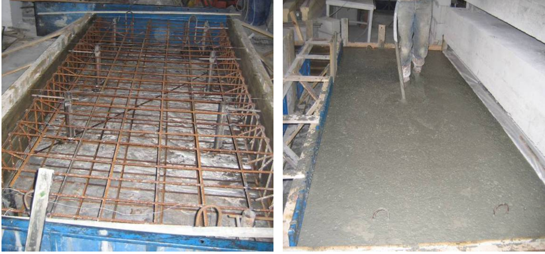
Şekil 4.13. Betonarme temellerin donatıları ve beton dökümü
