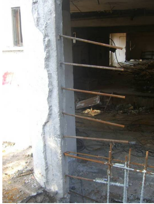
Şekil 3.4 İskelesiz açılmış ters yönde açılmış delikler
