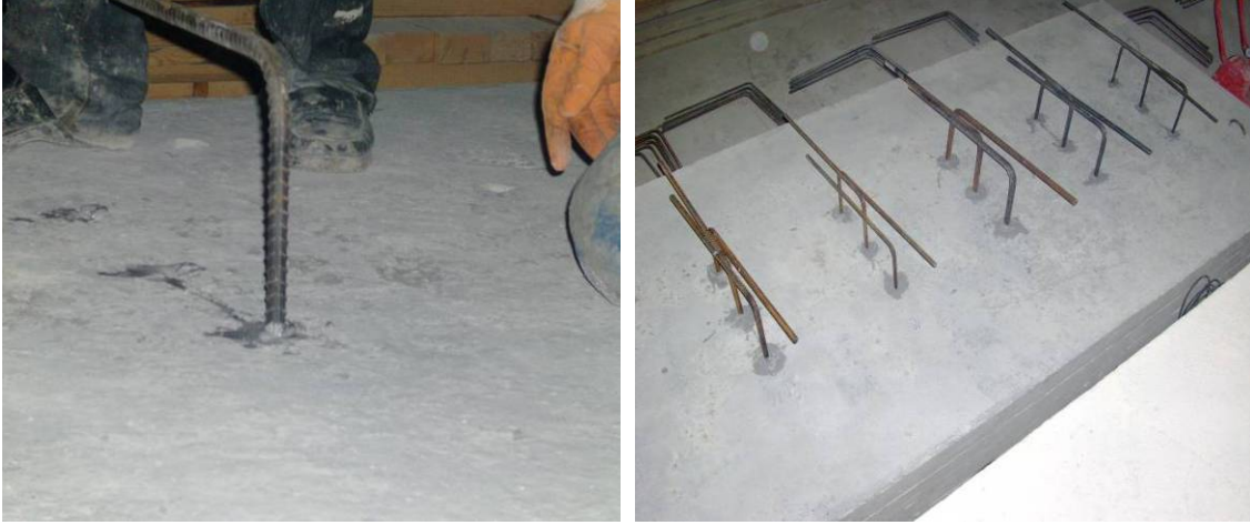
Şekil 4.15. Ankrajların ekilmesi
