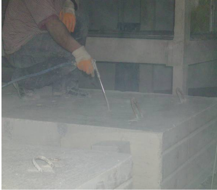
Şekil 4.14. Ankraj deliklerinin temizlenmesi
