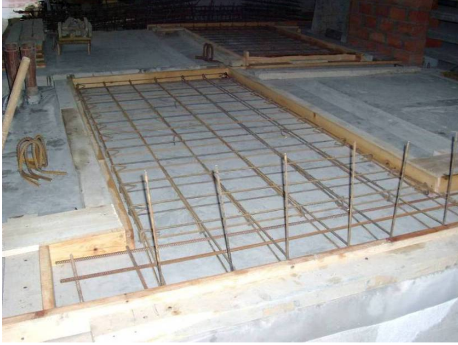
Şekil 6.9 Perde kalıbı
