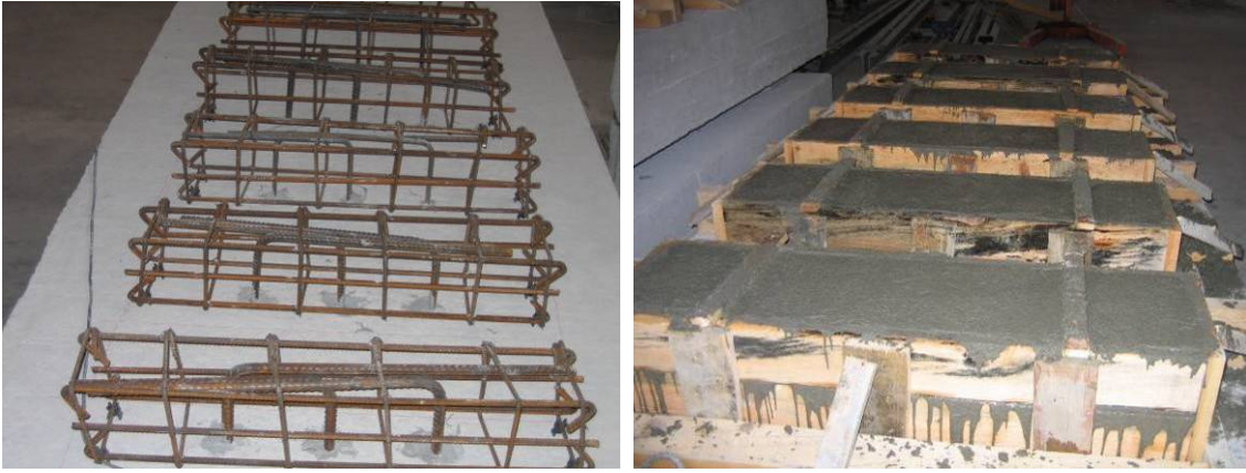
Şekil 4.16. Betonarme blokların donatıları ve beton dökümü
