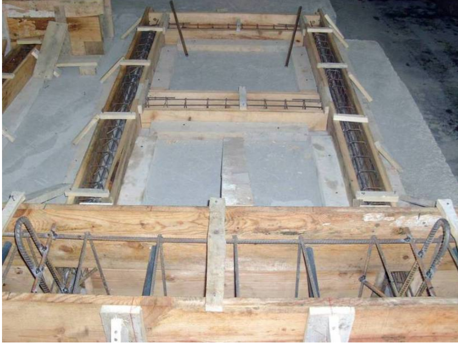
Şekil 6.7 Çerçeve kalıbı
