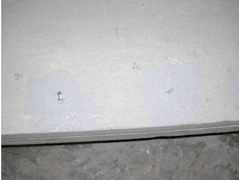
Şekil 6.11 Çerçeveslere perdelerin ankrajlarla bağlanması
