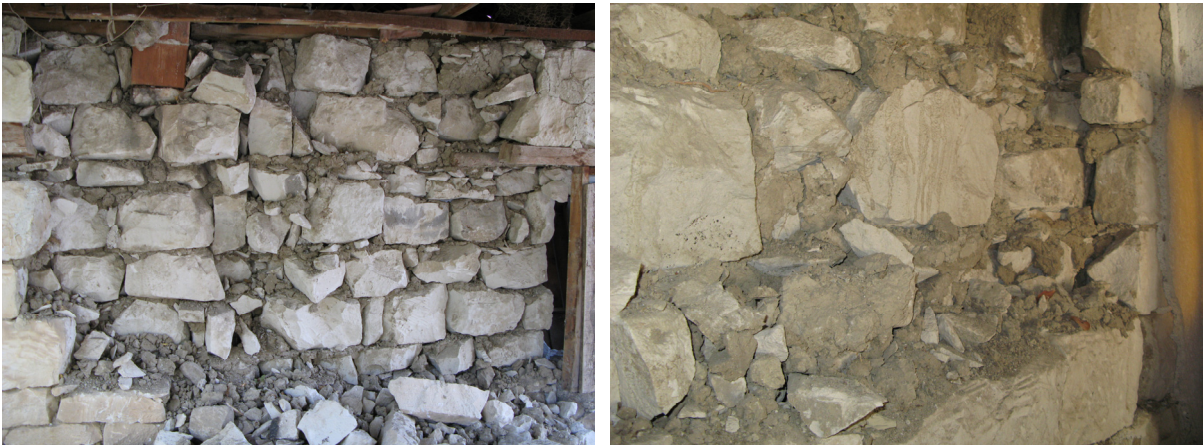
Şekil 5.2. Marn bloklardan imal edilmiş duvarlar ve dolgu harcı
