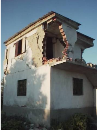
Şekil 2.1 Ülkemizde son yıllardaki depremlerde hasar gören yığma yapılardan örnekler
