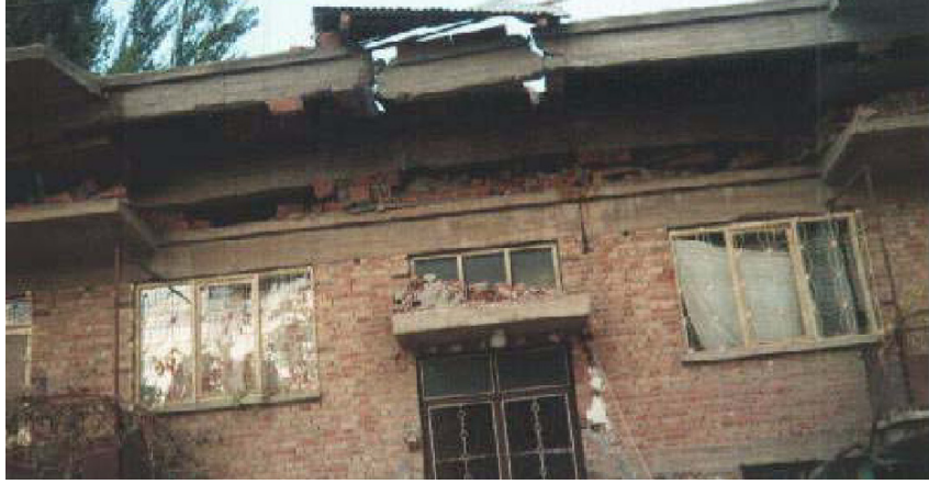
Şekil 2.1 Ülkemizde son yıllardaki depremlerde hasar gören yığma yapılardan örnekler
