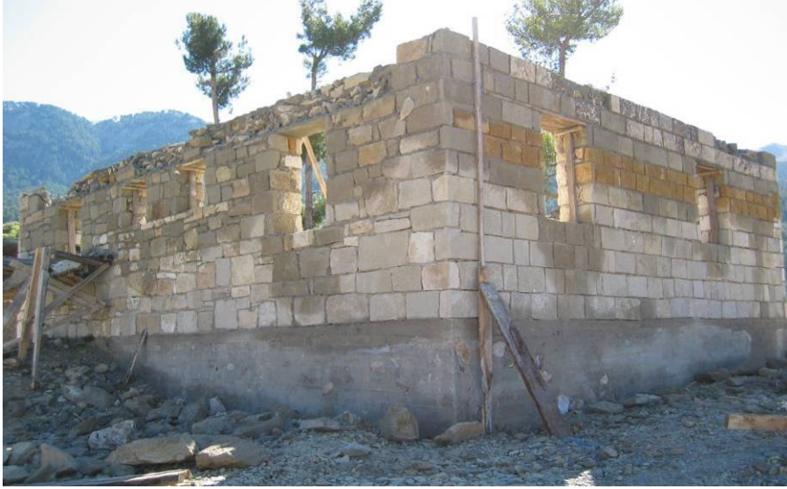
Şekil 5.8. İç duvarları imal edilmeden önce dış duvarları imal edilen yapı
