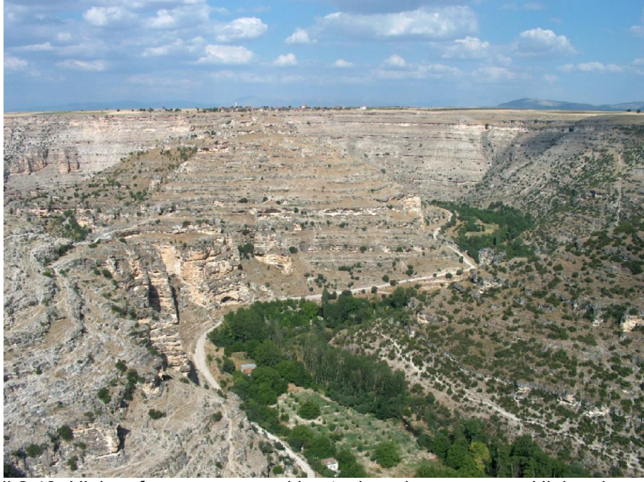
Şekil 2.43. Ulubey formasyonunun kireçtaşlarından görünüm, Ulubey kanyonu.
