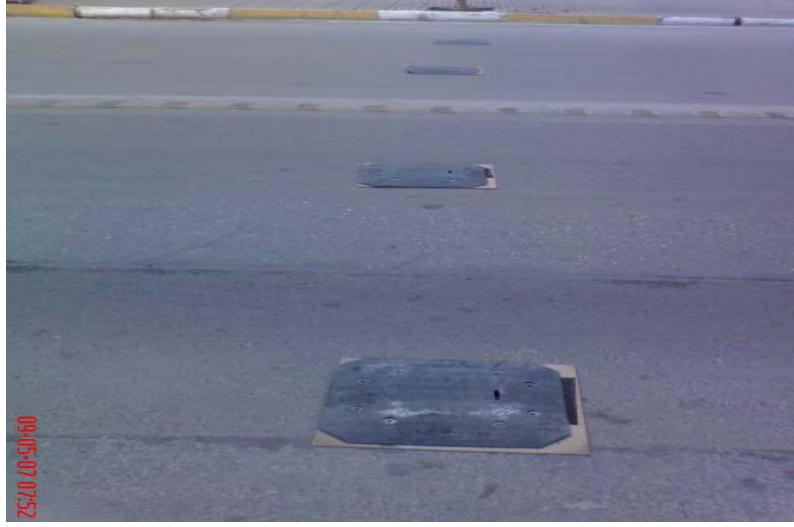
Şekil 4.38. 2x2 bölünmüş bir yolda sensörlerin yeni yöntemle monte edilmiş görünümü
