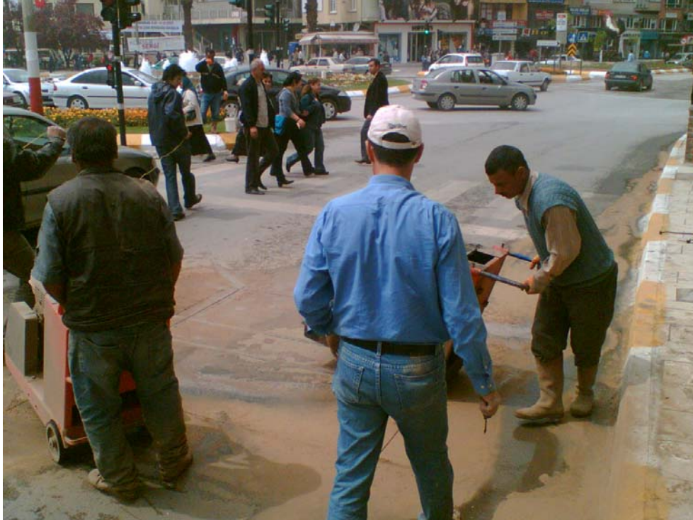
Şekil 4.29. Asfalt makinası ile kesim yapılırken
