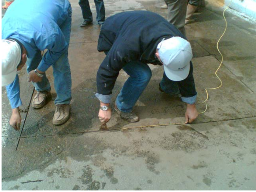
Şekil 4.30. Sensör kanallarına kablo yerleştirilirken
