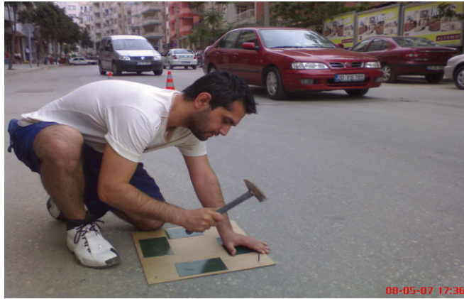
Şekil 4.37. Kontrplağın asfalt kaplama üzerine çakılması
