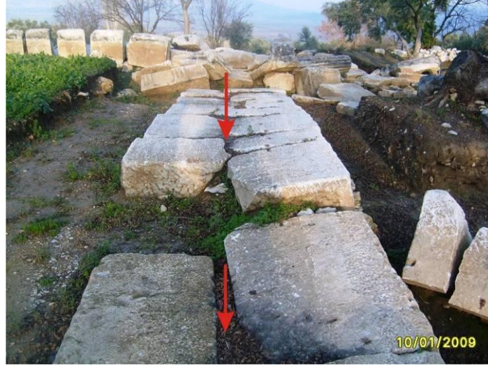
Şekil 11. Kuzey Stoa Peristasis altındaki taşlarda ortadan ve aksel kırıkların görünümü
