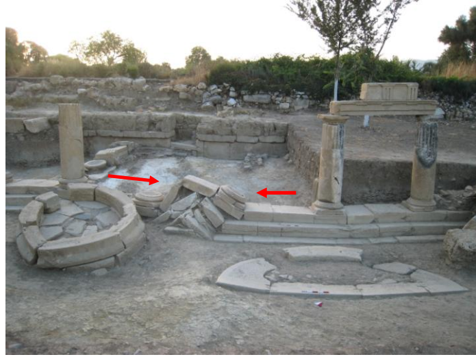
Şekil 10. Kuzey Stoa peristasis bloklarında sıkışma etkisiyle meydana gelen deformasyonlar.
