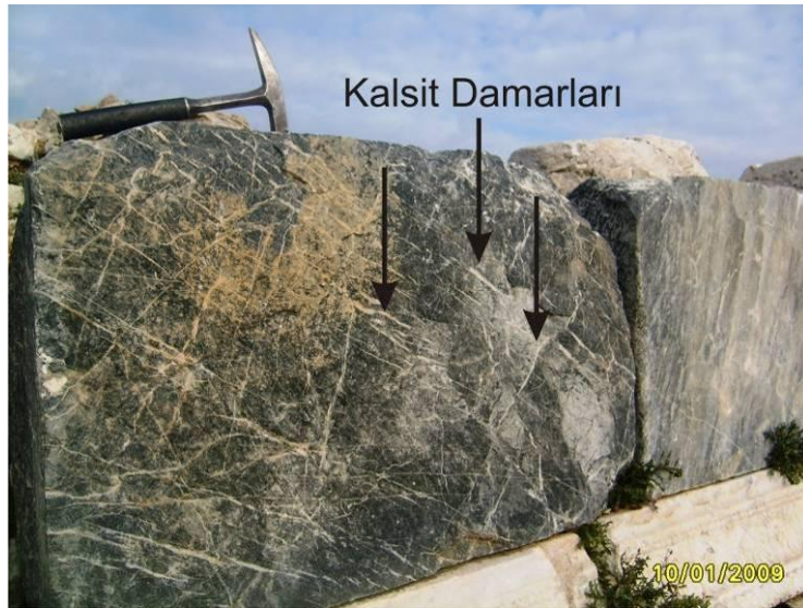
Şekil 7. Altar taban seviyesi üzerinde yer alan mavimsi gri renkli kireçtaşları ve görülen beyaz kalsit damarları.
