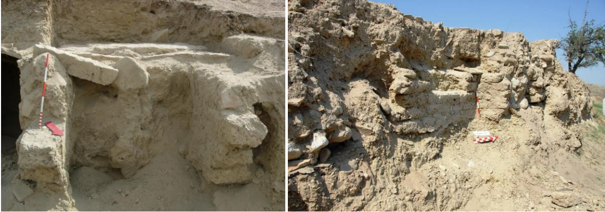
Resim 100: L.05.KDN.M03 Numaralı örgü tekne mezarın 1990 yılı yol açma çalışmaları sırasında tahrip olmuş hali.
